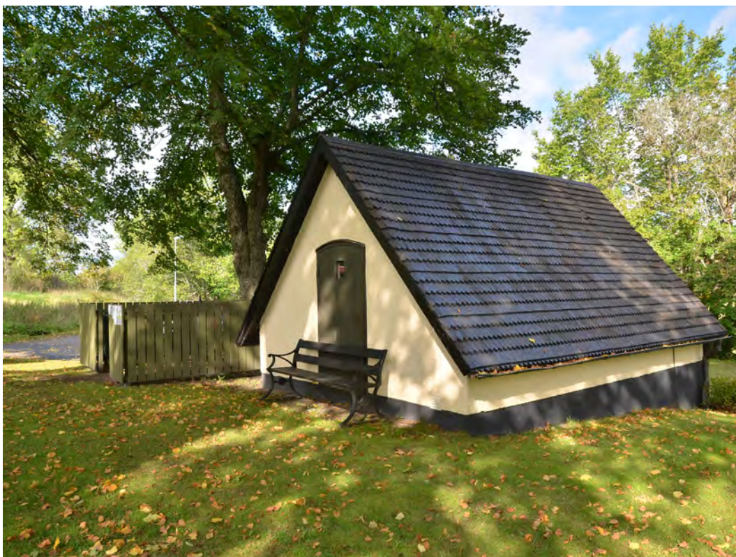
12 På den gamla kyrkogårdens norra del står ett tidigare bårhus troligen uppfört vid mitten av 1900-talet (SLM D2019-0038).
