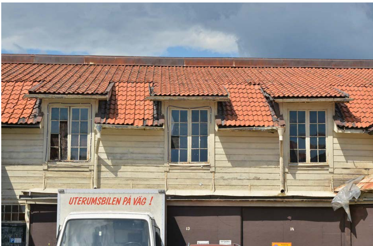
De tre takkuporna på den norra fasaden. Takavvattningen är noga utformad där vattnet från kuporna leds åt sidan ner på taket för att därifrån fortsätta i en kort hängränna ner i stupröret. Därefter leds vattnet vidare längs ytterligare en längre hängränna över portarna för att slutligen ledas ner mot marken i stupröret som syns på nästa bild till höger. (SLM D2018-0605)
