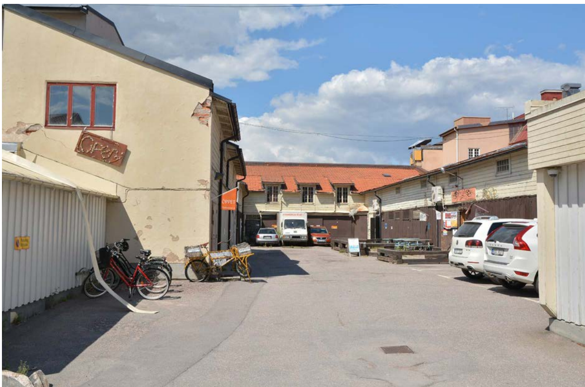
De aktuella gårdshusen sett från infarten från Västra Storgatan. Till vänster syns gaveln på västra längan, i bildens mitt syns den norra med de tre takkuporna, och till höger den östra längan. (SLM D2018-0596)
