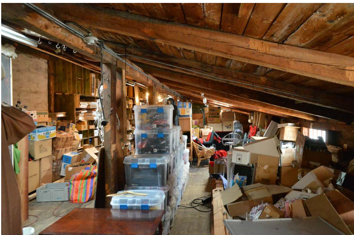
Den östra längans yttre del sett från norr. Till höger skymtar ett av fönstren placerat under takfoten. De bärande stolparna och bjälkarna i taket är viktiga för uthuskaraktären och skulle om de bevarades ge ett mervärde i nya lägenheter. (SLM D2018-0611)
