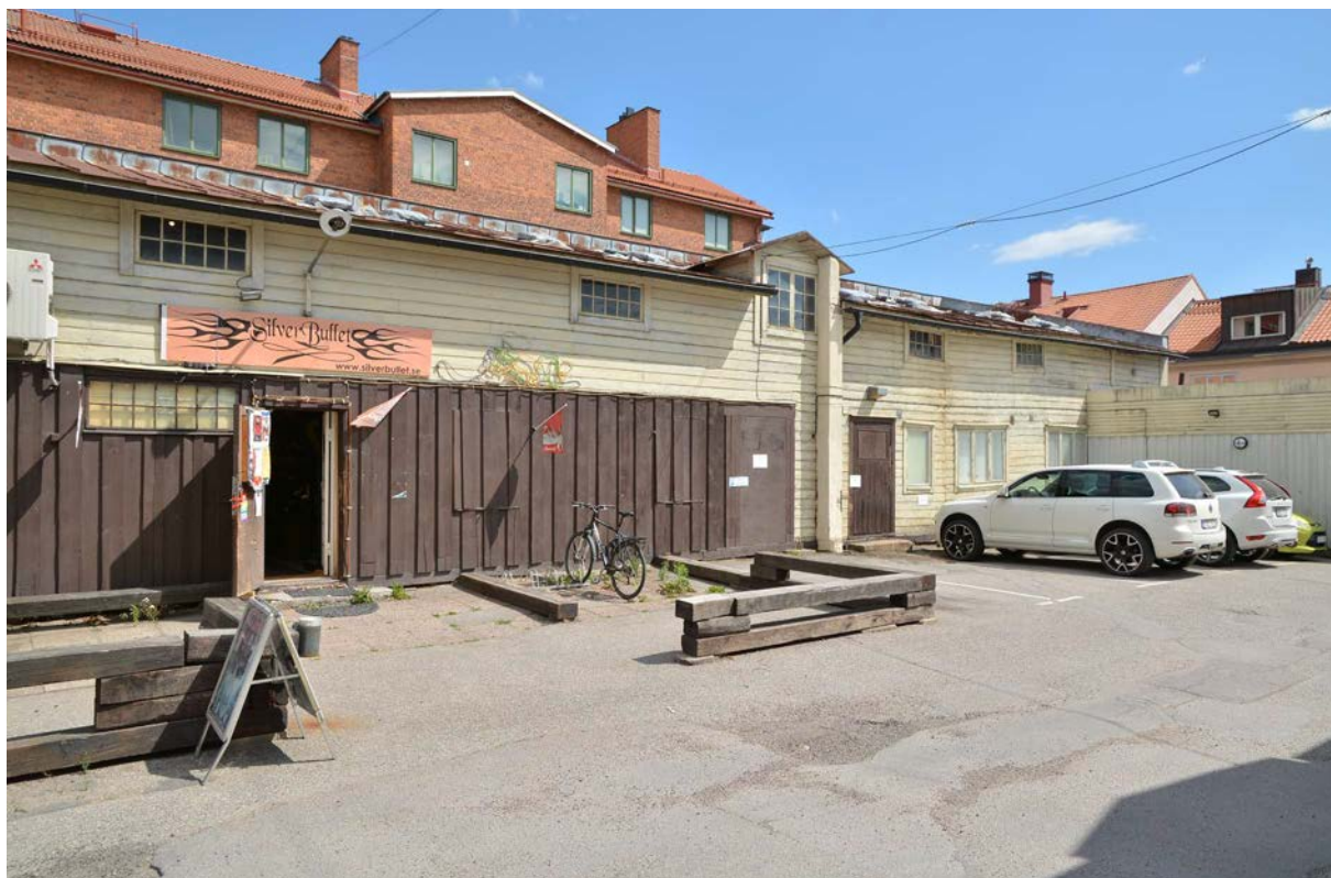
Den södra delen av östra längan sett från väster. Denna del är den äldsta sannolikt uppförd i början av 1900-talet. Till höger syns fönster till den kontorsdel som inreddes i byggnaden 1954. Vid samma tillfälle byggdes den brandmur mot lagerutrymmena till vänster som sticker ut från fasaden vid takkupan. (SLM D2018-0598)
