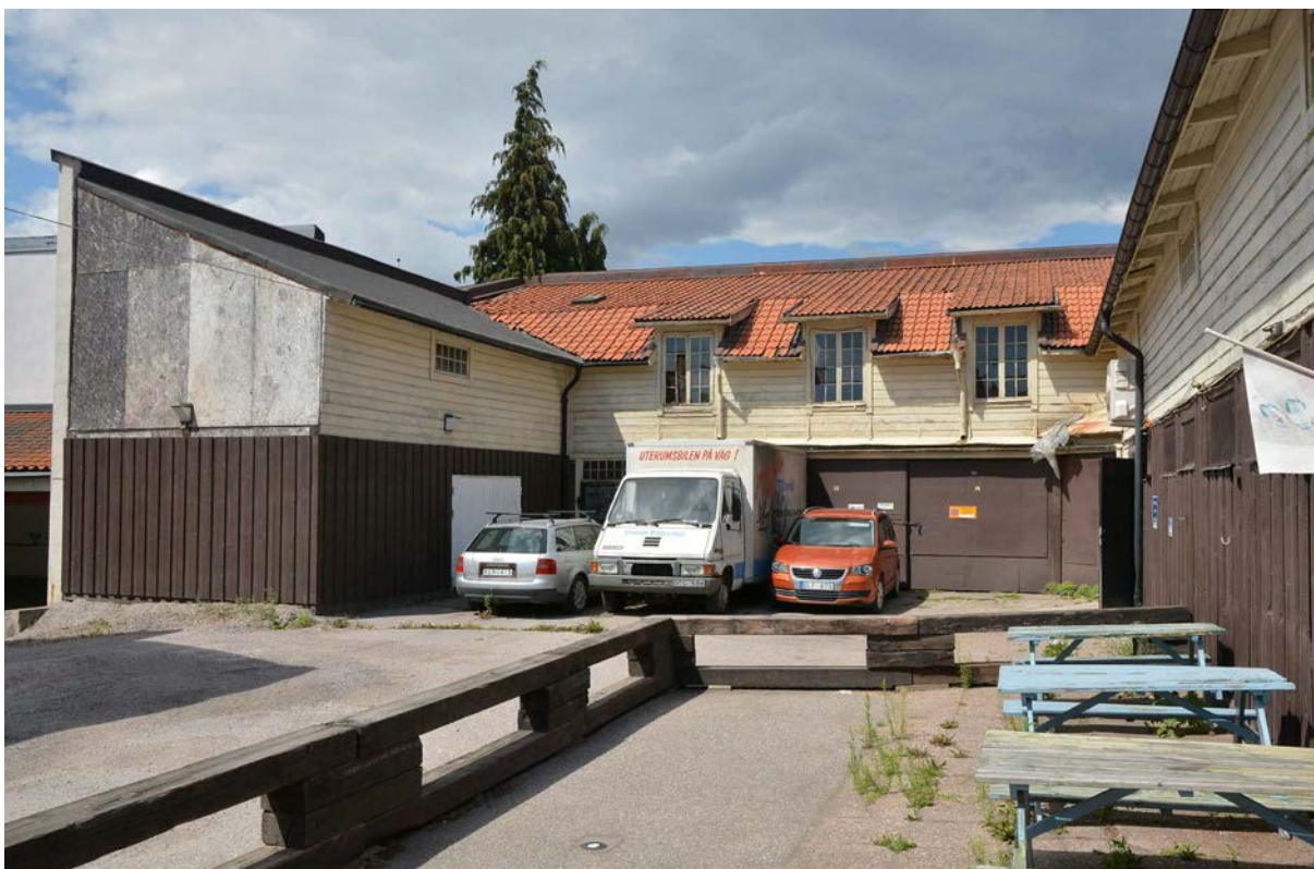
Den kvarvarande delen av västra längan och den norra med de tre takkuporna. Till vänster syns infarten som skapades när en del av västra längan revs. Snittet har täckts för med spånskivor och panel. (SLM D2018-0597)
