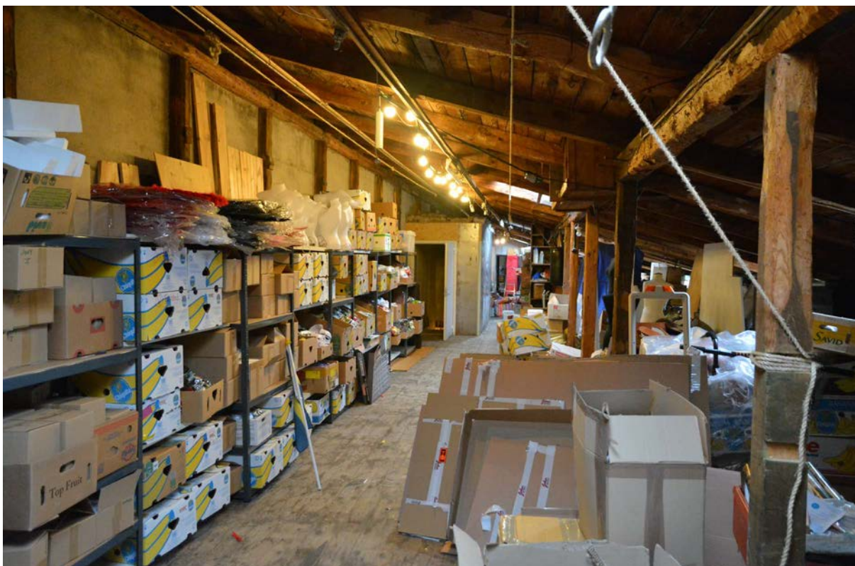
Den östra längans inre del sett från norr. Den murade och putsade brandmuren syns till vänster i bild. (SLM D2018-0610)
