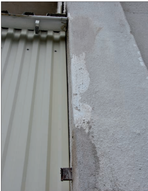
11. Vid skrapning framträder den ursprungliga vita ädelputsen, tydligt under senare putslager. Detalj av pilaster på byggnad 3C. (SLM 2015-982)
