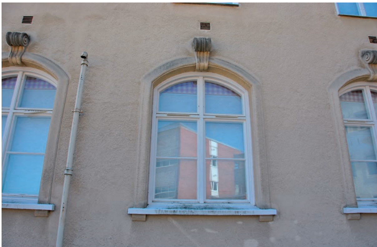
21. Detalj av bottenvåningens fönster på kontorsbyggnaden. (SLM 2015-991)
