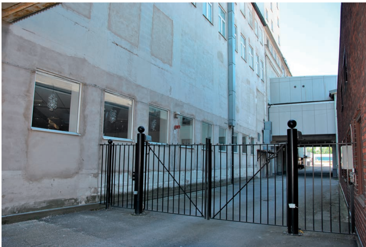
20. Baksidan av byggnad 3A. (SLM 2015-990)
