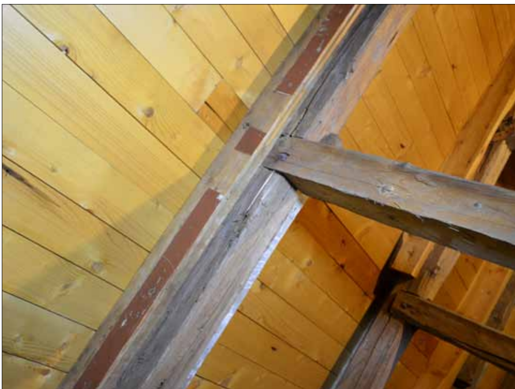
54 Övre ände på saxsparre husad i högbenet (SLM D2015-1397).
