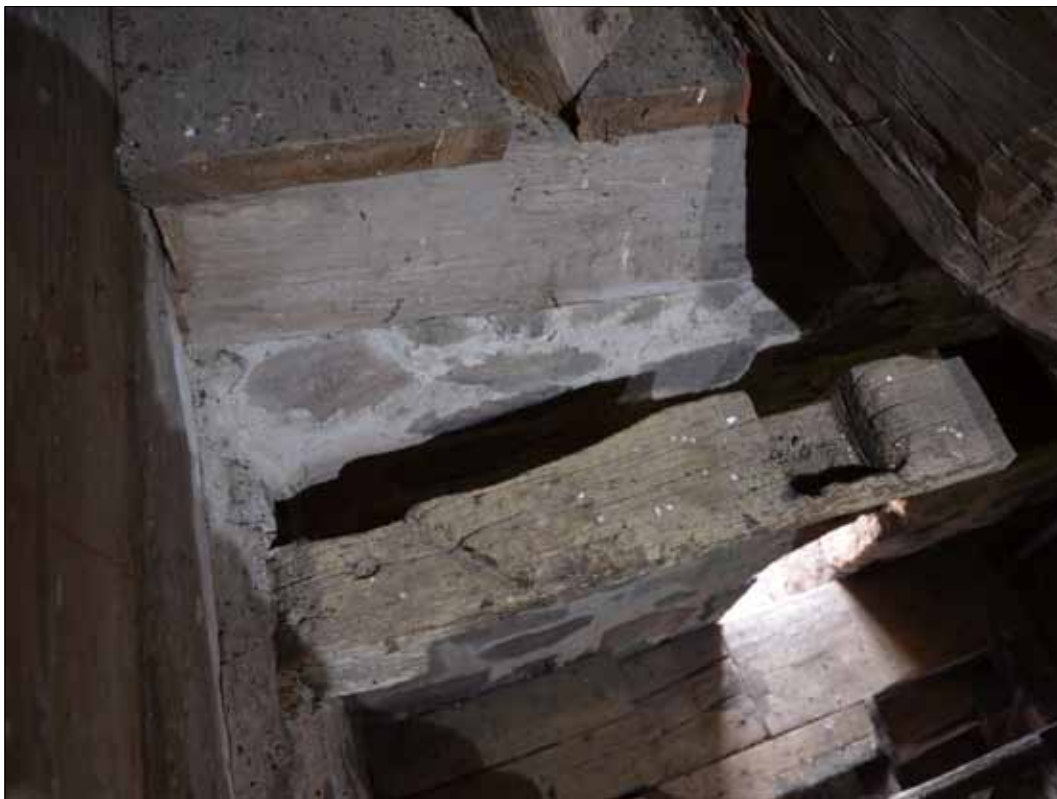
115 Bjälke med urtag för tidigare tornhuvens stickbjälke vid uppgången till klockvåningen (SLM D2015-1436).
