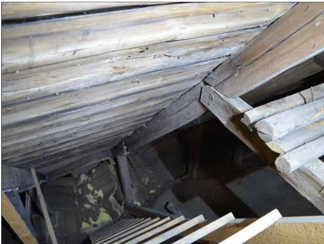
191 Korvindens norra takfall (Slm D2015-1483).
