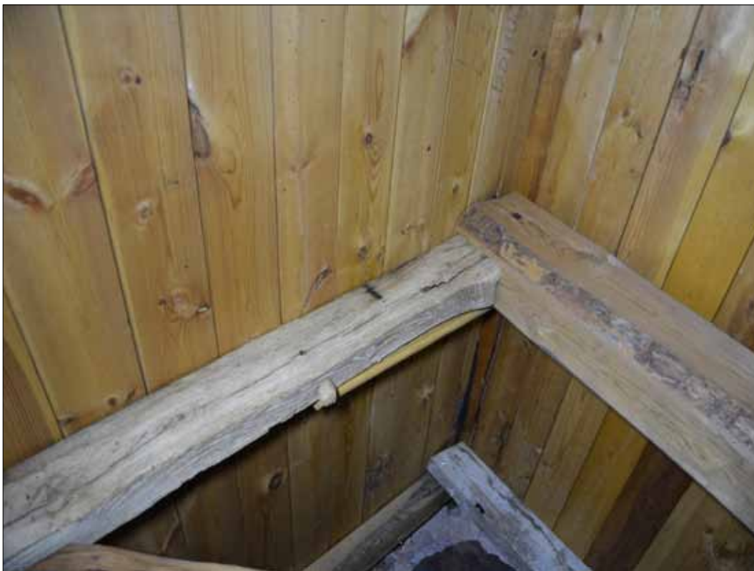
96 Ovanför koret står 7 takstolar med romanska och gotiska högben. Takstol nr 1 har på södra sidan ett sprätthugget högben i ek med två urtag för saxsparrar och dymlingar för taktro. Uppe vidnock har högbenet en skuren rundning (SLM D2015-1423).
