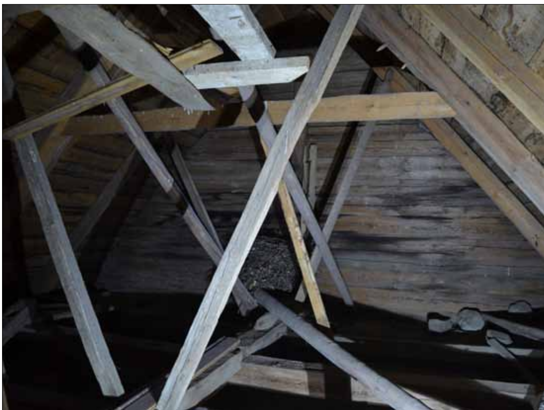
107 Tornrummets vind sedd mot väster (SLM D2015-1430).
