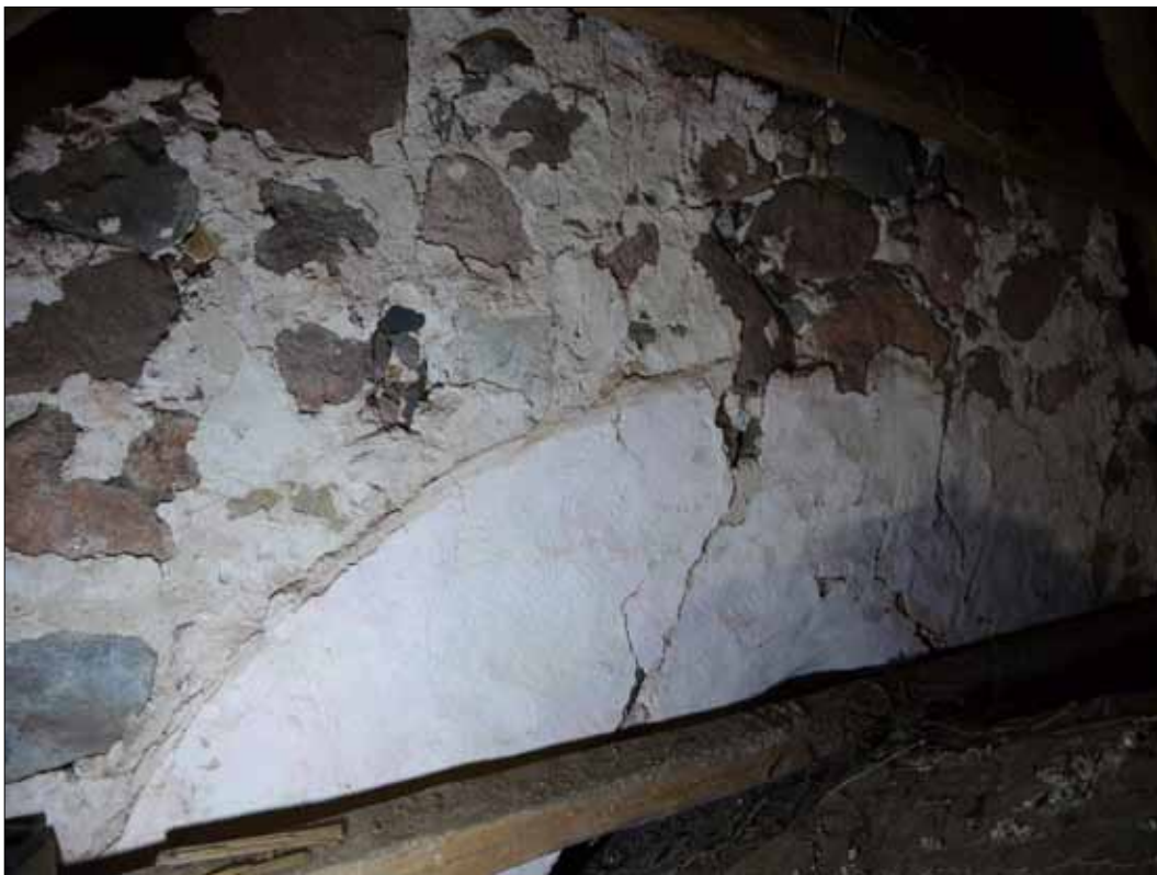
81 Spår efter det äldre trätunnvalvets form syns i putsen på östra gaveln (SLM D2015-1416).
