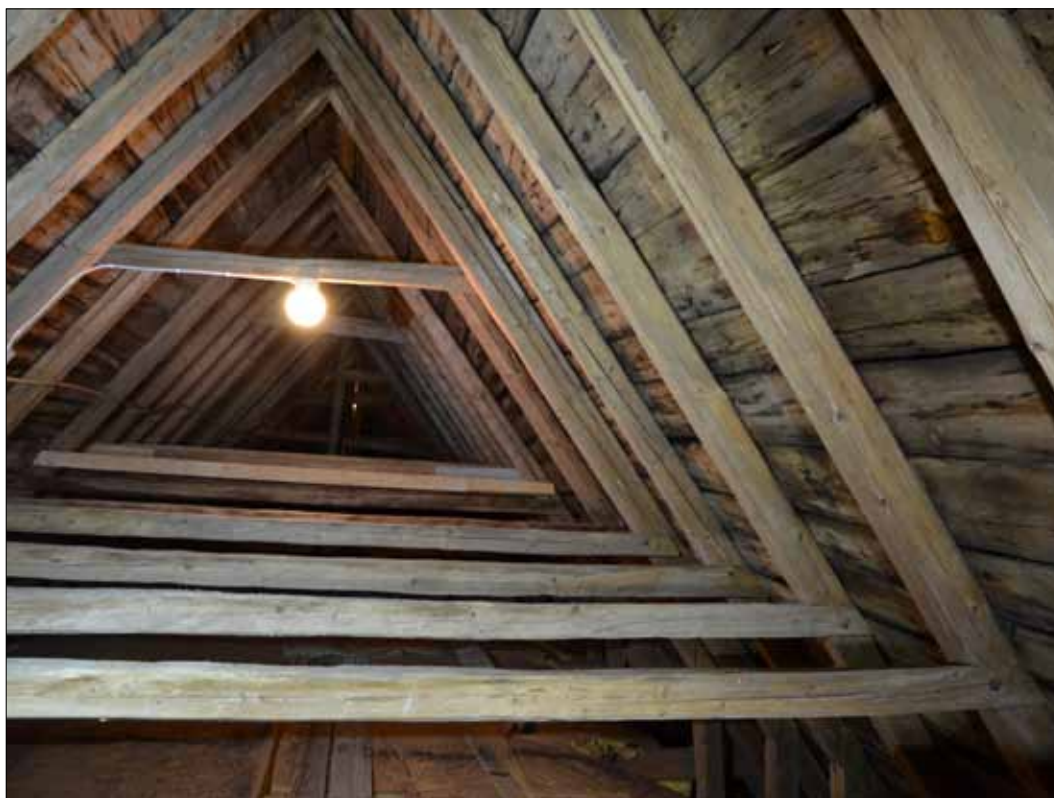
171 Långhusvinden sedd mot öster (SLM D2015-1470).
