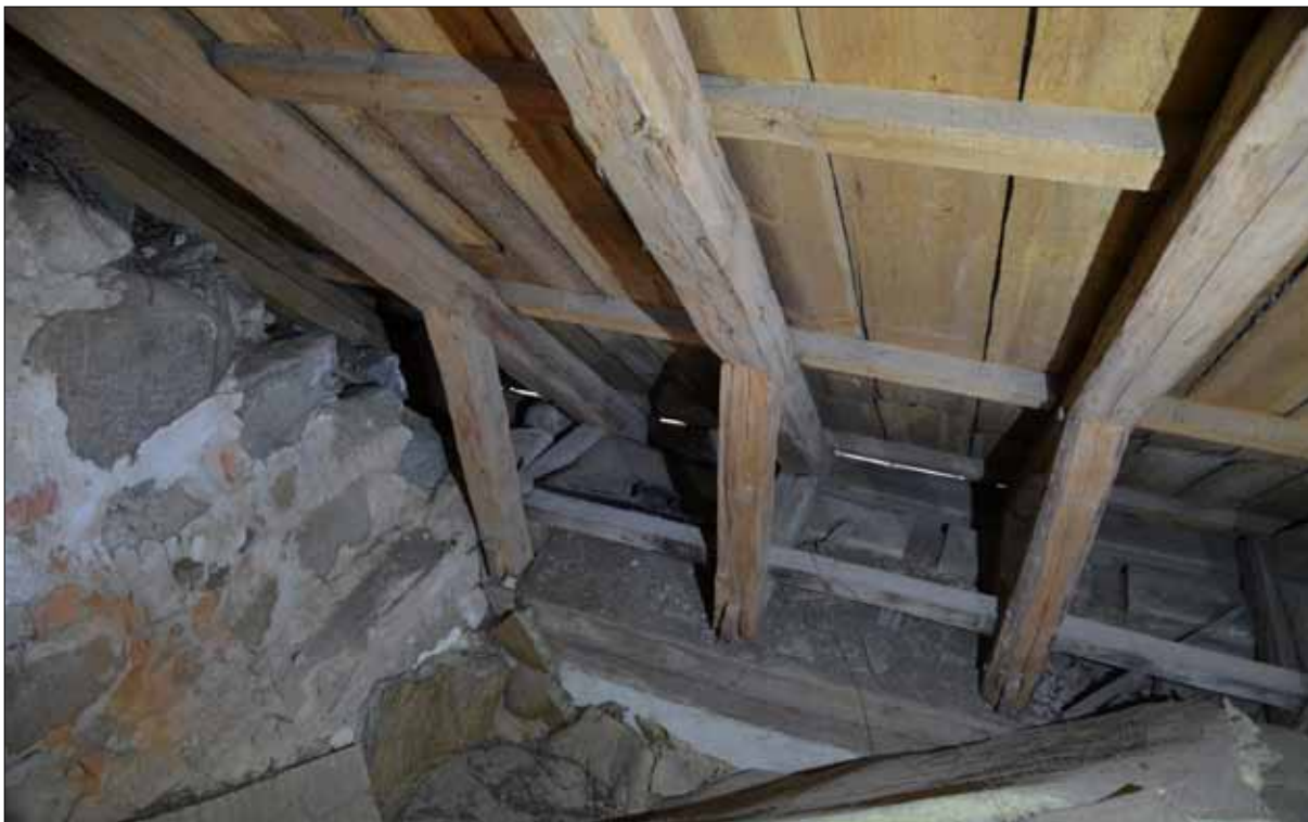
150 Vid takfoten syns det södra långsidans yttre remstycke med äldre urtag (SLM D2015-1457).
