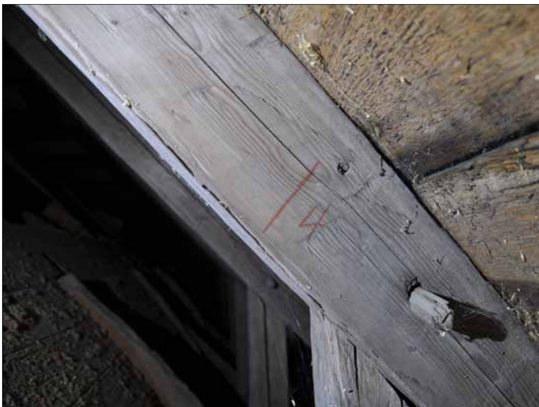
18 Siffrorna med rödkrita i mötet hanbjälke/högben kan möjligen härröra från den nya valvslagningen på 1700-talet (SLM D2015-1375). Fotografi: Daniel Eriksson.
