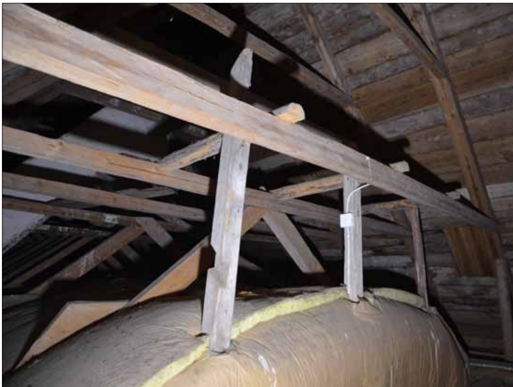
147 Takstolarna i öster över 1762-års tillbyggnad sedda mot väster. De vertikala stöden består av återanvänt virke med urtag och grånad yta. (SLM D2015-1455).
