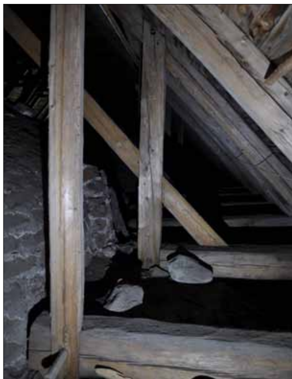
237 Andra stödbenet är från början utflyttat för att ge plats åt valvet. Taklaget är alltså yngre än valvslagningen (SLM D2015-1510). Daniel Eriksson.
