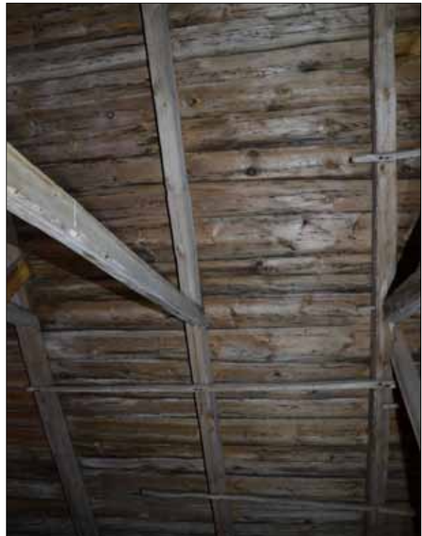
186 Norra takfallet på långhusvinden. Rikligt med sidoförstyvningar av rundvirke (SLM D2015-1480).
