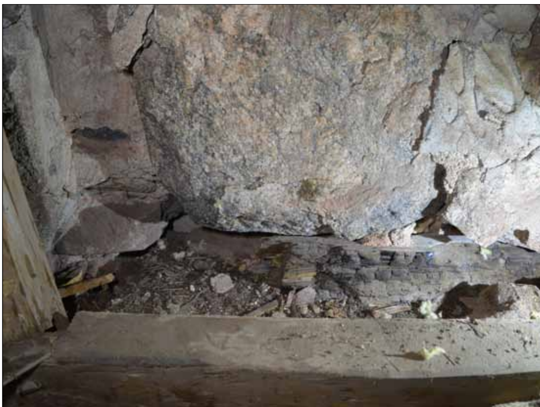
166 Brandskadad tass i västra långhusgaveln, norra sidan (SLM D2015-1468).
