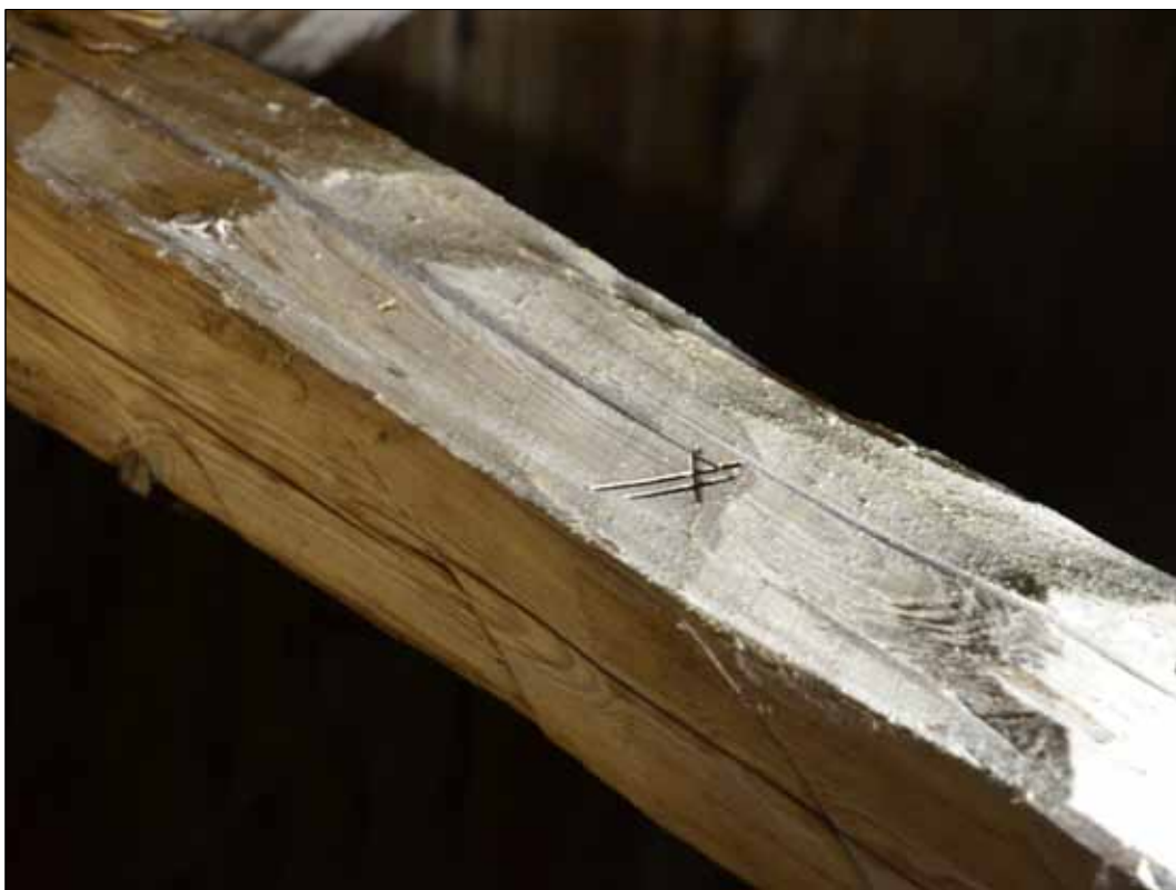
158 Timmermansmärken är utförda i form av runor, romerska siffror och symboler (SLM D2015-1462).
