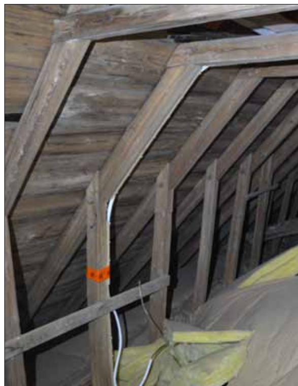
66 Delar av takstolarna i Gryts kyrka (SLM D2015-1406).
