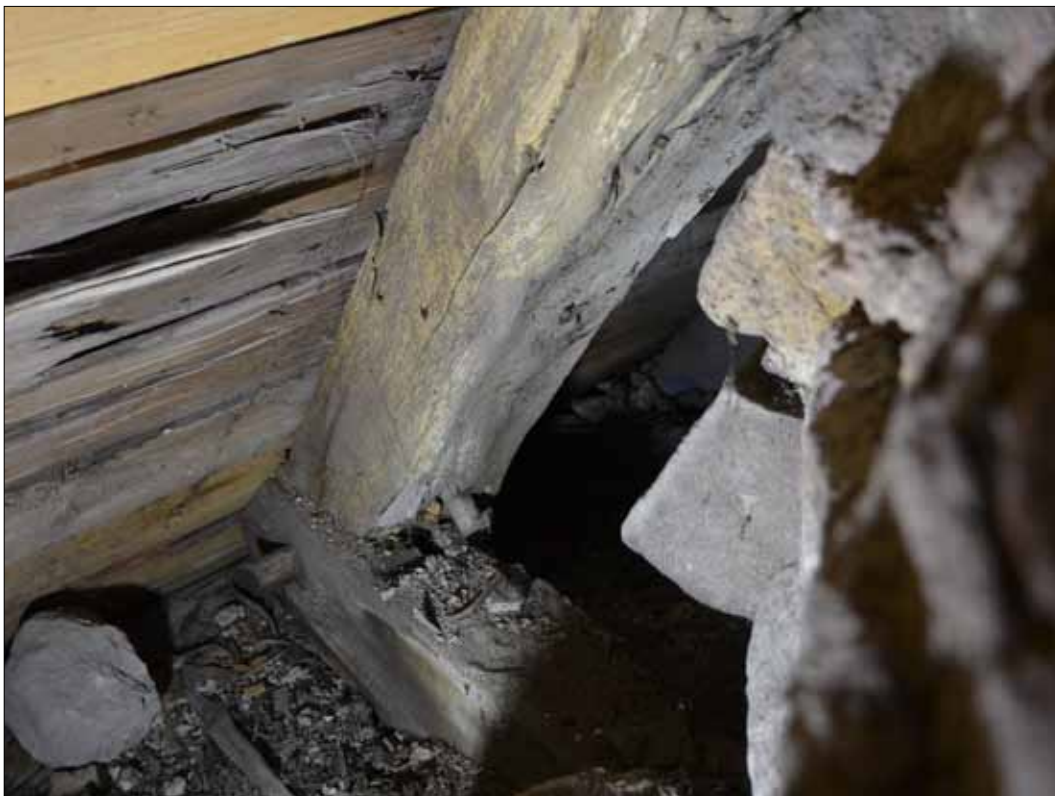
112 Högben och tass i anslutning till långhusets västgavel med sprätthuggen yta och fastdymlad spräckt och bilad taktro (SLM D2015-1433).
