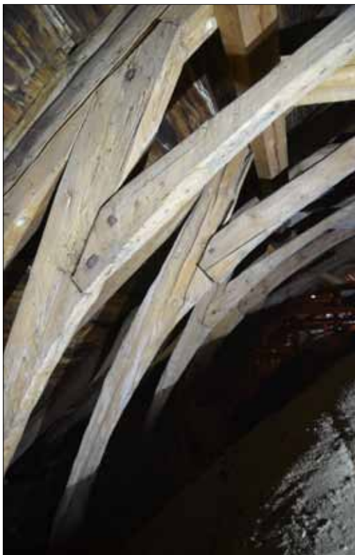
209 Mötena mellan takstolsdelarna har mycket varierande utförande, med och utan nacke mm (SLM D2015-1493).
