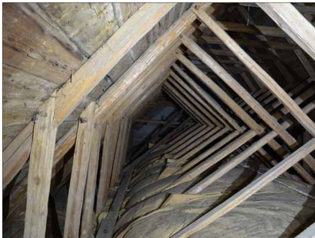
146 Möte stödben-högben med raka bladningar (SLM D2015-1454).
