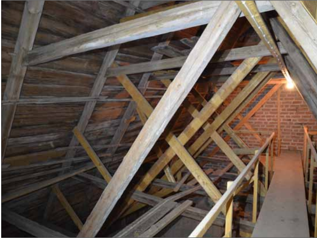
190 Långhusvinden sedd mot öster (SLM D2015-1482).
