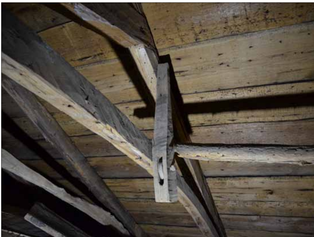
200 Fint arbetat träblack som kan ha använts för att hissa upp något i kyrkorummet (SLM D2015-1488).
