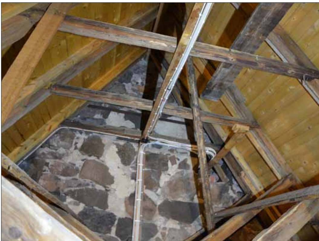
53 Vy mot västra gavelväggen (SLM D2015-1396).
