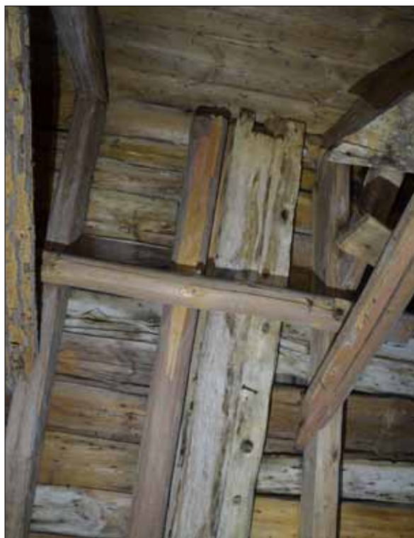
225 Kombinerat högben/takfotsbräda av ek i skarven mellan 1100-talskyrkan och 1400-talets utbyggnad österut (Slm D2015-1504).
