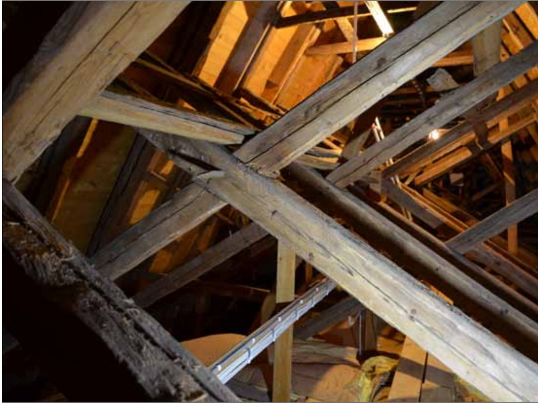
55 Saxsparrar med lång dymling i mötet (SLM D2015-1398).
