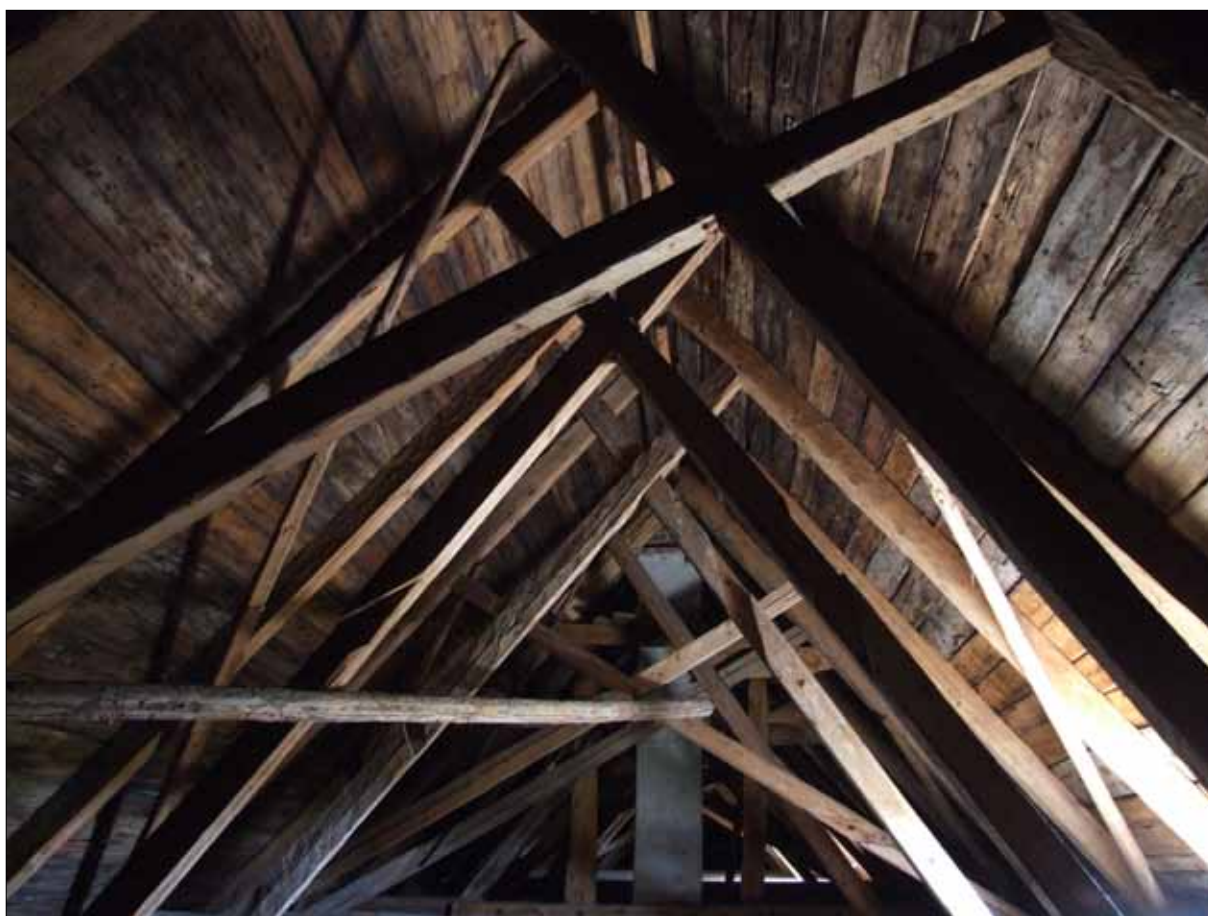
38 De flesta takstolarna består av återanvända medeltida delar (SLM D2015-1385).
