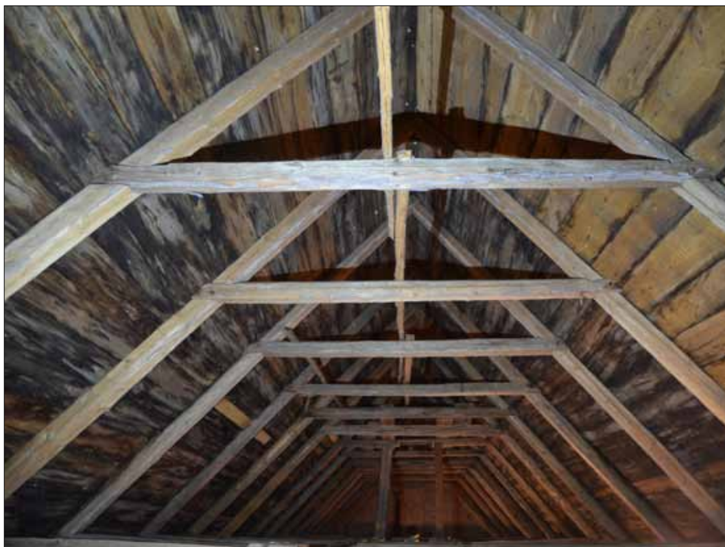
216 Långhusvinden sedd mot öster (SLM D2015-1498).
