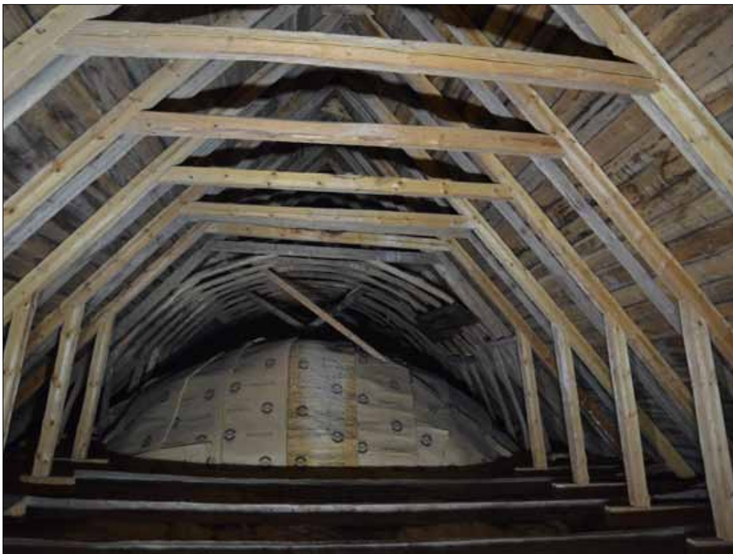
197 Långhusvinden sedd från väster. Närmast i bild syns förstärkningstakstolarna från 1881 och mellan dessa de mer silvergrå medeltida högbenen. Längst bort i bild över valvet syns takstolen för 1300-talets trätunnvalv (SLM D2015-1485).
