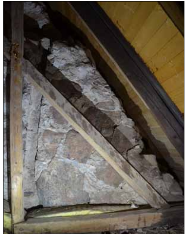
160 I västväggens mur finns avtryck av en äldre takkonstruktion med stödben och högben. (SLM D2015-1463).
