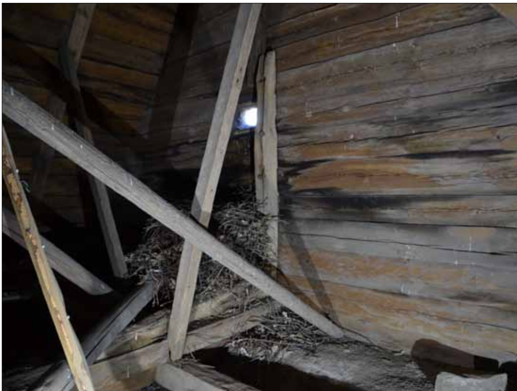
105 Tornrummets vind. Stort ek-knä är fastdymlat i timmerväggen och den t-formade styrbjälken (SLM D2015-1428).
