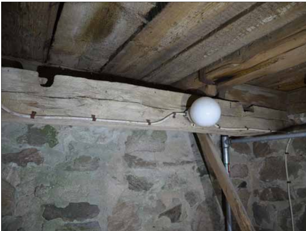
114 Bjälke med urtag för klockaxel (SLM D2015-1435).
