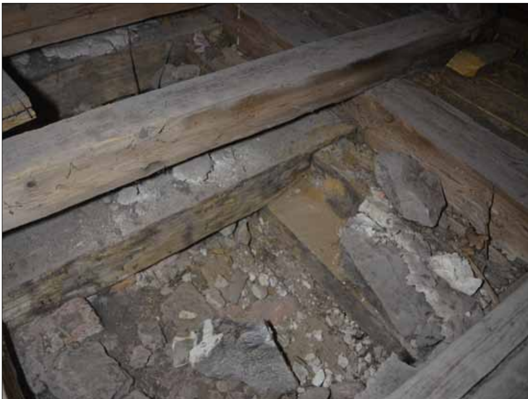
95 Yttre remstycket med invändig hylla och nedfälld bindbjälke (SLM D2015-1422).
