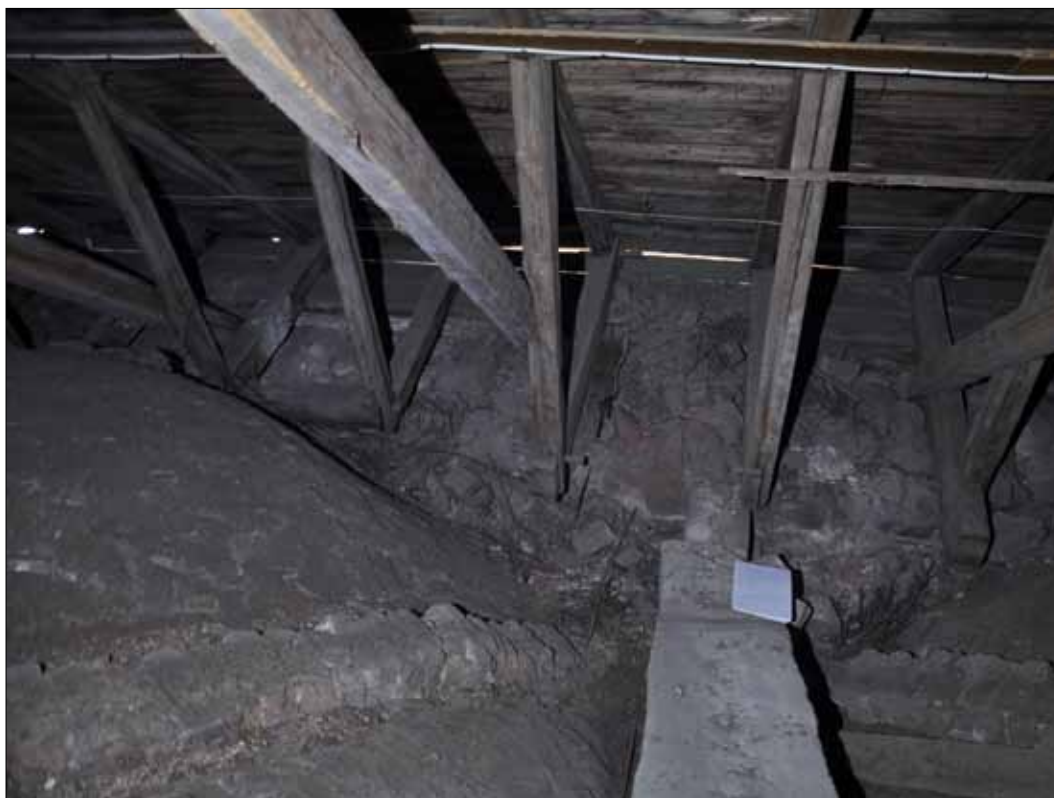
252 I murverket mellan takstol nr 11 och 12 syns tydligt skarven som uppstod då kyrkan förlängdes österut på 1300-talet. Den nyare muren är betydligt tjockare än den äldre. På murkrönen ligger en hel del byggsräp och annat som kan ge mycket information om byggprocesser och andra företeelser. Detta kan lätt försvinna vid städning. (SLM D2015-1523). Foto: Daniel Eriksson.
