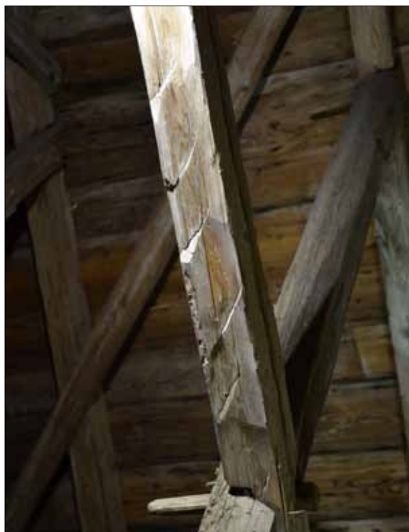
153 Detalj av en saxsparres undersida med upplättningshugg (SLM D2015-1459).
