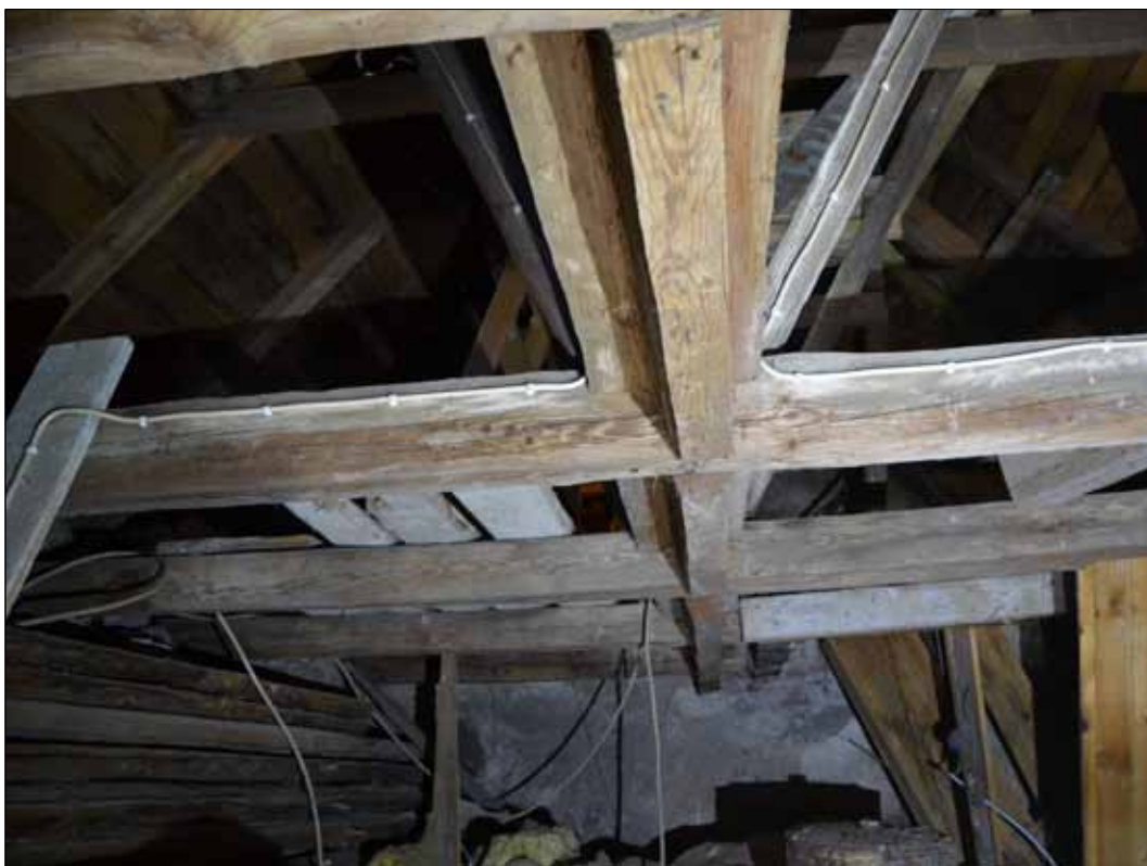
108 Den T-formade styrbjälken ihopknutad med bindbjälkarna (SLM D2015-1431).
