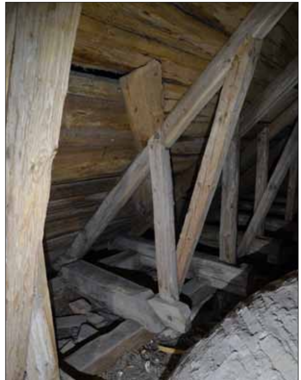
136 Återanvänd konstruktionsdel har fått ny funktion som tass (SLM D2015-1448).
