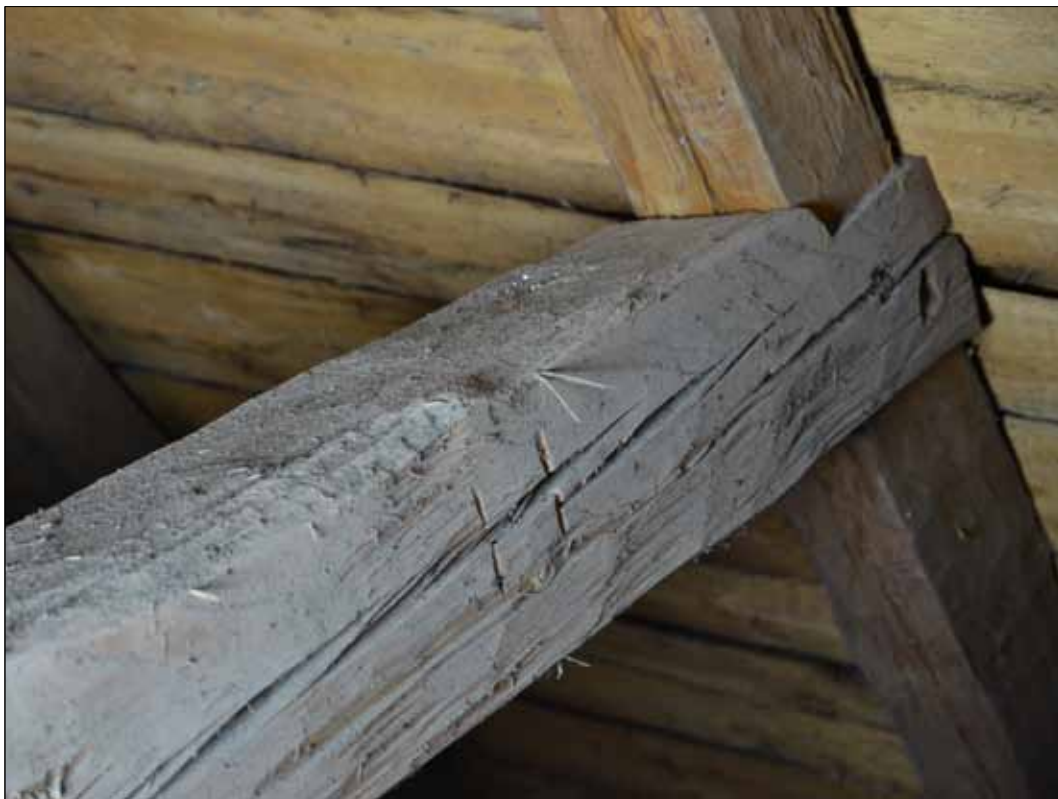
74 Detalj av möte hanbjälke-högben, utfört som bladning med nacke (SLM D2015-1411).
