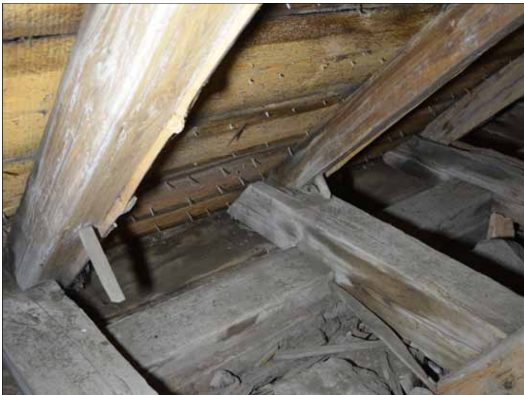
230 Yttre remstycke med hylla på båda sidor (SLM D2015-1506).
