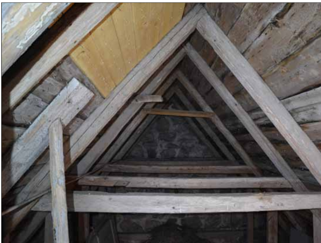
219 Vinden över sakristian. Den andra hanbjälken framifrån har urtag som visar att den kan vara en återanvänd bindbjälke (SLM D2015-1501).
