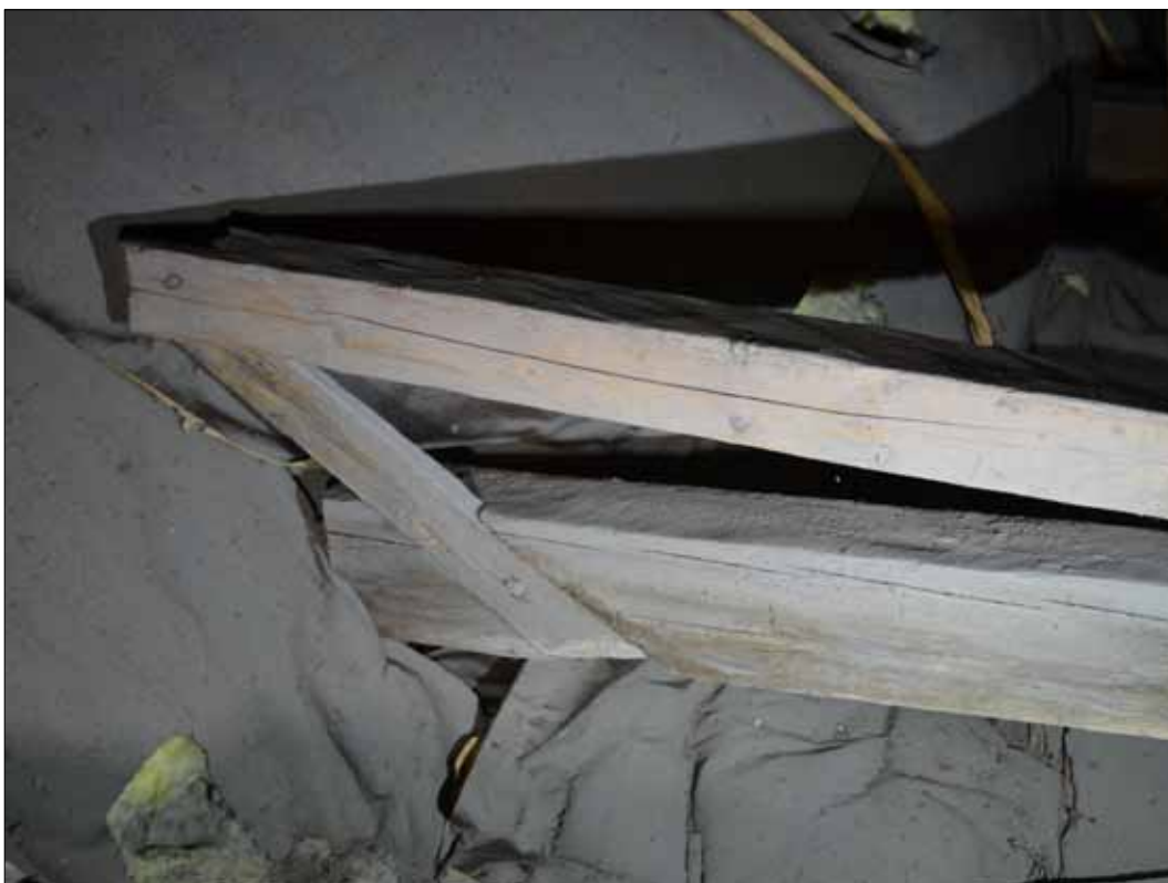
181 Kvarvarande del av ursprungligt möte stödben-bindbjälke (SLM D2015-1476).
