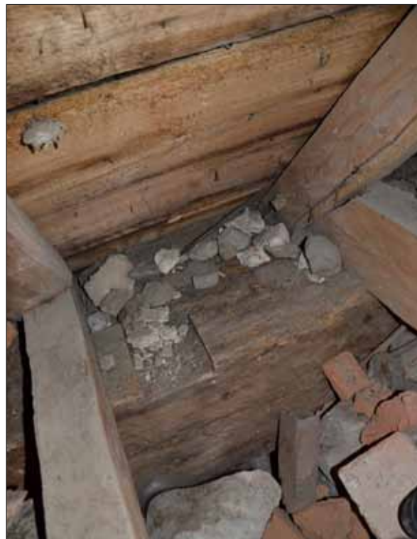
20 De yttre murremmarna hör troligen ihop med den äldsta takkonstruktion och har urtag kvar efter bindbjälkar (SLM D2015-1376).
