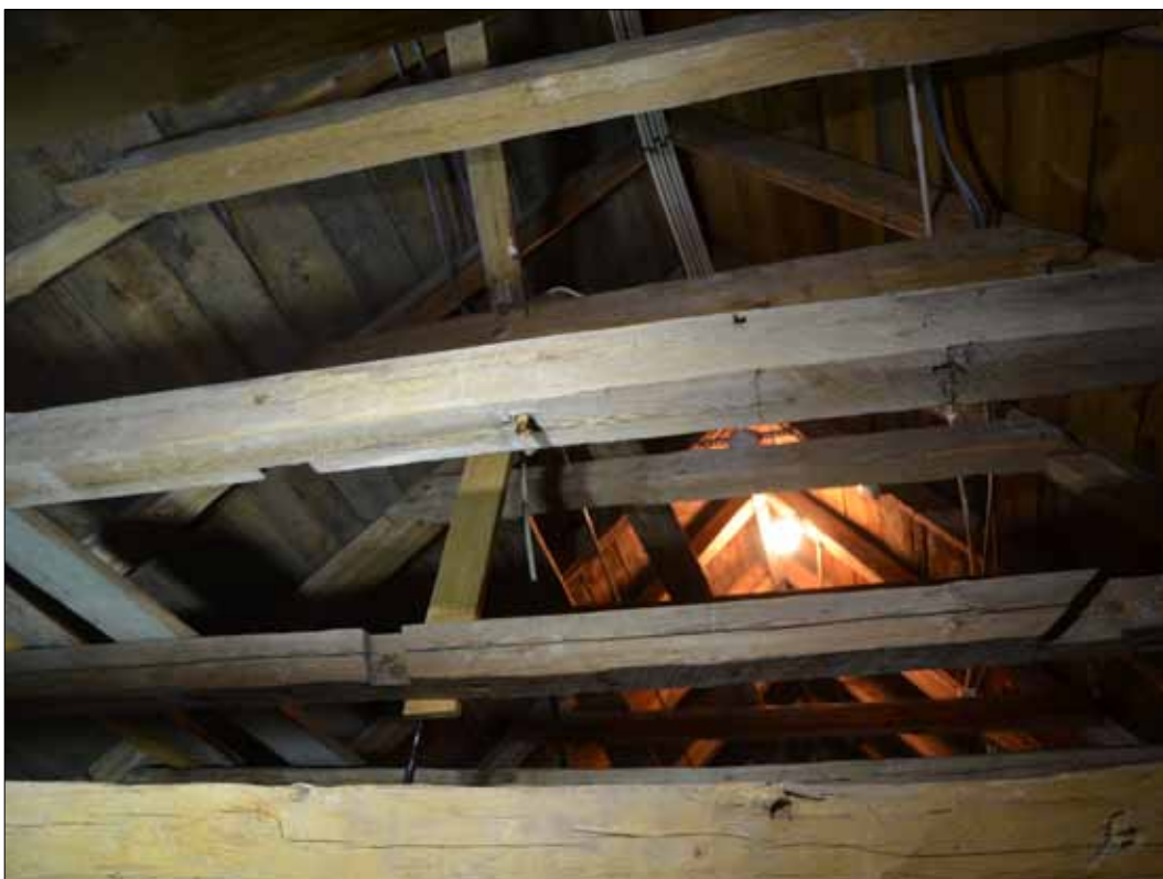
33 Ett antal stödben, tassar och hanbjälkar är sprattthuggna och har urtag (SLM D2015-1381).
