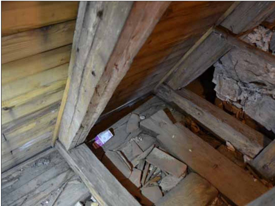
56 Detalj av knäbocken och inlaxad kortling mellan remstyckena. (SLM D2015-1399).
