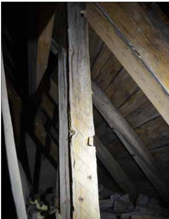
182 Återanvänt stödben på södra sidan av långhusvinden. Urtag för klockaxlar, sprätthuggen yta och teckning med kolkrita (SLM D2015-1477).
