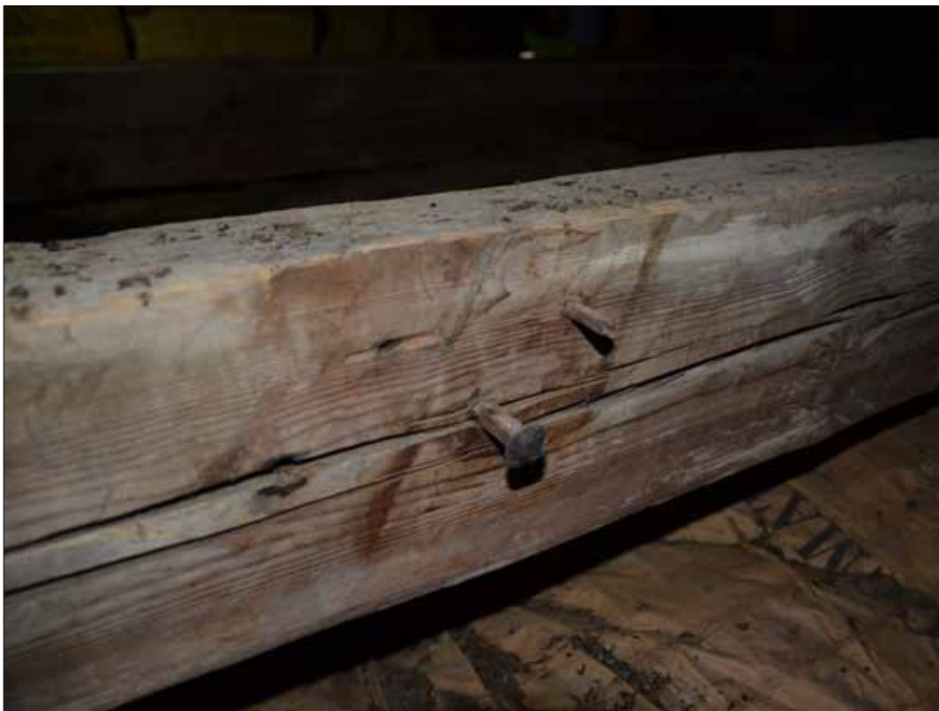
198 Grovt sprätthuggen romansk bindbälke med avtryck efter anslutande stödben som fästs in med två smidda spikar. (SLM D2015-1486).
