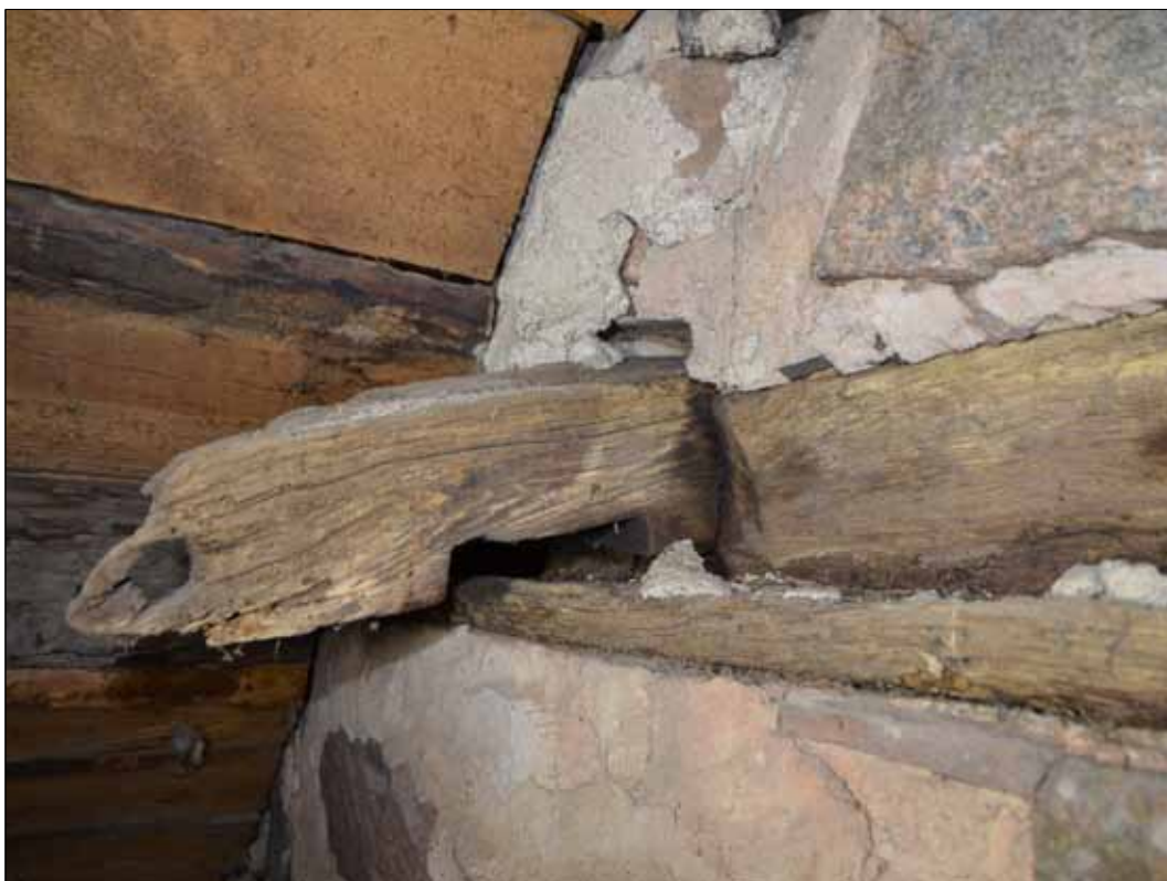
184 Utstickande taktass och yttre remstycke av ek med hylla tillhörande korets romanska takkonstruktion sedd från vinden över sakristian (SLM D2015-1479).
