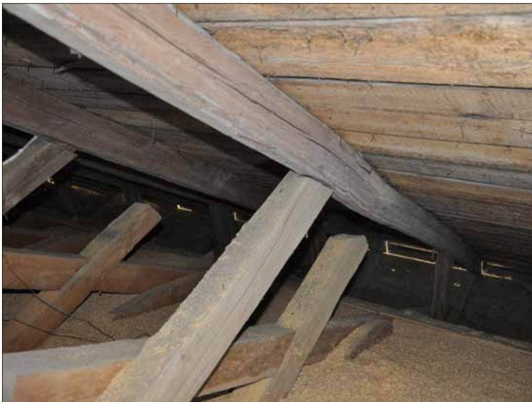
14 Notera det krokiga högbenet och att timmermannen har huggit med böjen både på över- och undersida. Bockkonstruktionen för 1754-års tunnvalv (SLM D2015-1371). Fotografi: Daniel Eriksson.
