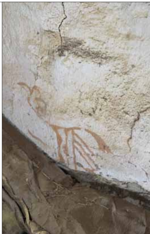
212 Fragment av kalkmåleri på östra gavelväggen (SLM D2015-1496).
