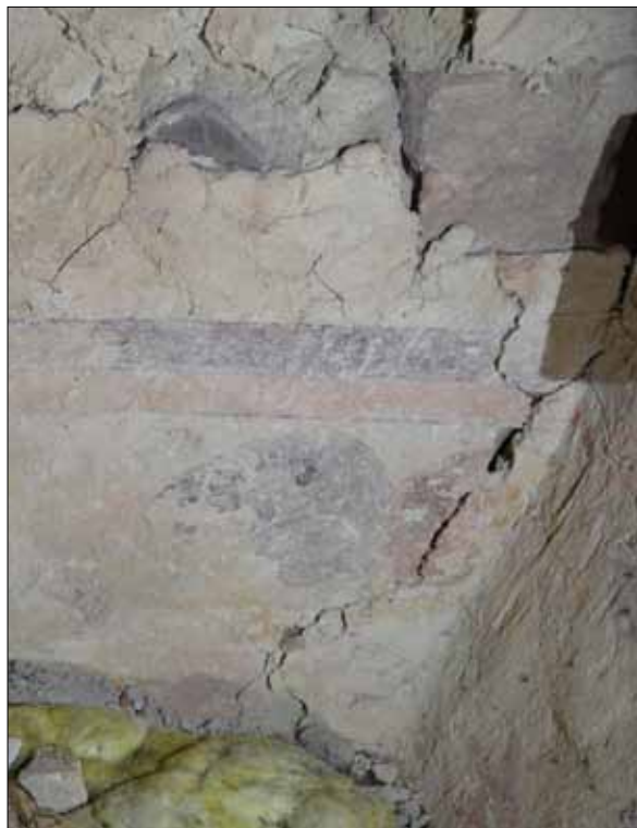
183 Detalj av fragmentariskt romanskt kalkmåleri i nordöstra hörnet av långhusvinden (SLM D2015-1478).
