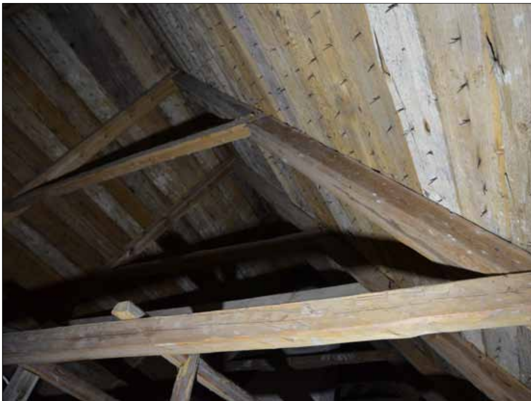
148 Övre delen av takstolarna ovan (SLM D2015-1456).
