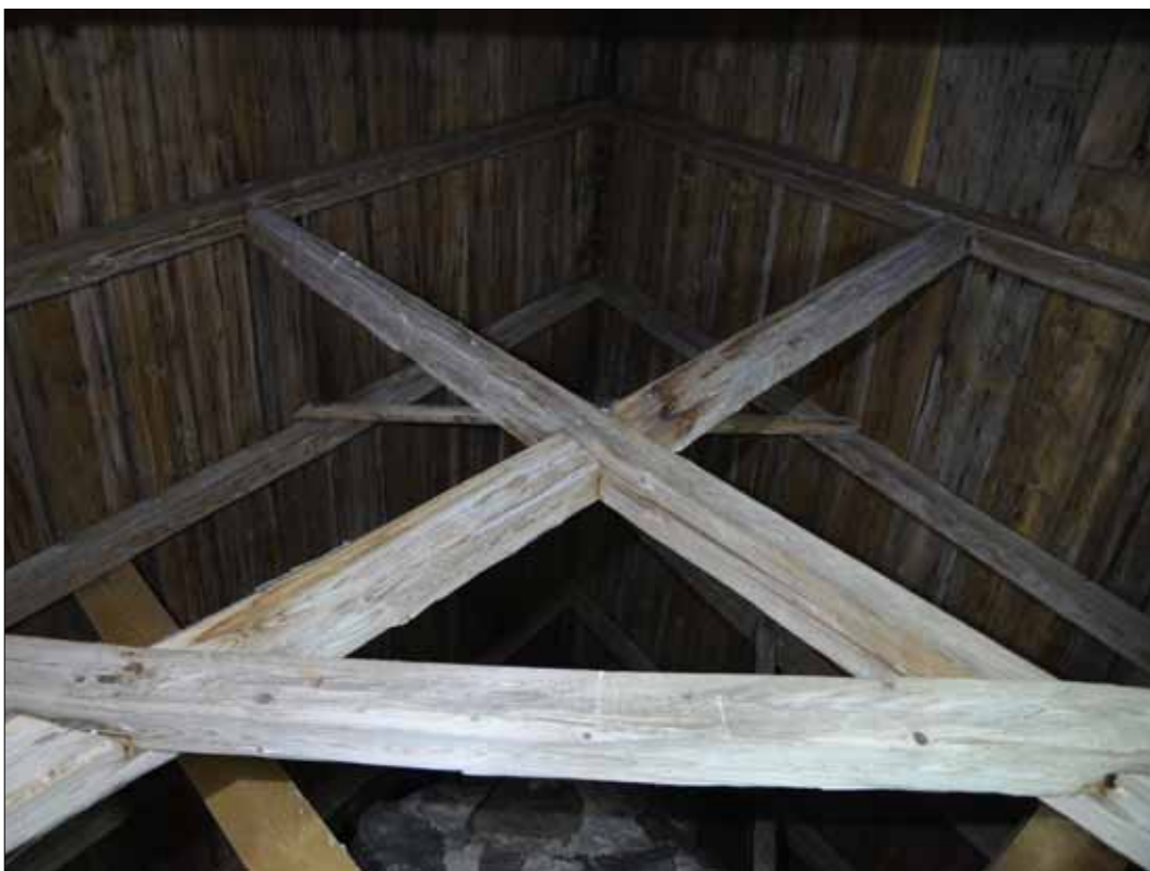
46 Saxsparrarnas möte med högben och hanbjälke (SLM D2015-1391).
