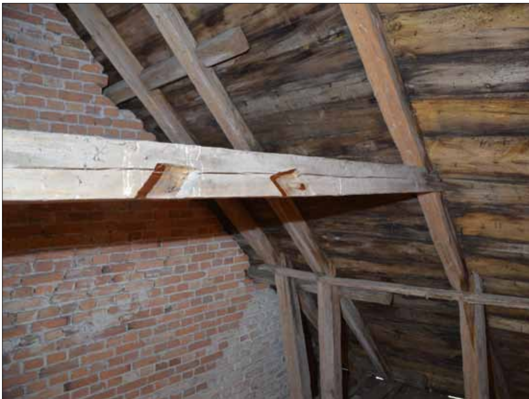
218 Äldre bindbjälkar med urtag för stödben återanvända som undre hanbjälkar (SLM D2015-1500).
