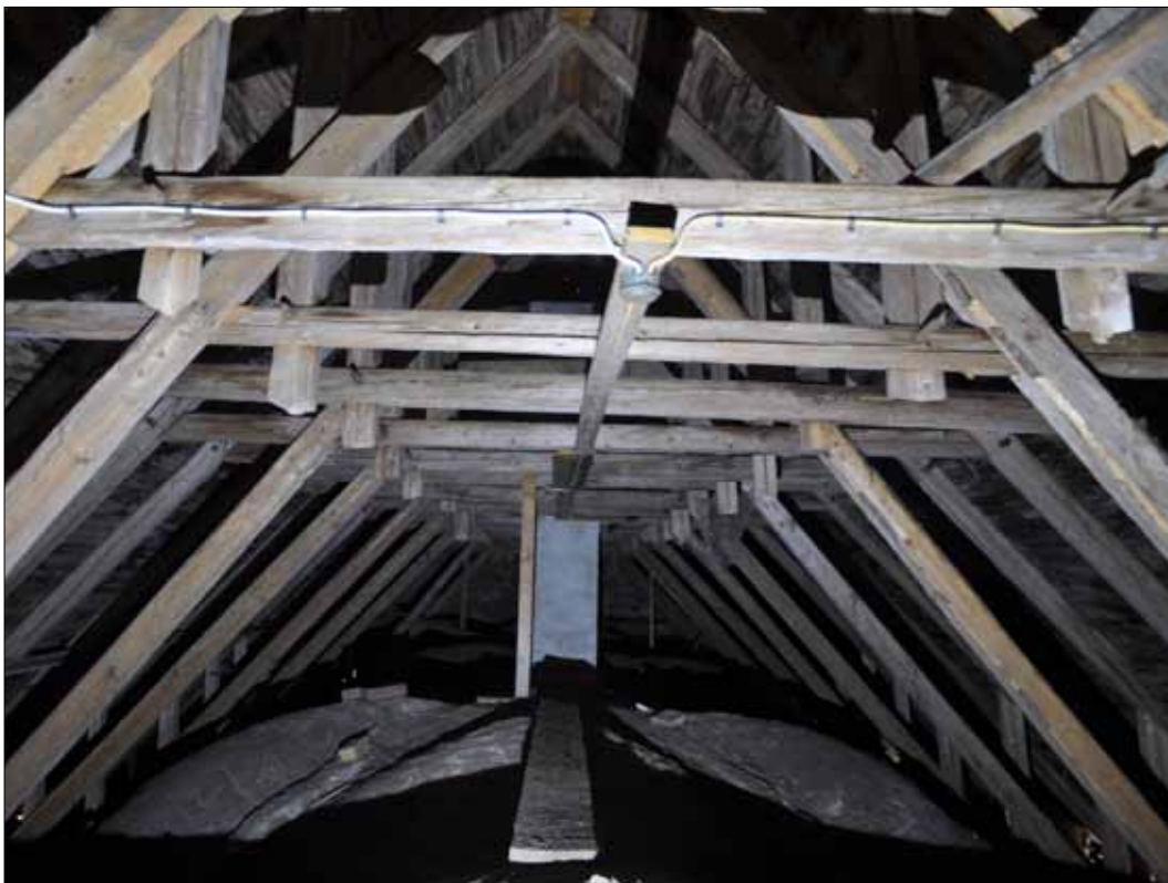
247 De övre stödbenen går förbi hanbjälkarna och är ändkapade med yxa på ett liknande sätt som de nedre stödbenen (SLM D2015-1518). Foto: Daniel Eriksson.
