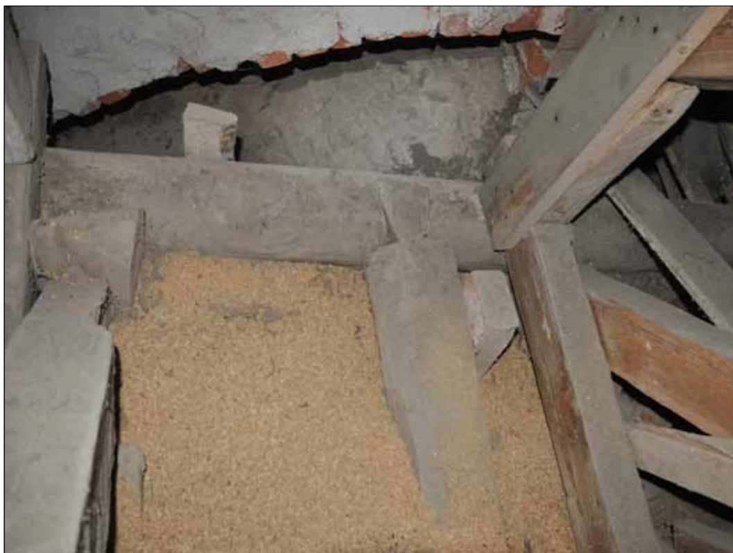
16 Yttre och inre remstycket har sammanfogats med laxade kortlingar (SLM D2015-1373). Fotografi: Daniel Eriksson.
