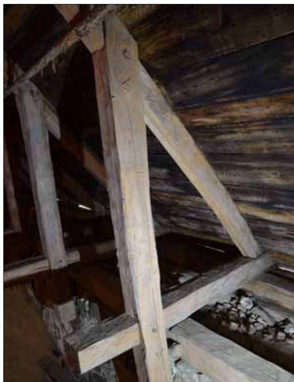
214 Knäbock med timmermansmärken (SLM D2015-1497).
