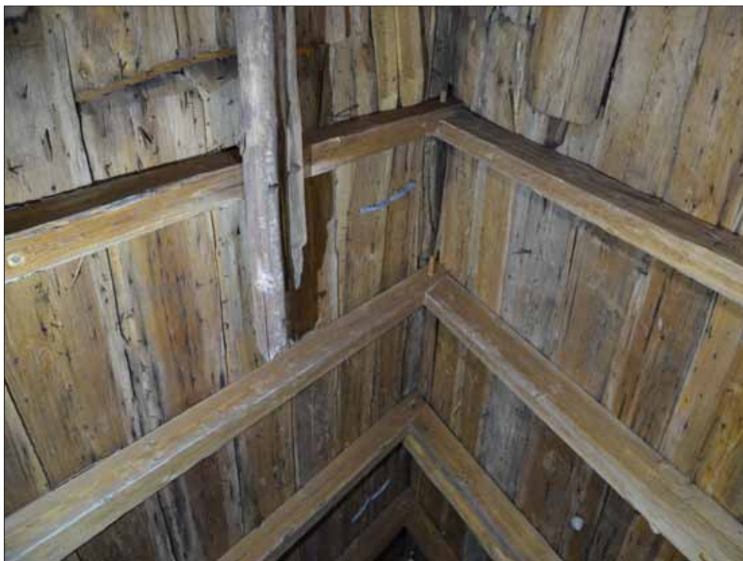
60 Saxsparrarnas möte med högben och hanbjälke (SLM D2015-1401).
