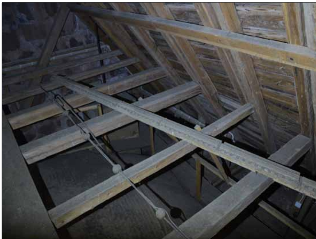
61 Mötet högben-hanbjälke är utfört som bladning med nacke (SLM D2015-1402).
