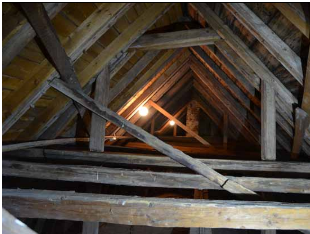
206 Långhusvinden sedd mot öster. Romanska högben med dymlingar för infästning av taktro (SLM D2015-1490).
