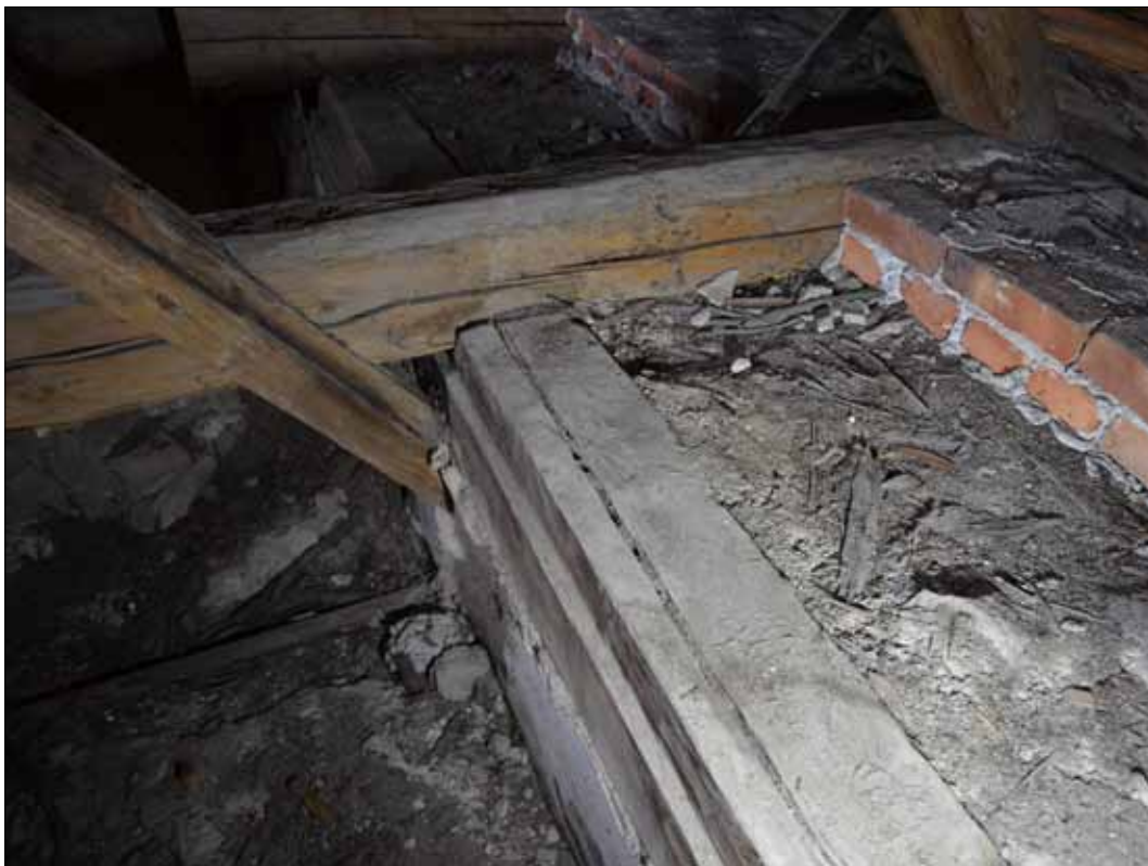
41 Inre remstycket med hylla in mot rummet vilket kan tyda på att kyrkorummet varit täckt med trätunnvalv (SLM D2015-1388).
