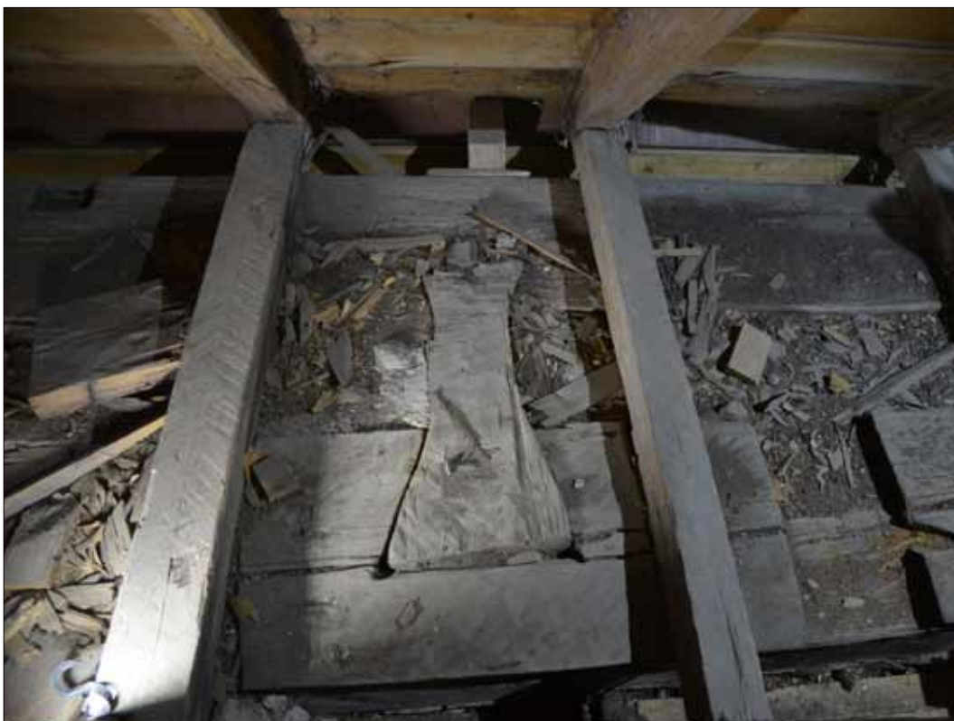
32 Både yttre och inre remstyckena är medeltida men sannolikt av olika generationer eftersom äldre urtag inte korresponderar mot varandra (SLM D2015-1380).
