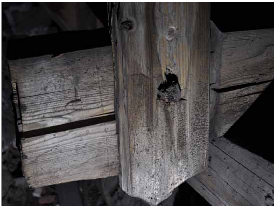
243 Nedre stödbenet löper genom och förbi knuten i tassan. Den slarviga ändkapningen är gjord innan montering. Notera ritsen för knuthakett till vänster om stödbenet (SLM D2015-1514). Foto: Daniel Eriksson.
