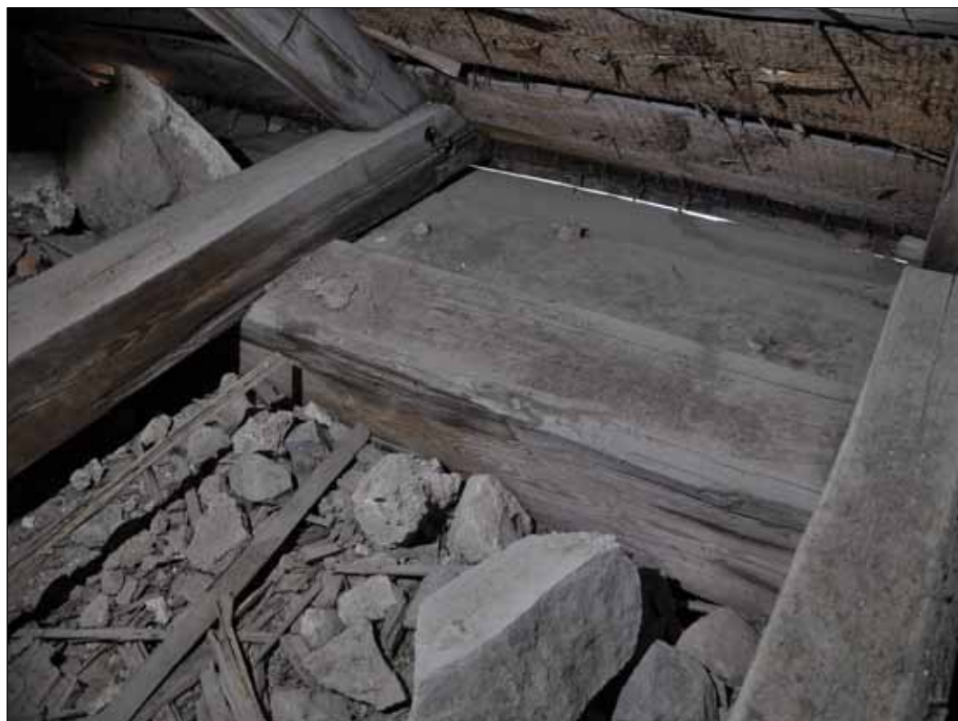
240 Yttre remstycke med vankant, lämplig för dendrodatering. Remstycke ca 23x24 cm. Knutpunkt tass-högben har rak bladning med stor dymling. Tass ca 13x20 cm. Högbenens dimension varierar mycket, medelvärde ca10x16 cm (SLM D2015-1511) Foto: Daniel Eriksson.
