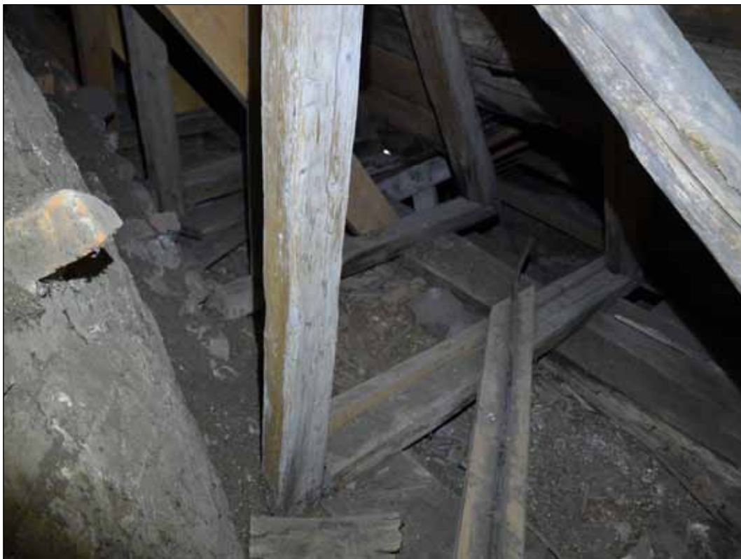
49 Detalj av knäbocken (SLM D2015-1394).
