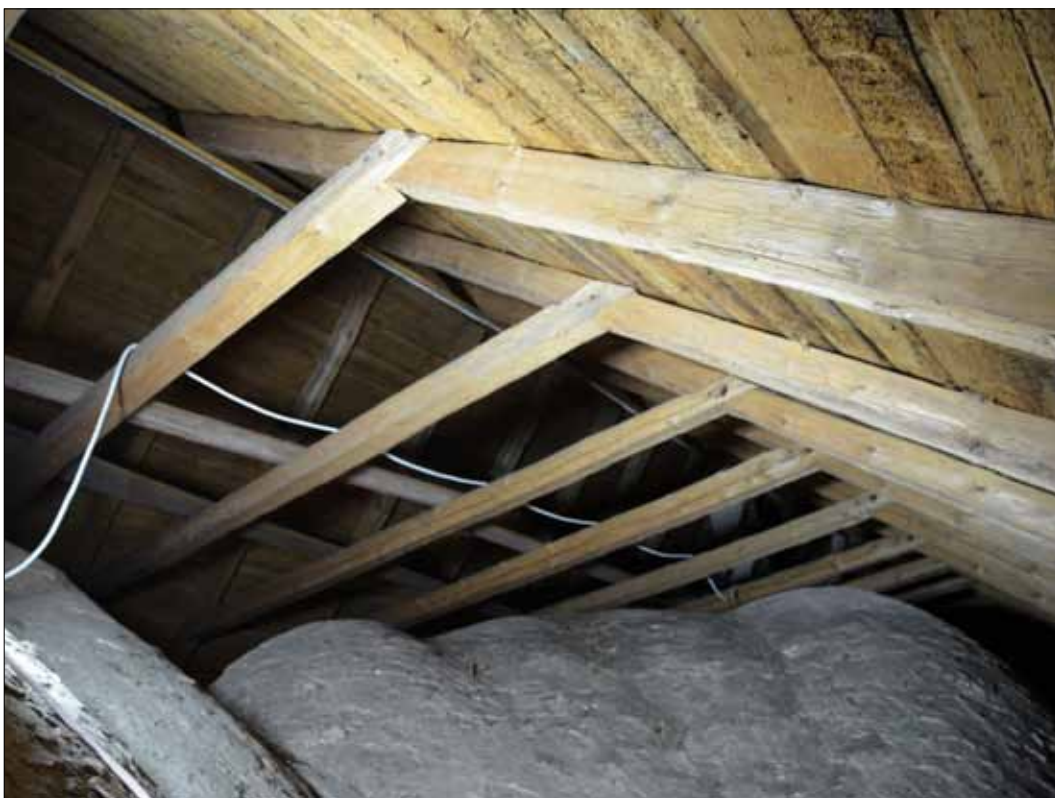
72 Möte hanbjälke-högben utmed det södra takfallet (SLM D2015-1409).
