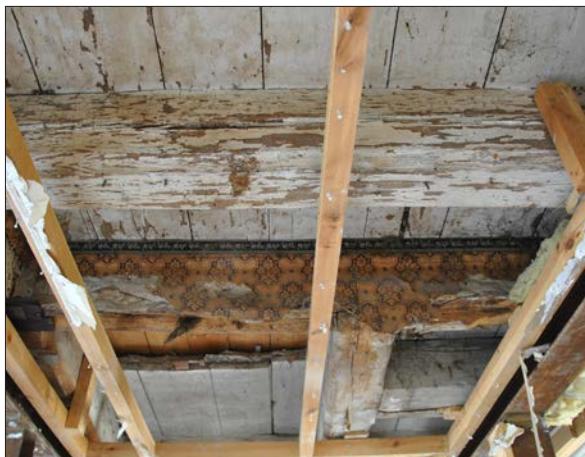
88 På nedre våningen fanns det i rum 103 äldre fasade takbjälkar som varit synliga. Under dessa var senare takbrädor spikade (Slm D2014-360).
