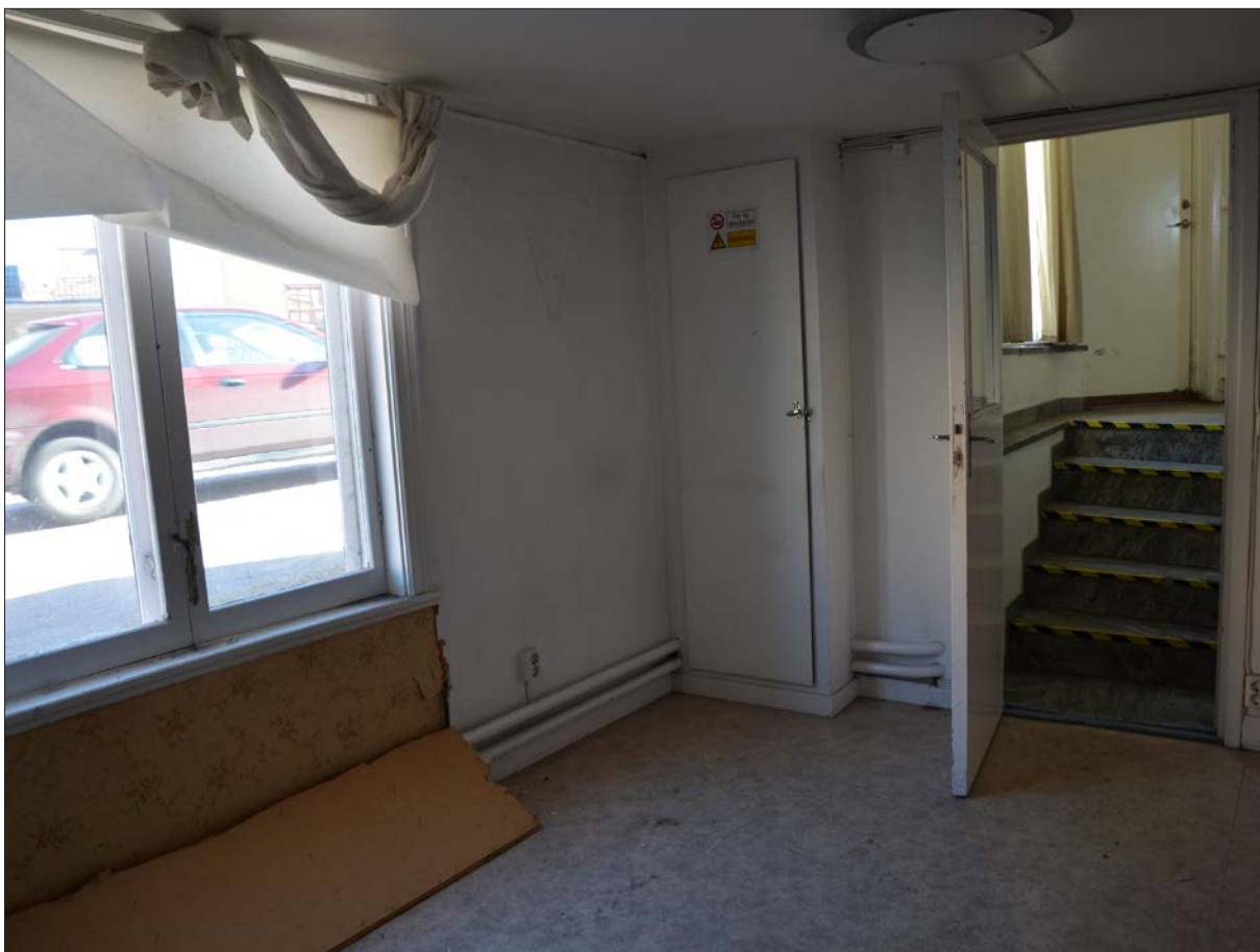
22 Rum 104 i bostadshusets sydöstra hörn, bottenvåningen. Till höger trappan upp mot den tidigare utställningslokalen, hus 1b (SIm D2014-286).
