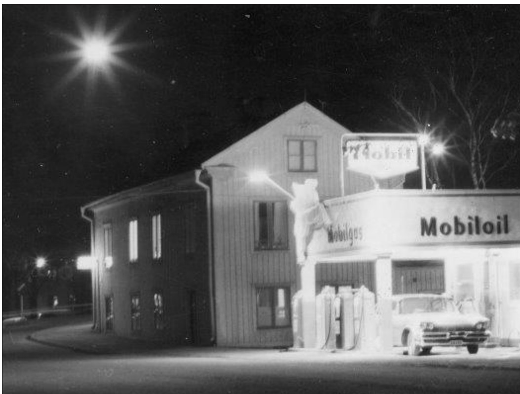
16 Fotografi av bostadshuset och bensinstationen efter år 1958 då gatunivån har höjts (Bildgruppen i Nyköping).
