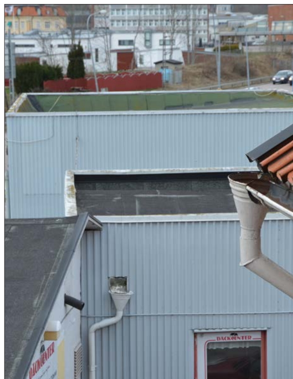
68 Vy från bostadshuset över byggnaderna 7:s tak (närmast) och byggnad 6:s tak (längst bort) (Slm D2014-331).
