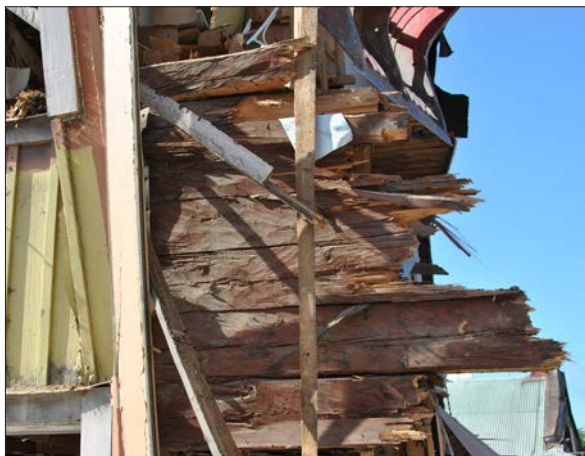
90 Även på östra fasaden var timret handbilat och rödfärgat (Slm D2014-362).
