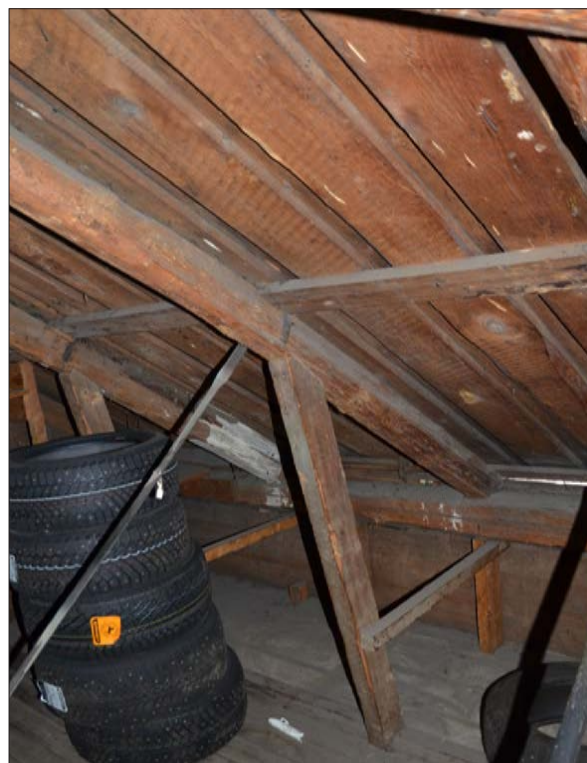
52 På vinden syns ytterväggen av liggande plank (Slm D2014-316).
