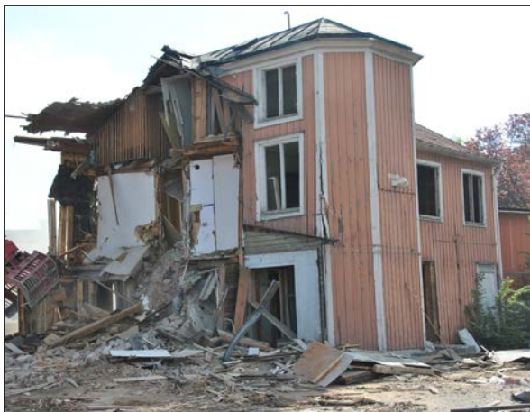
87 Rivningen av bostadshuset den 20 maj 2014 (Slm D2014-359).
