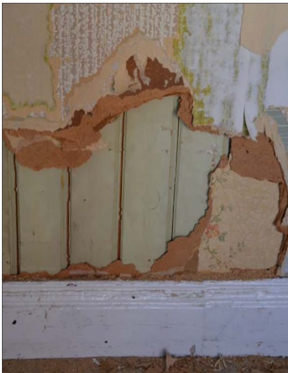
20 Under pappspänning med tapetlager i rum 104 syns den grönmalade pärlspontpanelen (SIm D2014-284).
