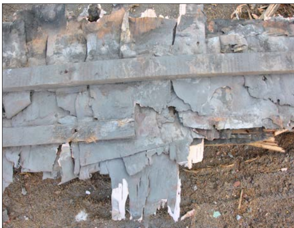
91 Under takteglet var flera lager med näver spikat på takbrädorna (Slm D2014-363).
