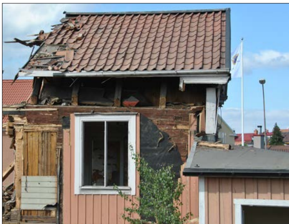
89 Bostadshusets västra fasad. Timret var rödfärgat och handbilat. Till vänster var tidigare verandan. Äldsta fasadpanelen syns (Slm D2014-361).
