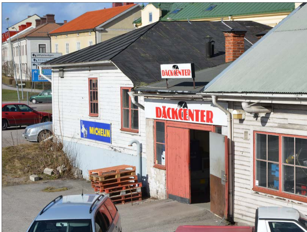
57 Från höger sett hus 5 och 4b, samt del av verkstaden 3 från väster (Slm D2014-321).
