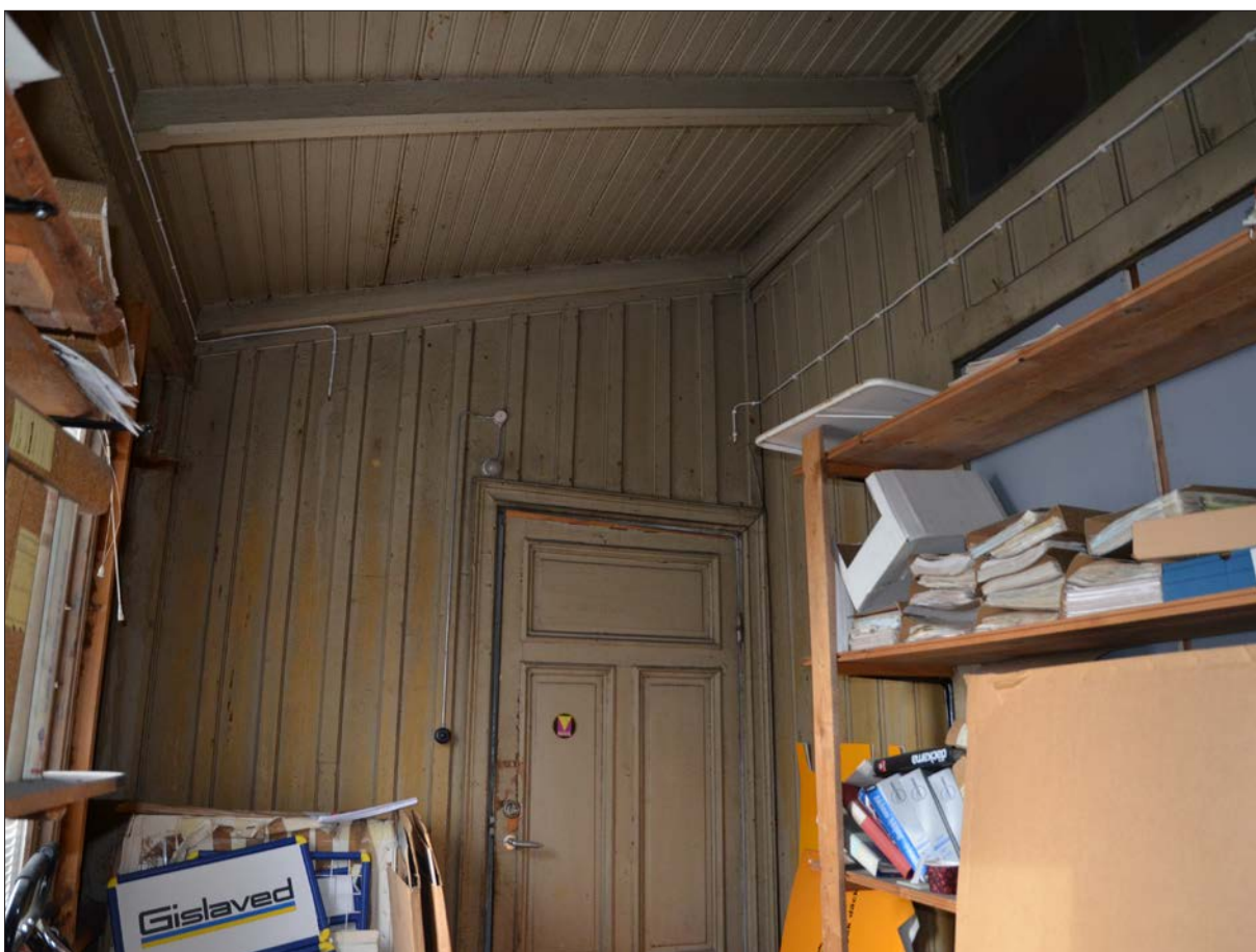
37 Söder om trapphuset ligger det som tidigare varit balkong/veranda, senare benämnt "lager". I rummet syns den näst äldsta fasadpanelen och ytterfönster till höger (Slm D2014-301).
