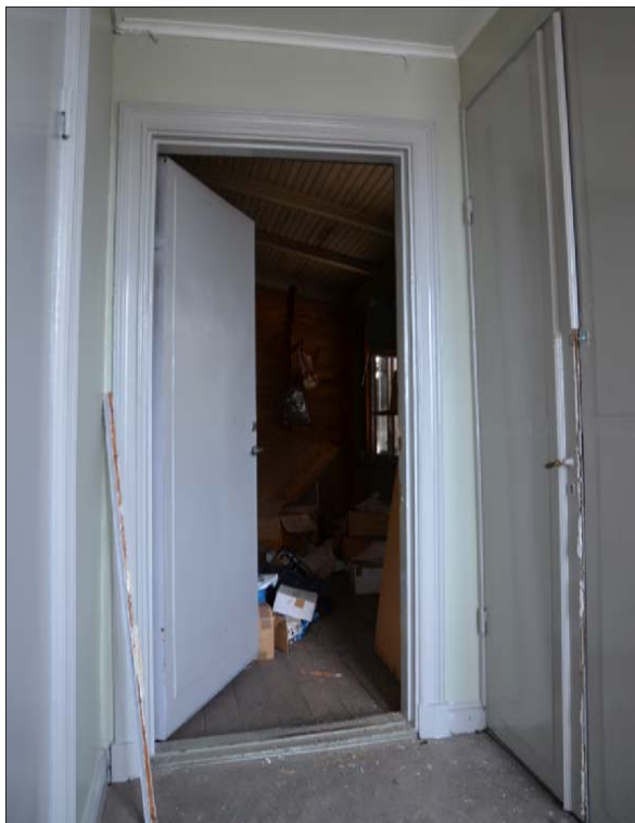
26 Vy av övervåningens farstu, rum 201, sett mot gamla verandan, rum 207. Till höger pardörren som leder upp till vinden (Slm D2014-290).
