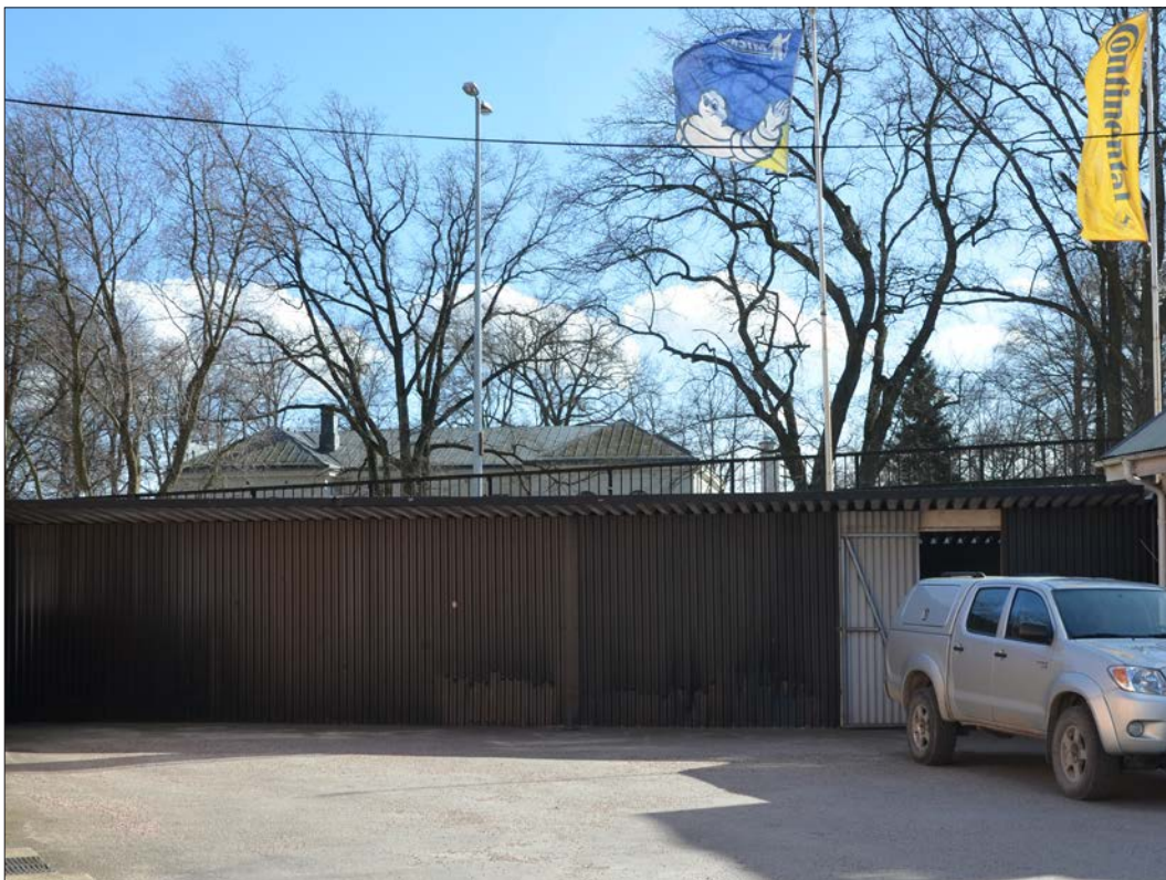
46 Förrådsbyggnaden 2 sedd från norr. Bakom anas teatern (Slm D2014-310).
