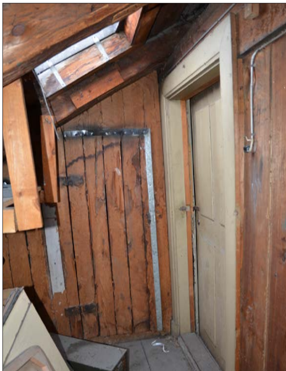
41 Vy av vinden, nordöstra delen. Rummet till höger är ett inrett vindsrum (Slm D2014-305).
