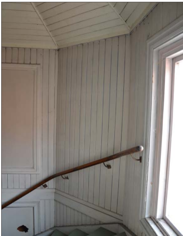
25 Trapphuset i bostadshuset sett från vindsvåningen ned mot farstun på övre våningen (Slm D2014-289).
