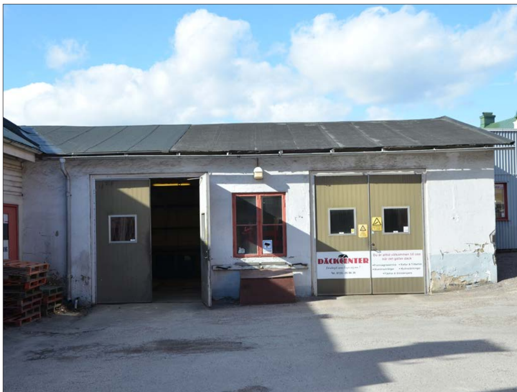
53 Byggnad 4a från söder (Slm D2014-317).
