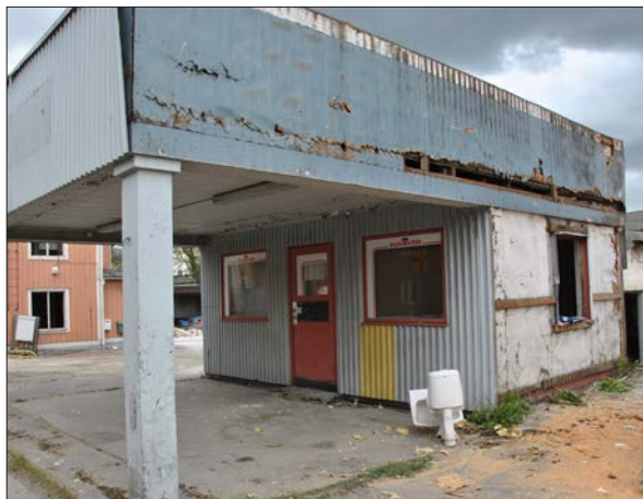
93 Bensinstationen efter det att fasadens plåtinklädnad tagits bort (Slm 2014-365).
