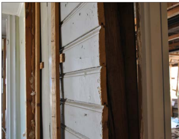
92 Den äldsta fasadpanelen var liggande och spontad (Slm D2014-364).
