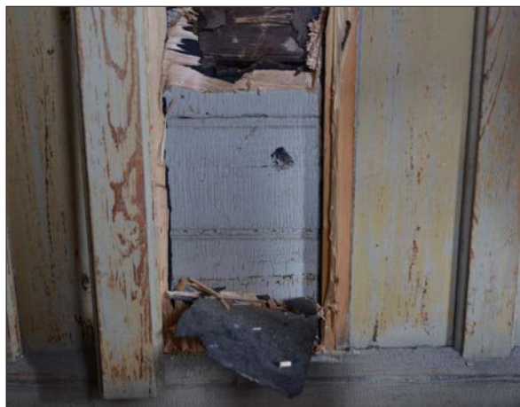
86 Underst den äldsta liggande grönmålade fasadpanelen. Överst den senare breda locklistpanelen (Slm D2014-345).
