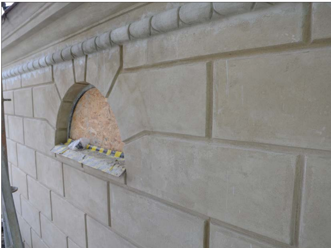
18 Vy av norra fasaden efter putsarbeten, men före avfärgningen (Slm D2013-871).
