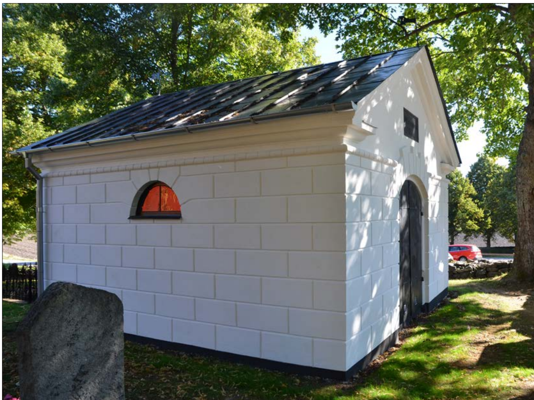
23 Gravkoret sett från nordväst vid slutbesiktningen 3 september 2013 (Slm D2013-873).
