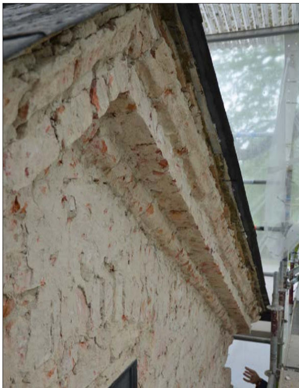
10 Västra gavelns takfotslist (SIm 2013-862).
