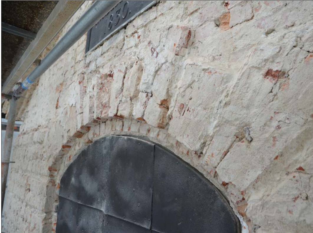
17 Del av västra gaveln efter att putsen har bilats bort (Slm D2013-870).
