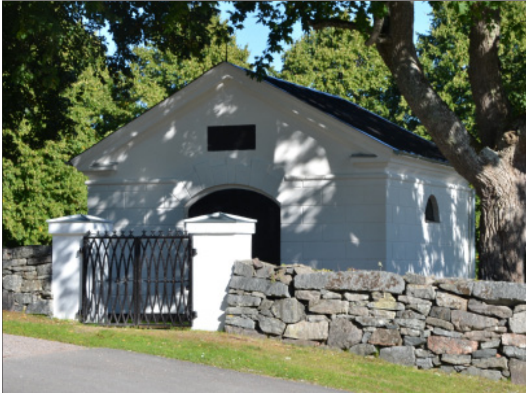
22 Gravkoret sett från sydväst vid slutbesiktningen den 3 september 2013 (Slm D2013-872).
