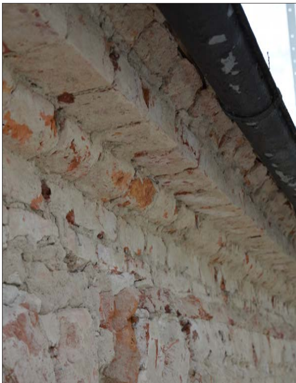
9 Långsidans profilerade takfotslist (D2013-861).
