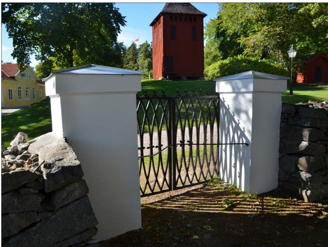
20 Grindstolparna efter åtgärder vid slutbesiktningen den 3 september 2013. Ny plåttäckning lades nu på stolparna (Slm D2013-875).
