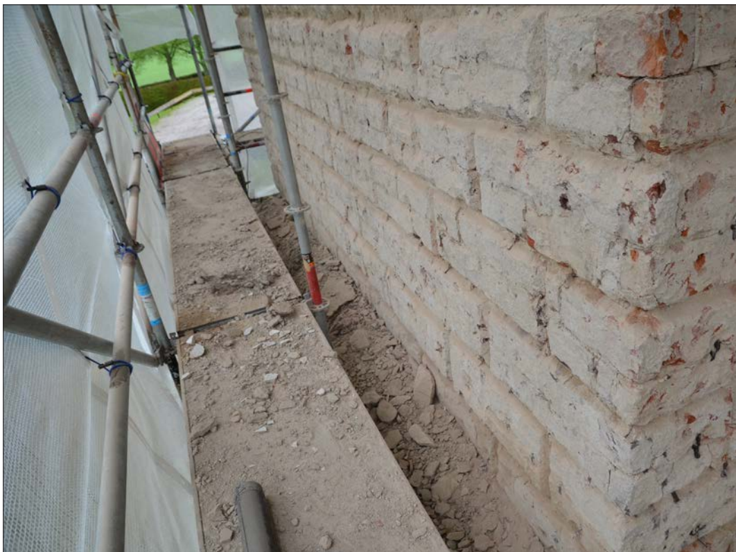
14 Kvaderindelningen har byggts upp av stortegel (Slm D2012-866).
