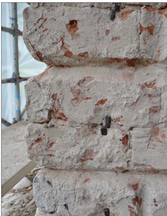
11 Detalj av ett hörn. Tegelstenarna såg ut att vara huggna före påmurning och har kramlats fast med smidda järnkramlor (SIm D2013-863).
