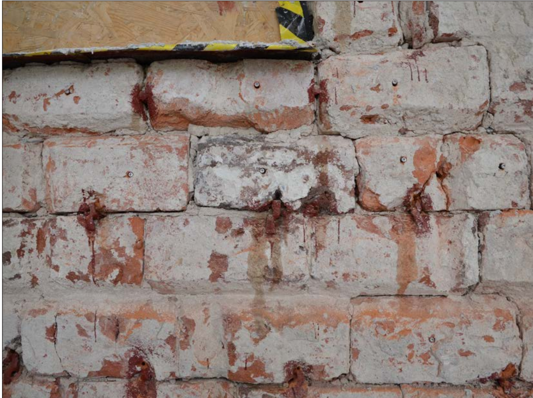
13 De flesta järnkramlorna togs inte bort. De dränktes med Isotrol grundolja, varefter de målades med rostskyddsfärg. I bild syns även skalmursförankringen som sattes i lösa tegelstenar (Slm D2013-865).
