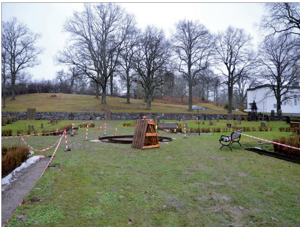
4 Arbetsområdet från sydväst i samband med anläggningsarbetet (Slm D13-372).
