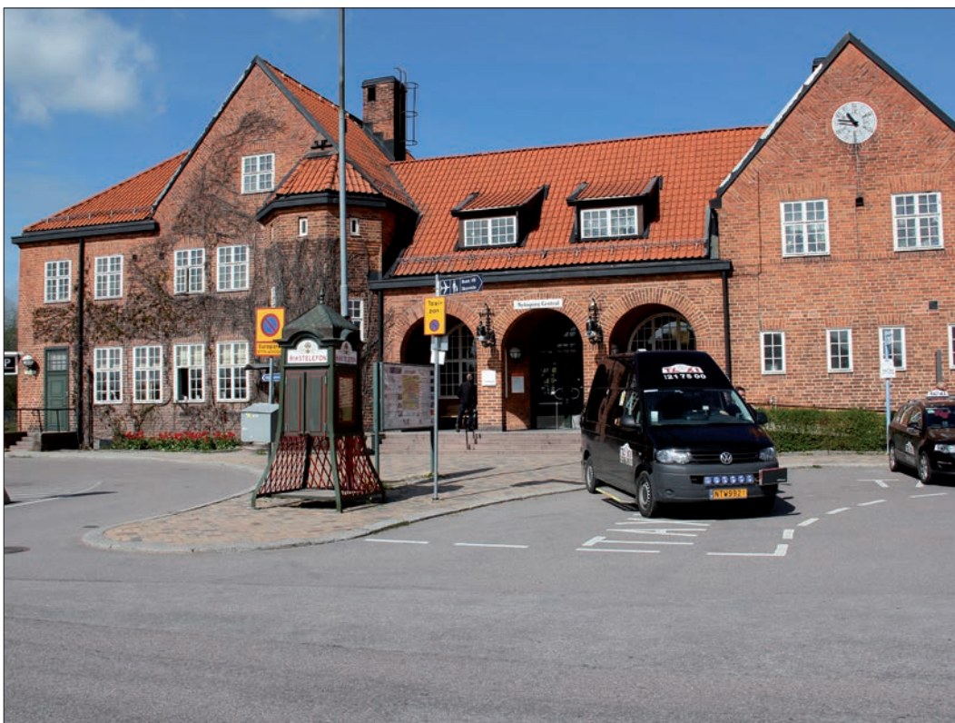
61 På Nyköpings stationshus framhävs inte vestibulen i höjdded. Här markeras den istället med en öppen entréloggia (Slm D12-0472).
