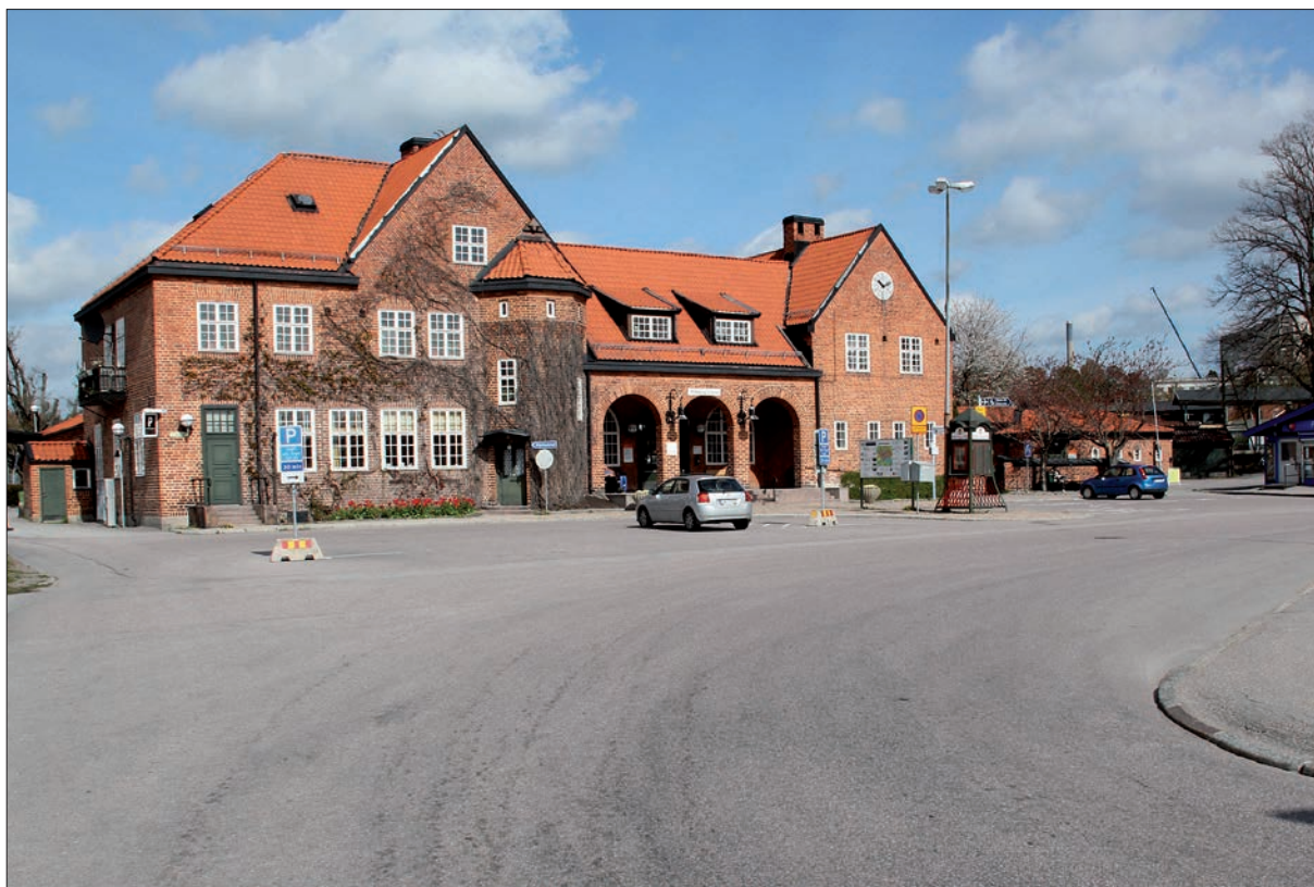
63 Centralplan och Nyköpings stationshus (Slm D12-0473).
