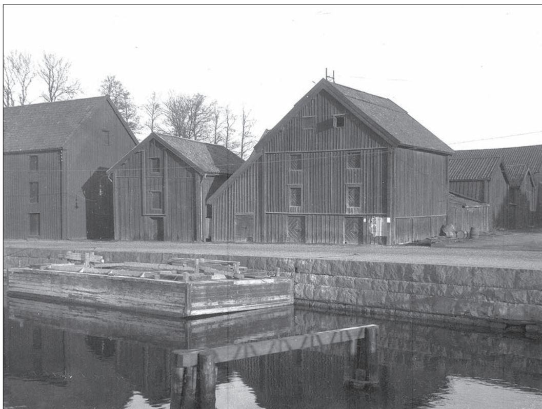
4 På bilden, som troligen är tagen under perioden 1922-1935, börjar tillbyggnadens pulpettak vid nuvarande Rökeriets norra takfall . Fotograf Dan Samuelsson, bilden är något beskuren (Nyköpings kommuns bildarkiv DS586).
