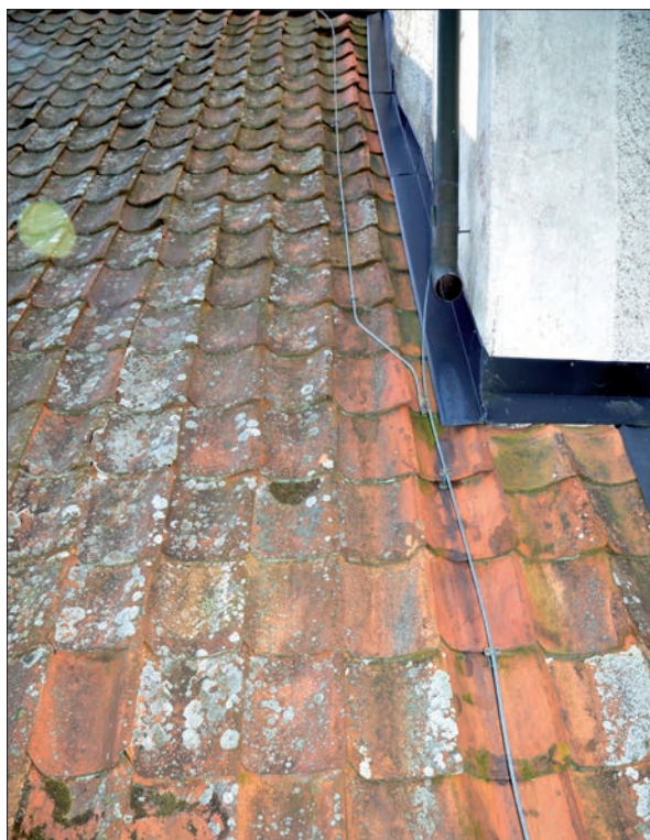
3 Det norra takfallets möte med tornets östra mur innan arbetet påbörjades (Slm D12-0785).
