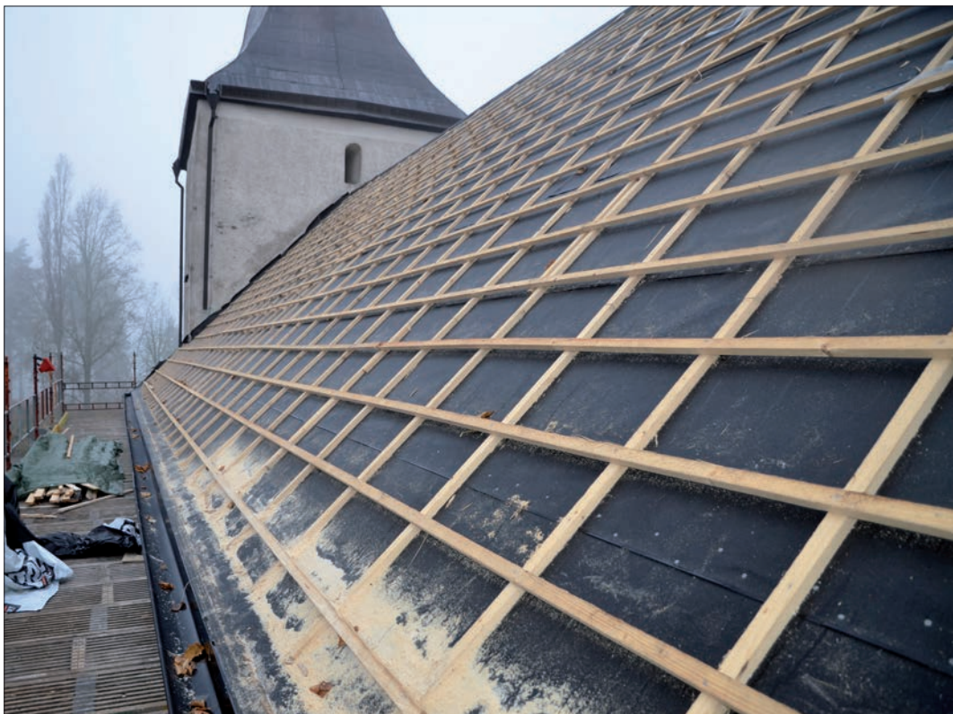
8 Det södra takfallet innan återläggning av takteglet (Slm D12-0790).
