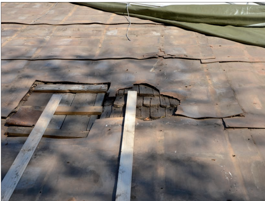
6 Luckan till vinden markerar läget för skorstenen för den kamin som utgjorde kyrkans uppvärmningsanordning omkring sekelskiftet 1900. Till höger om luckan ses det bevarade spåntaket (Slm D12-0788).
