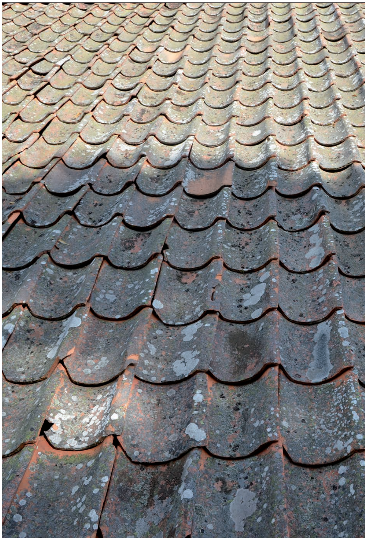
16 Det gamla takteglet på långhusets södra takfall innan arbetet påbörjades (Slm D12-0798).
