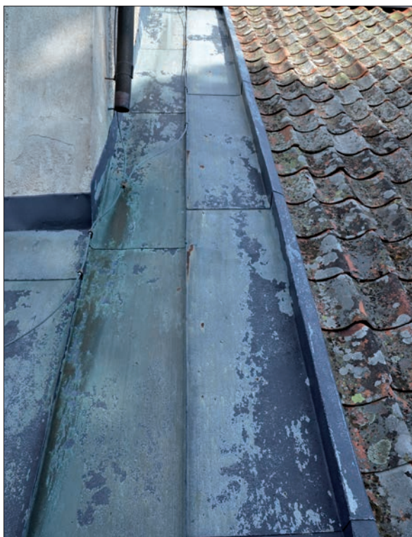
4 Rännan mellan långhusets södra takfall och tornet innan arbetet påbörjades (Slm D12-0786).
