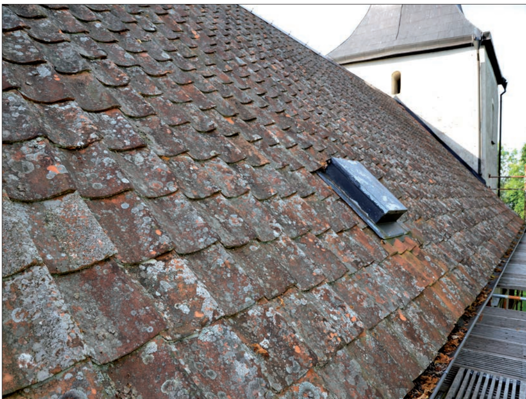
9 Långhusets norra takfall innan arbetet påbörjades (Slm D12-0791).
