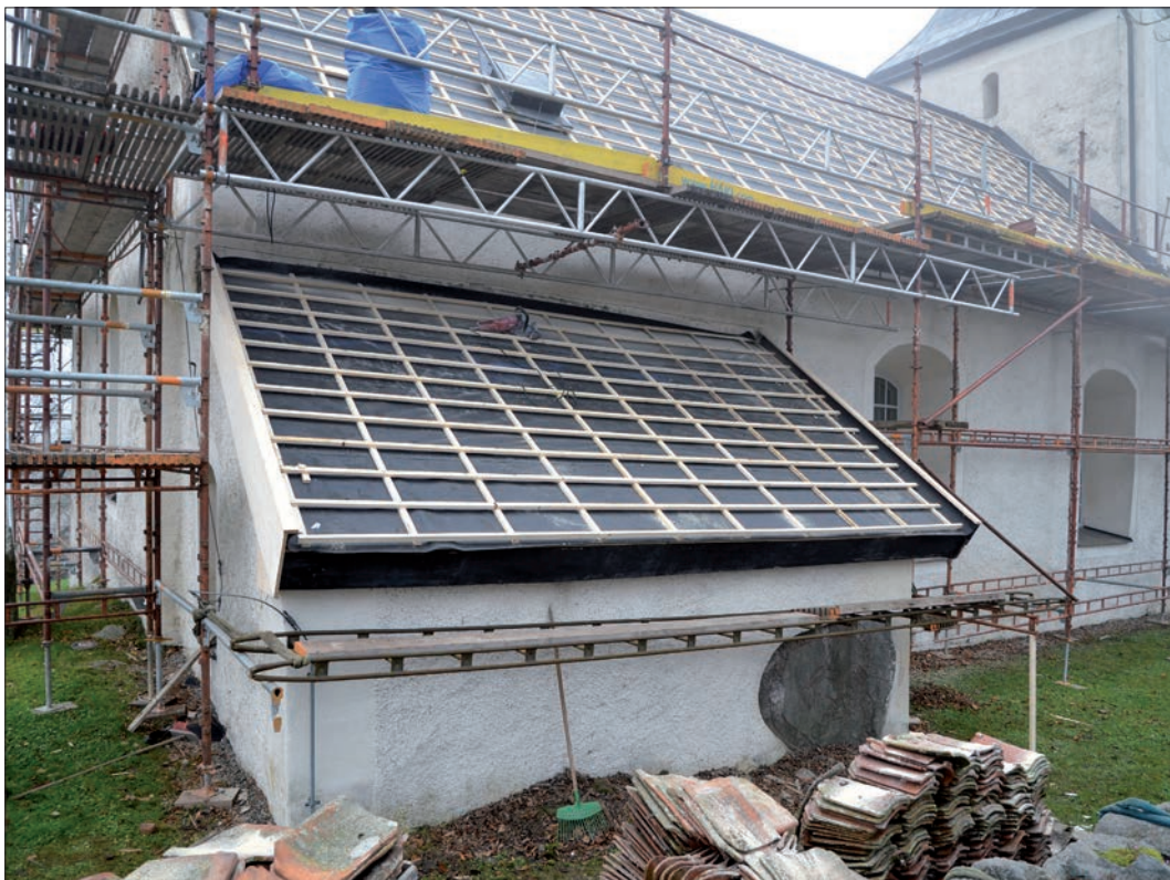
12 Sakristians pulpettak strax innan takteglet återlades (Slm D12-0794).
