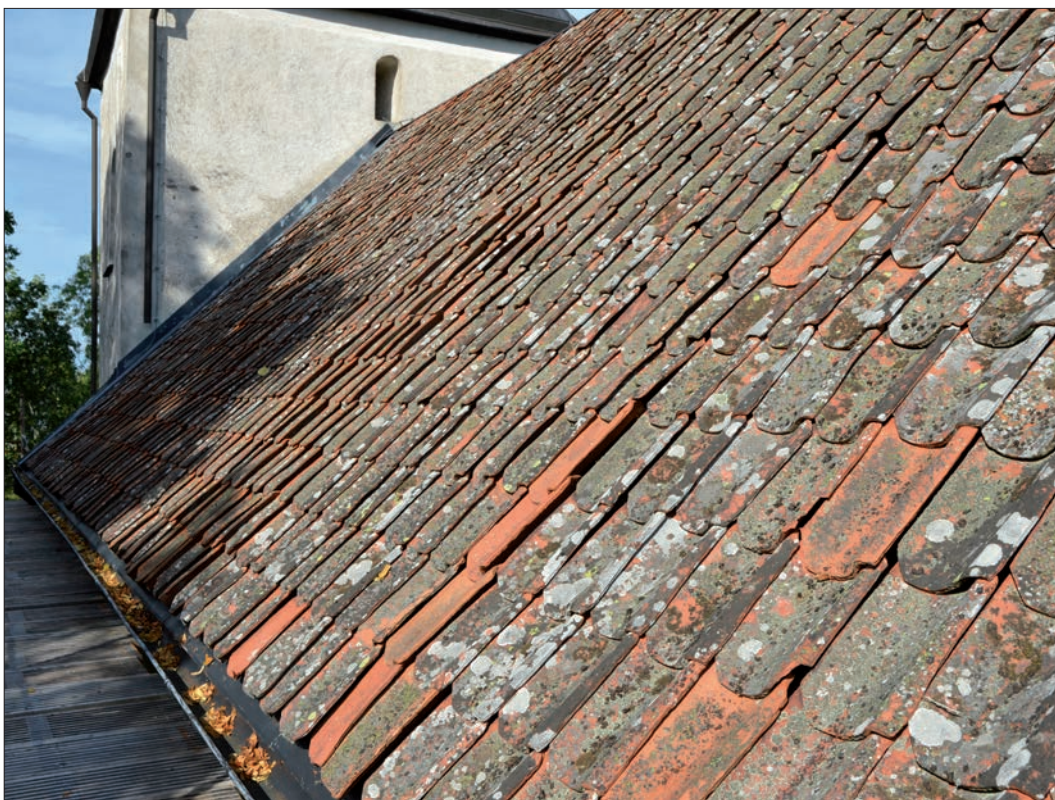
5 Långhusets södra takfall innan arbetet med takomläggningen påbörjades (Slm D12-0787).
