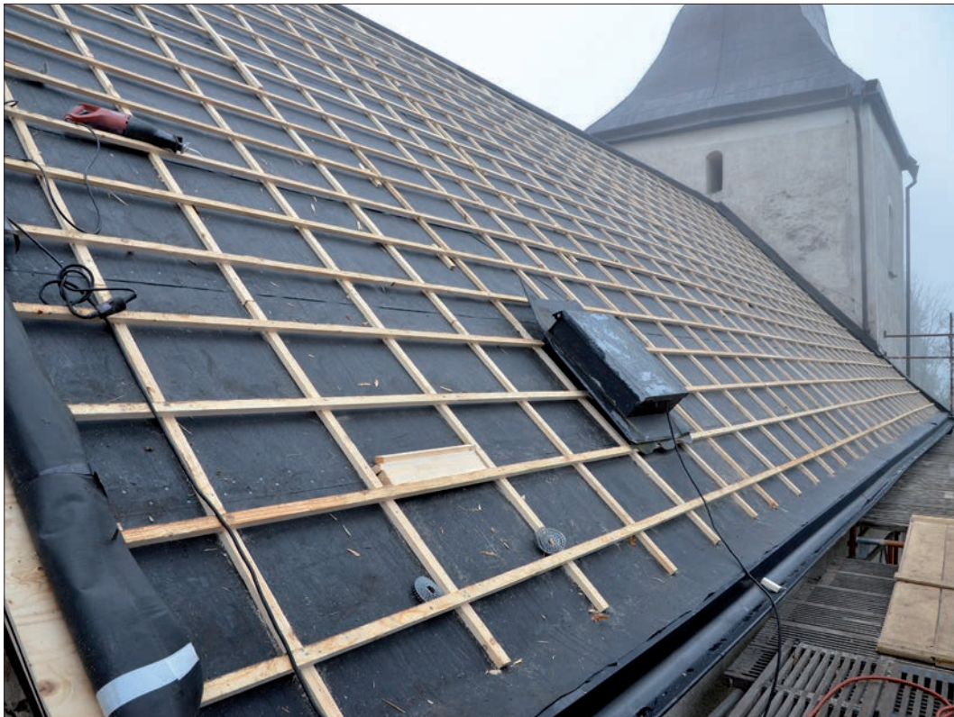
11 Det norra takfallet i samband med spikning av ny strö- och bärläkt (Slm D12-0793).
