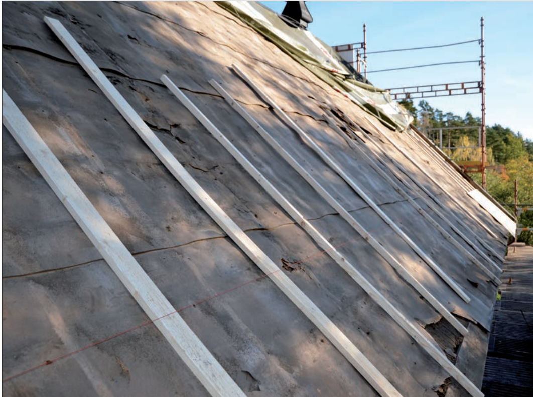
7 Svackor i takfallet riktades ut med hjälp av reglar (Slm D12-0789).
