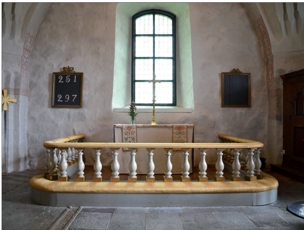
15 Koret och altarringen innan arbetet påbörjades (Slm D12-0925).
