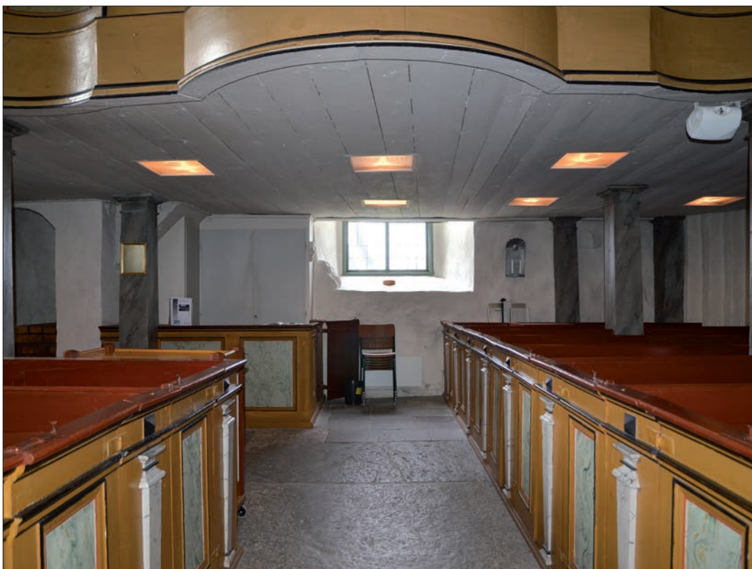
7 Kyrkorummets västra del innan arbetet påbörjades (Slm D12-0917).
