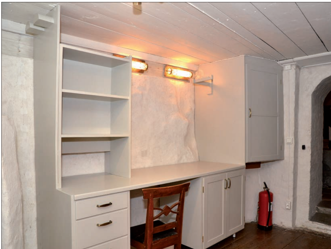
12 Sakristian efter avslutade arbeten (Slm D12-0922).
