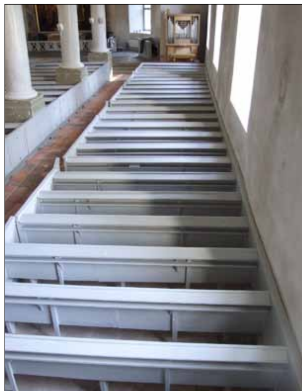
17 Kyrkans södra sidoskepp före demontering av bänkinredning och bröstningspanel (Slm D11-296).
