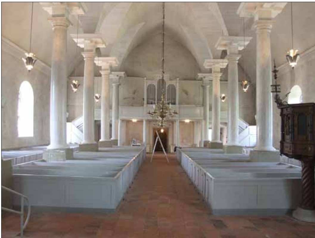
21 Kyrkorummet från koret i öster före ombyggnaden och restaureringen 2009-10 (Slm D11-300).
