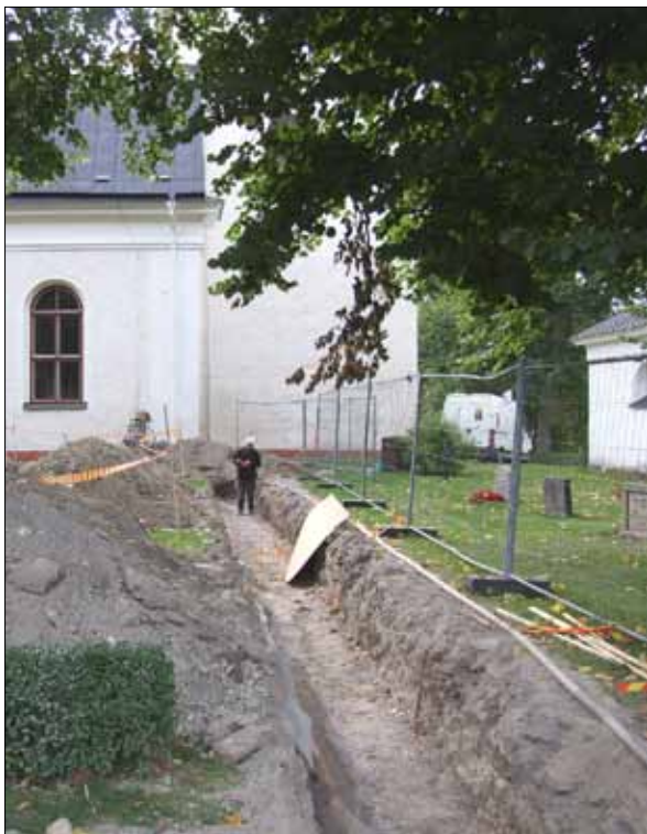
3 Schakt för kulverten mellan ekonomibyggnaden och kyrkan (Slm D10-304).
