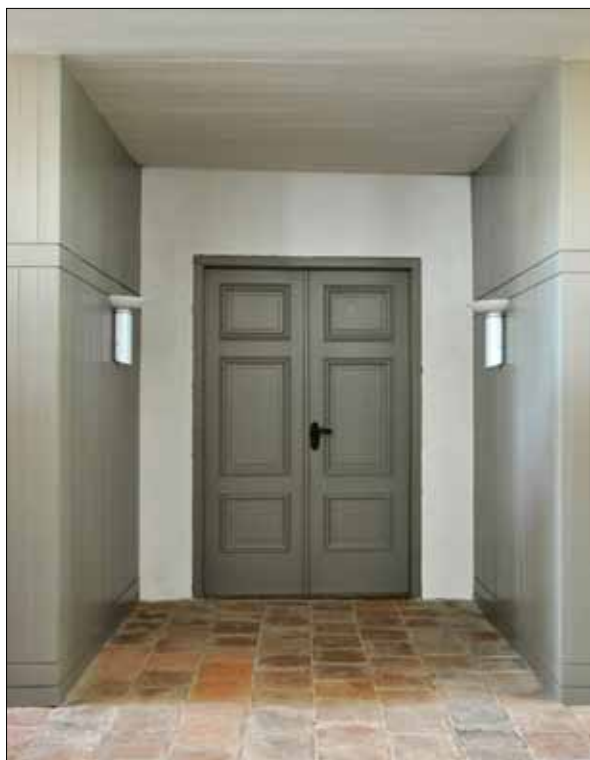
23 Passage mot dörren till tornets bottenvåning från öster (Slm D11-302).
