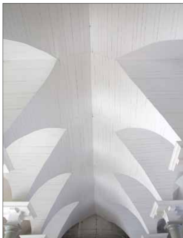
8 Mittskeppets kryssvalv av trä tillkom på 1820-talet (Slm D10-309).
