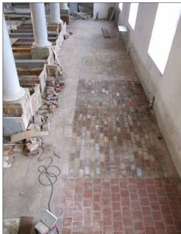
18 Det södra sidoskeppet efter återläggning av tegelgolvet (Slm D11-297).
