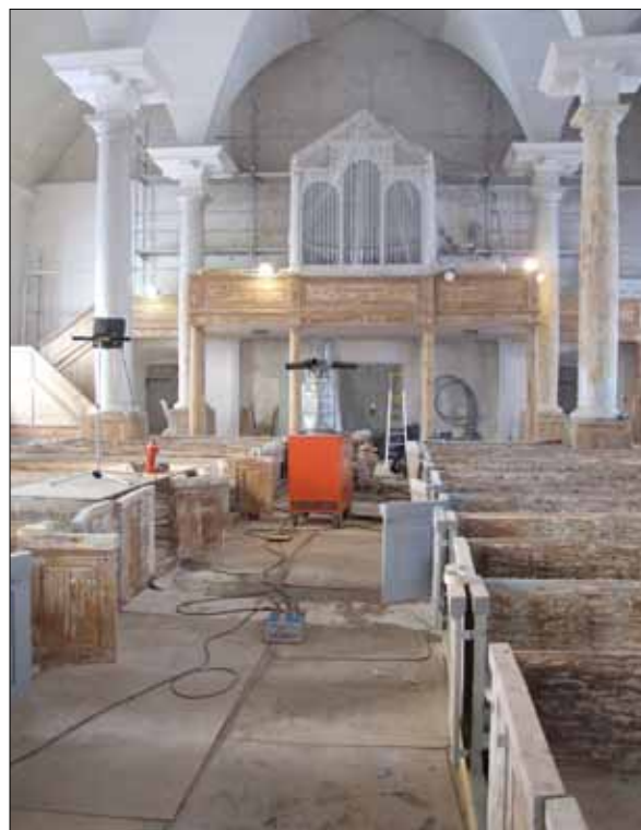
5 Mittskeppet från öster i samband med borttagning av färg på inredningen (Slm D10-306).
