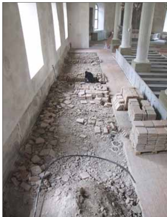
11 Norra sidoskeppet efter demontering av befintligt tegelgolv (Slm D11-291).
