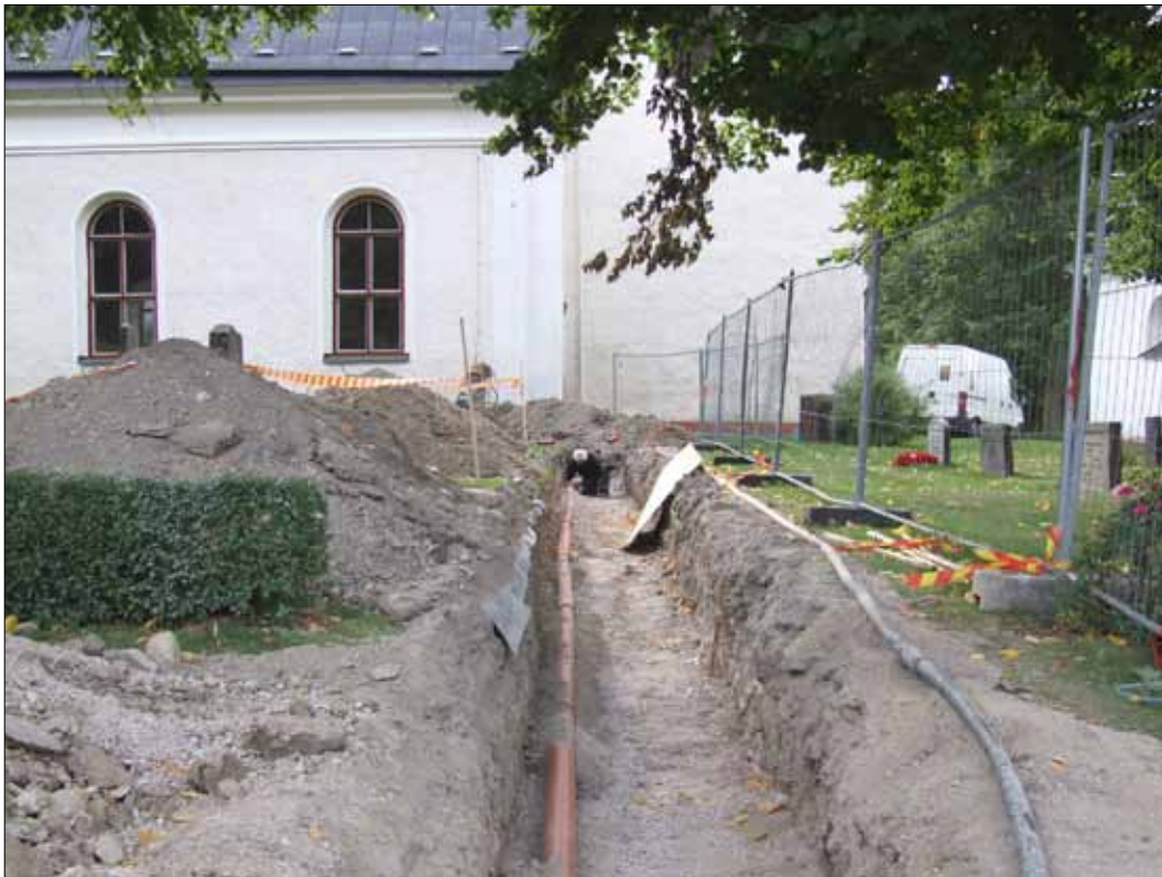
9 Utvändiga schakt var redan delvis återfyllda då Sörmlands museum skulle genomföra den arkeologiska schaktövervakningen (Slm D10-310).
