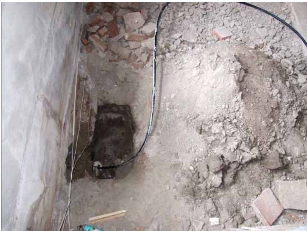
10 Schaktet för inkommande ledningar i det norra sidoskeppets nordvästra hörn (Slm D11-290).
