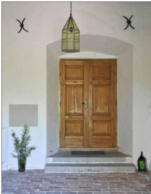
29 Den tidigare trärampen kunde tas bort i samband med ombyggnaden i och med att sidoingångarna kommer att tillgängliggöras (Slm D11-308).
