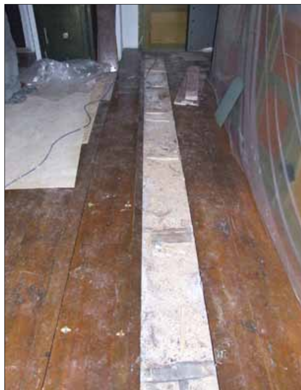
27 I sakristian lyftes en av golvplankorna för att dölja värmeledningsdragningsarna (Slm D11-306).
