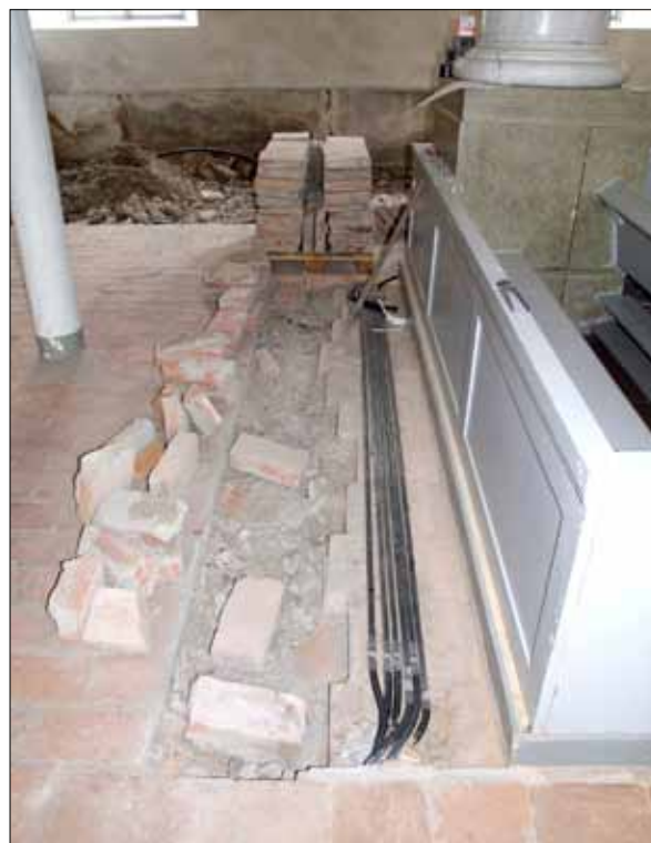
12 Läget för del av ledningsschaktet till nyinrättad toalett (Slm D11-292).
