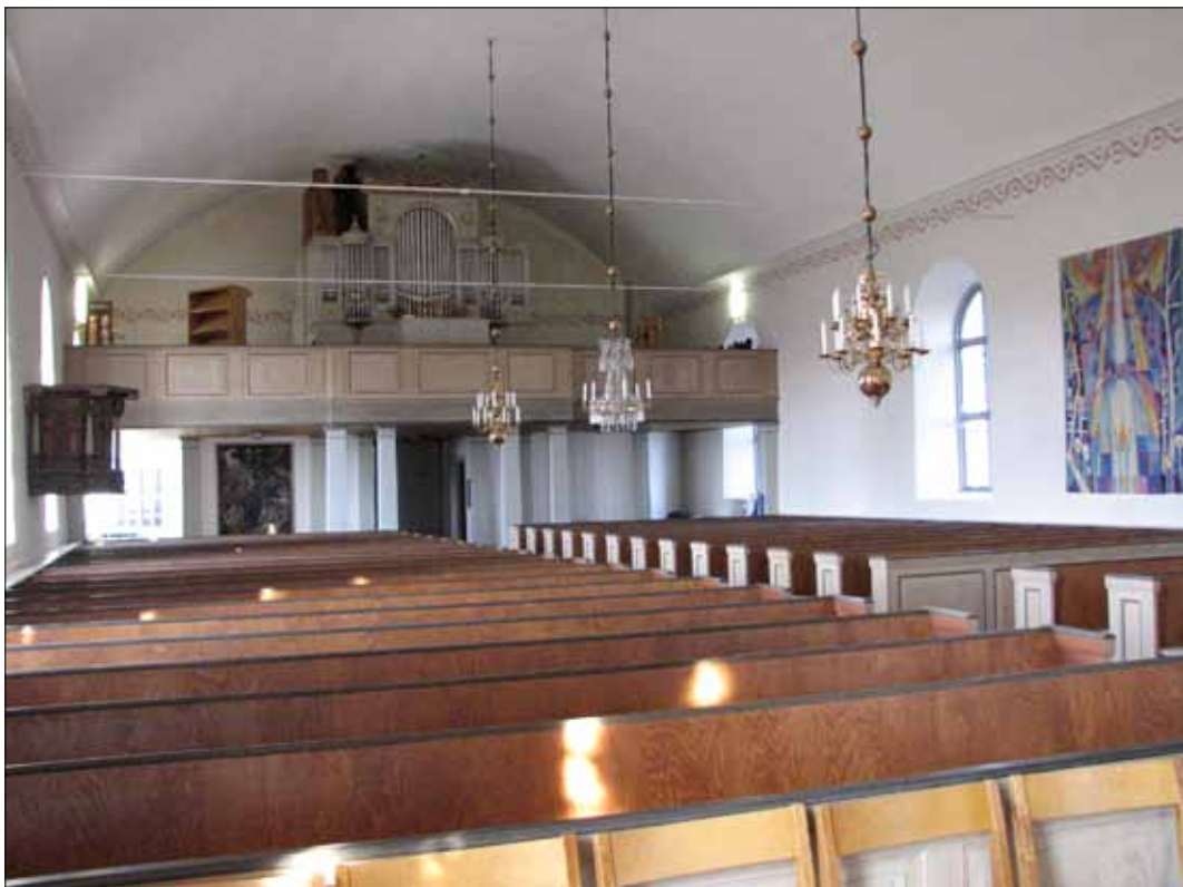
12 Kyrkorummet från sydost före utförda åtgärder. Foto: Kiladalens församling.
