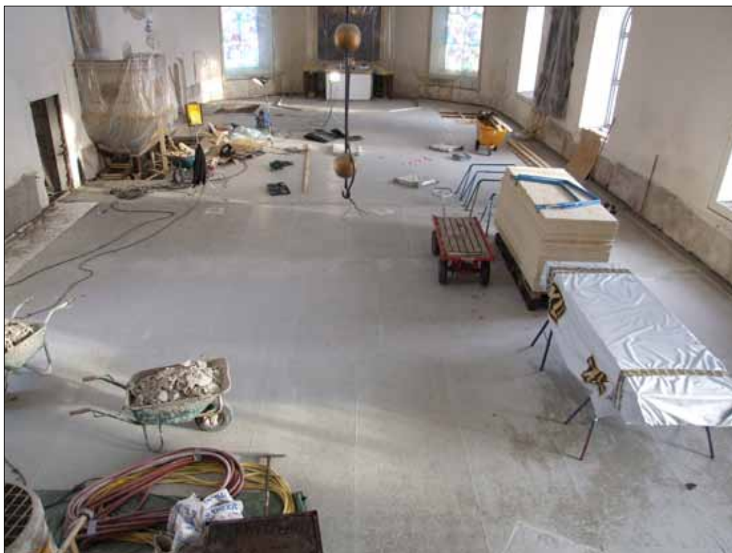
17 Kyrkorummet efter avslutad gjutning av ny betongplatta (Slm D11-419).
