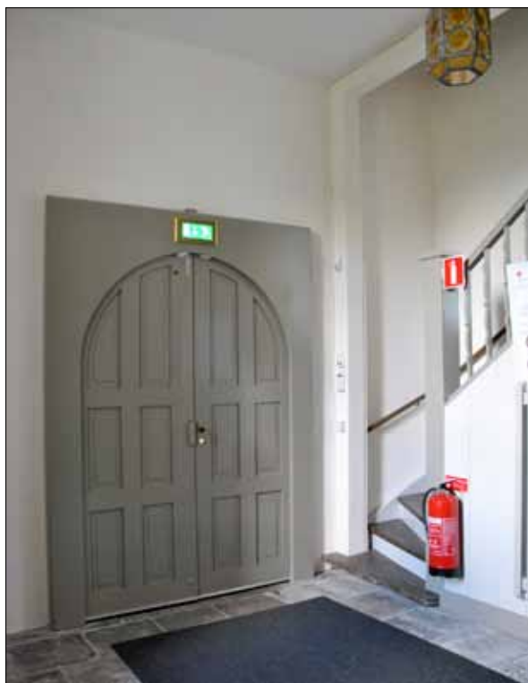
39 Västingången efter avslutade arbeten (Slm D11-440).
