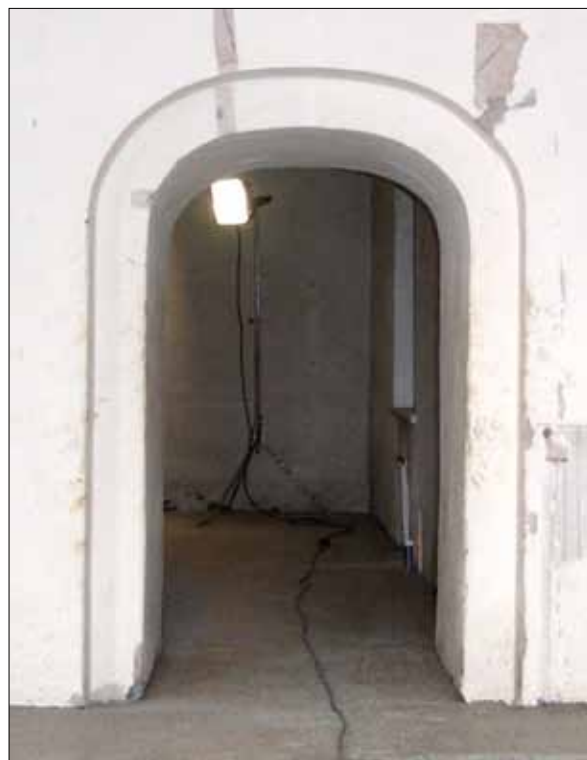
26 Dörröppningen mellan koret och sakristian före rivningen (Slm D11-427).
