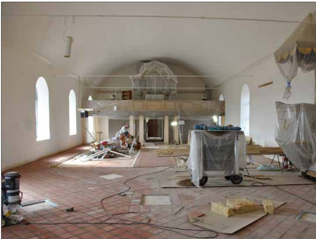
18 Kyrkorummet från öster i slutfasen av golvlägningsarbetet (Slm D11-420).
