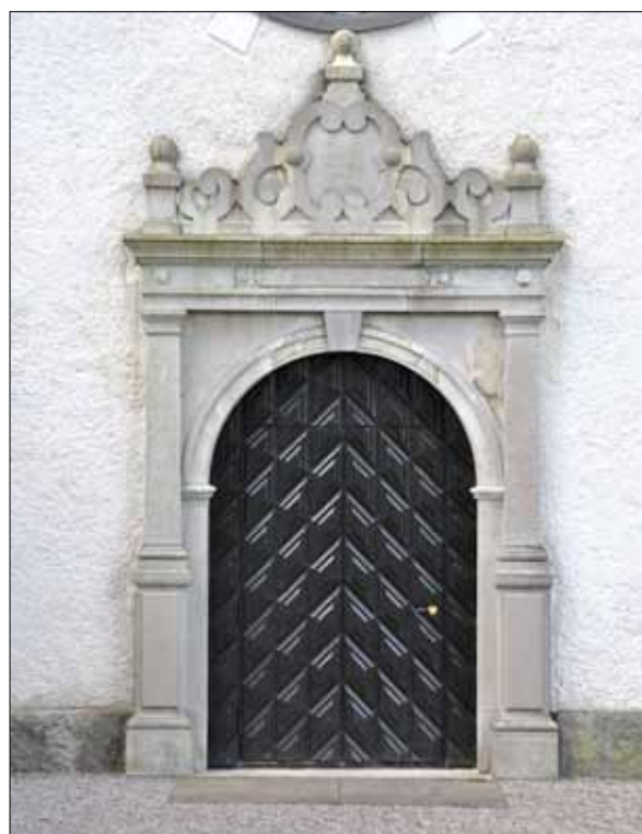
41 Kyrkans norra portal efter avslutad ombyggnad (Slm D11-442).
