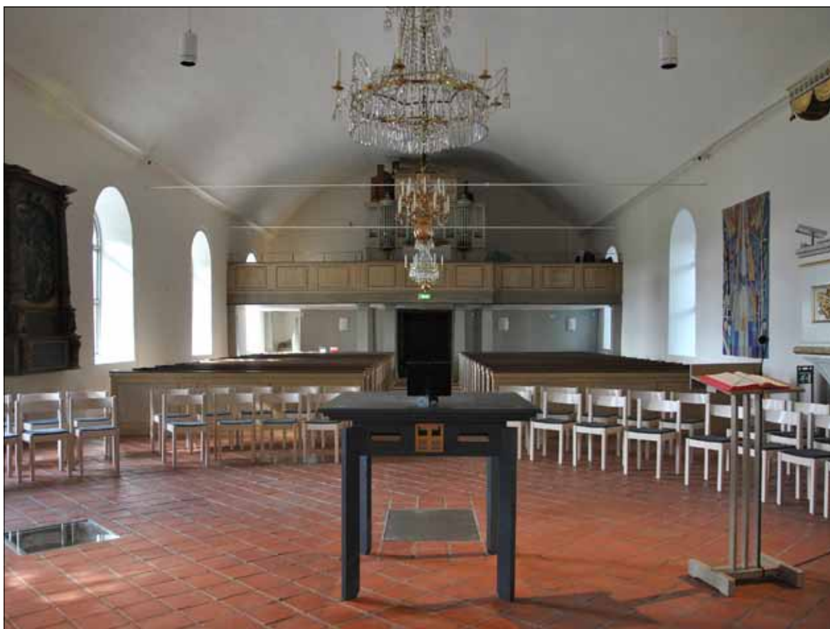
5 Kyrkorummet från koret i öster efter avslutade arbeten (Slm D10-1228).
