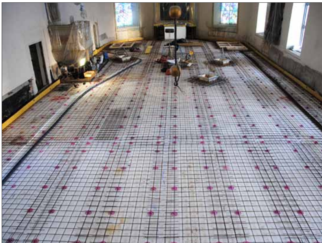
16 Kyrkorummet från orgelläktaren i väster under förberedelserna för gjutning av det nya underlagsgolv (Slm D11-418).
