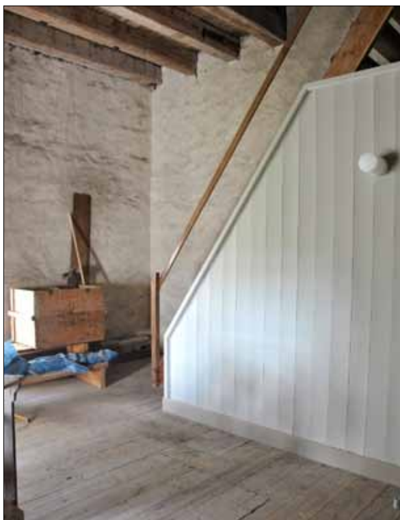
25 Värmeisolerande inklädnad av trappan mellan tornets första och andra plan (Slm D11-426).
