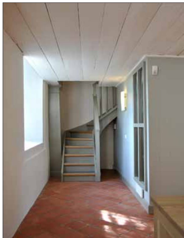
20 Trappan till orgelläktaren är efter ombyggnaden placerad i kyrkorummets sydvästra hörn och nås från kyrktorget (Slm D11-422).
