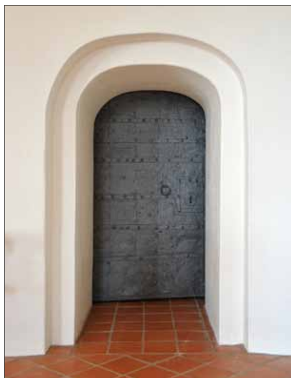
27 Dörröppningen mellan koret och sakristian efter rivning, höjning och uppmurning (Slm D11-428).
