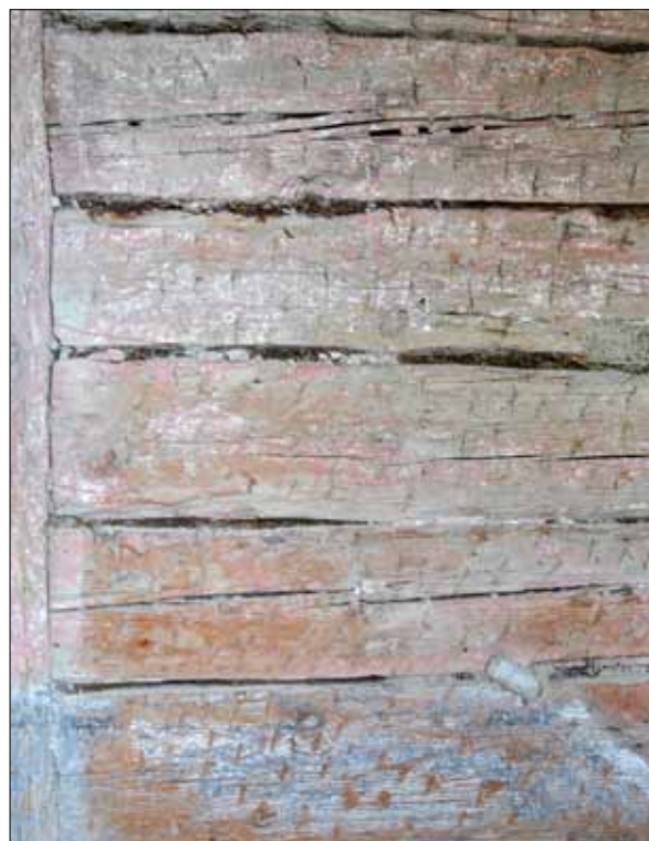
27 Stänkmålat väggparti på igensatt dörr mellan rum 107 och rum 110, sett från rum 107 (Slm D11-665).
