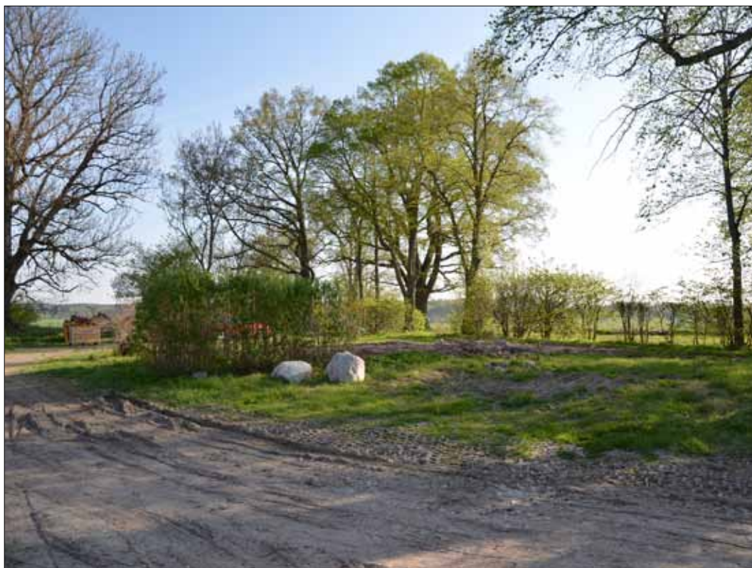
54 Läget för parstugan efter avslutad demontering (Slm D11-692).
