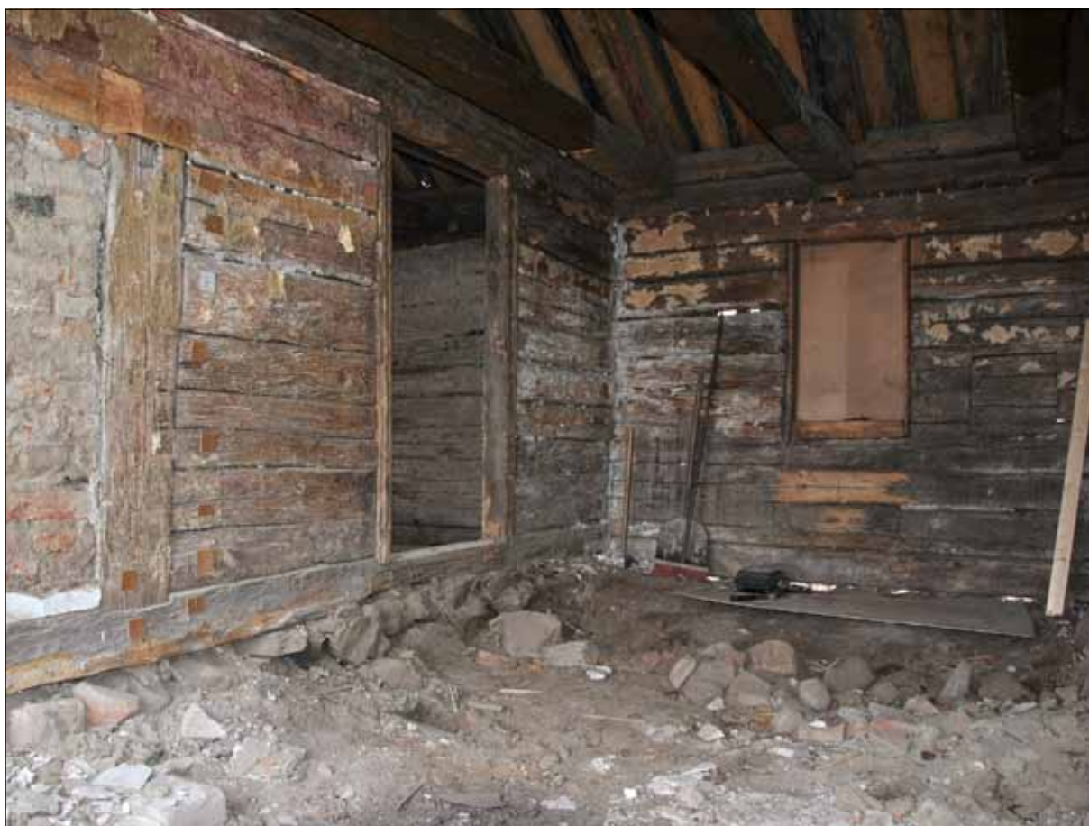
49 Rum 201 från sydväst under demonteringsarbetet (Slm D11-687).
