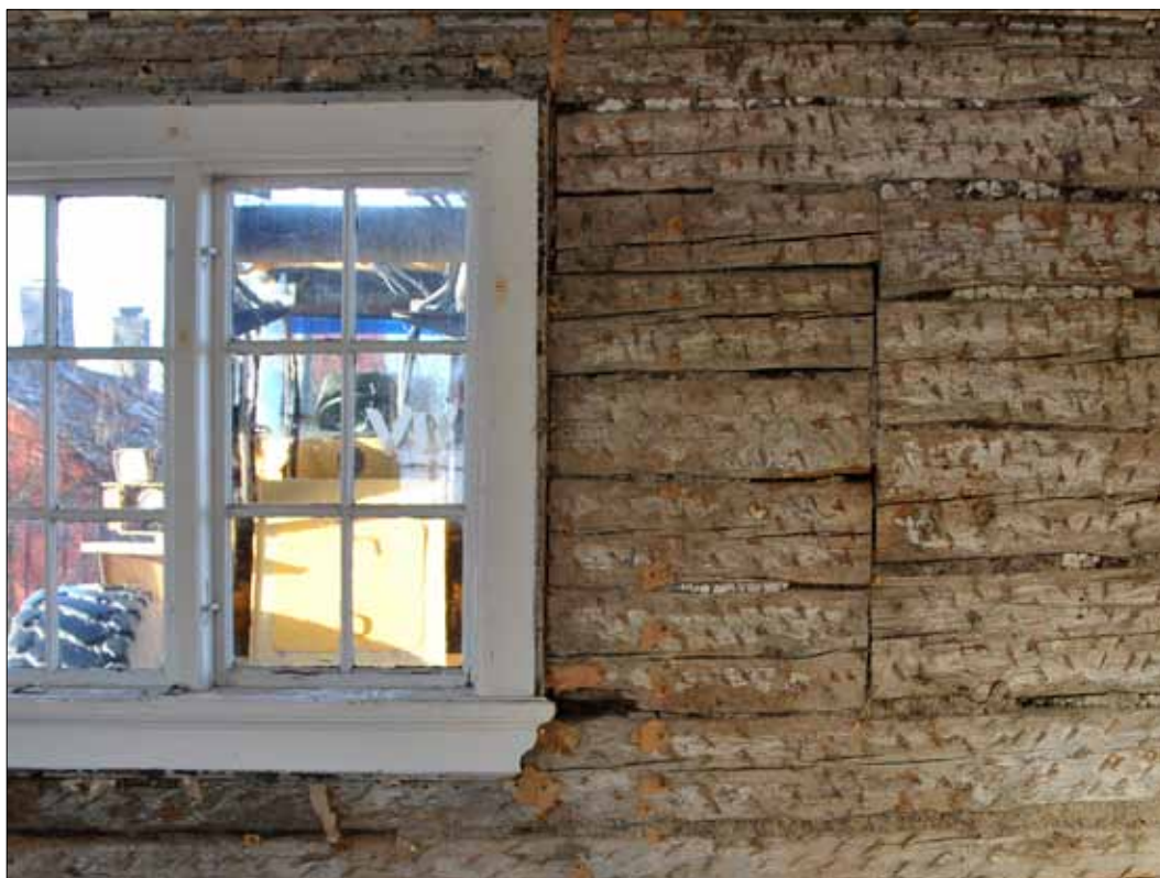
19 Igensatta äldre fönsteröppningar, här i rum 102, visar att fönstren har varit mindre i ett tidigare skede i byggnadens historia (Slm D11-657).
