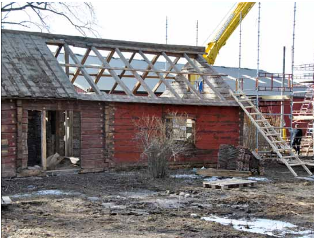
46 Stommen i påbyggnaden åt väster var troligen inte uppförd av återanvänt timmer (Slm D11-684).
