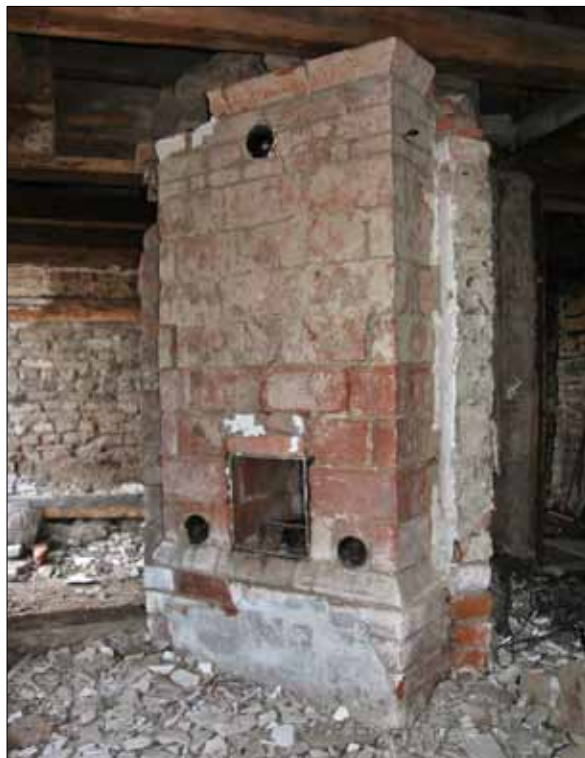
52 Rörspisen i rum 202 efter nedtagning av putsen (Slm D11-690).
