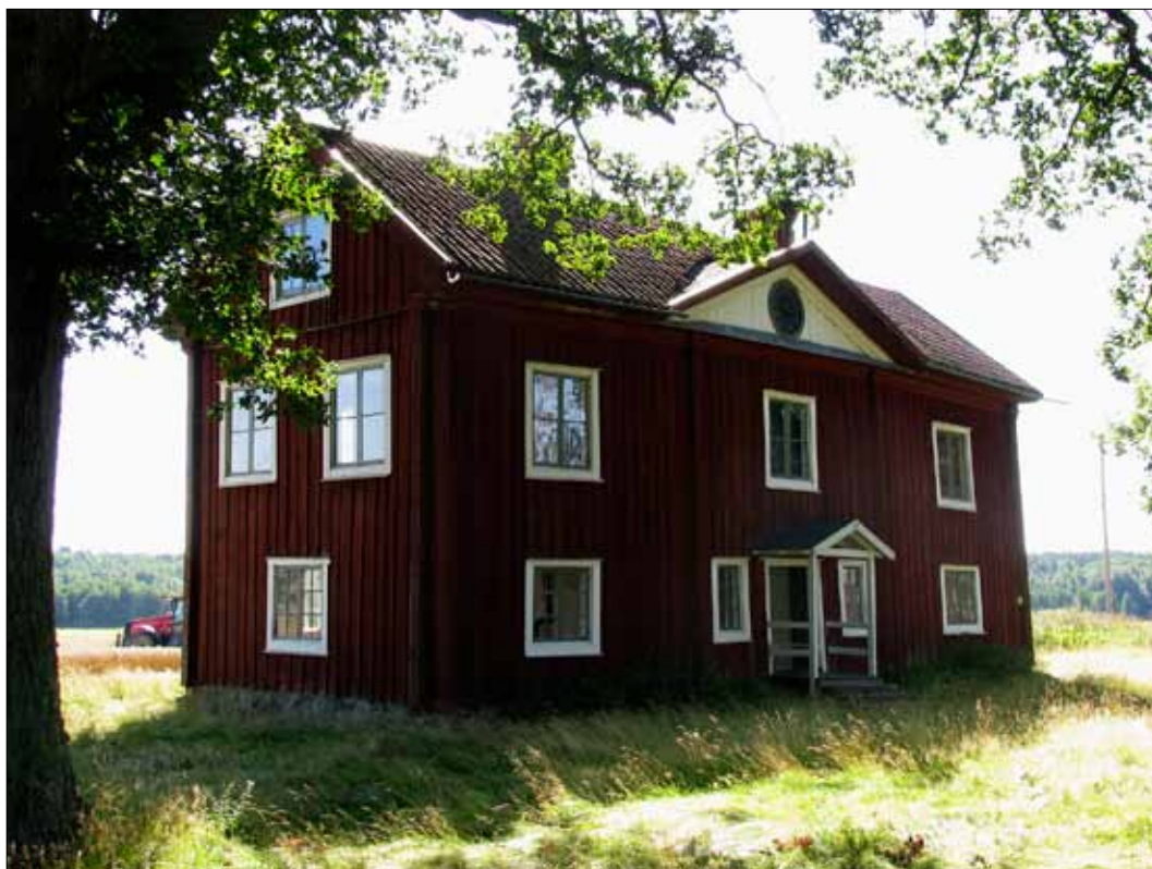
5 Manbyggnaden i augusti 2009 (Slm D11-647).
