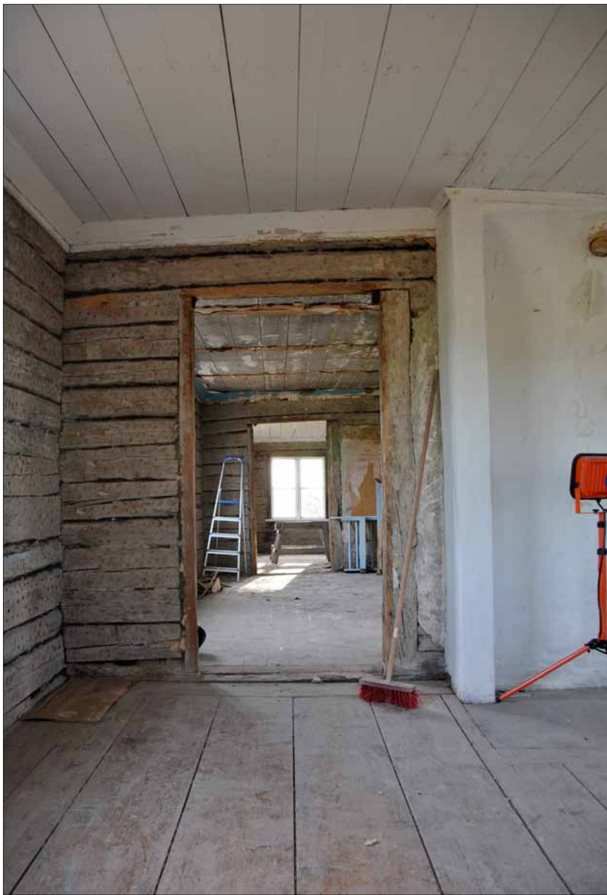
56 Manbyggnadens övervåning under demonteringsarbetet. Fotografiet är taget i rum 111 mot rum 109 & 110 (Slm D11-694).
