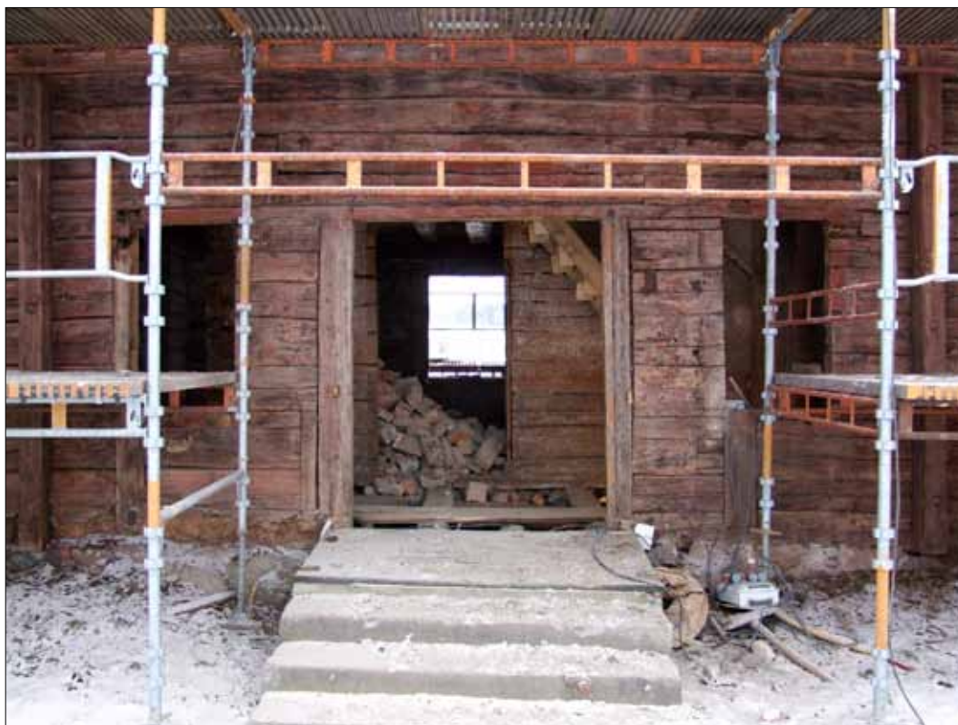
18 Ingången till manbyggnaden efter demontering av fasadpanelen (Slm D11-656).
