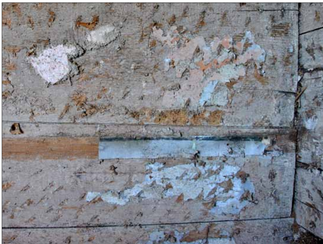
25 Bevarade ytskikt på väggen mellan rum 108 och rum 109 (Slm D11-663).
