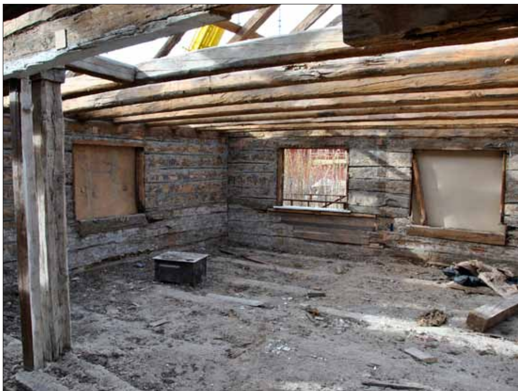
50 Tillbyggnaden från nordost strax före demonteringen av stommen (Slm D11-688).
