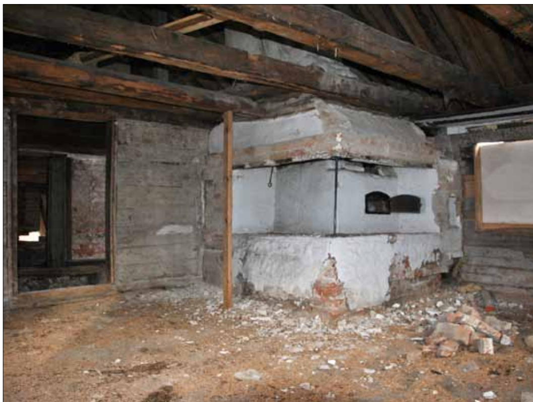
51 Rum 204 från sydost efter demontering av ytskikt, inredning, golv och innertak (Slm D11-689).
