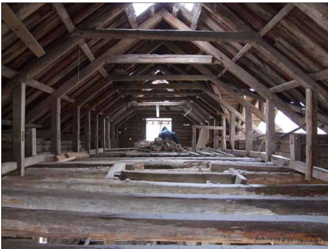
23 Manbyggnadens vind vid demontering av en av skorstensstockarna (Slm D11-661).
