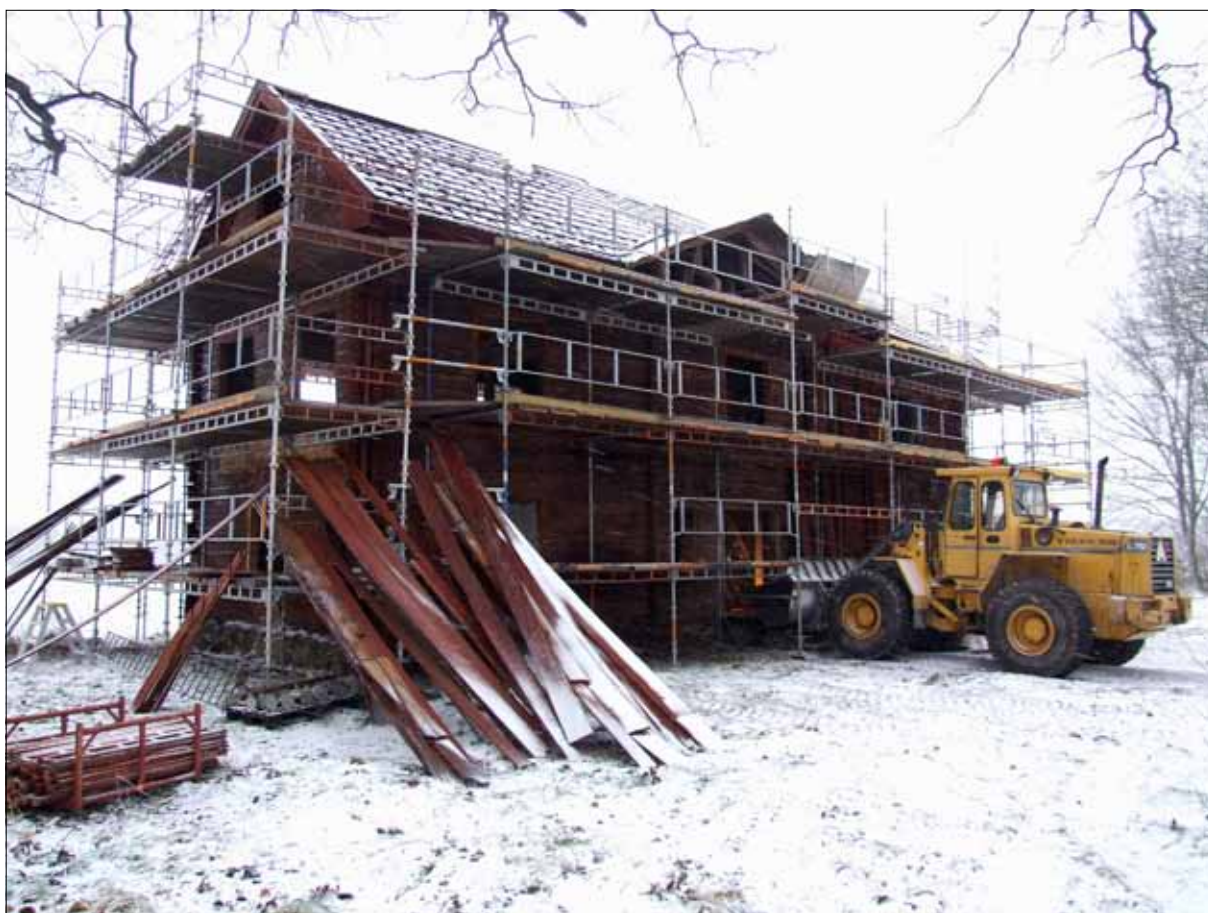
17 Demonteringen av manbyggnaden påbörjades i november 2010 (Slm D11-655).
