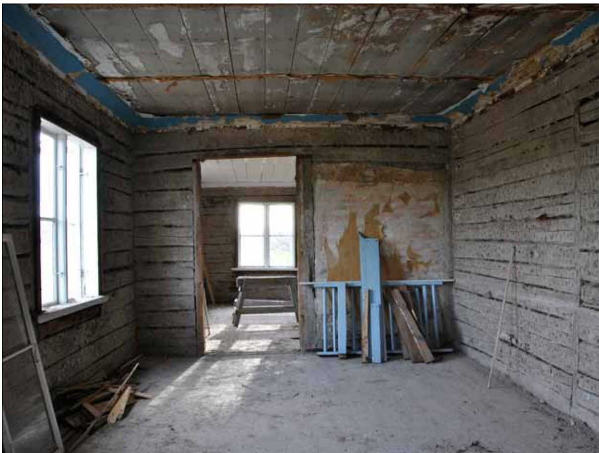
29 Rum 110 från norr efter att inredning och ytskikt har rivits ut (Slm D11-667).
