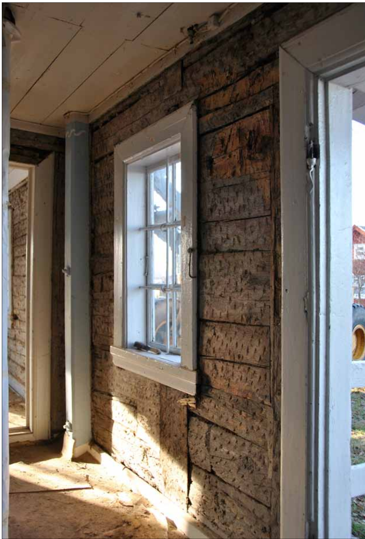
16 Manbyggnadens entré, rum 101, efter rivning av inredning och ytskikt (Slm D11-654).
