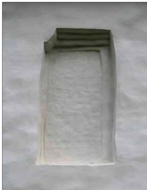
30 Utformningen av det östra blindfönstret på kyrkans södra fasad efter avslutad restaurering, 20080918 (Slm D09-115).
