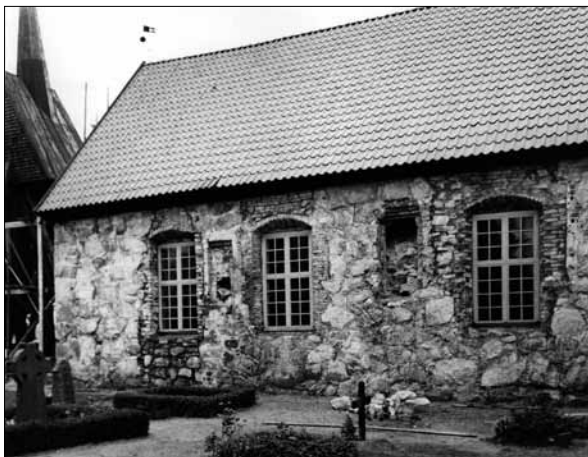
5 Kyrkans södra fasad vid renoveringen 1961. Fotograf C-G Blomberg (Slm A24-561).
