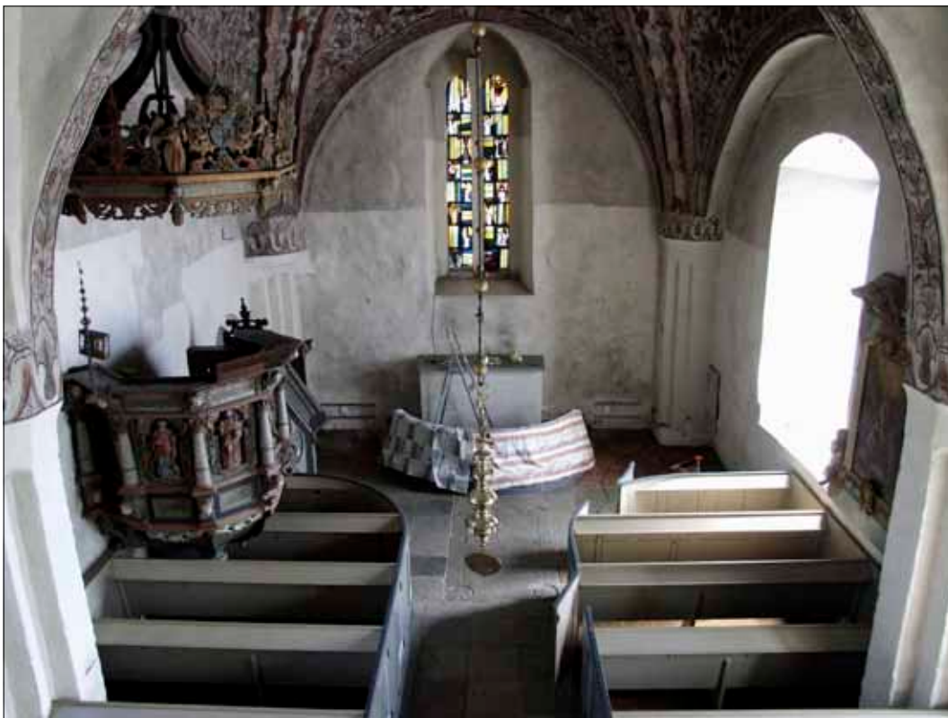
38 Kyrkorummets östra del efter påbörjad rengöring av väggarna. Fotografiet är taget från orgelläktaren i väster, 20080605 (Slm D09-101).
