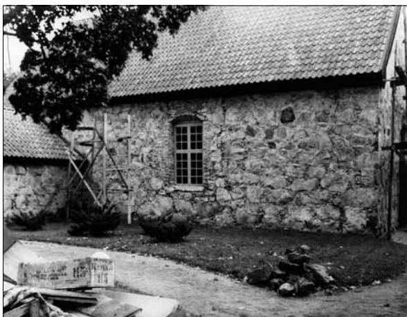
6 Kyrkans norra fasad vid renoveringen 1961. Fotograf C-G Blomberg (Slm A24-562).
