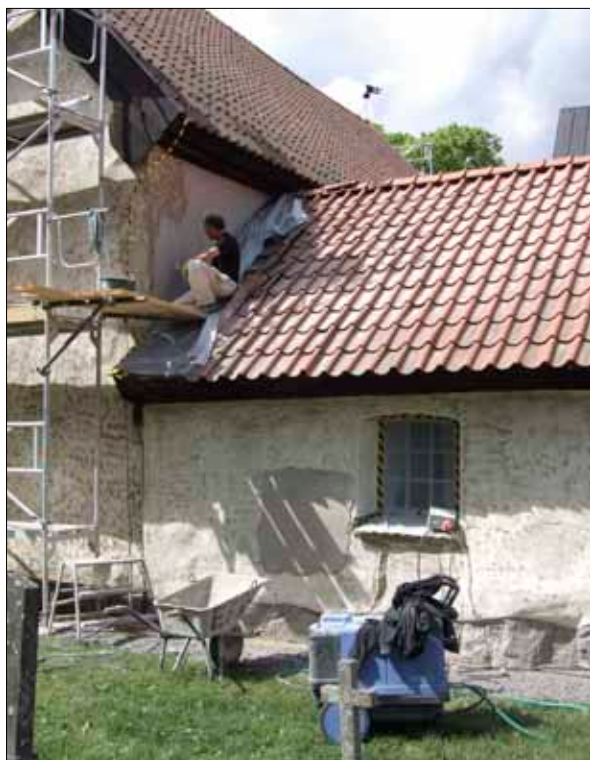
13 Göran Thelander, Eskilstuna Fasad & Kalk, färdigställer ett prov på en slevslätad yta på kyrkans norra vägg, 20080613 (Slm D09-103).
