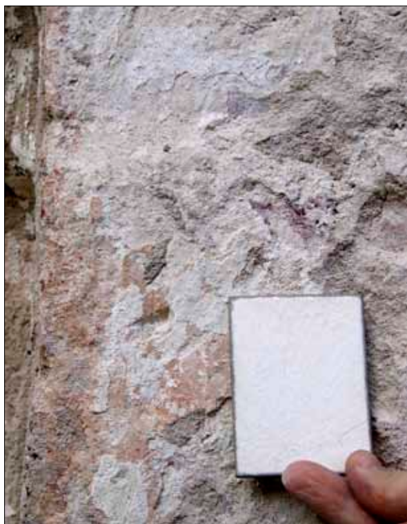
28 Jämförelse mellan äldre färglager (4) och kulör 46:2 (Kalkfärg 90) bruten med obränd terra, 20080616 (Slm D09-106).
