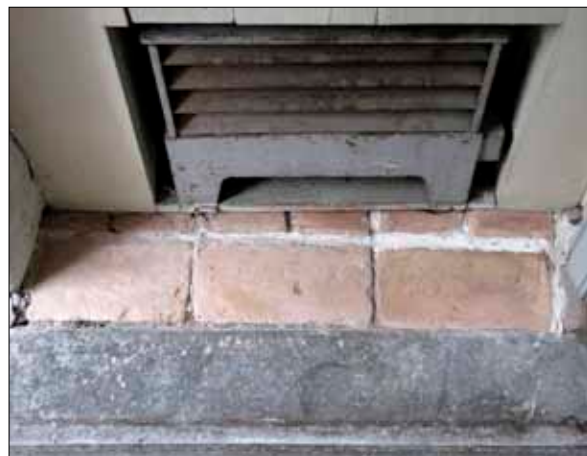
22 Vindfångets tegelgolv är delvis uppbyggt med infärgat kalkbruk. Fotografiet är taget från norr, 20080918 (Slm D09-118).
