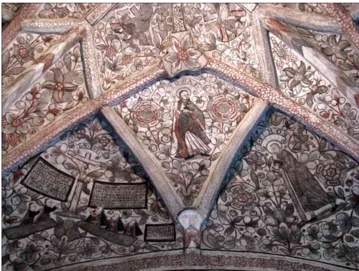
9 Del av den södra valvkappan i kyrkorummets östra valvtravé. Fotografiet är taget från norr, 20080918 (Slm D09-639).
