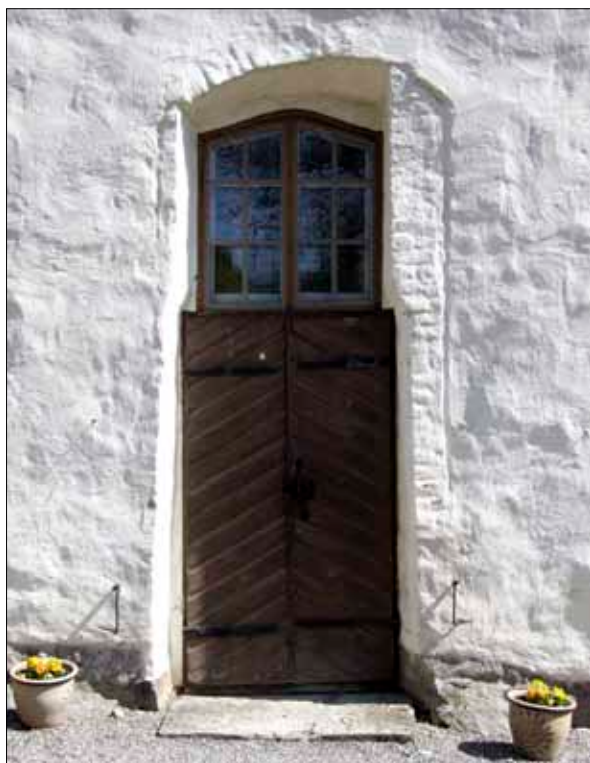
24 Markering av äldre murverk i anslutning till kyrkans ingång efter 1961-års restaurering, 20050508 (Slm D09-095).
