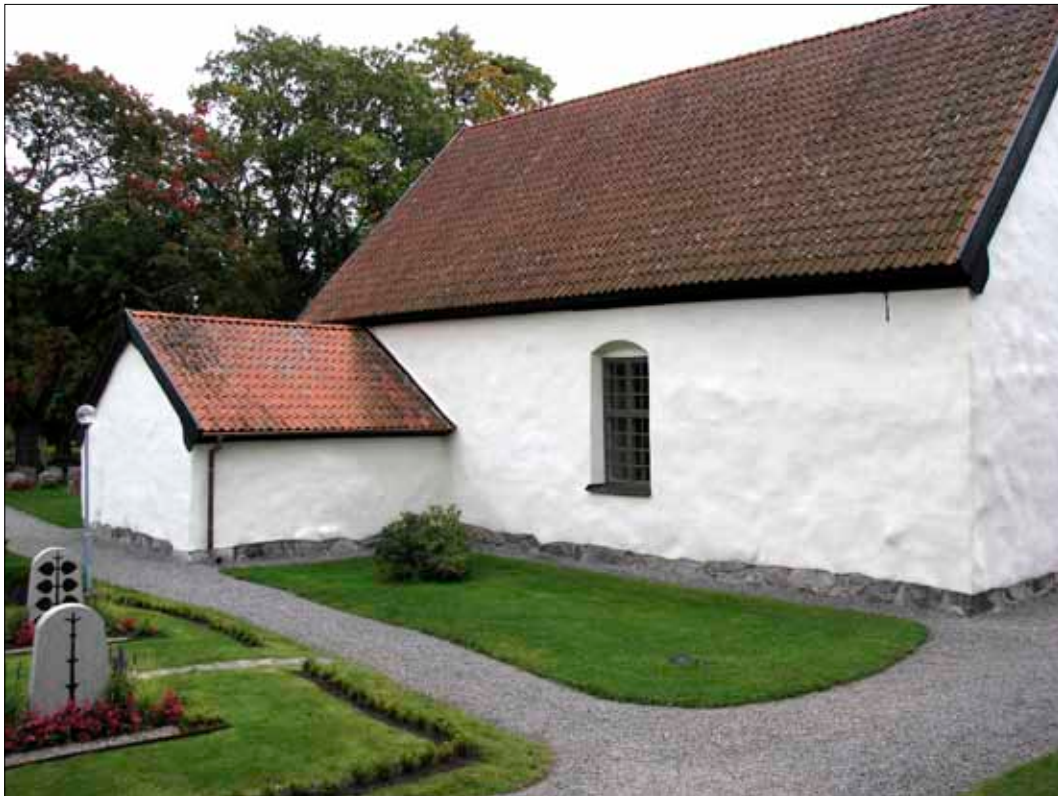
35 Vrena kyrkas norra fasad efter avslutad restaurering. Fotografiet är taget från nordväst 20080918 (Slm D08-636).
