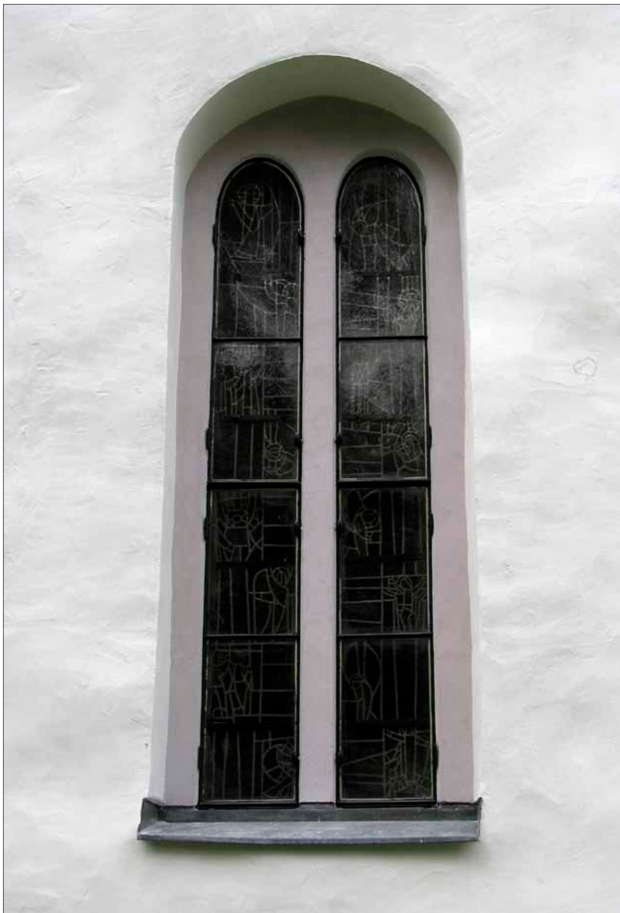
41 Fönstret på kyrkans östra gavel efter avslutad restaurering, 20080825 (Slm D09-112).
