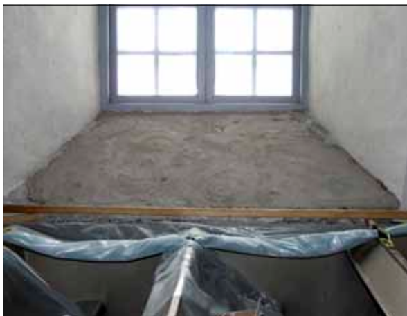
19 Kyrkorummets fönsterbänkar lagades med kalkbruk, 20080806 (Slm D09-109).
