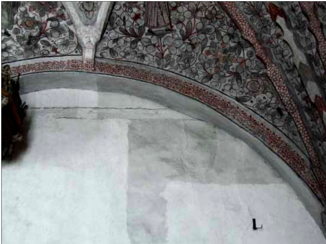
39 Vägg och valv i anslutning till predikstolen under arbetets gång, 20080623 (Slm D09-107).
