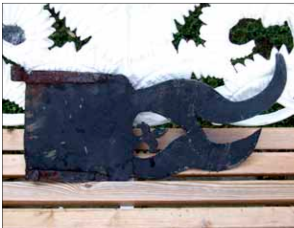
17 Vindflöjeln före reparationen, 20080806 (Slm D110).
