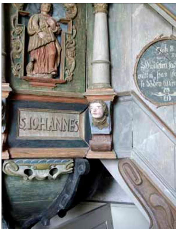
31 Sprickor i kyrkans predikstol som troligen har orsakats av rörelser i predikstolens trappa, 20080508 (Slm D09-099).
