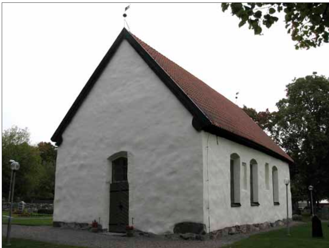
33 Vrena kyrkas västra och södra fasader efter avslutad restaurering. Fotografiet är taget från sydväst, 20080918 (Slm D08-634).
