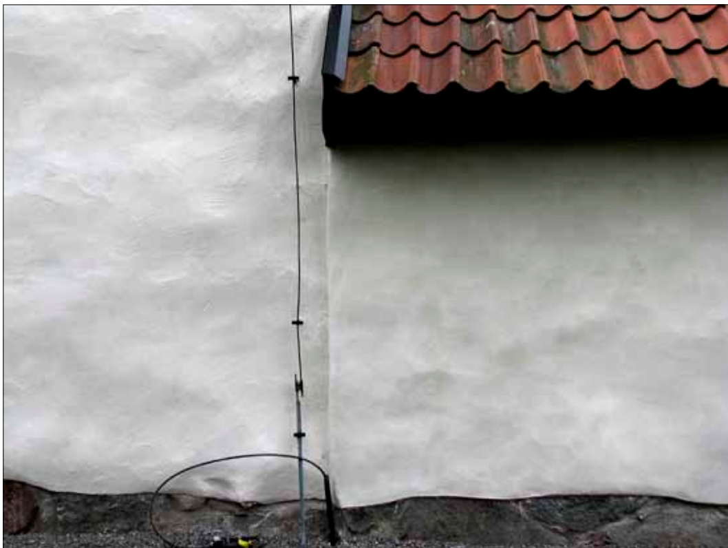
36 Mötet mellan den först färdigställda ytan på kyrkans östra gavel, till vänster, och den sist färdigställda ytan på sakristians östra fasad, till höger, visar utvecklingen av murarnas slevslätningsteknik under restaureringens förlopp, 20080918 (Slm D09-117).
