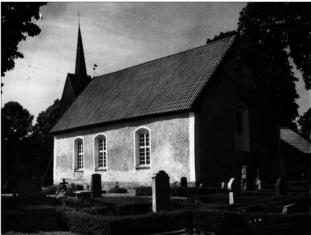
4 Vrena kyrka före renoveringen 1961. Fotografiet är taget från sydost av Dan Samuelsson, möjligen 1926 (Slm A24-548).
