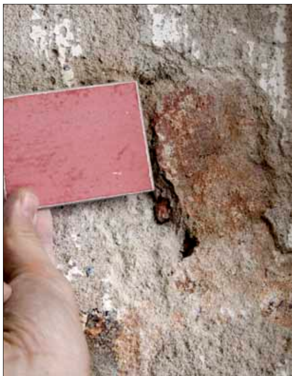
27 Jämförelse mellan äldre färglager (2) och kulör 225:5 (Kalkfärg 90) bruten med järnoxidrott, 20080616 (Slm D09-105).
