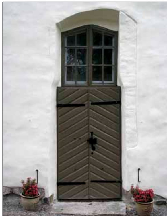
25 Vid restaureringen år 2008 markerades även läget för fönsteröppningens solbänk med en rits, 20080918 (Slm D09-113).
