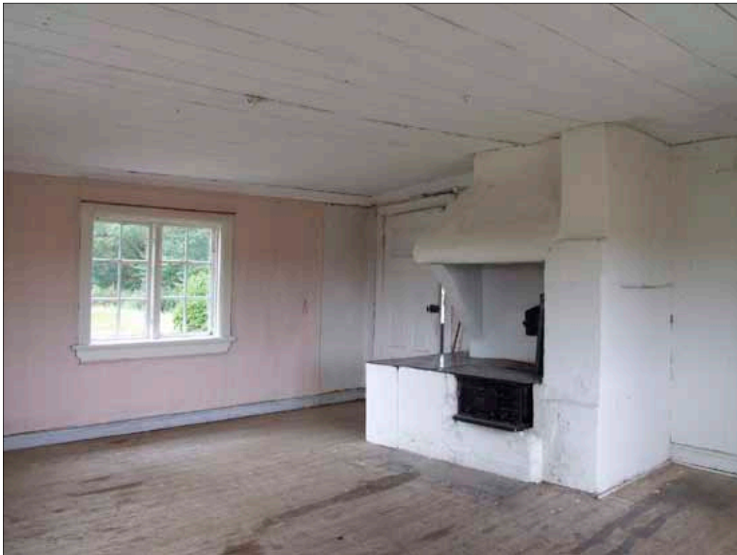
23 Rum 102 från sydost (Slm D10-526).
