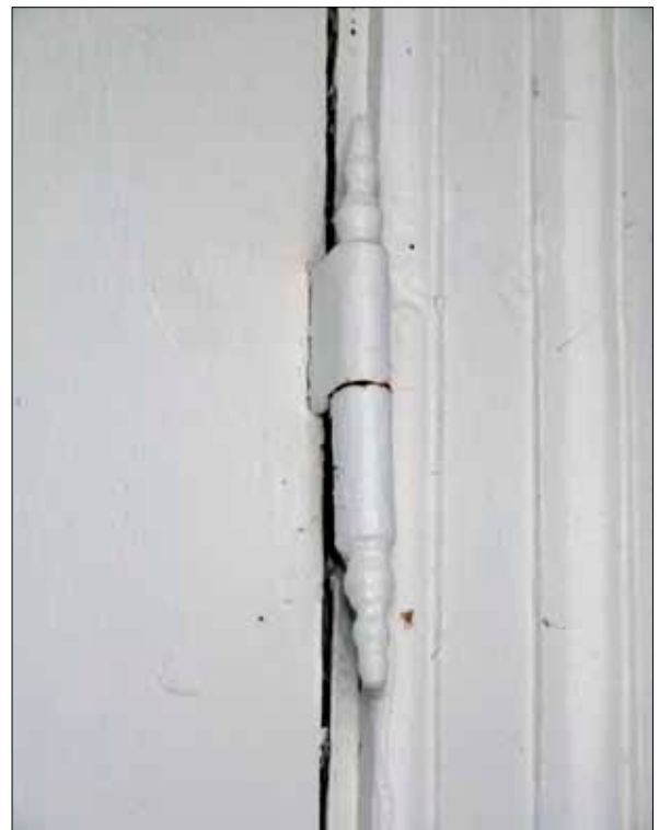
34 Stolpgångjärn av 1700-talstyp på dörren till rum 111 (Slm D10-537).
