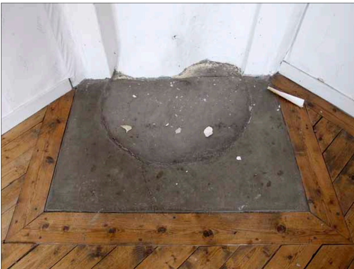
41 Avtryck efter en rund kakelugn vid murstocken i rummets nordvästra hörn (Slm D10-544).
