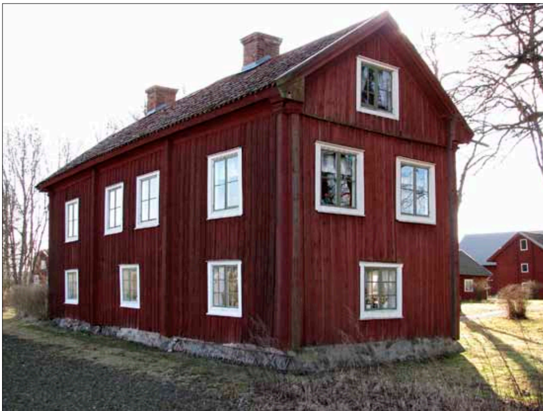
18 Huvudbyggnaden från nordost (Slm D10-521).
