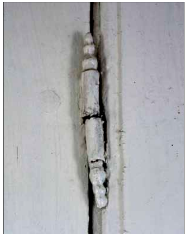
22 Stolpgångjärn av 1700-talstyp på dörren till rum 106 (Slm D10-525).
