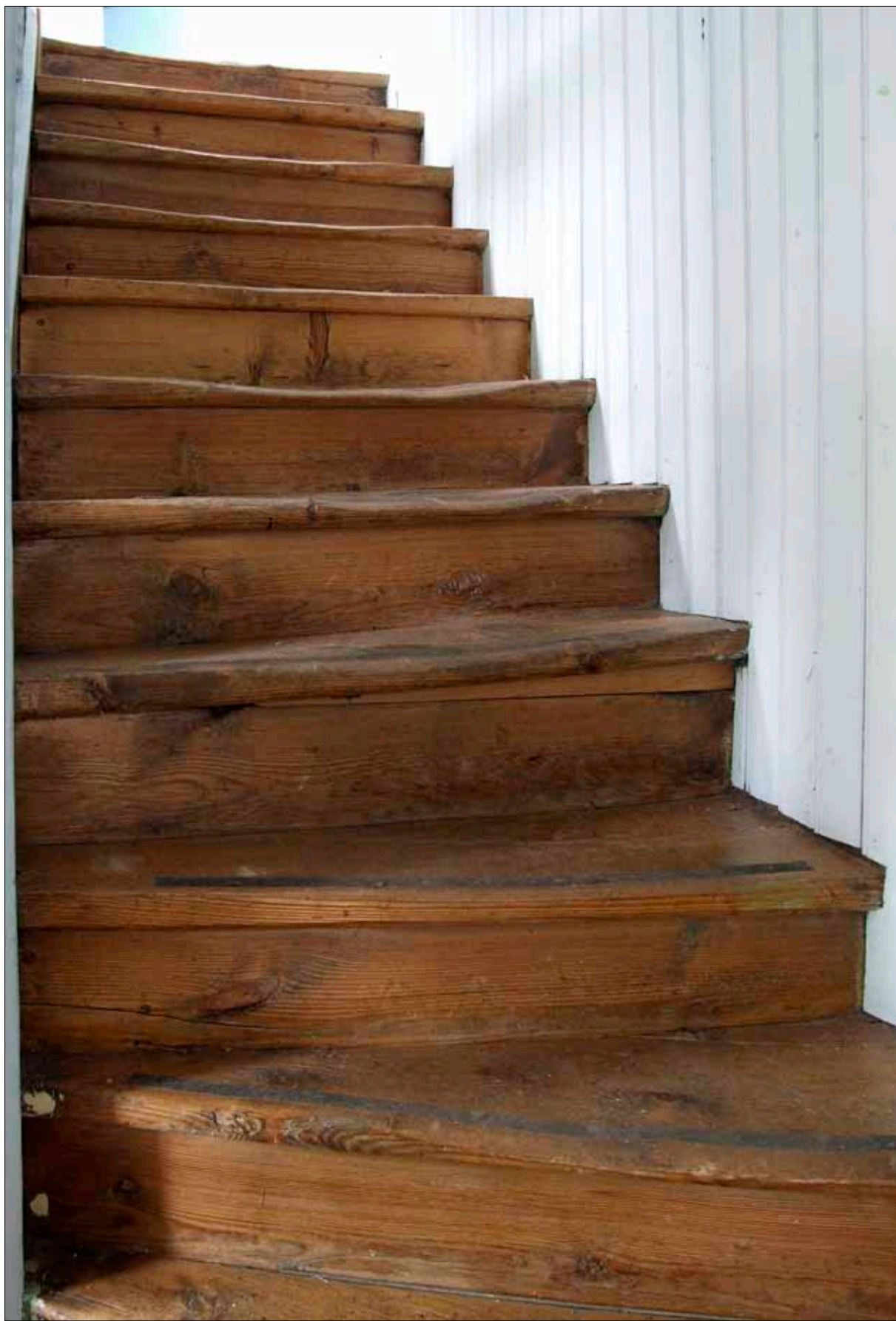
12 Trappan till manbyggnadens övre plan bär djupa spår av många generationers tunga steg efter en hård arbetsdag (Slm D10-516).
