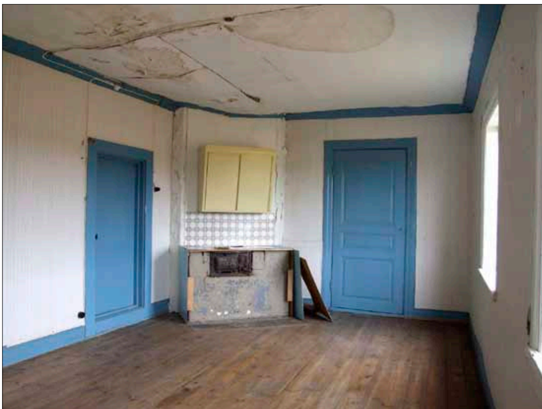
42 Rum 110 från sydost (Slm D10-545).
