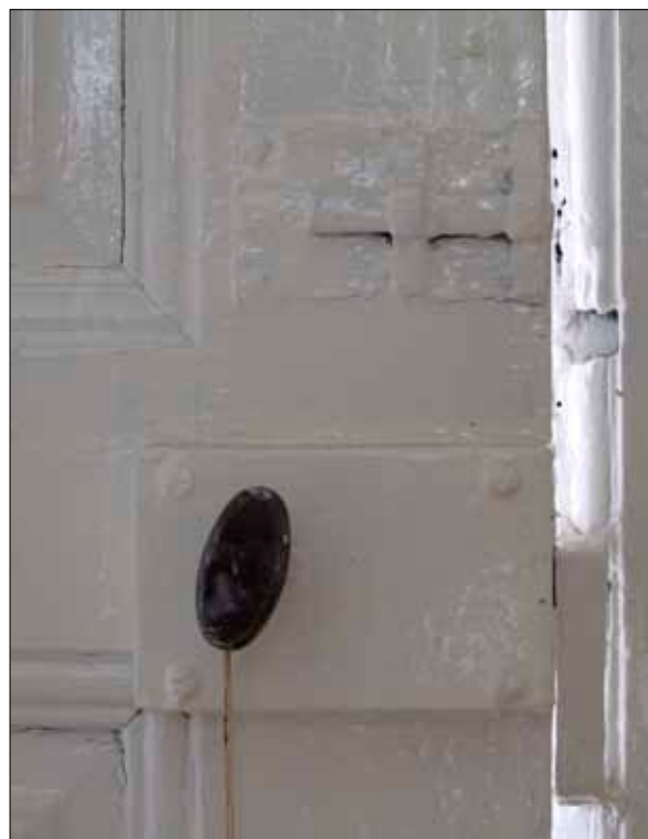
38 Kammarlås och skottregel på dörren till rum 109 (Slm D10-541).
