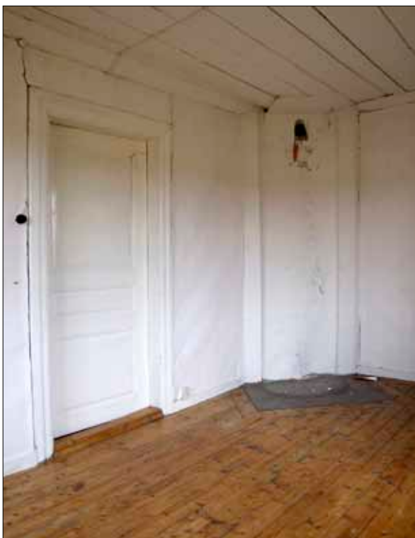
39 Rum 109 från sydost (Slm D10-542).
