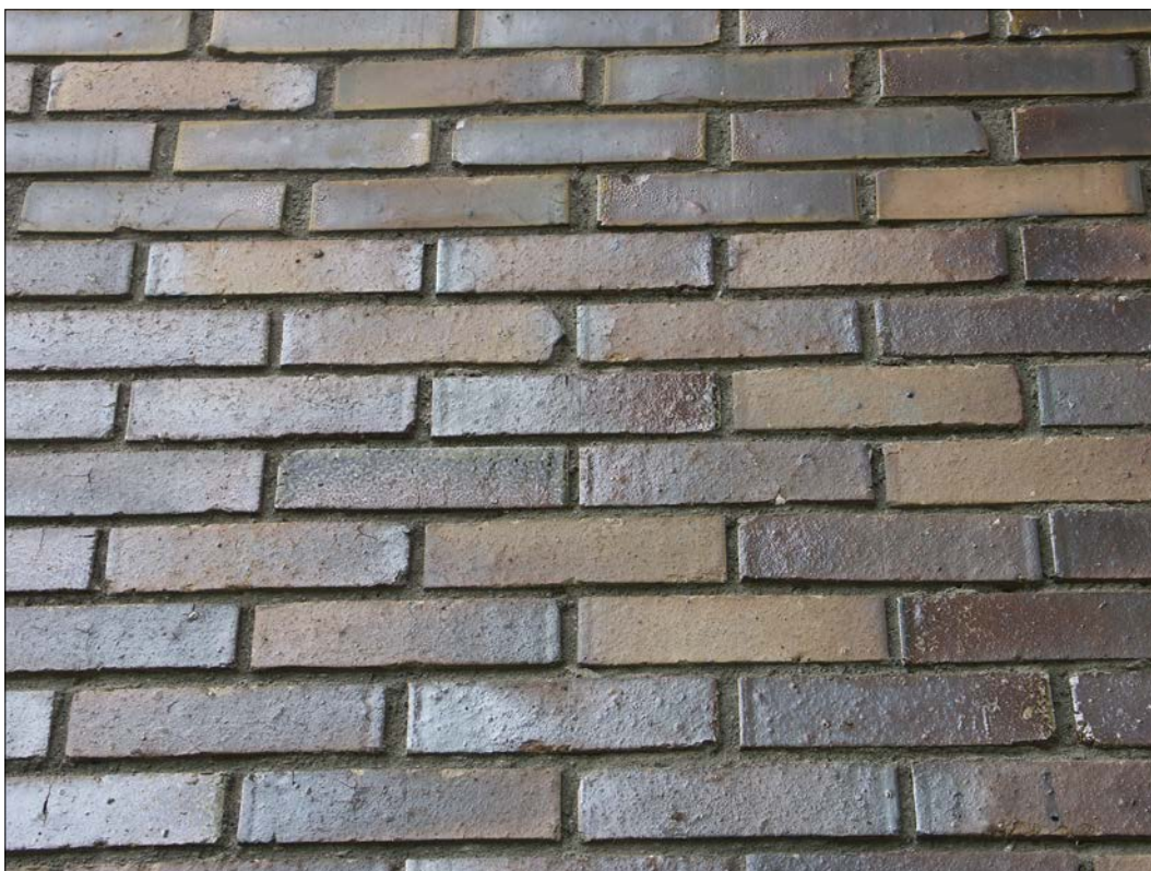
Fig 23 Teglet i 1984 års byggnadsdel är något tunnare och har murats med smalare fogar än på den första byggnadsdelen. De olika färgskiftningarna i teglet ger ett textilt uttryck och en samverkan sker mellan byggnadskropparna.
