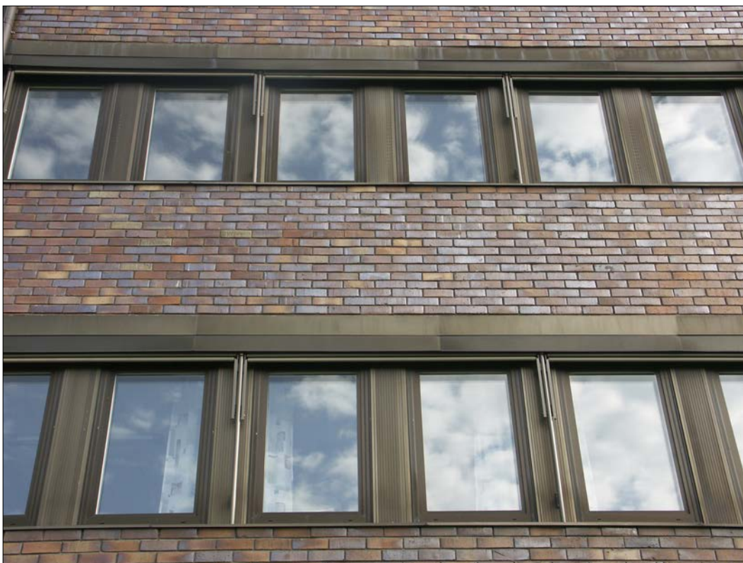
Fig 20 Fönsterband är ett viktigt kännetecken för dessa fasader. Här har dock tillägg gjorts med horisontella plåtar för upphängningsanordning av markiser. Fönsterbågar av plåt har blivit kraftigare och fönsterytorna har minskats. Originalutförandet var mera stilrent och elegant.
