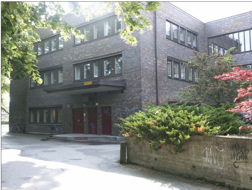
Fig 18 På baksidan finns en lastkaj och en upphöjd plantering inom en brädgjuten betongmur. Planteringen fanns 2007.
