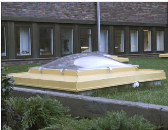
Fig 46 Nymålade kupolplåtar ovanpå garaget.
