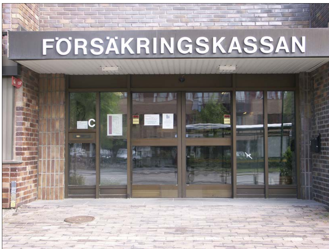
Fig 13 Det finns två entrépartier. Detta är det sydöstra som är beläget i byggnadsdelen från 1984. Mönstermurning med stående klinkerplattor eller tegel inramar porten.
