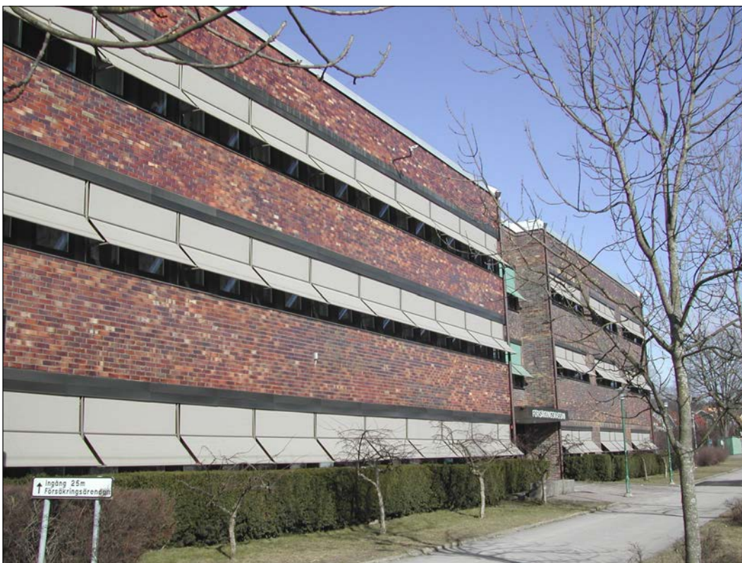
Fig 11 Här kan de båda byggnadsetapperna ses. Den närmast kameran är från 1970 och den längre bort från 1984. Arkitekturstilen överensstämmer men tegeltyperna i fasaderna skiljer sig åt. Markiserna ger sitt särskilda avtryck och förändrar utseendet.
