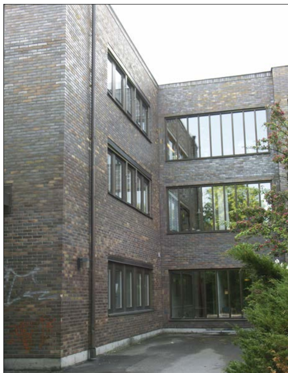
Fig 17 Byggnadskroppen till vänster från 1984 ansluter till den äldre delen via ett indraget entréparti. Här visas baksidan.
