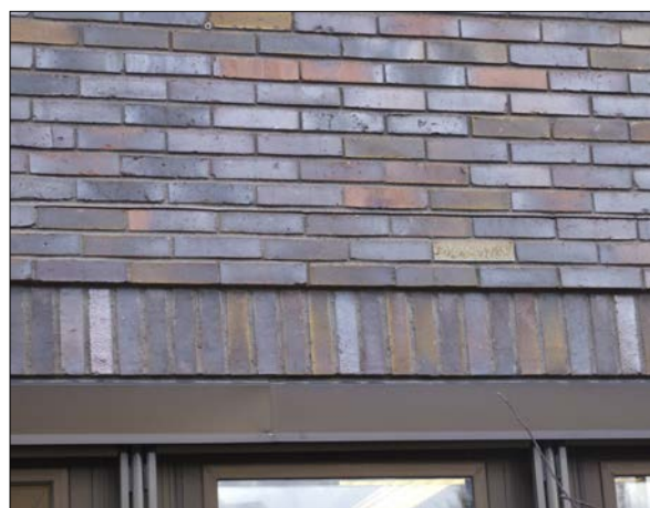
Fig 38 En typ av mönstermurning förekommer i den nya delen. Bakom plåten ovanför fönsterraden finns markisioletterna som ofta är nerfällida.
