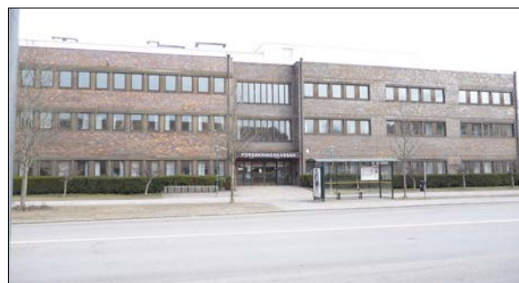
Fig 5 Här syns de båda byggnadskomplexen från 1970 till vänster och 1984 till höger.
