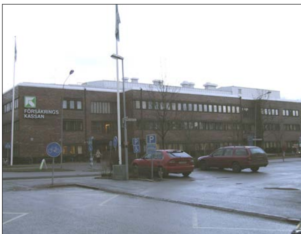
Fig 35 Här syns den nya strukturen för modern teknik på taket. Byggnaden följer teknikutvecklingen.
