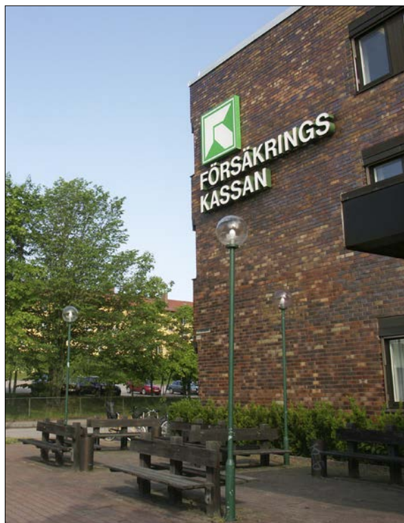
Fig 15 Till ursprungsanläggningen hör de grupperade parksofforna, en särskild ring att koppla hundar vid samt cykelställ av betong.
