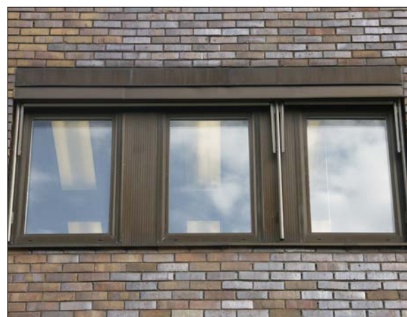
Fig 44 Dubbla plåtar ovanför fönstren förgrövar det arkitektoniska uttrycket.
