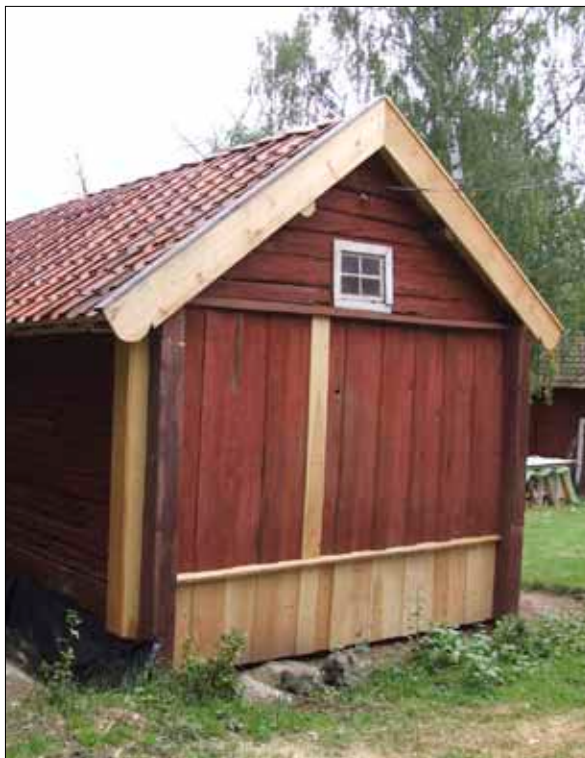
20 Östra flygelns norra gaveln efter åtgärd. Panelen kapades nedtill och lagades i med nytt virke.
