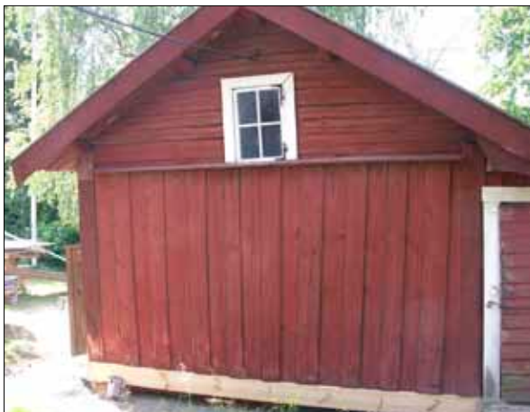
11 Västra flygelns norra gavel, som i samband med syllagningarna lyftes ca 20 cm vid nordöstra hörnet.
