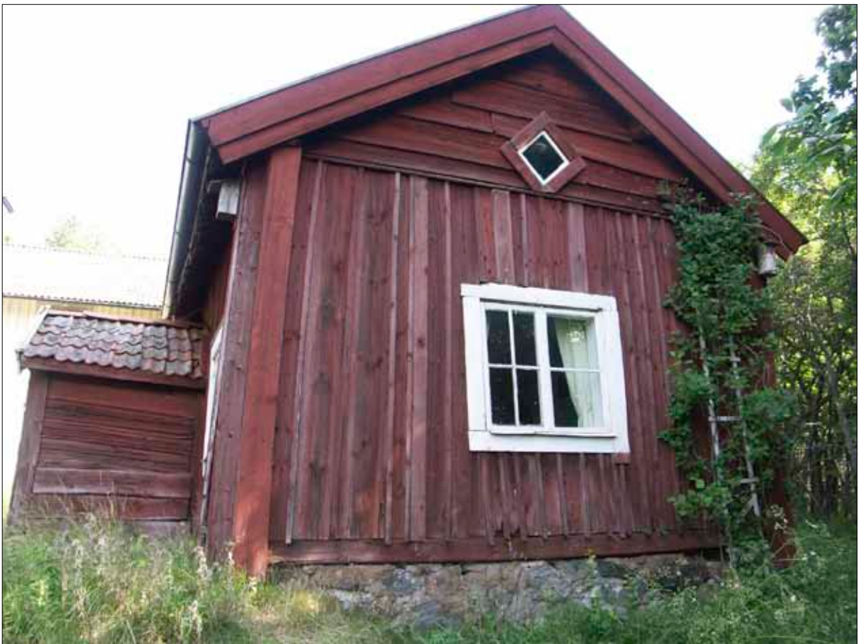
10 Östra flygeln sedd från söder före åtgärder.
