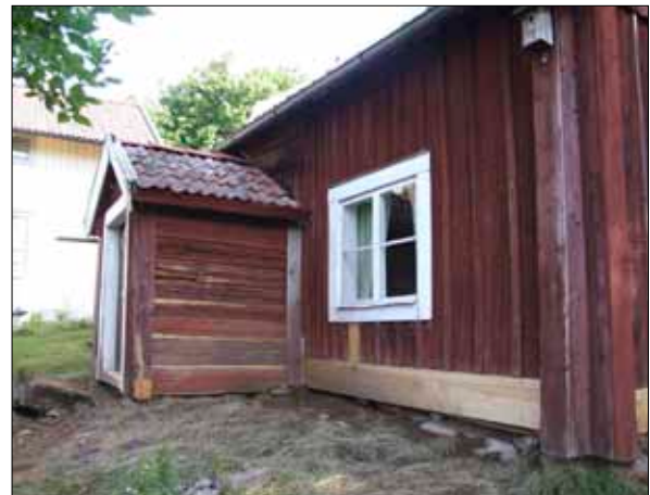
15 Södra delen av östra flygelns västra fasad.
