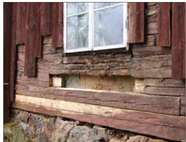
16 Timret under fönsteröppningen i södra gaveln var dåligt. De två nedre stockarna är utbytta. Fotograf Dag Forssblad, Sörmlands museum.
