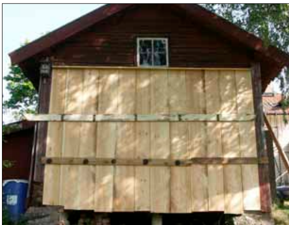
13 Södra gaveln på västra flygelns panelades in. Panelen spikades provisoriskt med horisontella brädor under torktiden.
