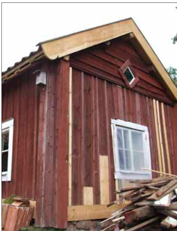
21 Östra flygelns södra gavel efter åtgärder. Vindskivornas nya utformning valdes av hantverkaren.
