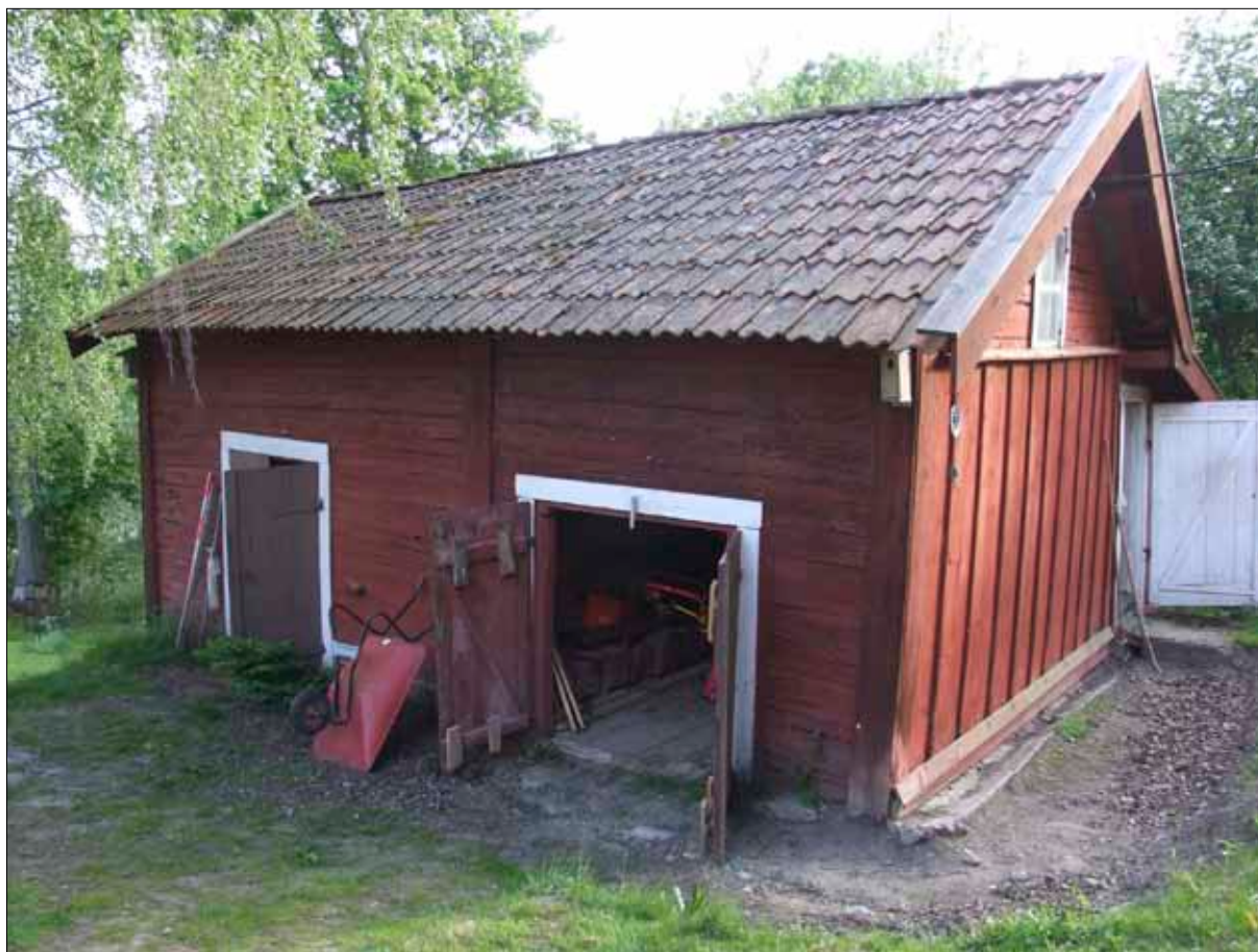
3 Västra flygeln i maj 2008, efter det att marken grävts bort.
