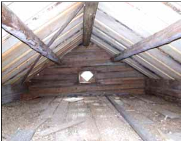
19 Taklaget sett mot söder. Kroppåsen är bytt. Snedsträvor lades mellan åsarna.
