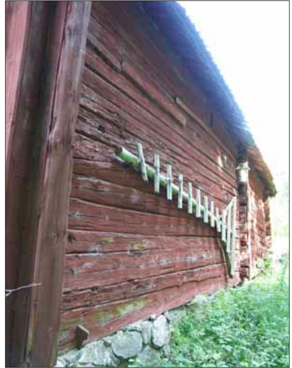
9 Östra flygelns östra fasad före åtgärder.
