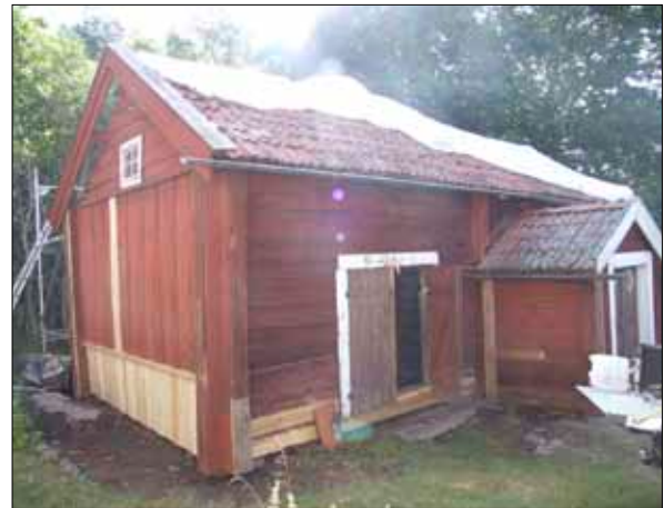
14 Östra flygeln efter arbeten med stommen.
