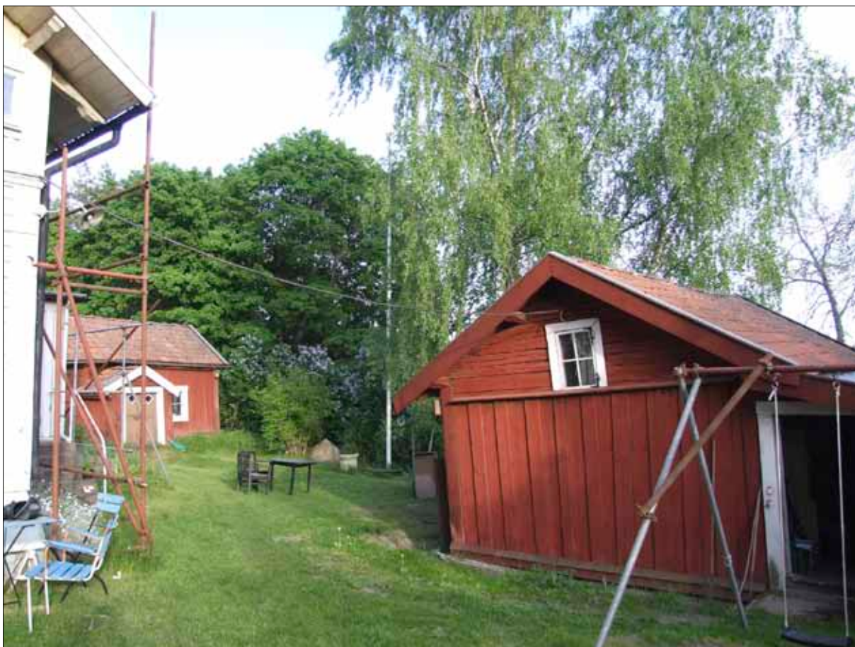
7 Marknivån var för hög vid de båda flyglarna. Här är marknivån delvis justerad vid västra flygel.
