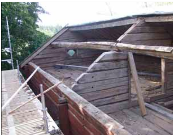
17 Östra flygelns under arbeten med taket. Väggbandet hade satt sig och var tidigare upplagt. Mellanvägg och gavelrösten hade förskjutits.
