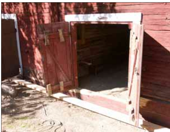
12 Syllstocken på västra flygelns östra fasad fick bytas från nordöstra hörnet fram till södra dörröppningen.
