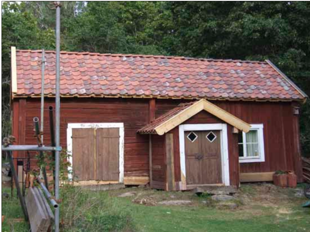
22 Östra flygelns västra fasad efter åtgärder.
