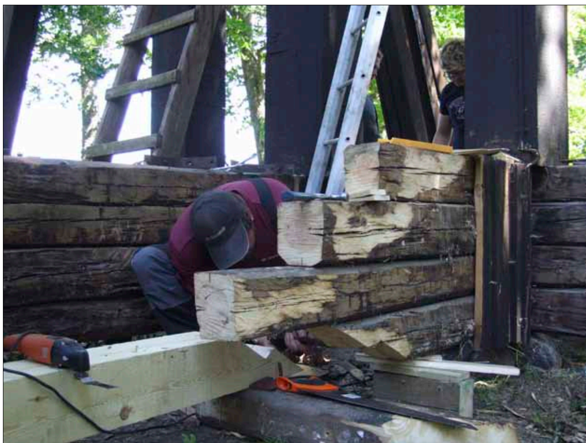
12 Lagningar utförs av Henrik Nyberg, Byggnadsvård i Dalarna AB. Syllen V1.
