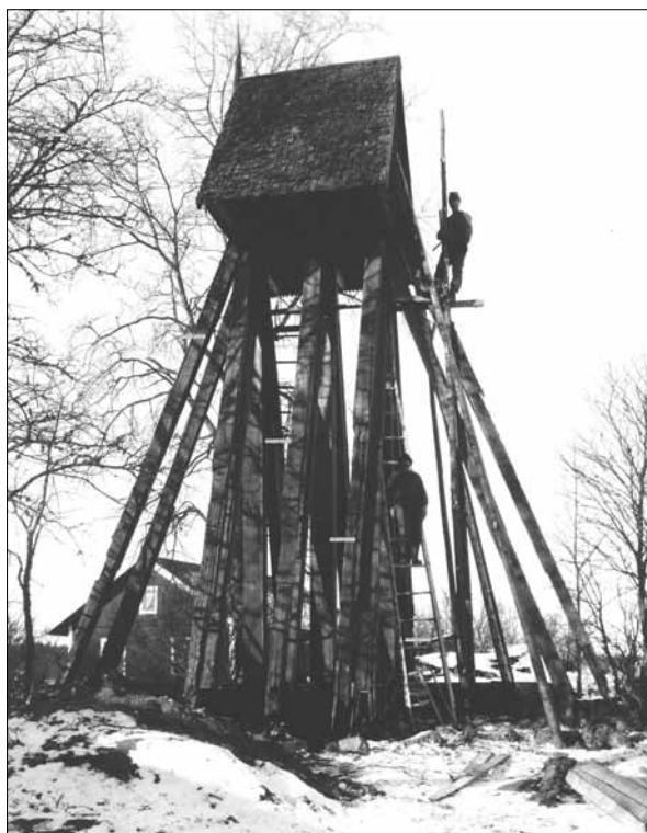
3 Renovering av klockstapeln den 20 februari 1928 Fotograf Erik Kling. Sörmlands museums arkiv, bild M035175.
