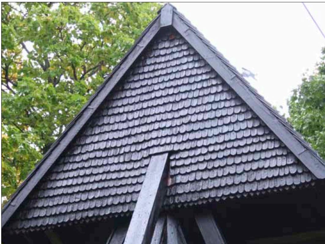
24 Norra gaveln efter renoveringen. Endast enstaka spån byttes.
