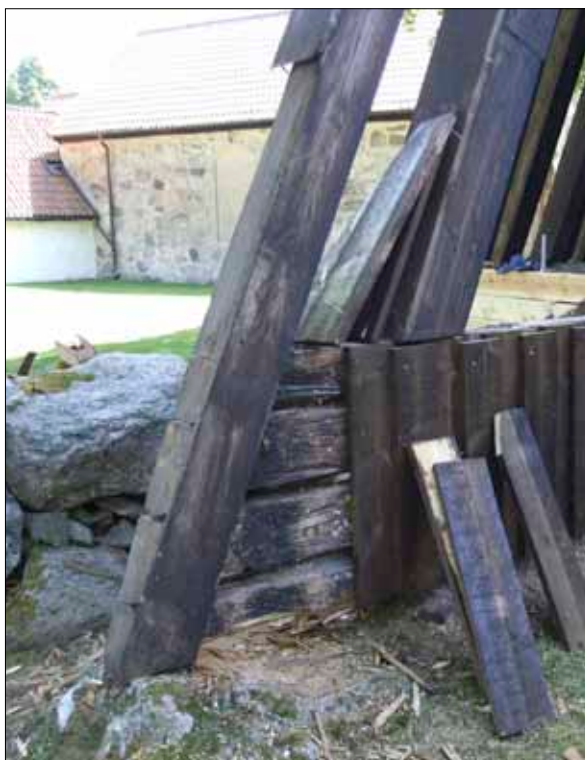
10 N, norra syllstocken före åtgärder, sedd från väster.
