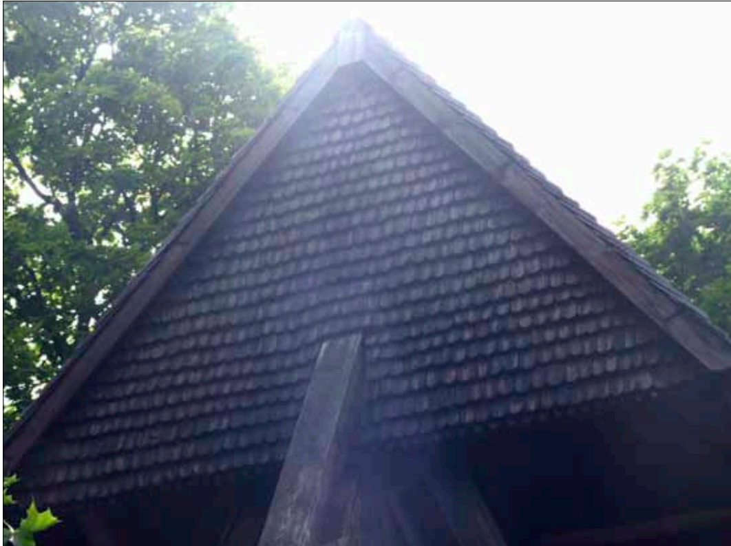
23 Norra gaveln före åtgärder.
