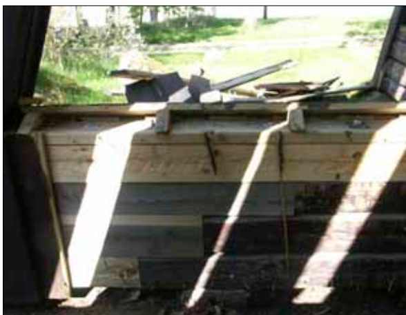
7 V3 före renoveringen, syllen upplagd med modernare virke.
