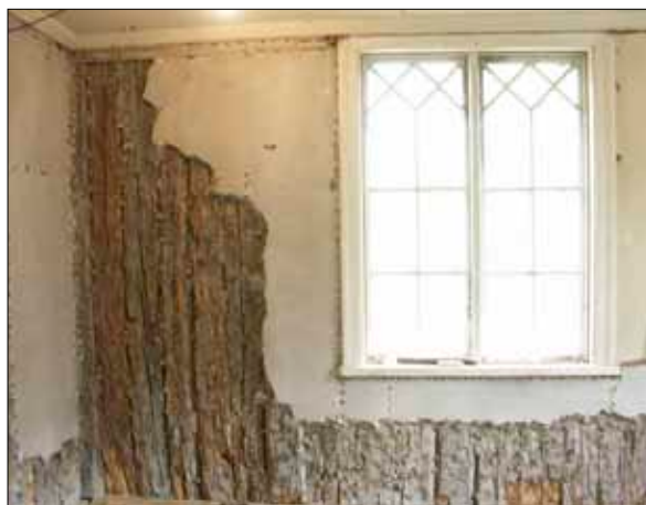
18 Östra väggen i rum 16. Väggens stomme består av stående timmer.
