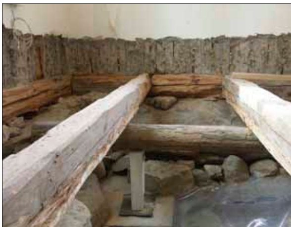
22 Bjälklaget i rum 17 sett mot väster.
