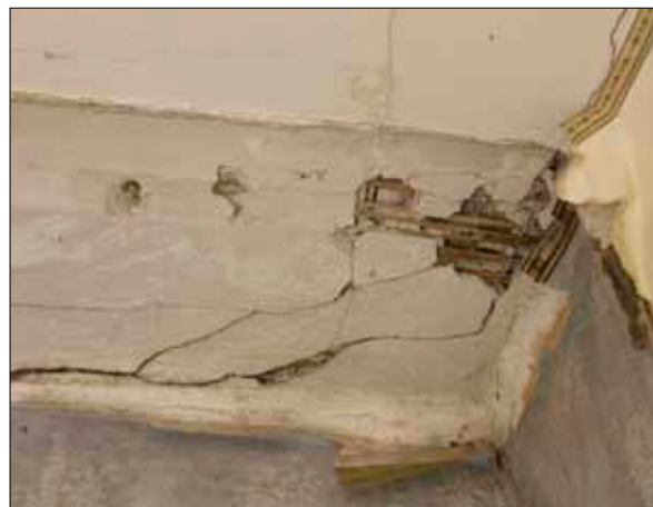
31 Taket i rum 27. Putsen är utförd på en putsbärare av vass.
