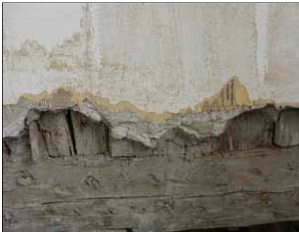
21 Detalj av östra väggen i rum 17. Ovanpå lerklining är tidningspapper klistrat som handlar om Kreügerartikeln, sannolikt 1930-tal.
