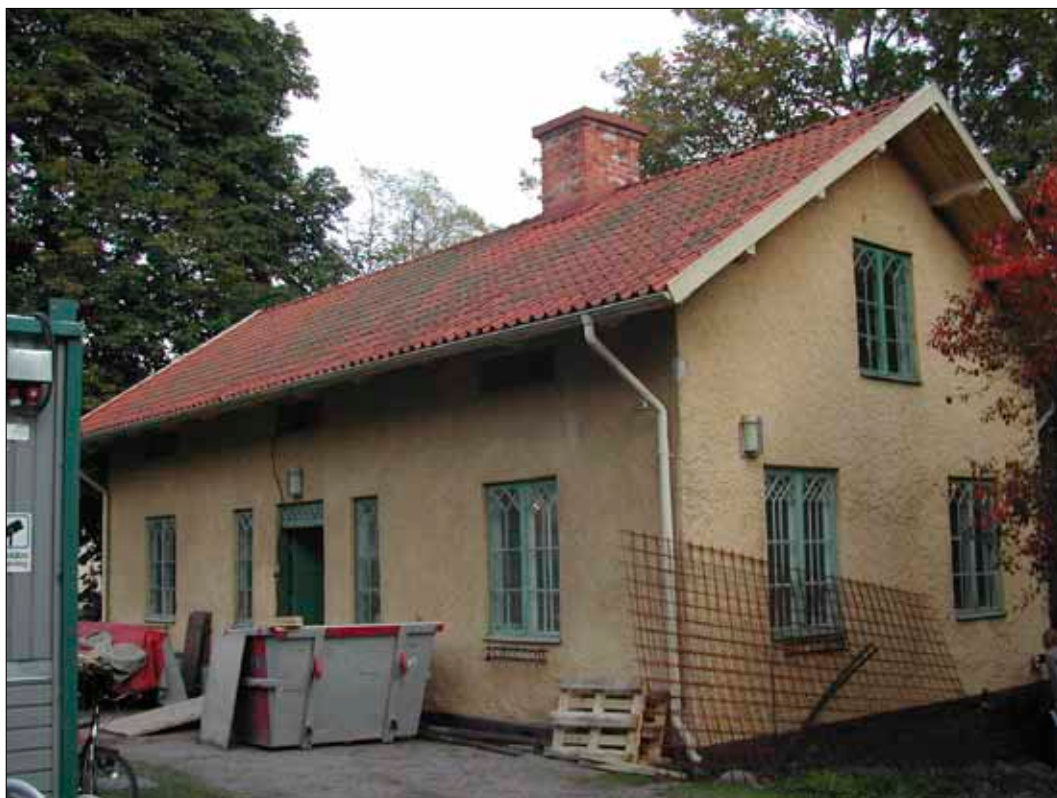
4 Annexet under renoveringen i september 2007. Fotografi från sydväst.
