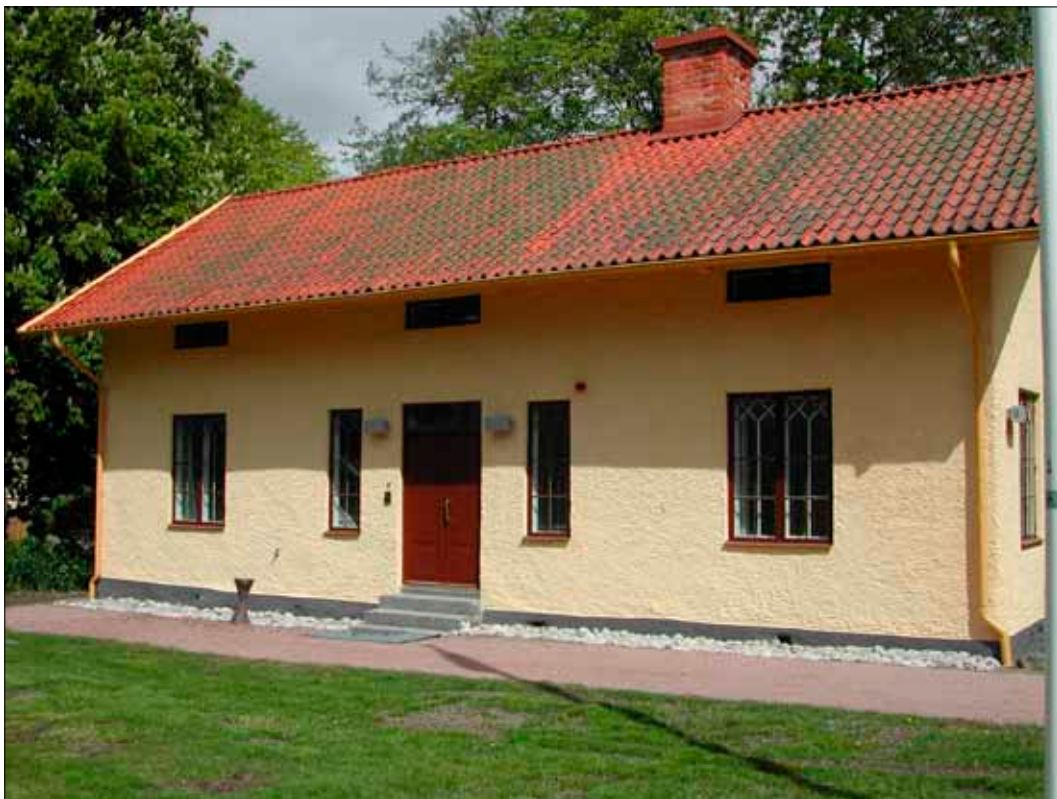
35 Västra fasaden i maj 2008, efter renoveringen. Fotografi Magnus Josephson, Sörmlands museum.
