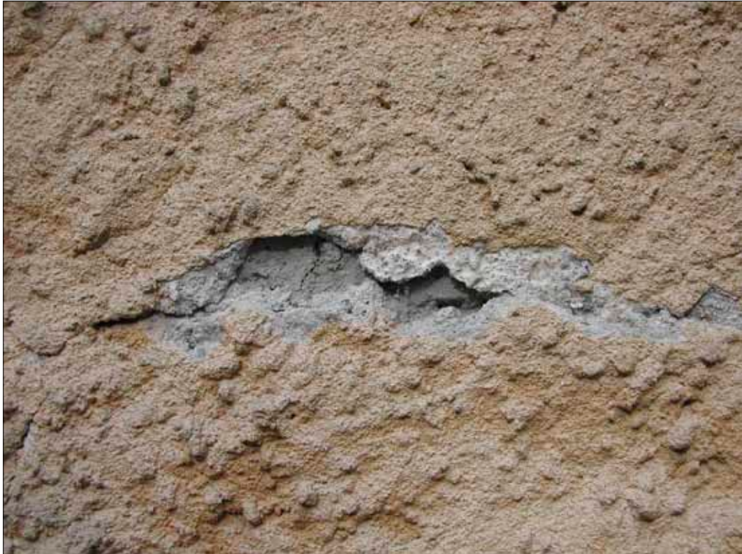
6 Detalj av spritputsen före renoveringen. Under nuvarande lagret syntes en ljusare gul avfärgning.
