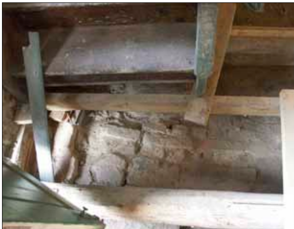
10 Under golvbjälklaget syns källarens tunnvalv av tegel.
