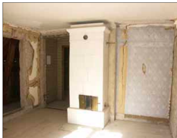
30 Gavelrummet, rum 27, sett mot norr.
