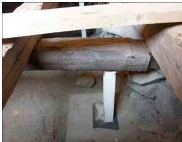
13 Bjälklaget vilade på rundstockar.
