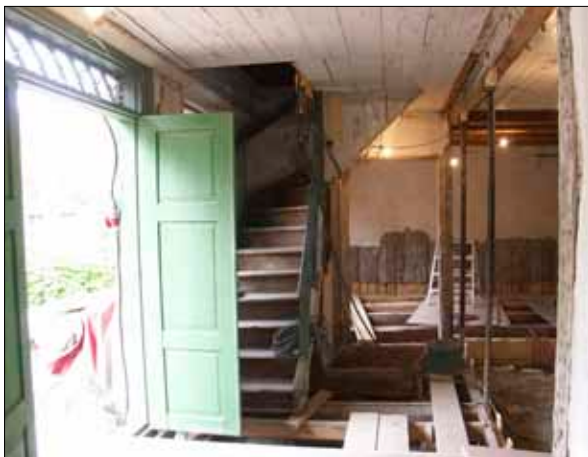
8 Rum 11, entrén, sedd mot norr.
