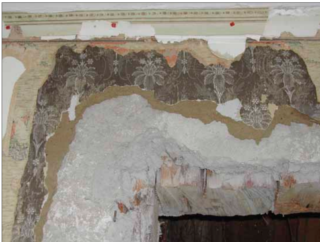
32 Andra tapetlagret synligt i rum 27, västra väggen.
