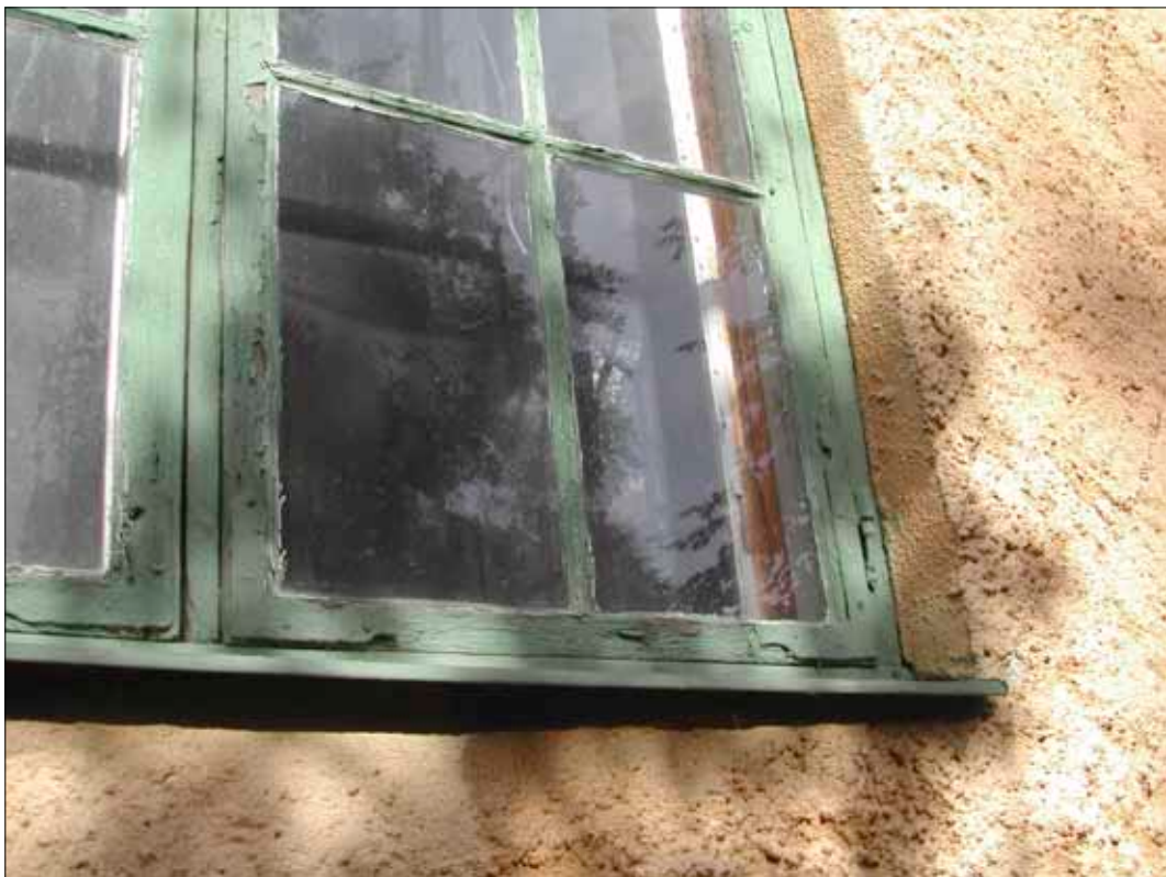
7 Fönsterbågarna var senast målade mörkt gröna, men underliggande färglager var rödbruna.
