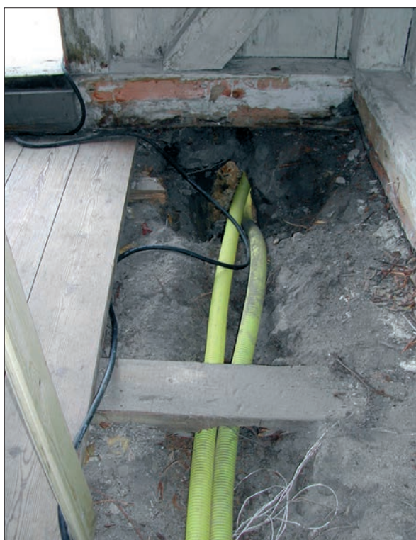
23 Vattenledningen lades under golvet i västra vapenhuset.
