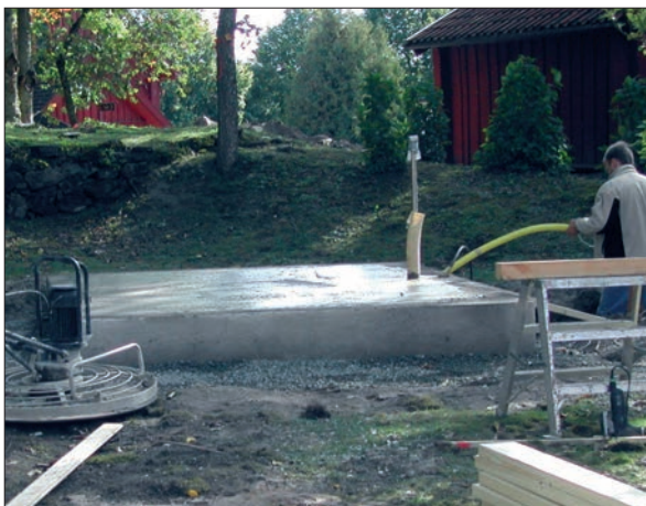
13 Gjutningen gjord för blivande pumphuset.
