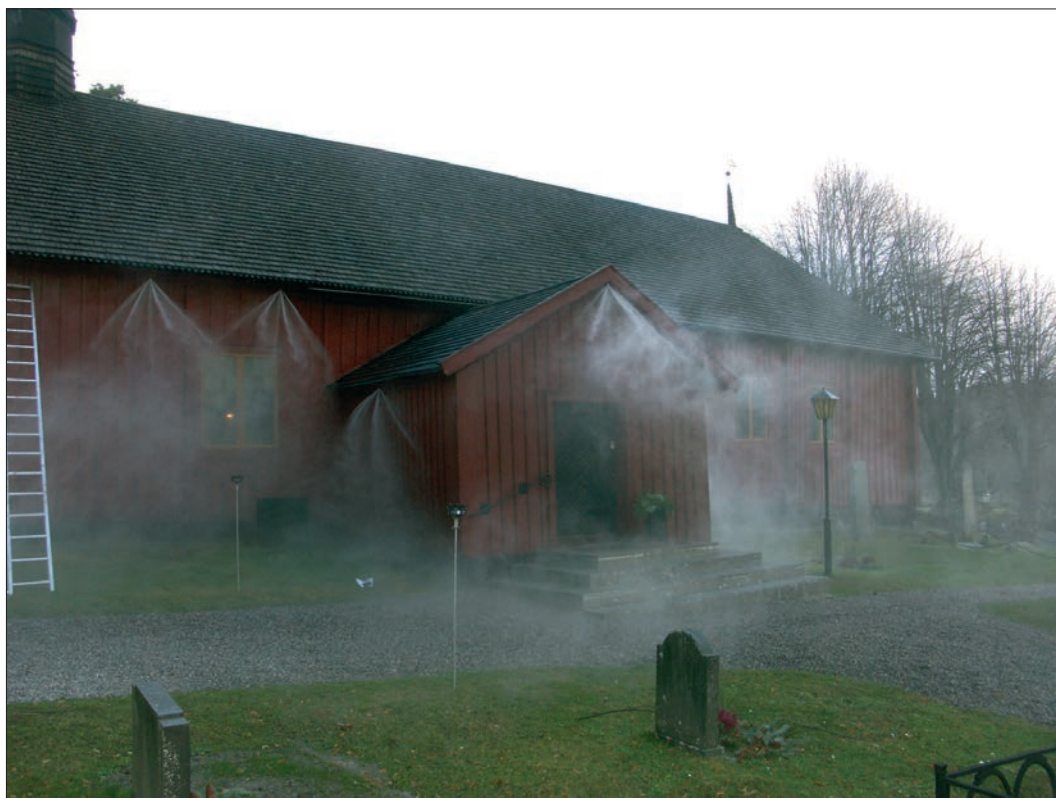
2 Test av sprinkleranläggningen den 15 november 2005.
