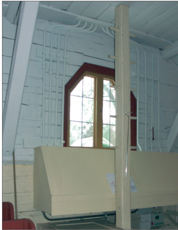
22 Sektionsgruppen byggdes in i en låda och ventiler målades in i rätt kulörer.
