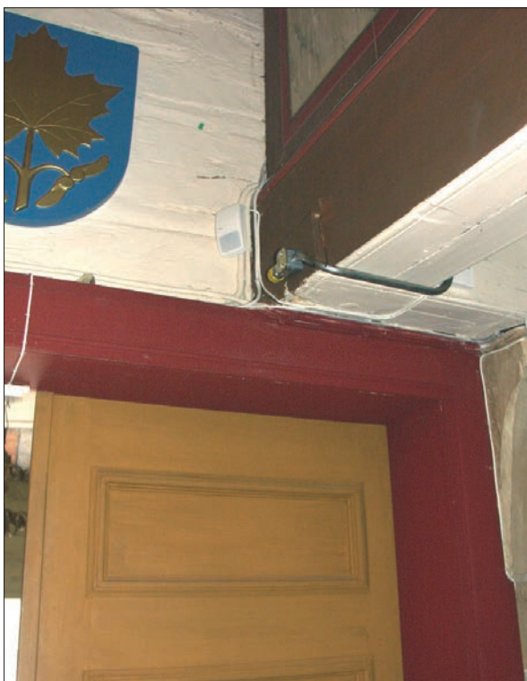
21 I långhuset under orgelläktaren lades synliga rör, som senare målades in i omgivande kulör.
