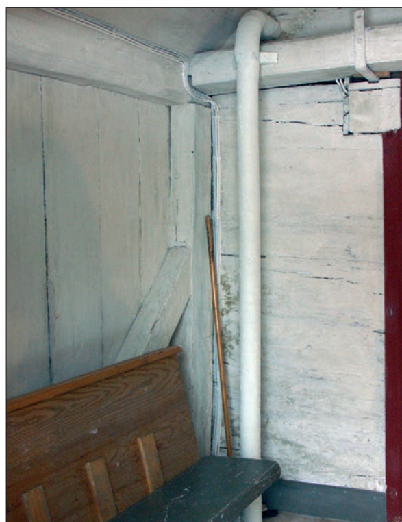
25 Röret isolerades, kläddes in med gasbinda och målades med limfärg, vilket blev mindre framträdande än om röret byggts in.
