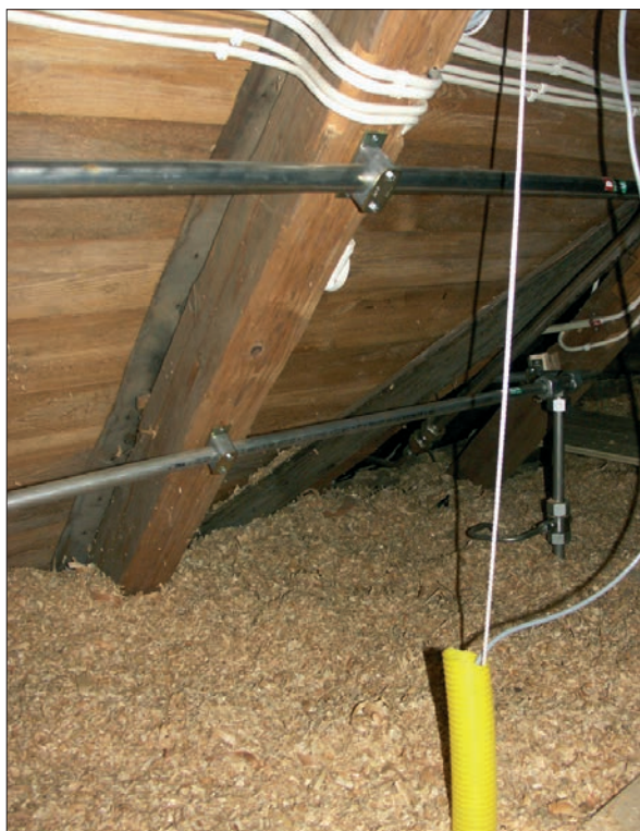
29 Ett rör monterades i kutterspånisoleringen ovan långhuset, för att kunna höja och sänka rökdetektorn .
