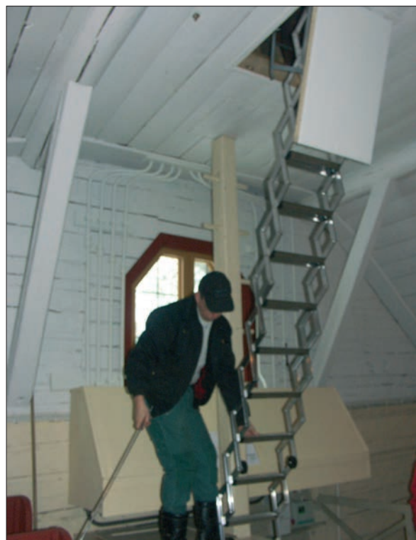
30 En ny vindslucka med inbyggd nedfällbarstege monterades för att enklare kunna nå vinden. Vaktmästare Rolf Johansson i bild.
