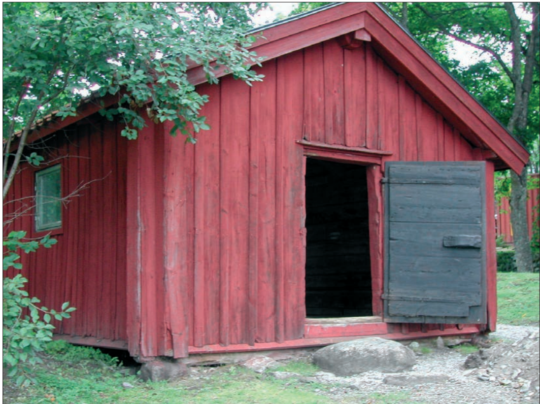
5 Före detta likboden som är belägen väster om kyrkan utanför bogårdsmuren.
