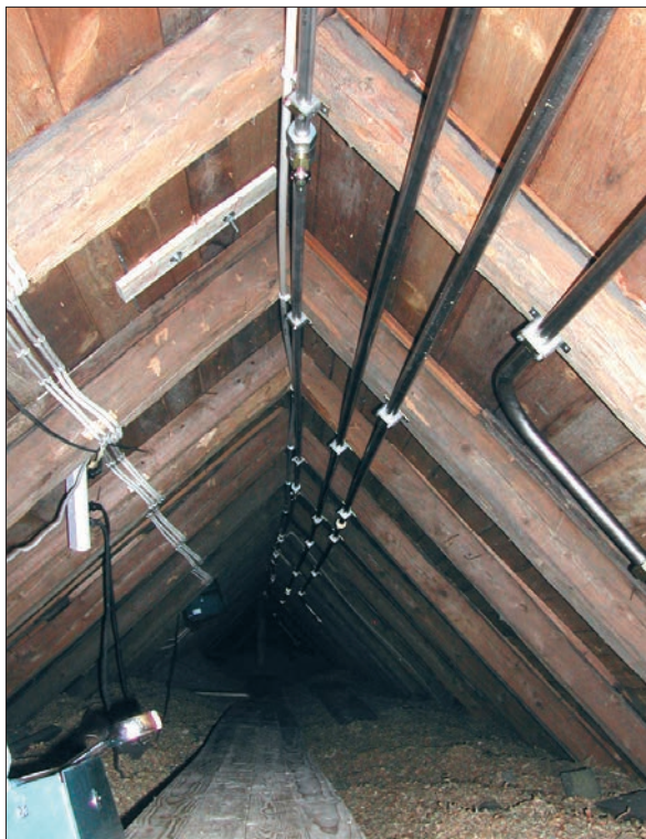
27 Rören förlades till största delen på vindsutrymmen, här en vy ovan långhuset.
