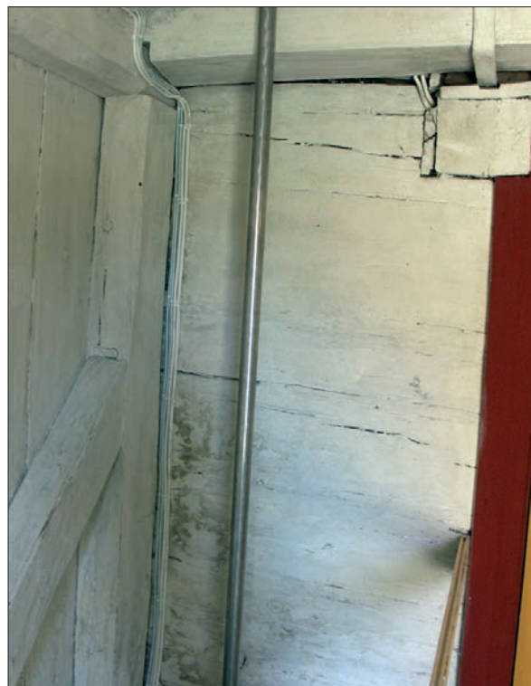
24 Inkommande vattenrör i västra vapenhuset blev synligt i nordöstra hörnet.
