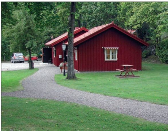
7 Vy av de nya personalutrymmena som ligger väster om kyrkan, likboden och klockstapeln.
