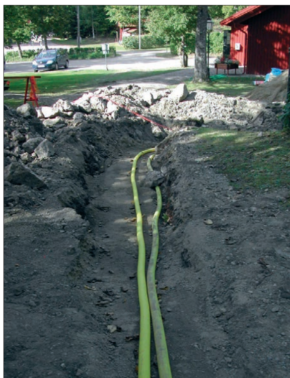
16 Grävning för vattenrör gjordes från nya pumphuset fram till västra vapenhuset.
