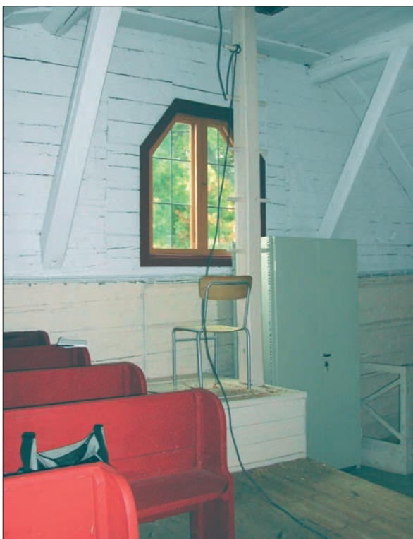
8 Bakre delen av orgelläktaren före arbeten påbörjat.
