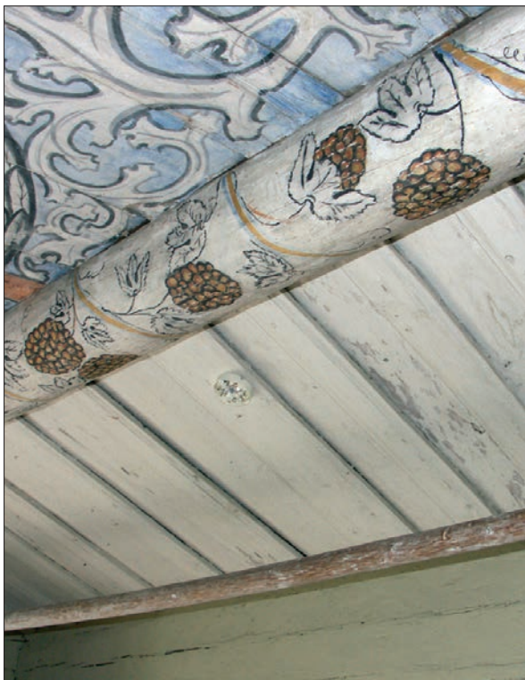
26 Rökdetektor i västra vapenhuset.
