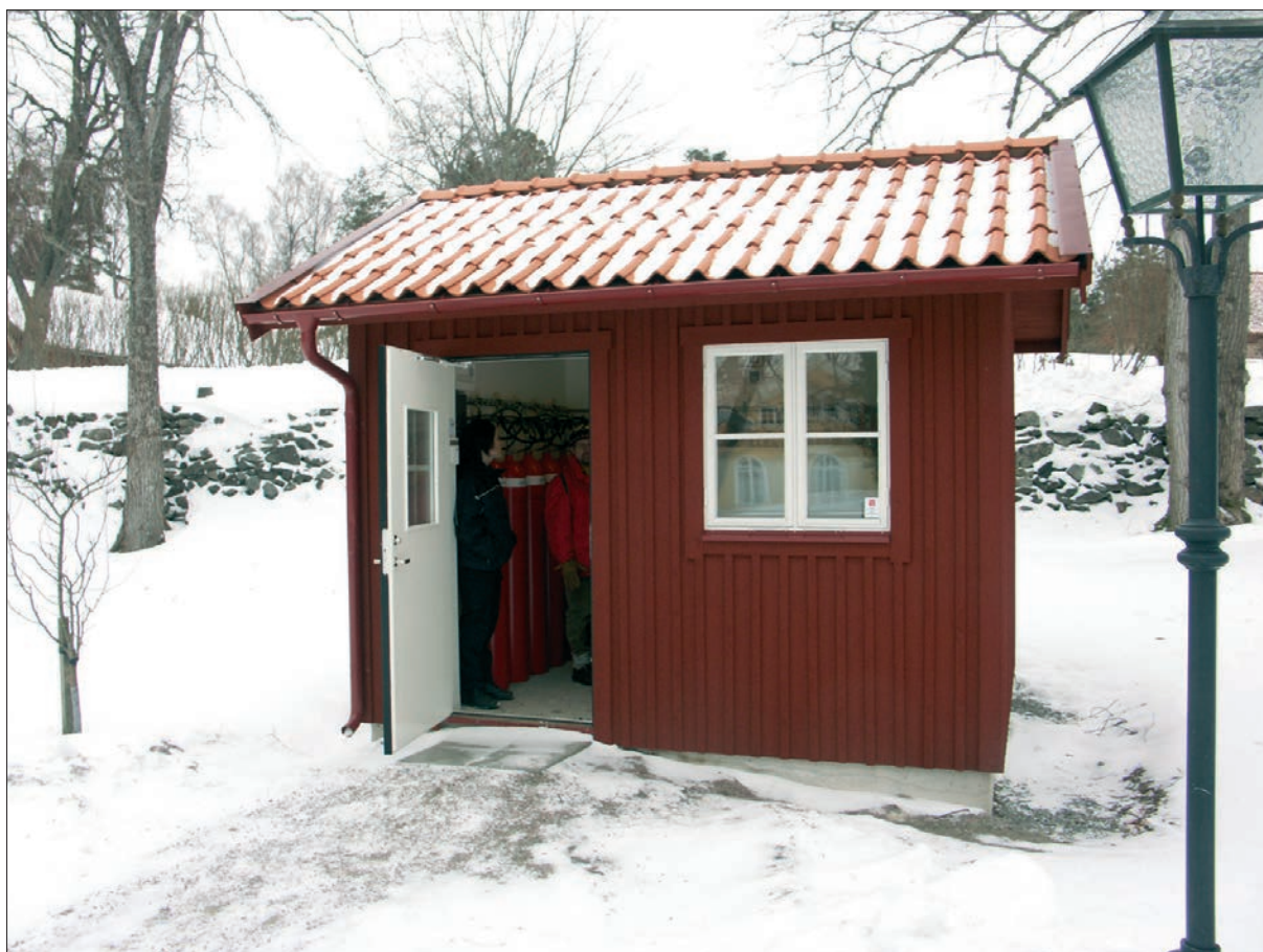
15 Nya pumphuset stod färdigt i augusti 2006.
