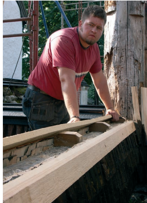
Bild 40. Syllens avtäckning läggs på av Henrik Nyberg.
