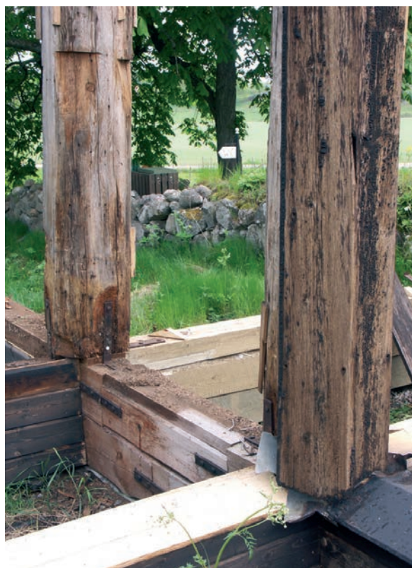
Bild 12. Detalj av mittstolparna som har tydliga märken efter den tidigare spånsplikningen.
