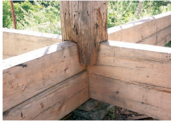
Bild 28. Detalj av ena mittstolpen som nu är nedsänkt och gafflad över syllen.
