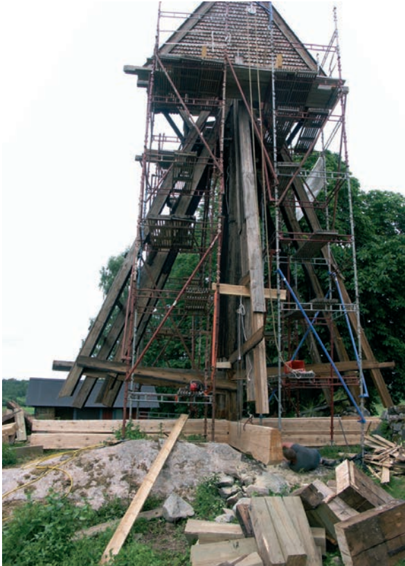
Bild 22. Nya syllstockarna på plats. Klockstapeln upphissad.
