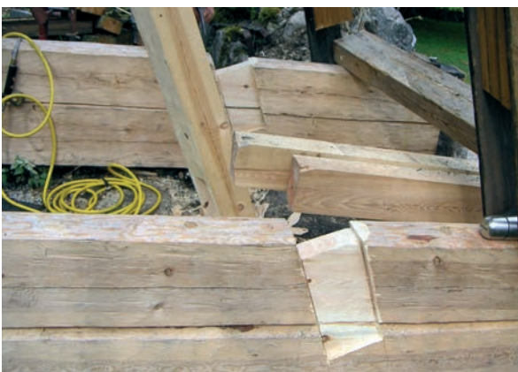
Bild 30 & 31. Till vänster: Detalj av urtaget i syllen för snedsträvan. Till höger: Snedsträvorna utformade som en klo. Fotografi Stefan Östberg.
