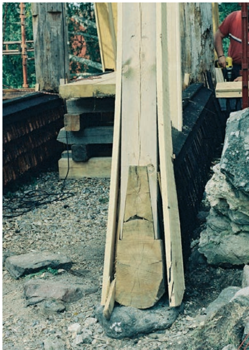
Bild 39. Täckbrädorna på den yttre snedsträvan går över syllinklädnaden, vilket ger ett bredare intryck av strävan.
