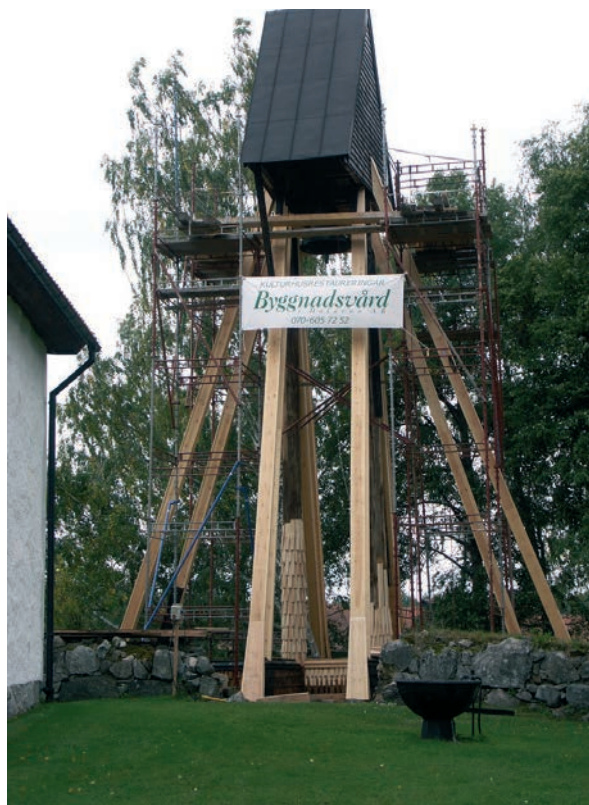
Bild 46. Klockstapeln sedd från öster under pågående arbete.
