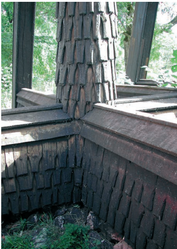
Bild 34. Detalj av Floda klockbocks syll och mittstolpe, klädda med näbbspån.
