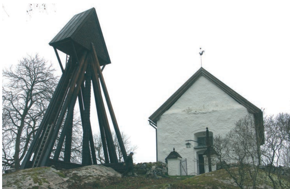
Bild 1. Halla klockstapel efter restaureringen 2005.
