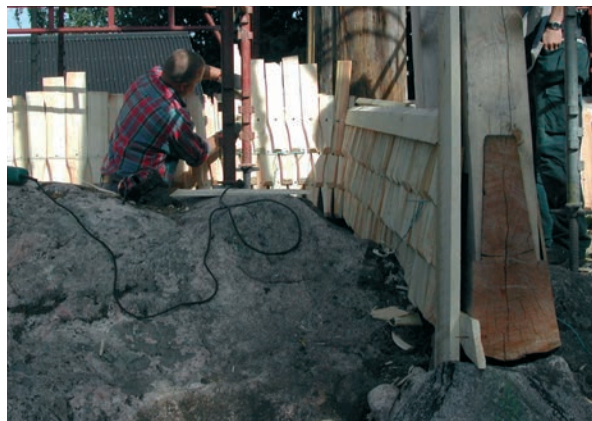
Bild 36. Övre spånlager spikas på. Henrik Larsson i bild.
