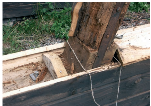
Bild 16. Inre snedsträva, understödd med kloss.
