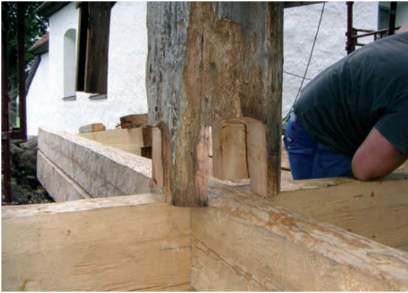
Bild 27. Mittstolparna högs ur med yxa. Fotografi Stefan Östberg.
