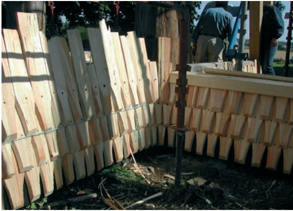
Bild 37. Detalj av näbbspånsinklädnaden.
