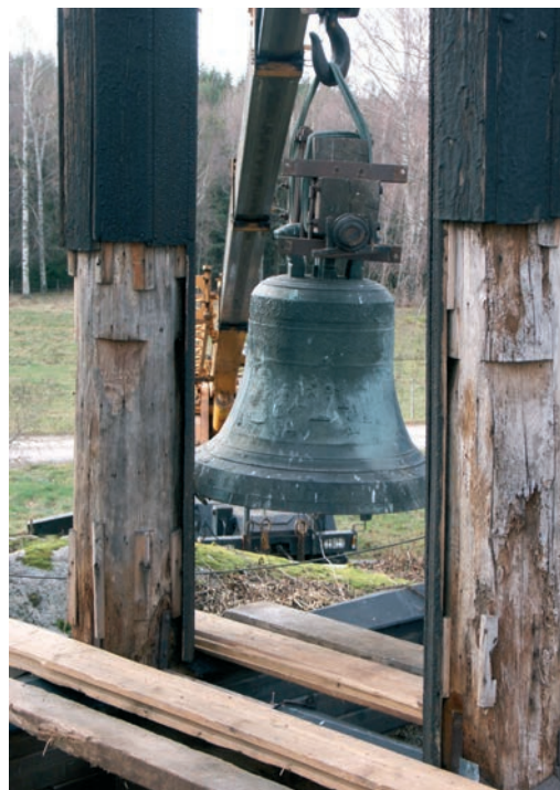
Bild 19. Klockan tas ned i november 2004 m h a skylift.
