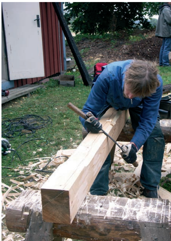
Bild 44. Nya strävan fasades med bandkniv av Fredrik Lindberg.
