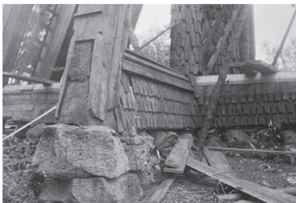
Bild 6. Detalj av Floda klockstapel vid reparationer 1919. Fotografi Sven Brandel, Kulturmiljöbild, ATA.
