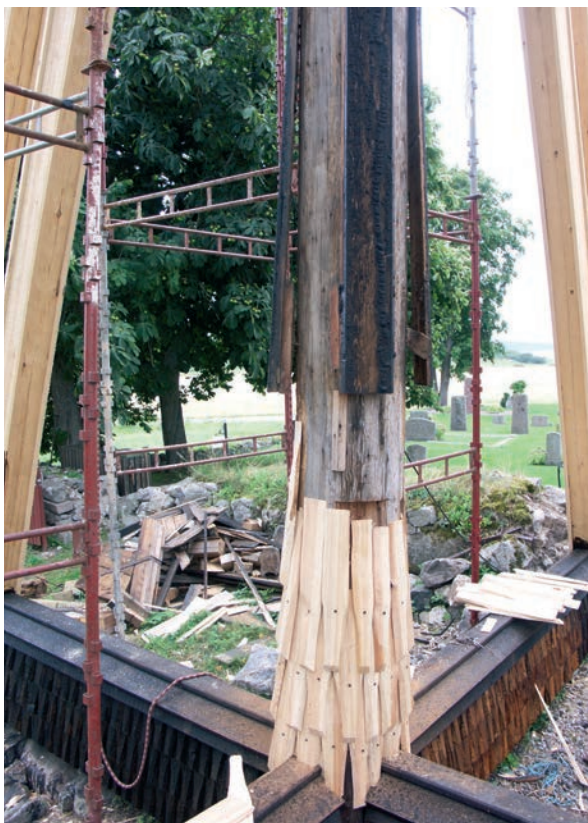
Bild 42. Nedre delen av klockstapeln som nu är klädd med näbbspån.
