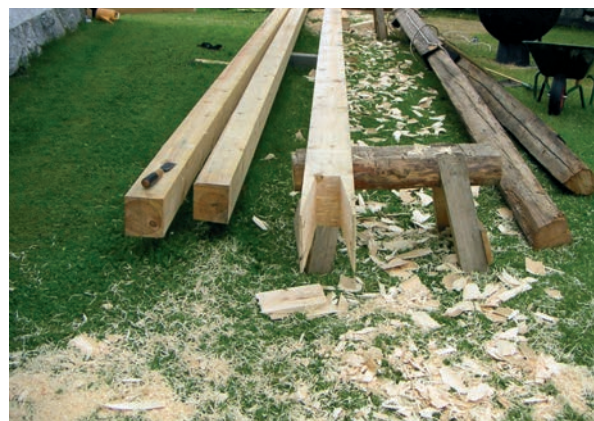
Bild 30 & 31. Till vänster: Detalj av urtaget i syllen för snedsträvan. Till höger: Snedsträvorna utformade som en klo. Fotografi Stefan Östberg.
