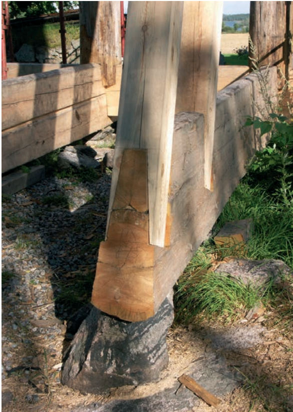
Bild 32. Detalj av yttre och inre snedsträva.
