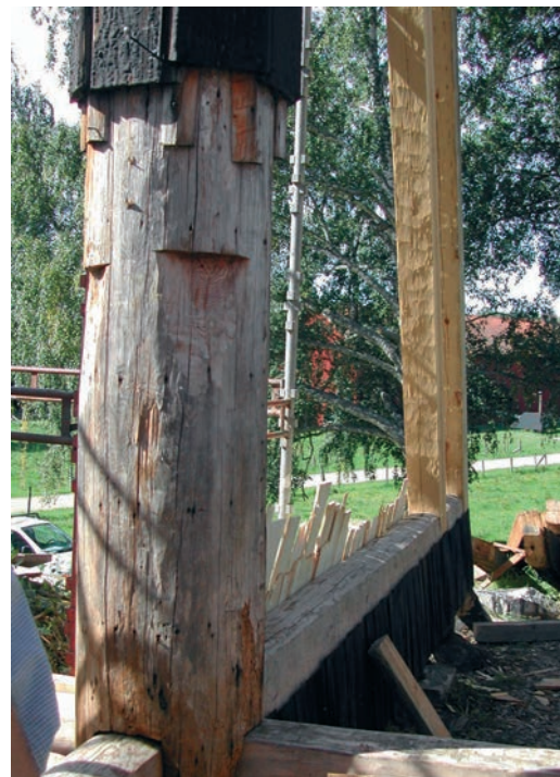
Bild 41. Mittstolpen hade tydliga märken efter näbbspånsens spikrader.
