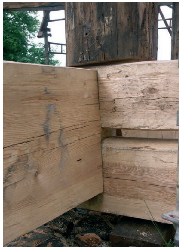
Bild 26. Syllstockarna förbands halvt i halvt.
