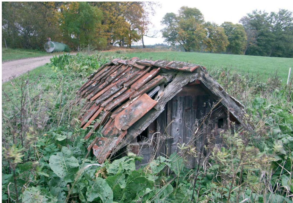
Bild 47. Lilla pumphuset placerat öster om ekonomibyggnaderna.
