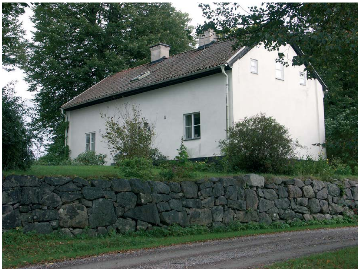
Bild 15. Södra flygeln sedd från sydväst.
