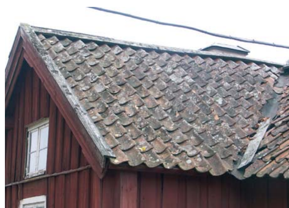
Bild 24 & 25. Till vänster gårdshuset sett från väster och till höger detalj av taket med figursågad vindskiva och rostig plåtränna.
