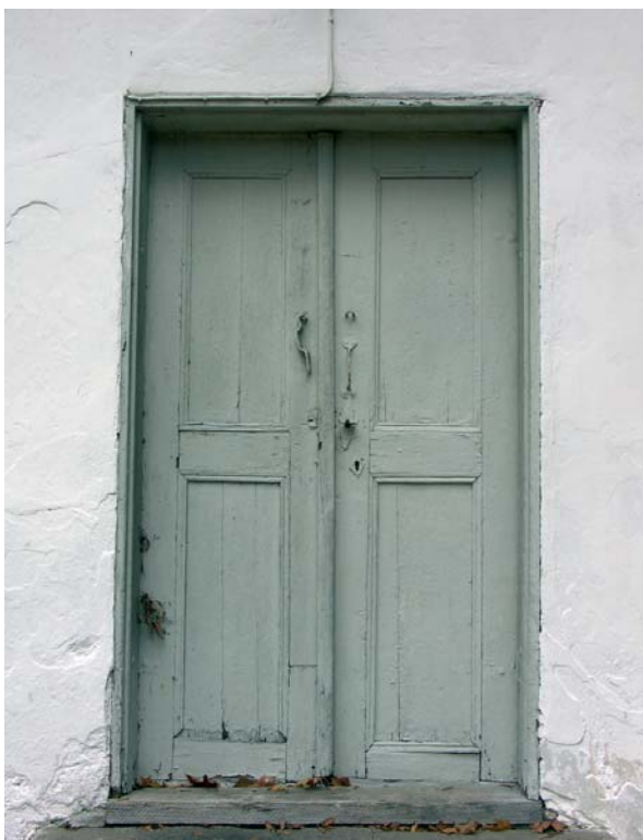
Bild 18. Detalj av norra flygelns portal.
