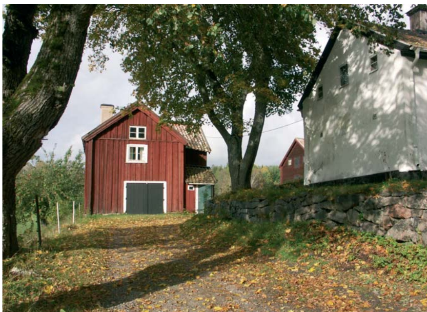
Bild 26. Gårdshuset sett från söder, till höger norra flygelns gavel.
