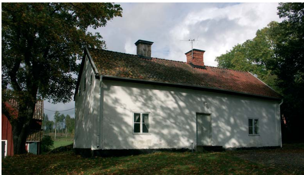
Bild 16. Norra flygeln sedd från sydväst.
