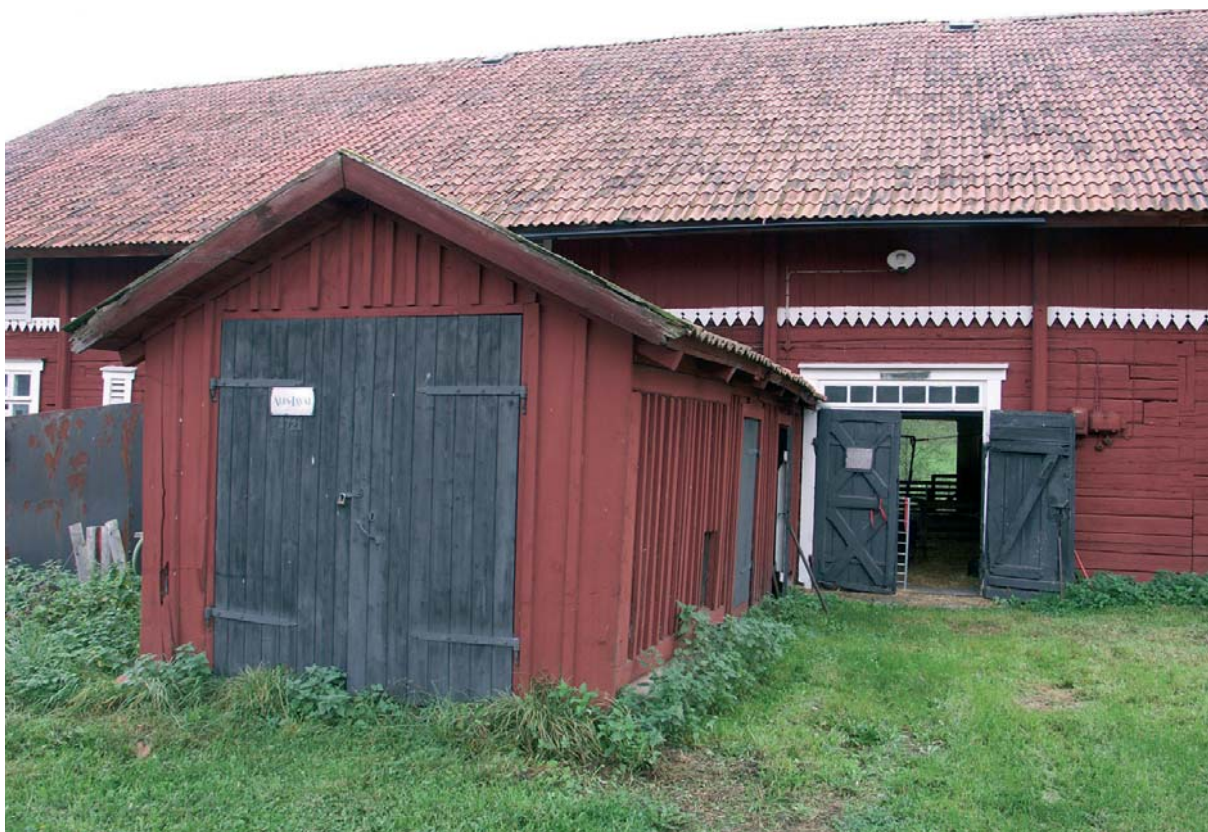
Bild 37. Mjölkrummet sett från nordost. Observera de dekorativa kryssen på dörrbladen och spetsdekoren på fasaden.
