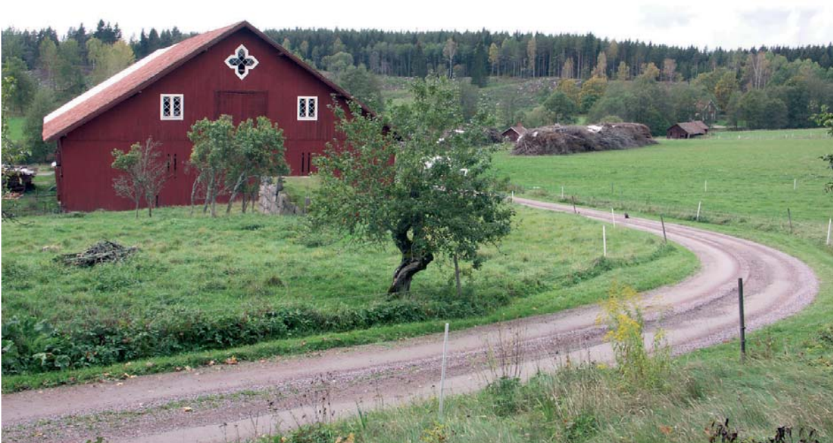
Bild 4. Vy från öster mot fägårdens nordvästra del. I bild syns logens östra gavel och till höger kan smedjan och sågbyggnaden anas.
