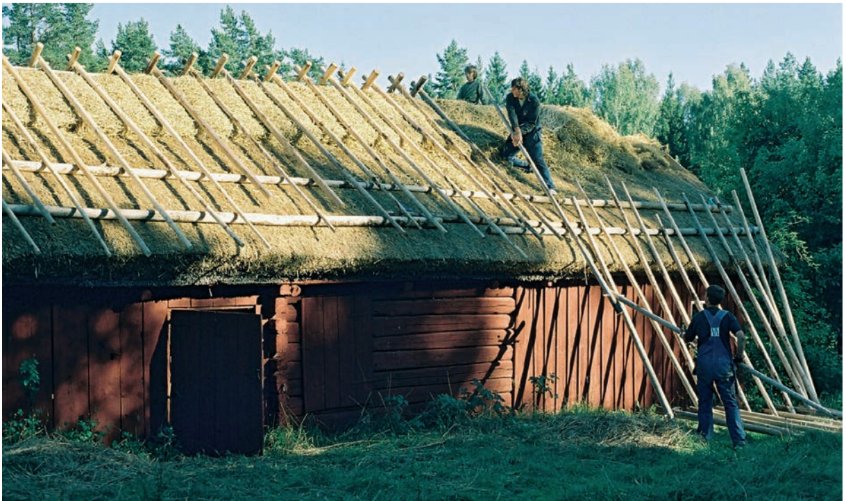
Bild 19. De vertikala takryttarna placeras ut över takfallen. Hantverkare Eje Arén och Johan Arén. I bild även Anton Hylander.
