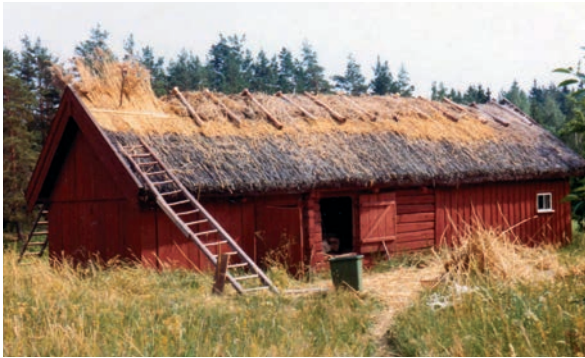
Bild 4. 1970 läggs ny ryggning. Fotografi inlånat av fastighetsägaren. Foto Louise von Krusenstierna.
