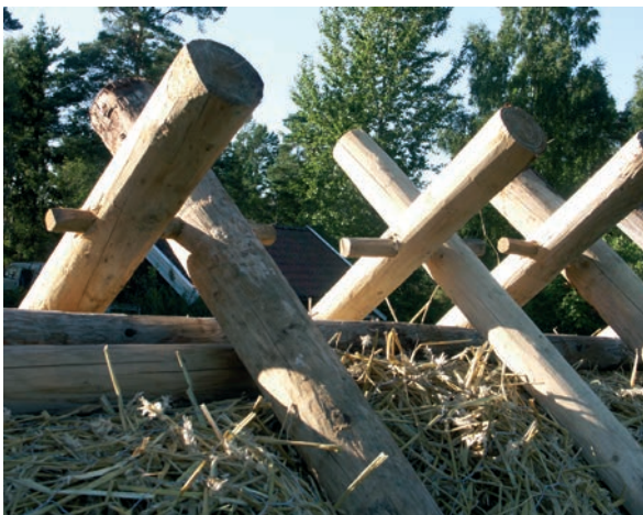
Bild 20. Takryttarna sitter ihop parvis över nocken med en dymling.
