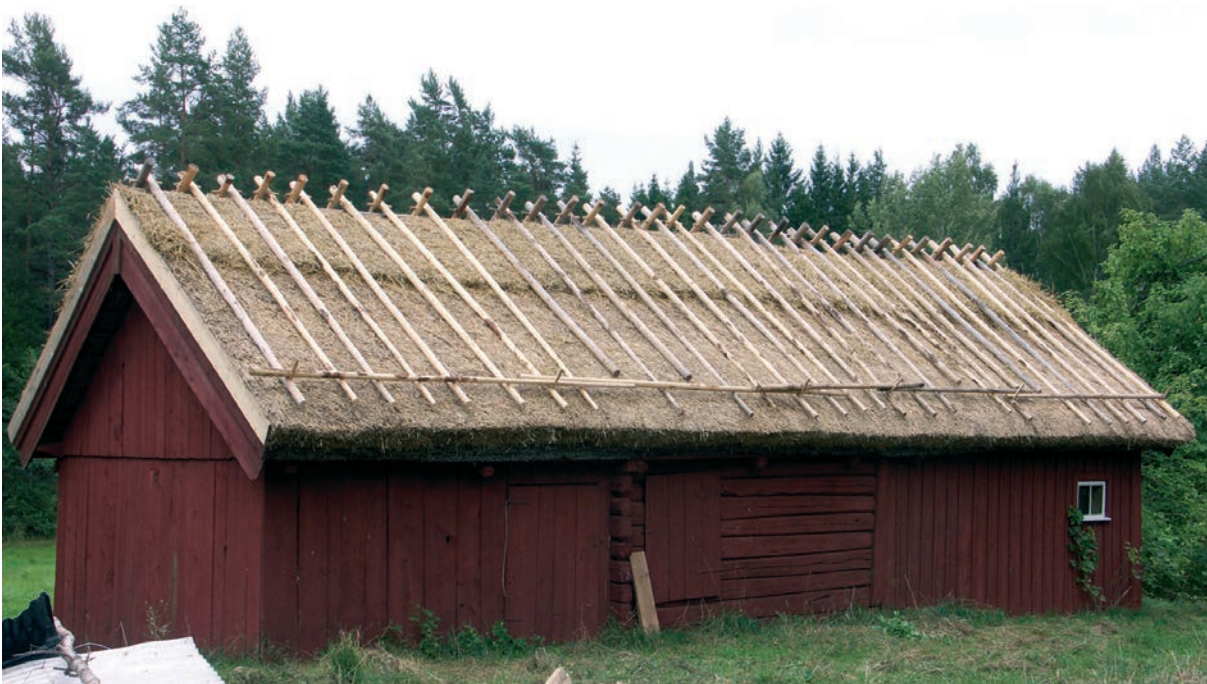
Bild 21. Vassläggningen är klar.
