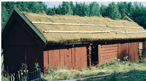
Bild 15. Västra takfallet är utlagt. De horisontella rundslanorna är till för att gå på under arbetets gång.
