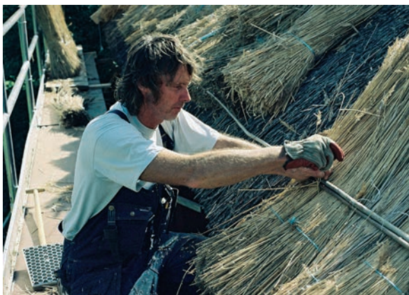
Bild 12. De två nedre raderna av kärvar hålls fast i underlagstaket med bindraft av hassel.
