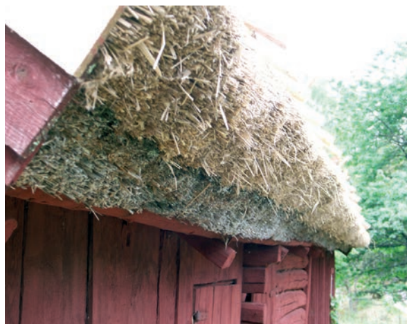
Bild 23. Takskägget efter läggning med tidigare vasslager och det nya.
