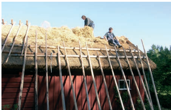
Bild 16. Halmen till ryggningen läggs ut.
