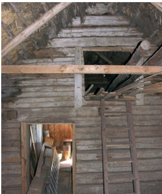
Bild 7. Vy från logen in mot ladugårdsdelen. De horisontella långåsarna vilar på timmerstommen.
