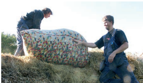
Bild 17. Halmen bars upp i säckar som breddes ut övernocken. Hantverkare Eje Arén och Johan Arén.
