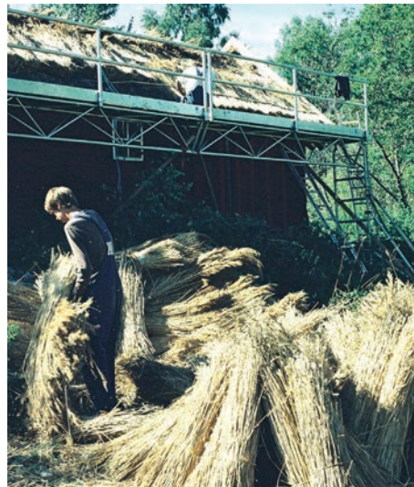
Bild 11. Kärvarna av vass läggs ut jämnt över taket med början längst ned vid takfoten av hantverkare Per Holmqvist.
