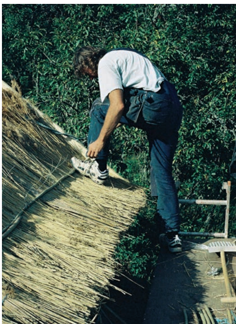
Bild 13. Bindraften trycks åt hårt för att vassen ska hållas kvar och för att få bra bindning i längsslanorna och binds fast.
