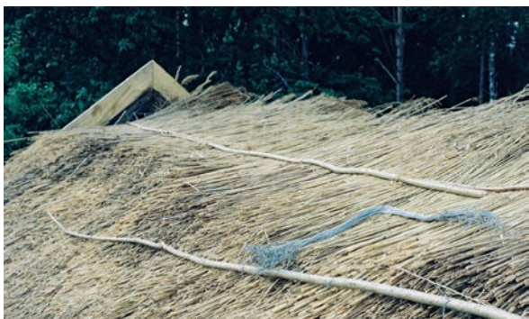
Bild 14. De två övre raderna av vassen som kommer att hamna under ryggningen hålls också fast med bindraft av hassel och binds med ståltråd. Två rader binds för att få ned rottoppen ordentligt.
