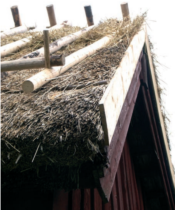
Bild 22. De horisontella fotstängarna vilar på dymlingar som sitter i takryttarna.
