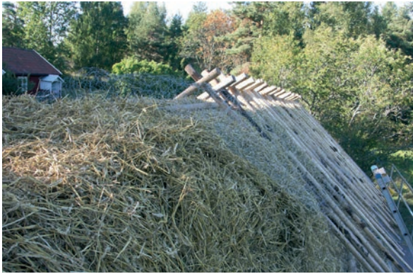
Bild 18. Ovan halmen breddes hönsnät ut, för att få en längre livslängd på ryggingen.
