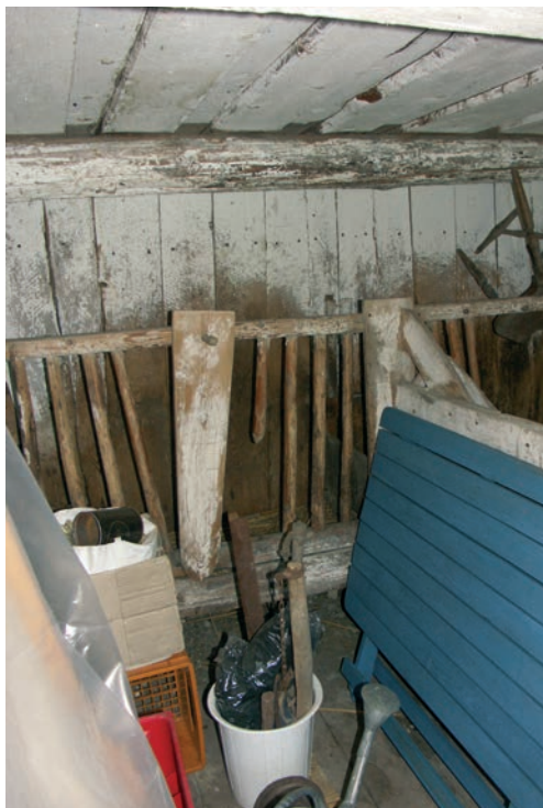
Bild 9. Ladugårdsdelen där båsinredningen för två djur finns kvar. Väggar och tak är vitkalkade.
