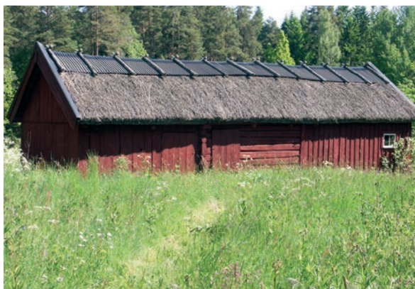
Bild 1. Segerstastugans log- och ladugårdsbyggnad från väster innan åtgärder.
