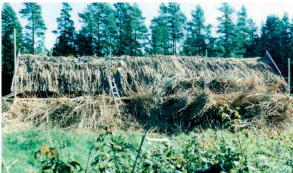
Bild 5. Nästa gång taket lades om var 1989 då sannolikt undre lagret sparades och ny vass lades på. Fotografi inlånat av fastighetsägaren. Foto Louise von Krusenstierna.
