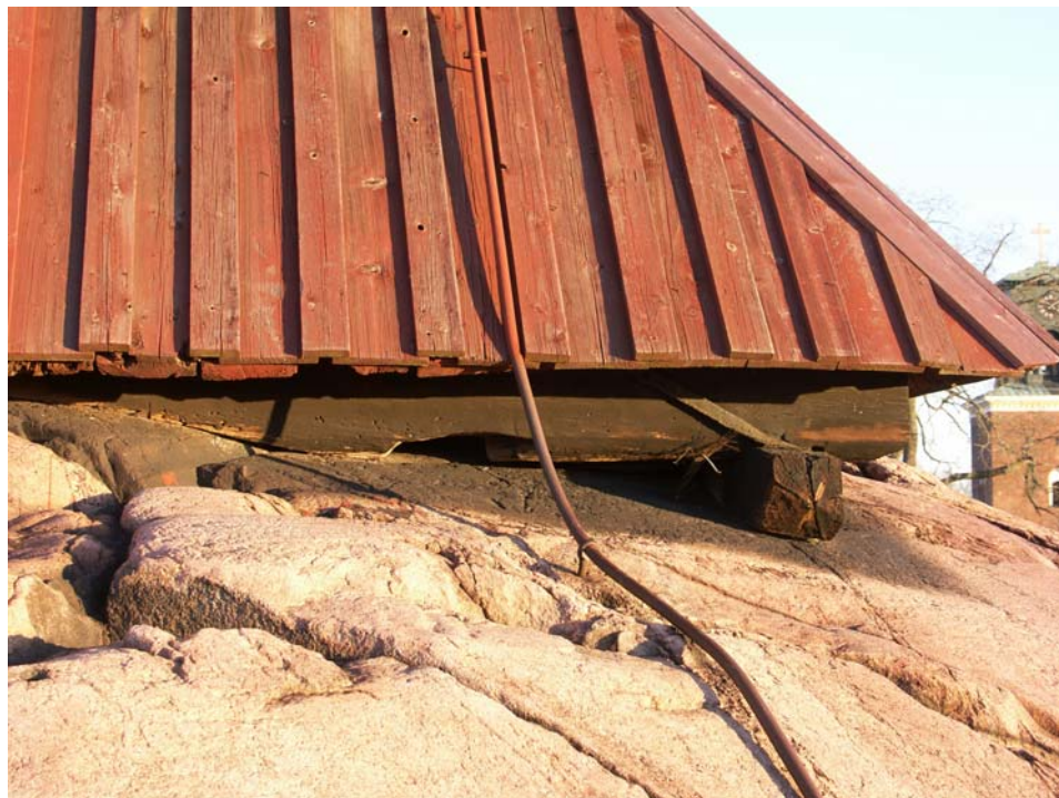
Del av klockstapelns västra hörn, med syllstockar direkt på berg.
