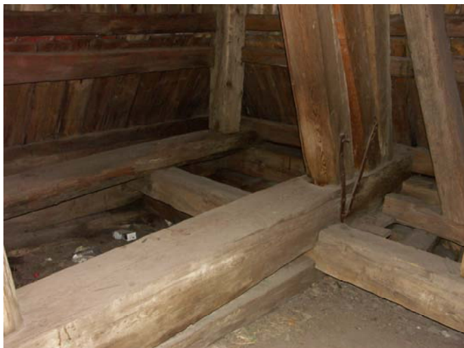
Del av klockstapelns nordvästra hörn på plan 1. Snedsträvan är tappad i syllstocken.
