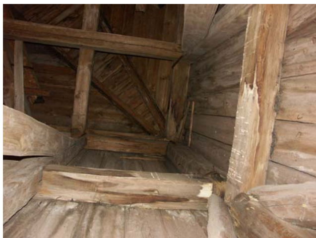
Till vänster svampangrepp i klockstapelns södra hörn. På fotografiet syns även de äldre små lucköppningarna. Till höger vy upp i stapelns norra hörn.
