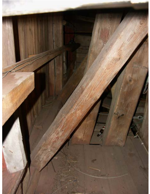
Detalj under stora klockan, Till höger en av snedsträvorna på östra delen av klockstapeln som motverkar lutningen av tornets övre del.
