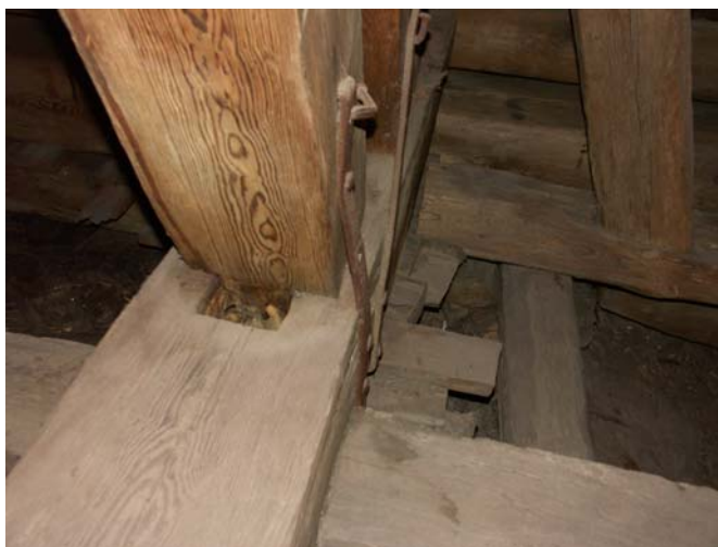
Del av klockstapelns nordvästra hörn på plan 1. Snedsträvan är tappad i syllstocken.
