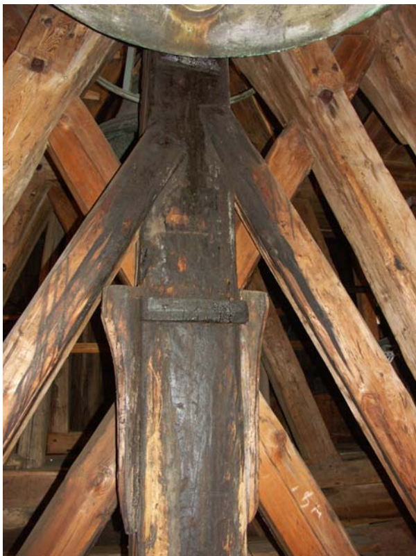
Detalj under stora klockan, Till höger en av snedsträvorna på östra delen av klockstapeln som motverkar lutningen av tornets övre del.
