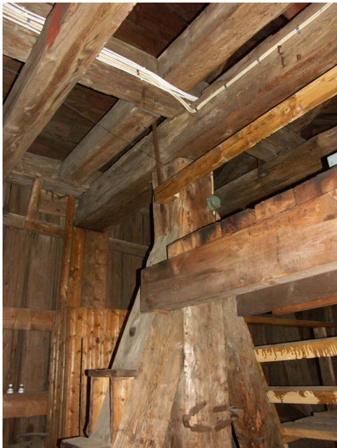
Till vänster västra stolpens avslut på plan 3. Stolpen är tappad i bjälken ovan och förbunden med järmband på södra sidan av stolpen. Överst till höger norra stolpen.
