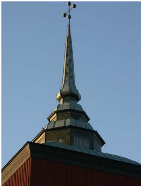
Stapelns torndel, med den fönsterförsedda lanterninen. Spirans kulor är utbytta och har tidigare varit förgyllda.
