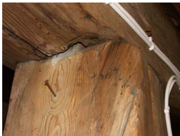
Till vänster västra stolpens avslut på plan 3. Stolpen är tappad i bjälken ovan och förbunden med järmband på södra sidan av stolpen. Överst till höger norra stolpen.
