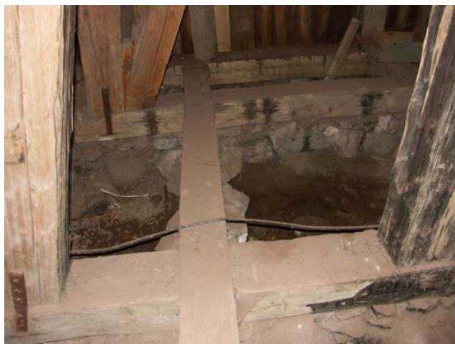
Till vänster detalj av en syllstock som är intappad i den åttakantiga syllramen. Även stolpar är sannolikt tappade i syllen. Syllstockar ligger i kryss upplagda på naturstenar direkt på berg.
