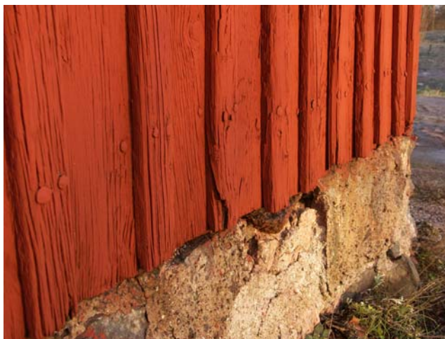
Mycket av den gamla panelen finns bevarad, med fasade locklister, spikade i jämna rader.
