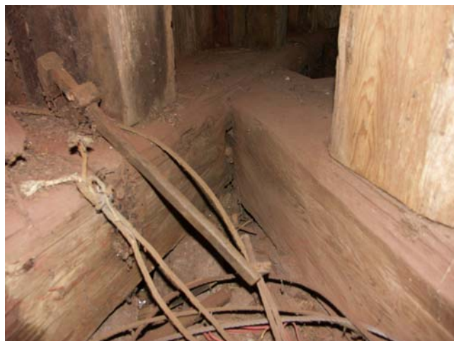
Till vänster detalj av en syllstock som är intappad i den åttakantiga syllramen. Även stolpar är sannolikt tappade i syllen. Syllstockar ligger i kryss upplagda på naturstenar direkt på berg.
