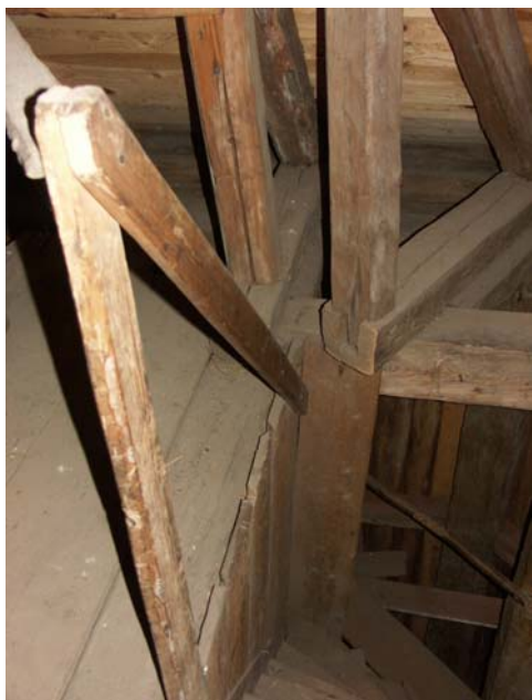
Vy ned i trappan från plan 4. Högbenet är intappat i tassan. Till höger spår av ett gammalt fågelbo på plan 4.
