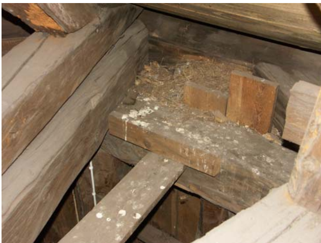
Vy ned i trappan från plan 4. Högbenet är intappat i tassan. Till höger spår av ett gammalt fågelbo på plan 4.
