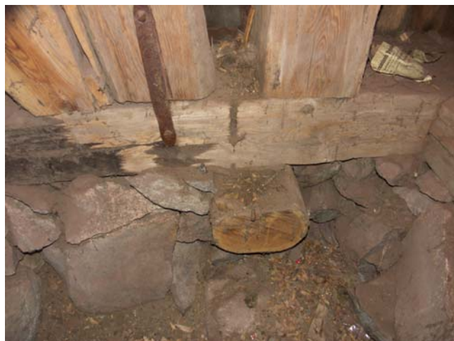
Järnband håller ihop snedsträvor och syllstock. Stolpar är dymlade i syllstocken.
