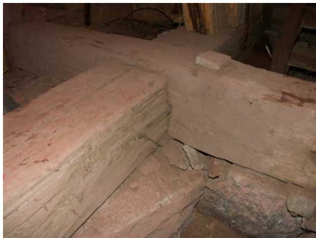
Till vänster detalj av en syllstock som är intappad i den åttakantiga syllramen. Även stolpar är sannolikt tappade i syllen. Syllstockar ligger i kryss upplagda på naturstenar direkt på berg.
