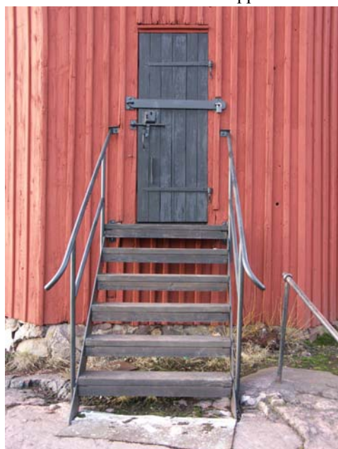
Mycket av den gamla panelen finns bevarad, med fasade locklister, spikade i jämna rader.
