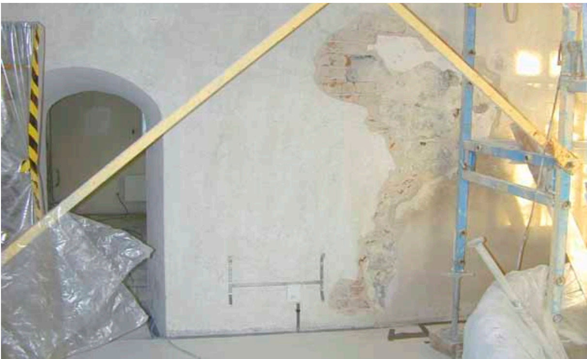
Figur 74. Utkragningen visade sig tillhöra en ojämnhet i murverket som jämnats ut sekundärt.
