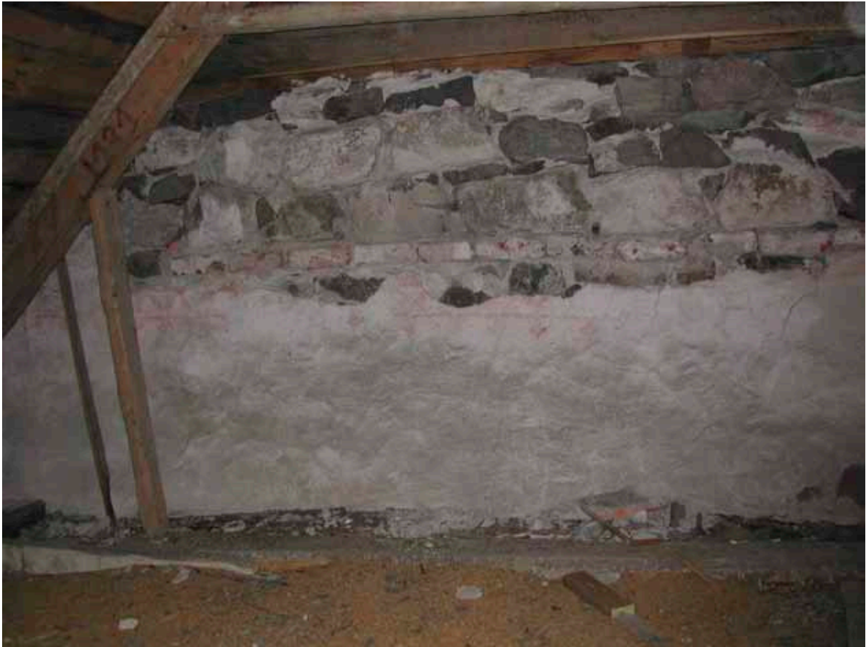
Figur 58. Från sakristians vind kan man se att kyrkans långsidor har förhöjts. Utjämningskiftet av tegel tillhör det gamla murverket vilket kan konstateras genom att spår av dekorationsmåleri även finns på detta. Tegelskiftet bör ursprungligen ha bildat underlag för ett remstycke av trä.
