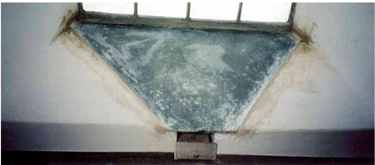
Figur 39. den invändiga solbänksplåten justerad. Foto: Kent Fredriksson 2003.
