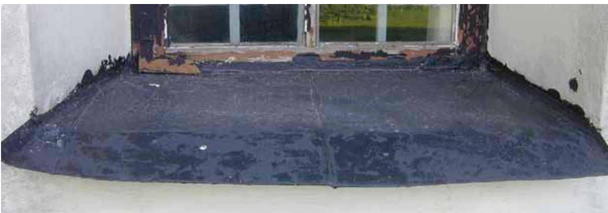
Figur 20. Den fortfarande intakta solbänken till sakristians östra fönster.
