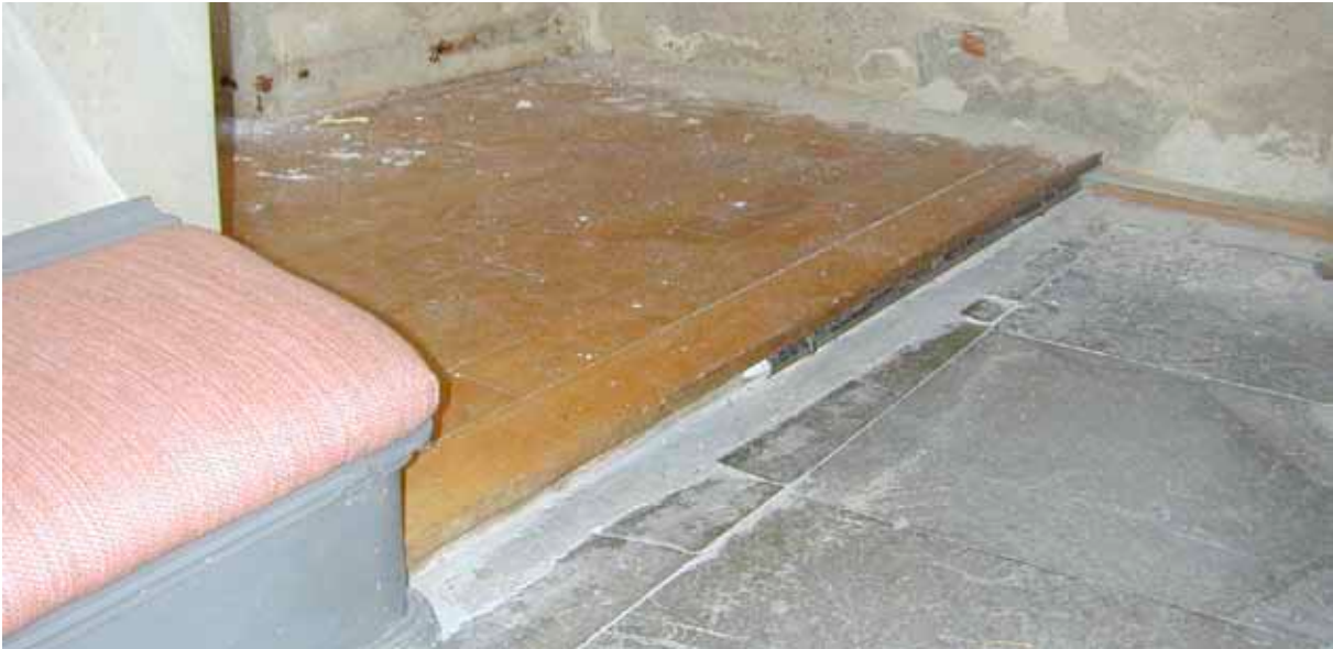
Figur 36. Trägolvet innanför altarringen före åtgärd.
