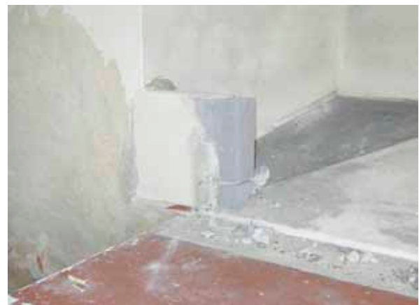
Figur 47 Betongkonstruktionen i anslutning till altarskåplsplaceringen revs och ersattes med en motsvarande i tegel år 2003
