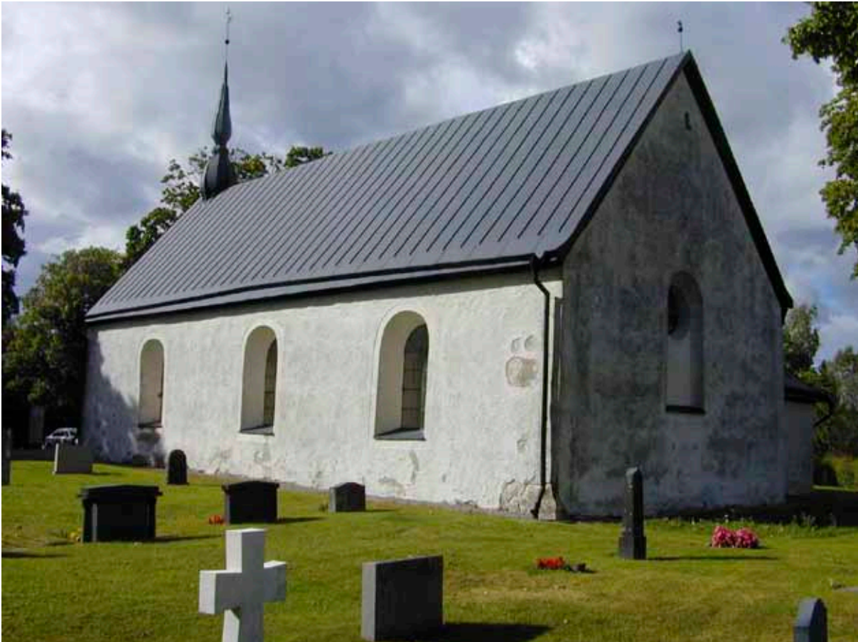
Figur 16. Putssläpp förekom på samtliga kyrkans fasader.
