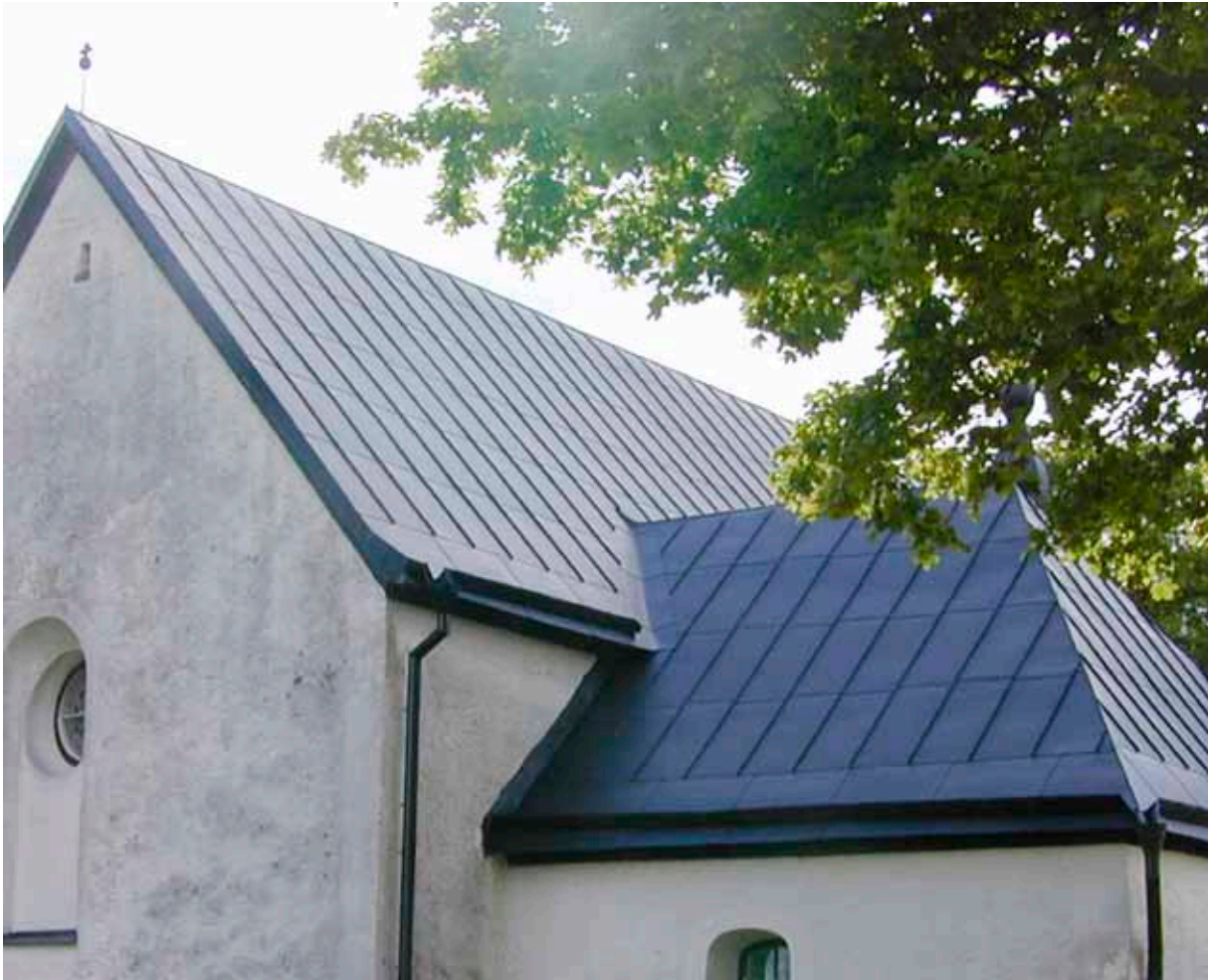
Figur 13. Plåttäckningen från år 1888 ersattes år 1999 med en ny plåttäckning.
