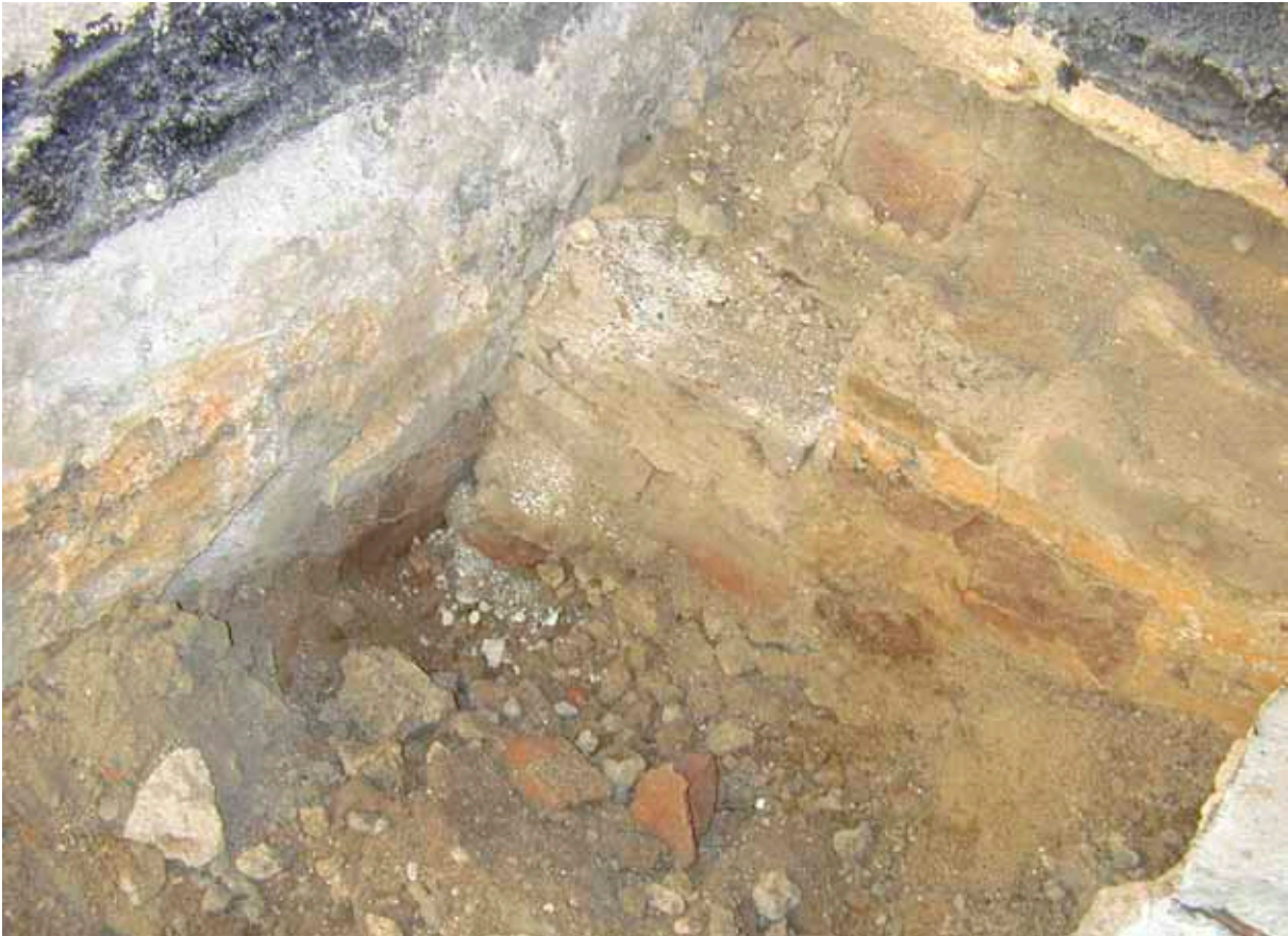
Figur 71. Fogen mellan första och andra tegelsten i respektive skift på altaravsatskonstruktionen uppfattas av författaren som en stötfog. Detta skulle innebära att altaravsatsen inledningsvis har stått fristående från östra korväggen, som möter till vänster i bild.
