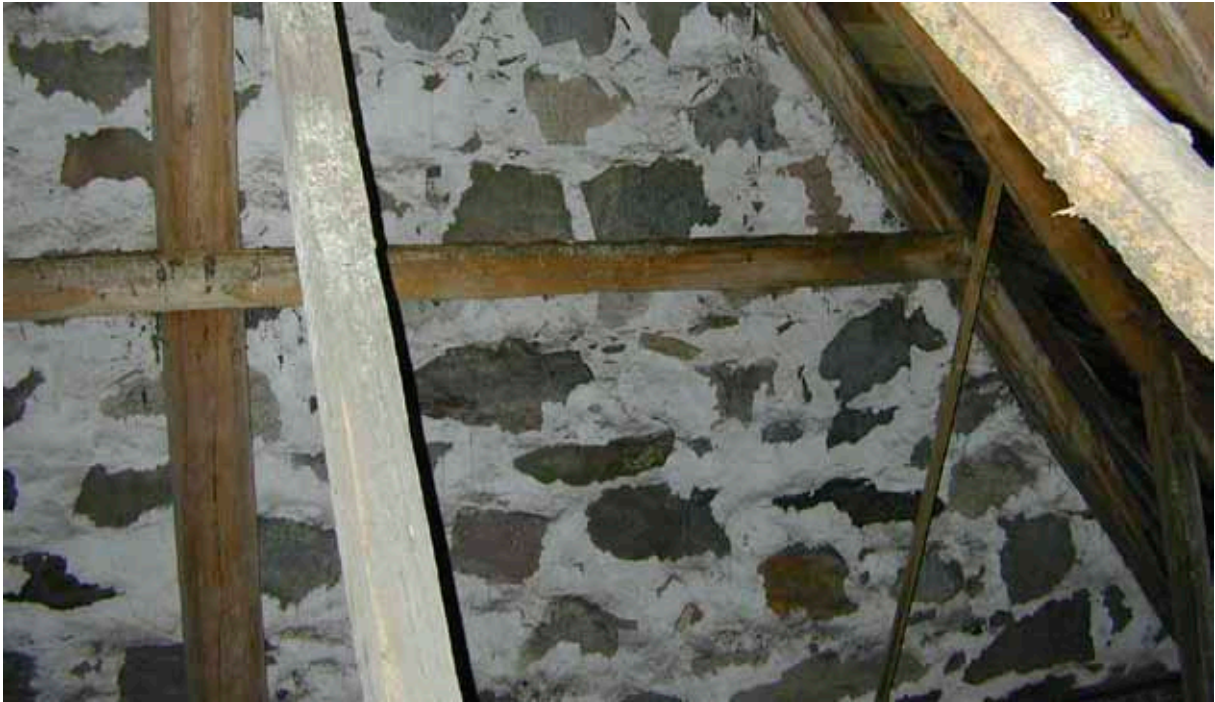
Figur 54. Västgavelns murverk har oregelbunden skiftgång med inkilad skolsten vilket tyder på en tillkomsttid runt 1300 snarare än 1100-tal som tidigare förmodats.
