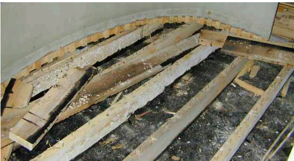
Figur 37. 1935 års golv demonterat.
