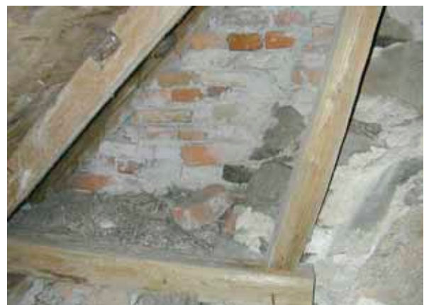
Figur 55. Gavelröstena har breddats sekundärt varvid tegel är använt i stället för gråsten. Foto från korvindens nordöstra hörn.
