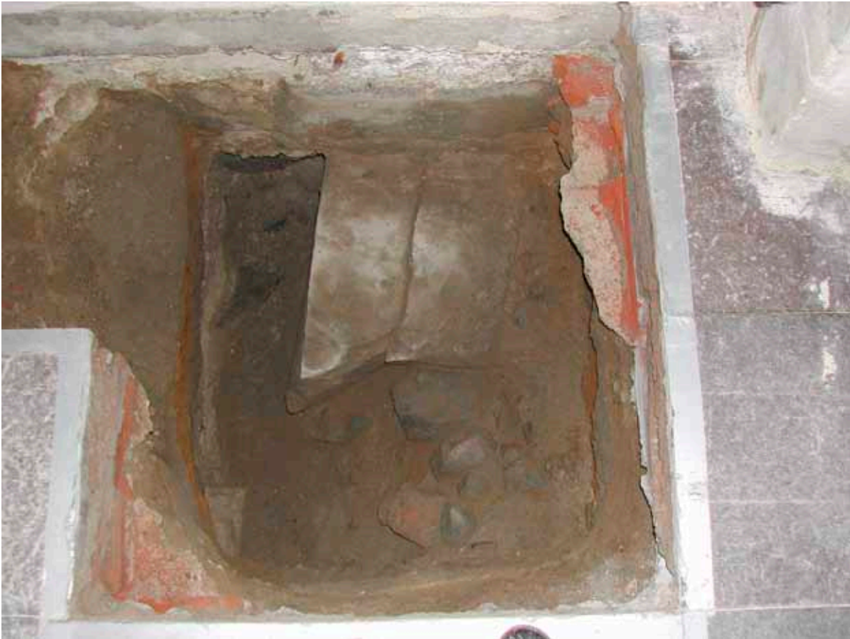
Figur 64. Grunden till en byggnad som föregår den nuvarande stenkyrkan påträffades i korets sydvästra del. Grunden som löper i nordsydlig riktning underlagrar det östvästliga murverket till korets södra vägg.
