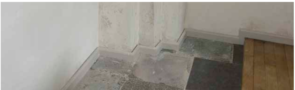
Figur 35. Golv och golvlist färdigt
