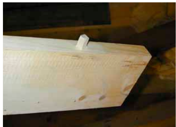
Figur 51. Golvbräderna sammanfogades sinsemellan med hjälp av tränaglar. detta system tillåter en viss ventilation mellan brädorna.
