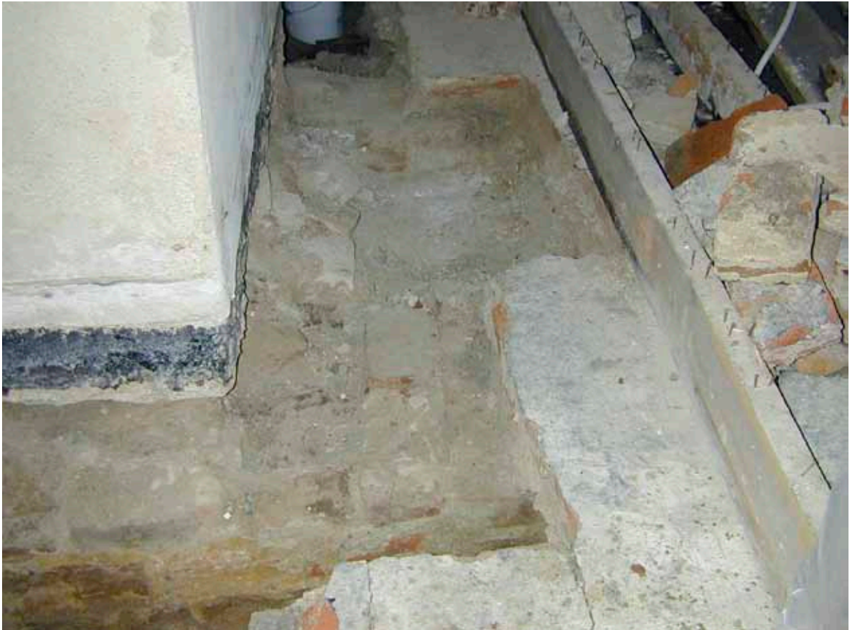
Figur 69. Grundläggningen till det altarbord som krönt avsatsen skjöt fram under det nuvarande altarbordet. Konstruktionen bröts delvis ner i samband med senare dräneringsarbeten.
