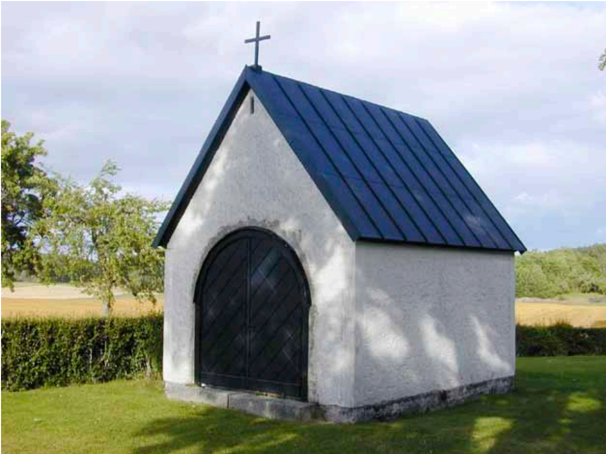
Figur 12. Gravkapellet från 1944. Foto taget inför putsagningsåtgärderna år 2003.
