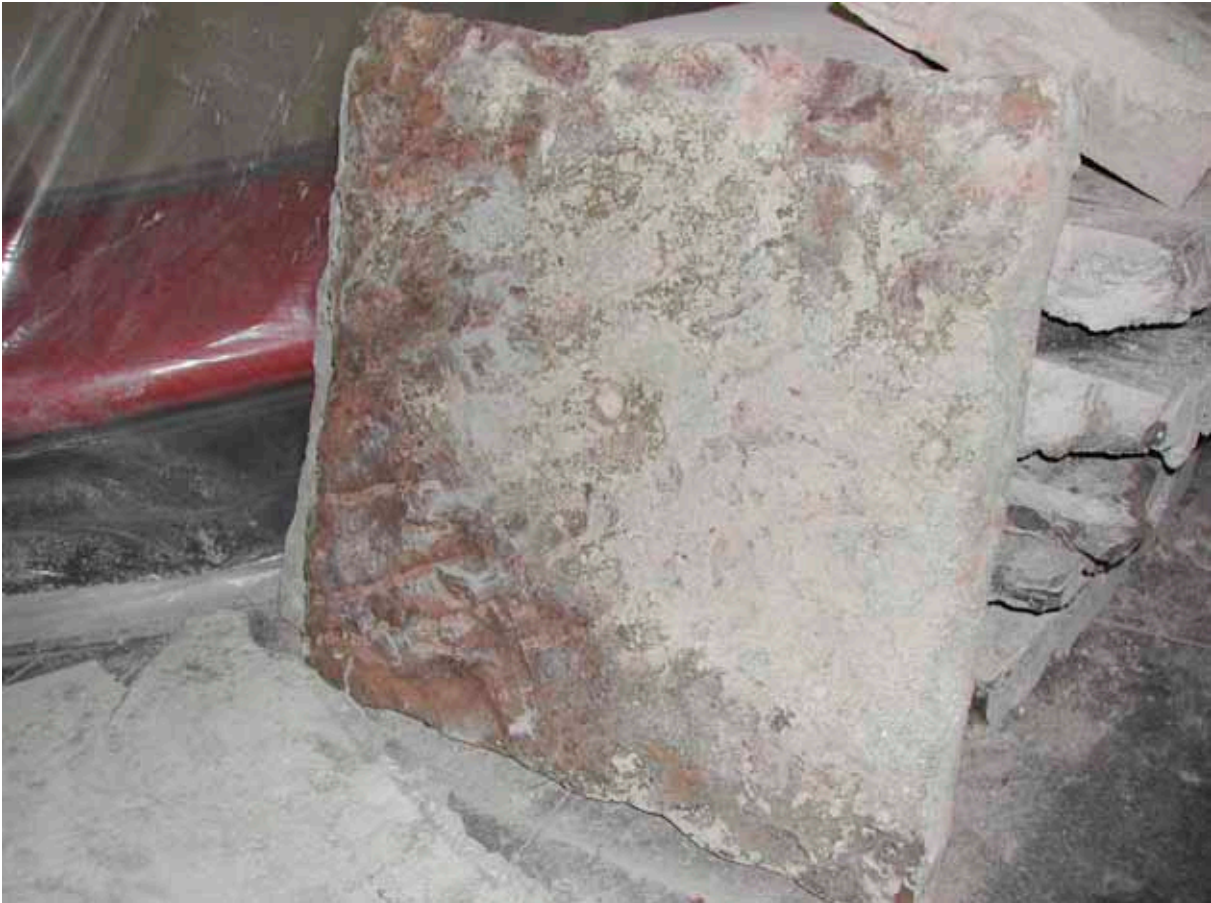
Figur 87. Kalkstenshällarnas undersida i det äldre kalkstensgolvet är försedda med en borrarad fördjupning i mitten.
