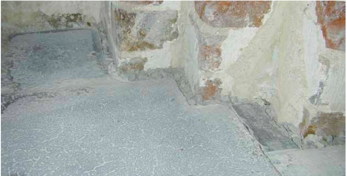
Figur 34. Av ventilationsskäl belades ej golvet med kalksten ända in till vägg.
