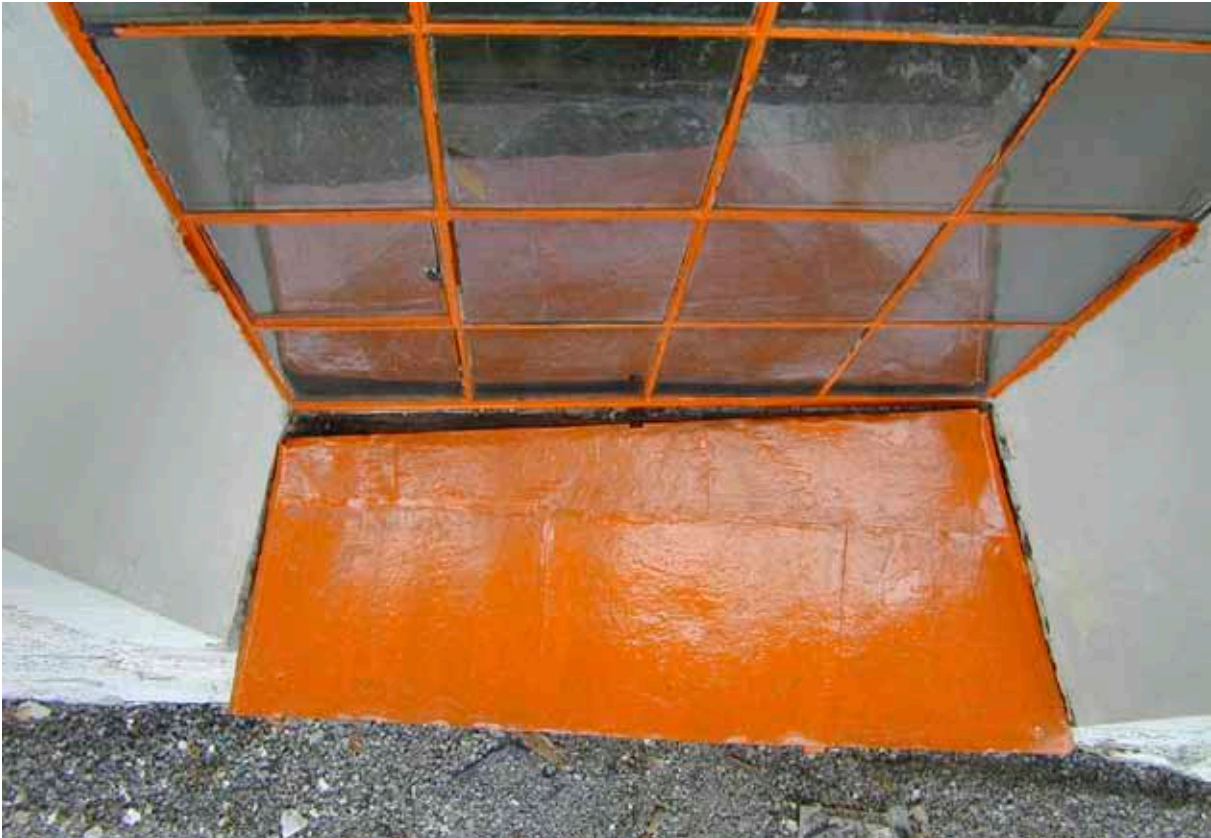
Figur 23. Solbänksplåtarna mönjades på fram och baksida. Solbänksplåten på långhusets norrsida innan dess att kanterna kliptes ner.
