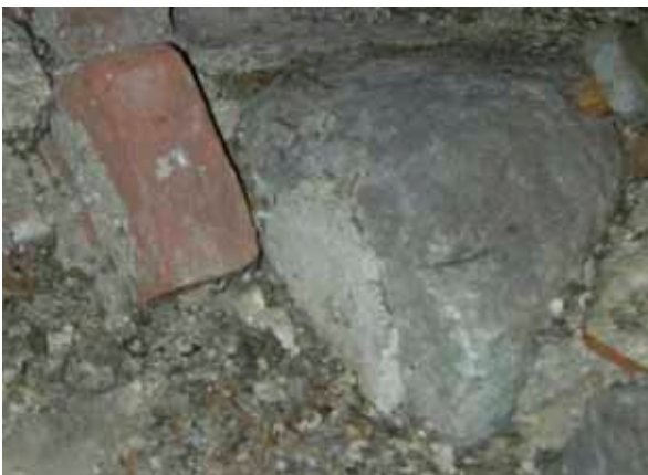
Figur 53. Ett bevarat parti slätputs synligt från vinden på långhusets södra murverk visar att kyrkan inte har varit försedd med valv ursprungligen. Innerväggarna har ursprungligen nått upp till dåvarande murkrön. Foto taget i långhusvindens sydvästra hörn.
