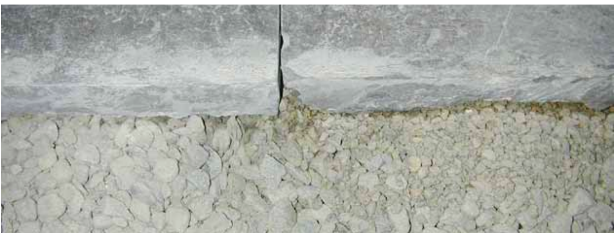
Figur 33. Det urschaktade golvet närmast vägg fylldes med singel.
