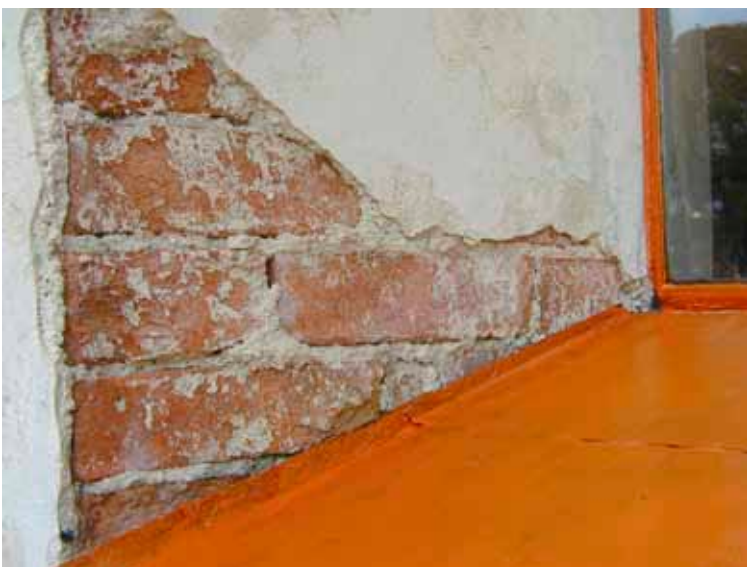
Figur 24. I samband med arbetet med solbänkarna frilades murverket i fönster-nischerna. Såväl sidor som underlag till solbänkarna är murat med handslaget kalksatt stortegele (mått ca 32 x 16 cm i plan). Detta tyder i likhet med solbänksplåtarnas utformning och uppdagandet av fönstrens tidigare stickbågiga form på att fönstren förstörats före år 1888 års restaurering. Bilden är tagen före det att plåtarna kliptes ner.
