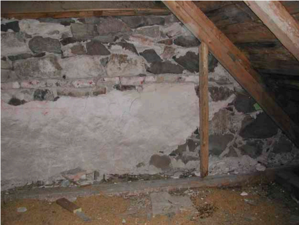
Figur 61. Läget för det östra takfallet på den sakristia som föregick 1731 års nyuppförda sakristia syns från vinden till denna byggnadsdel genom att den tidigare fasadputsens slutar i en diagonal skarv där taket tog vid. Bildens nedre högra hörn. Det bara murverket på motsatt sida denna skarv uppvisar samma oregelbundna skiftgång med skolning av småsten som de båda gavelröstena. (se figur 54 och 56).
