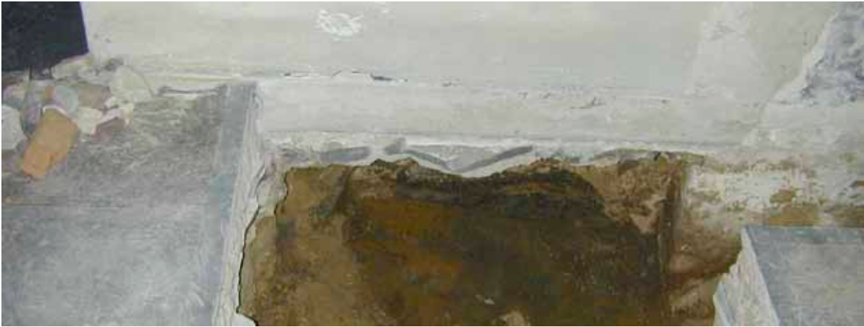
Figur 73. En sekundärt igensatt inkragning av murverket påträffades strax öster om ingången till sakristian. Det inkragade partiet syns till höger i bild. Sakristians dörröppning skymtar till vänster i bildens ovankant.
