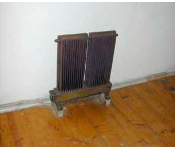
Figur 49. Elradiatorer från 1935 års restaurering togs bort i kor och sakristia. De finns dock kvar i långhuset
