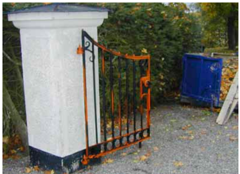
Figur 29. Grindar och plåtdetaljer på grindstolparna mönjades samt målning behandlades på samma sätt som metalldelar på kyrkobyggnaden
