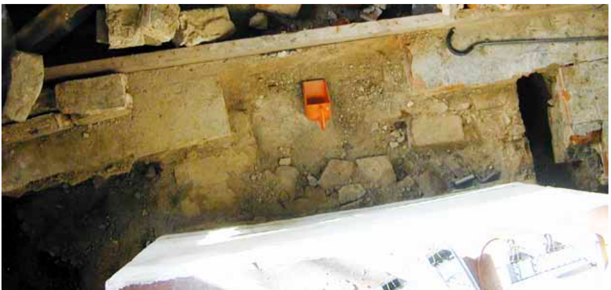
Figur 70. Altarrumskonstruktionen från ovan med delar av tegeltäckningen borttagen. Innandömet i den till sina ytskikt tegelmurade konstruktionen är utförd i grästen. Material ur denna fyllning skymtar till vänster om öskaret i bild.
