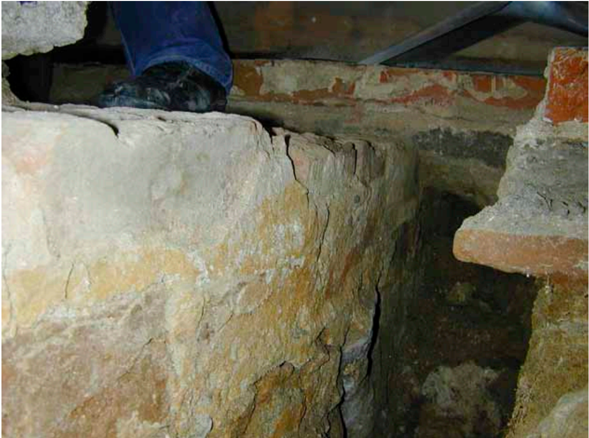
Figur 67. Den påträffade högaltaravsatsen löper in under golvpartier som ej blev frilagda i samband med undersökningen vilket innebär att dess utbredning åt väster ej är känd.. Det nuvarande altarbordet skymtar ovan till vänster i bild. Dess hörn hänger i luften eftersom golvtegel från det golv som överlagrar altaravsatskonstruktionen i sin tur underlagrar altarbordet. Det nuvarande altarbordet tillhör med andra ord inte högaltaravsatsen.
