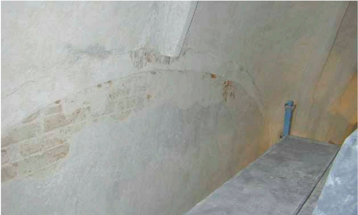
Figur 42. En av de mer intressanta upptäckterna under putslningsarbetena var förekomsten av en sköldbåge till korvalvet åt norr. Avsaknaden av ett sådant liksom den murförtjockning som igensättningen av densamma medfört har använts som bärande argument vid tidigare datering av kyrkan samt tolkning av kyrkans byggnadshistoria. Existensen av denna gördelbåge försvagar därför kraftigt sakgrunden för tidigare uppfattningar i dessa frågor (se även avsnittet "Påträffad utkragnign i korets norra vägg" nedan.
