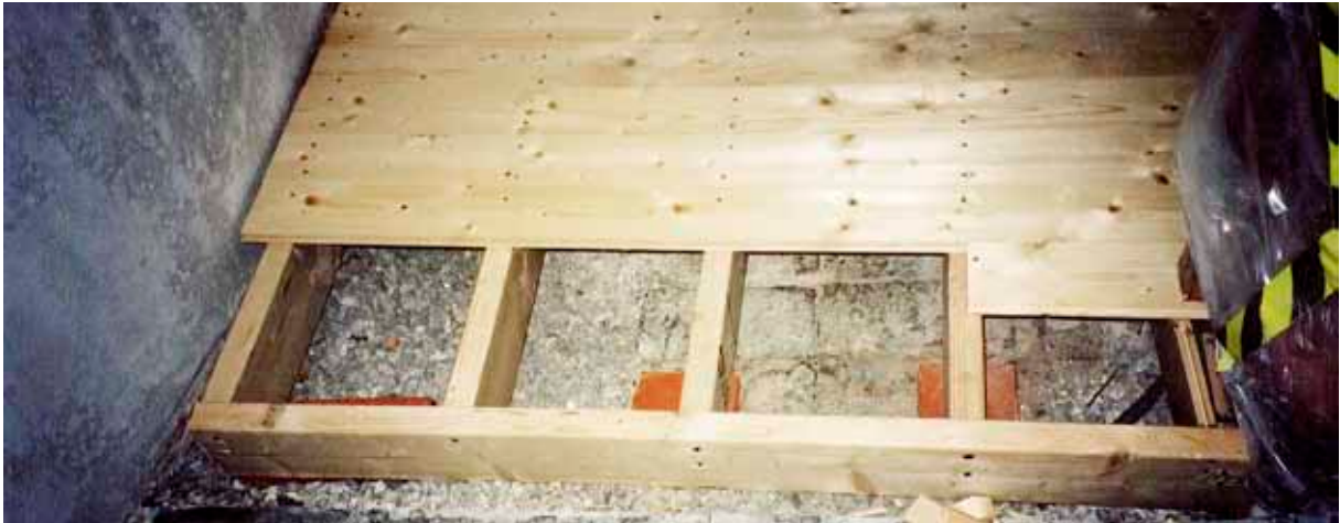
Figur 38. Det nya golvet innanför altarringen läggs. Foto: Kent Fredriksson, 2003
