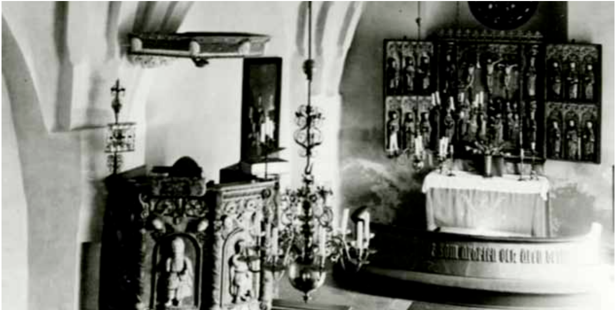
Figur 31. Tio år efter den restaurering där golvet innanför altarringen tätades hade omfattande kapillära fuktproblem uppstått i korets östra murverk. Foto: Ivar Schnell, 1945, Sörmlands museums arkiv
