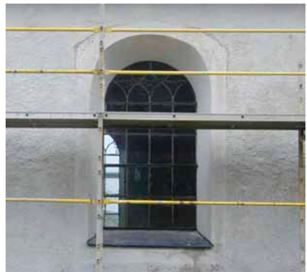
Figur 18. Frilagd omfattning till den tidigare stickbågiga öppningen. Mellanfönstret åt söder. Jämför med västgavelns fönster figur 10, sid. 12.
