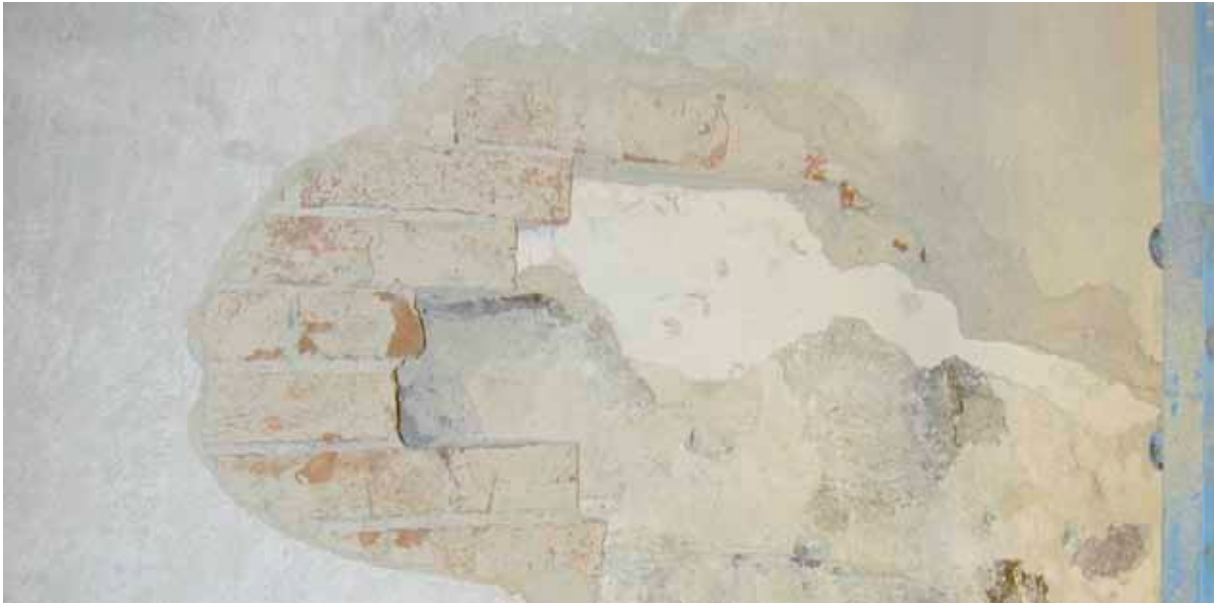
Figur 75. En gradvis och mjul övergången råder mellan det buktande putsade gråstensmurverket och det tillhuggna och utjämnande tegelmurverket.
