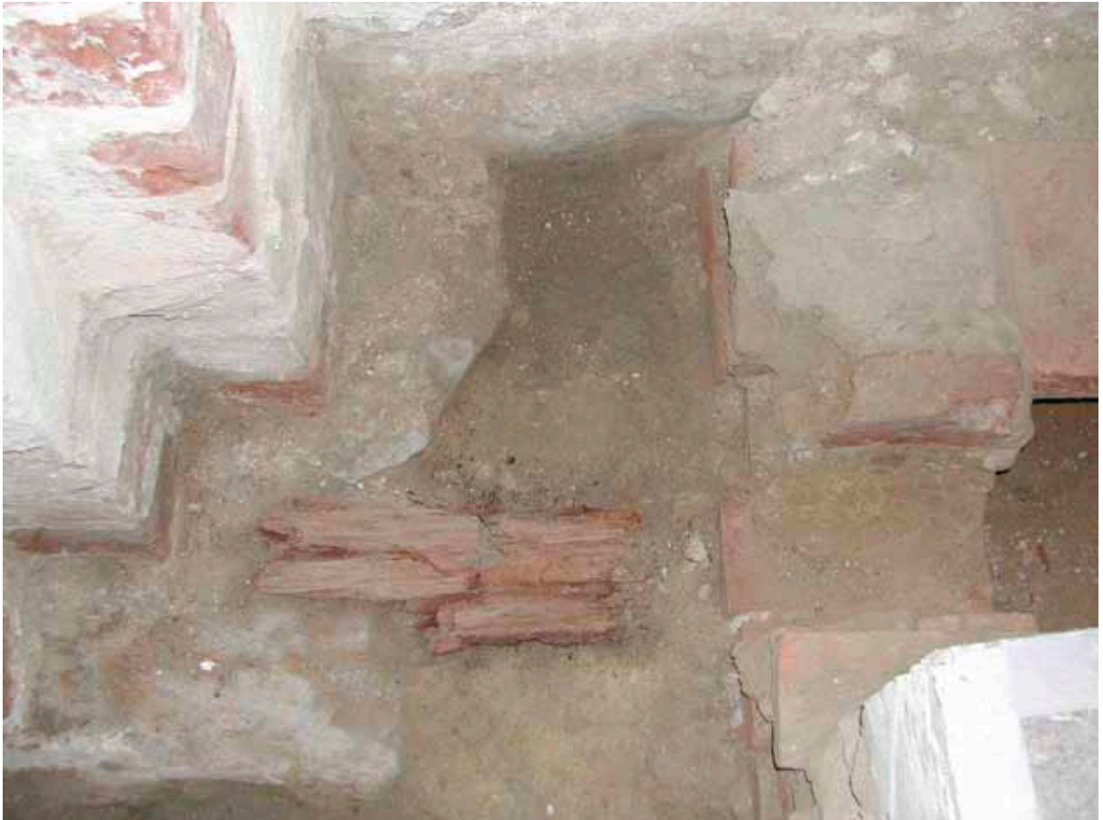
Figur 78. Rester av de bjälkar som burit upp gravens håll fanns fram tills nu kvar vid gravens östra gavel.
