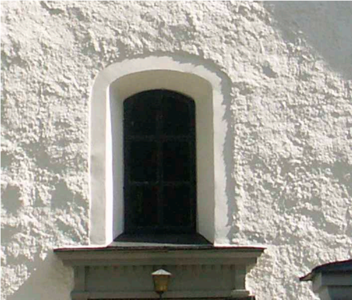
Figur 10. Fönstret på västra gaveln togs upp åt 1776.
