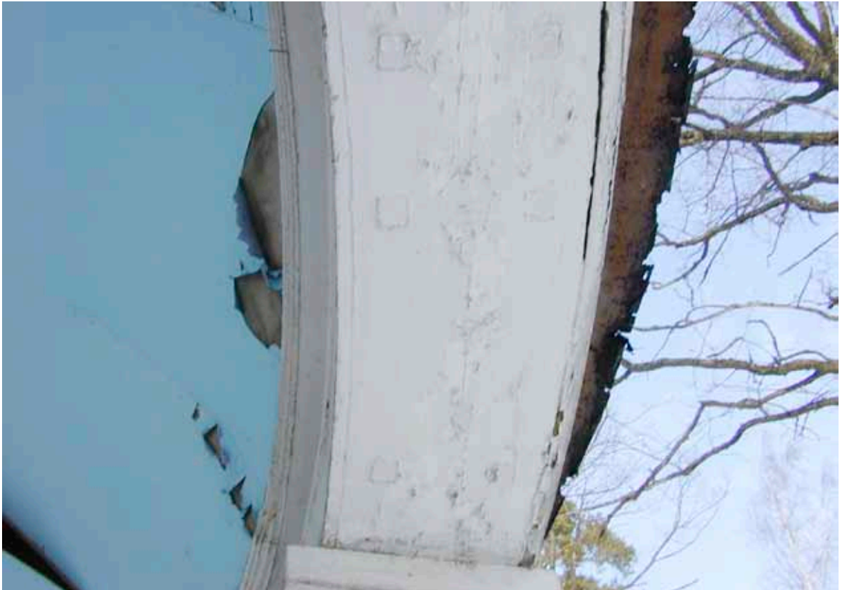
Figur 15. Brädinklädnaden av entablementets undersida har tappats fast med entablementet med kraftiga tappar. Konstruktionen är överdriven om det enda syftet är att fästa de aktuella brädorna. Tapparna bör ha en vidare funktion i entablementets konstruktion. Vilken funktion och i såfall hur denna konstruktion ser ut har ej varit möjlig att utröna inom ramen för detta projekt. I samband med ett eventuellt senare förnyande av templets innertak kan kanske saken utredas i samband med att entablementets ovansida friläggs.
