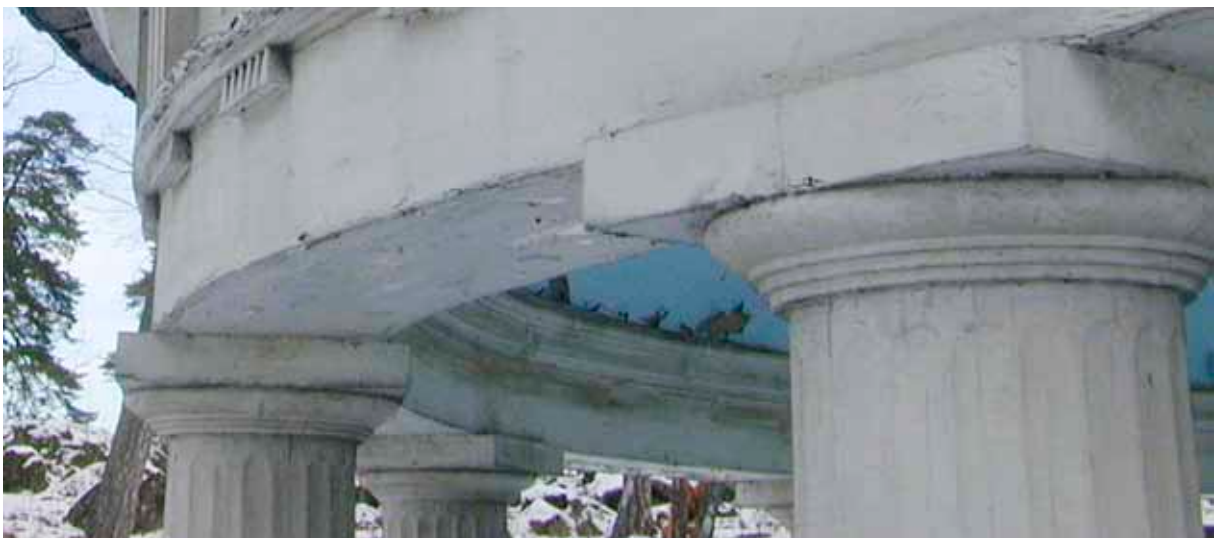
Figur 12. Kolonnerna är utformade enligt dorisk kolonnordning där kapitalet är försett med abakus (fyrkantig platta), ekinus (den rundade dynlika underdelen samt anuli (ringarna på kapitalets nederkant. Kolonnskäften har kannelyrer (räfflor).
