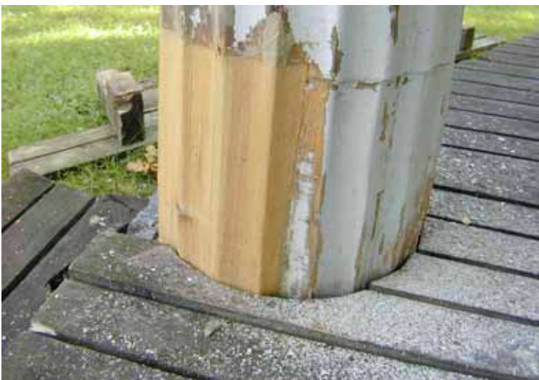
Figur 10. I samband med omläggning av golvet vid 1900-talets mitt, förhöjdes golvet så att golvbrädorna till skillnad mot tidigare, ligger upplagda på fundamentet till kolonnerna. Lagningen t.v. är utförd av Bengt Berglund (se s.17). Den övermålad lagningen på t.h i bild på kolonnnsen är utförd under 1950-talet.
