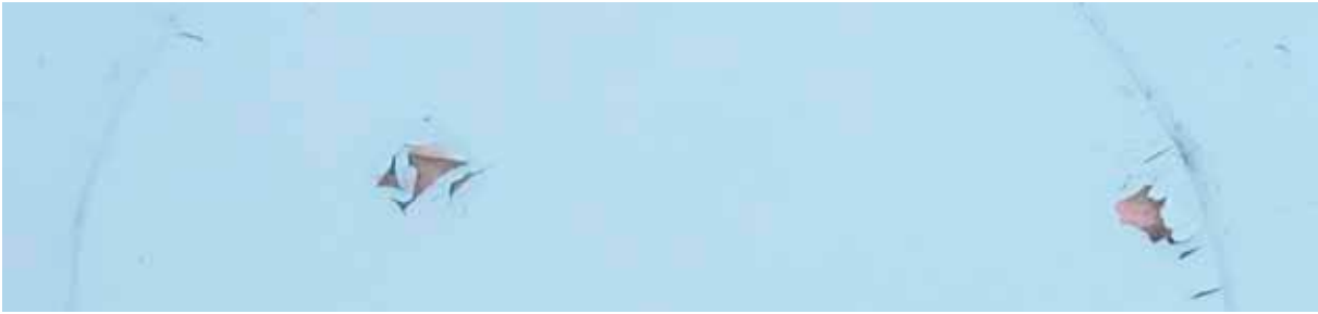
Figur 17. Den blå plastfärgen på templets innertak flagar. En rosa och för masonitetaket troligen ursprunglig kulör skymltar under den befintliga blå.
