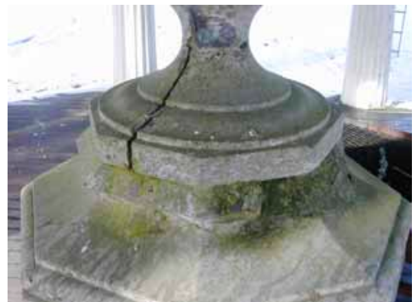
Figur 43. Skada som bör lagas av stenkonservator om urnan ska flyttas till ett läge utan skyddstak.
