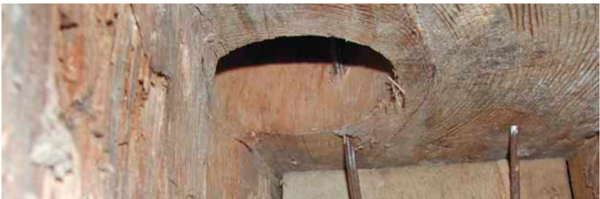
Figur 35. Kolonnernas timmerkärnor är borrade. Sannolikt har detta skett för att reducera risken för märgsprickor.
