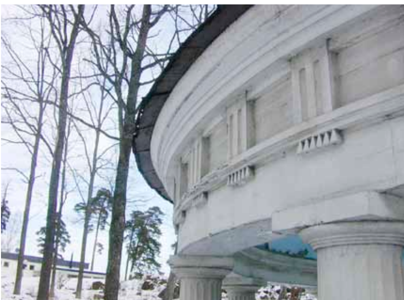
Figur 14. För att förstärka entablementets horisontella verkan har templet utformats med triglyffris.
