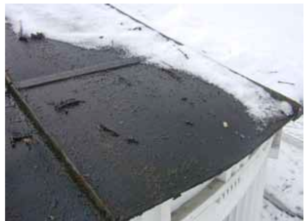
Figur 16. Yttertaket är täckt med enkelfalsade ogalvade järnplåtsskivor. Denna typ av taktäckning blir allt mer sällsynt.
