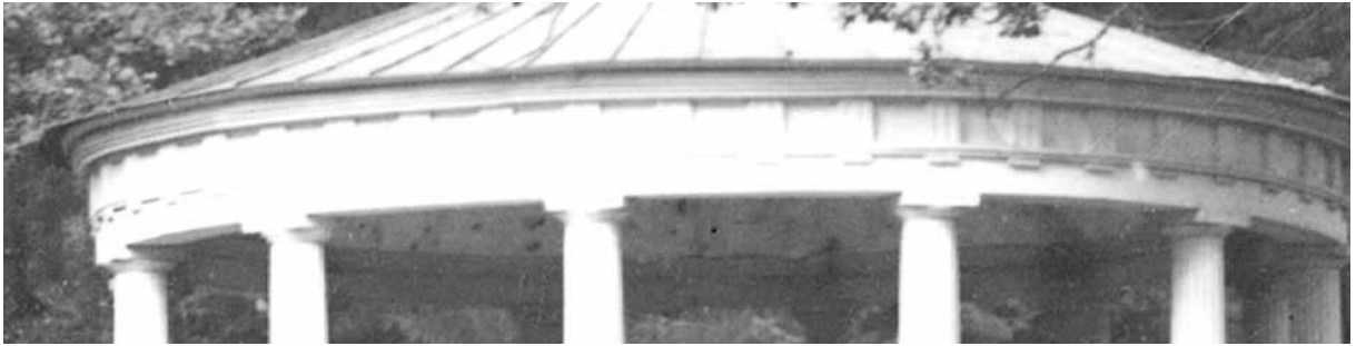
Figur 38. Det innertak templet hade vid 1900-talets början skymtar på fotot. Taket är målat i en ljus kulör. De mörka fläckarna kan möjligen tolkas som färgflagor eller revor i en vävspänd yta. Takets i så fall dåliga skick vid denna tidpunkt indikerar att det vid fototillfället kan vara relativt gammalt. Det är därmed inte osannolikt att man skymtar det ursprungliga innertaket från sent 1700-tal på bilden. (utsnitt av fig. 1, sid 5).
