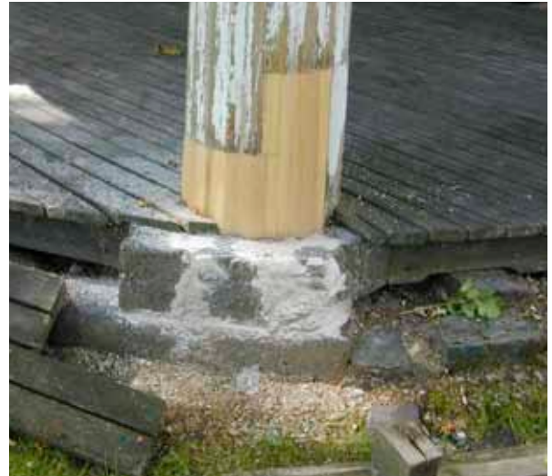
Figur 24. Berglunds färdiga lagning. Berglund lagade även slaggstensfundamentet varvid luftkalkbruk användes. Kolonnen isolerades från fundamentet med näver. Det tidigare bakfallet åtgärdades i görligaste mån i samband med ommurningen av fundamentet.
