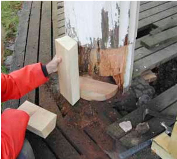
Figur 23. Bengt Berglund passar in en lagningsbit. Berglund valde att utföra lagningen utan lask samt att skära kannelyrerna i efterskott varvid varje bit kunde omfatta flera kannelyrer.
