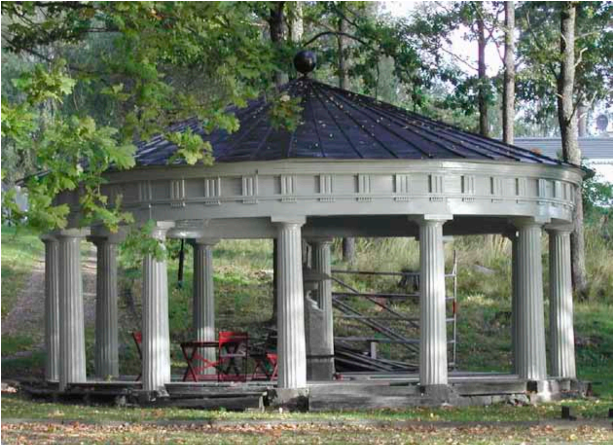
Figur 32. Ekotemplet efter målning. Kulören är vald utifrån det underst påträffade färglagret på byggnaden. Om vi har att göra med den ursprungliga färgsättningen, vilket är bedömningen, har templet nu återfått den färgsättning det hade under sent 1700-tal.
