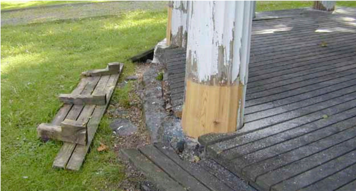
Figur 9. Brädgolvet är tillkommet i samband med underhållsarbeten på 1940 eller 1950-talet.
