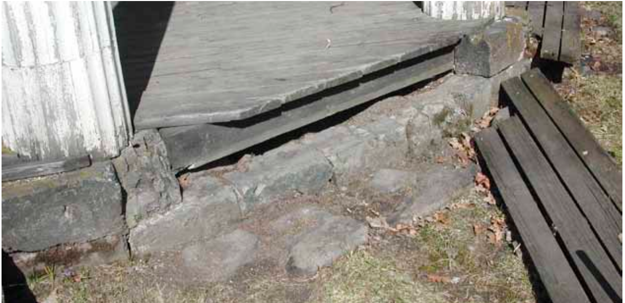
Figur 7. Kolonnerna är grundlagda med kalkbrukssatta slaggstensblock i två skift. Det undre skiftet löper ut i en syllstensrad som i dagsläget utgör upplag för trappstegen runt templet. Ursprungligen bör det ha utgjort upplag för ett trägolv som i ytterkant bör ha följt templets rundade form bättre än vad dagens golv gör.
