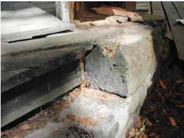
Figur 37. Det gamla golvupplaget i fasadliv fungerar nu som upplag för trappstegen runt templet. Det förhöjda partiet på bilden tillhör fundamentet till en av kolonnerna.
