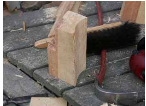
Figur 25. Björn Björkkvist valde att utföra sina lagningsbitar med lask. Varje bit omfattade en kannelyr. Kådrikt virke valdes som lagningsvirke.
