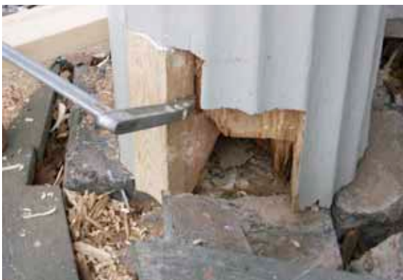
Figur 26. Lagningsbitarna inpassades, limmades och tappades på skrå. Sista biten fick limmas och spikas utifrån.
