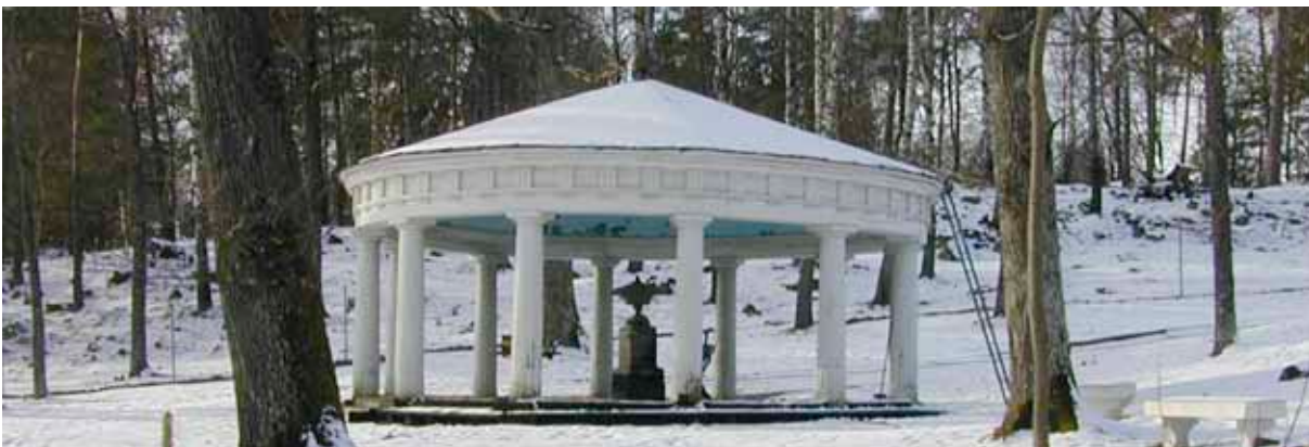
Figur 6. Templet före åtgärd i februari 2004.
