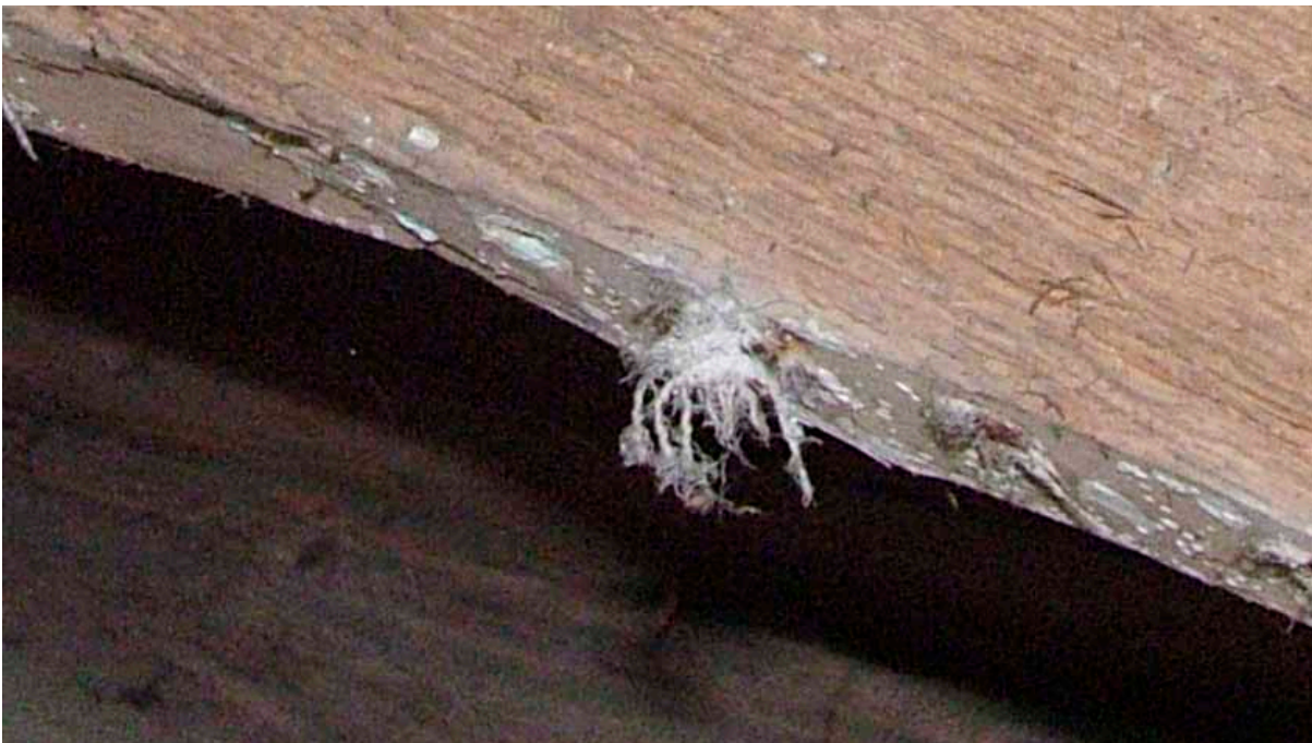
Figur 41. Textilludd, en rest av det tidigare vävspända taket. (Foto: Anita Lindqvist 2004)
