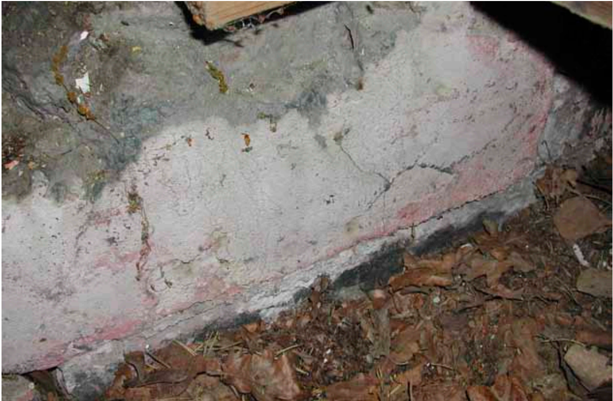
Figur 34. Sockelns insida bär spår av puts vilket indikerar att socklarna som helhet har varit putsade. Den rosa kulören är sannolikt resultatet av ett rödalgsangrepp.
