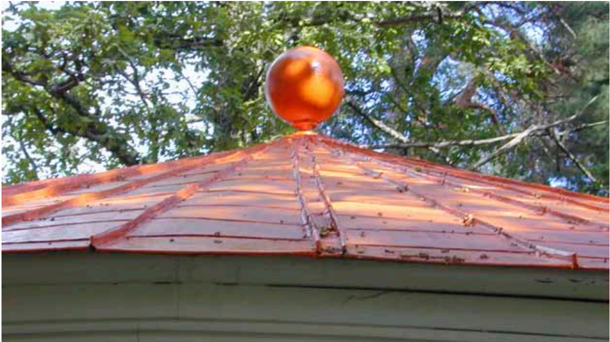
Figur 30. Hela taket mönjades innan täckstrykning skedde med svart linoljefärg.
