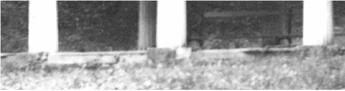
Figur 36. Utsnitt från fig. 1. Det äldre golvet låg lägre än det nuvarande vilket som bilden visar innebär att ovan- delen på fundamenten till kolonnerna tidigare var frilagda. Detta foto liksom bevarad grundläggning till bjälklaget för golvet gör att den tidigare golvnivån liksom golvbrädernas ungefärliga tjocklek kan fastställas (se även fig 7 och 8, sid. 9). Ännu har dock ej foton påträffats som visar hur golvet var lagt. (utsnitt av foto, fig. 1 på sid. 5).
