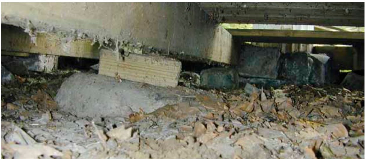
Figur 8. Bjälklaget till golvet är grundlagt på naturstenar vilka sannolikt utgjort upplag även för det äldre och kanske ursprungliga bjälklaget som fanns före det att golvet förhöjdes och förnyades vid 1900-talets mitt.
