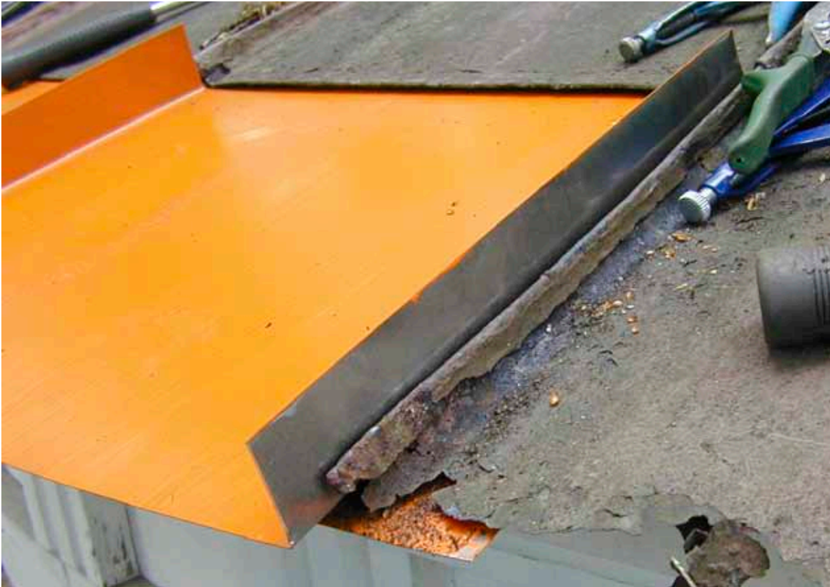
Figur 28. Plåten lagas genom insticksskiva och nytt språngbleck där den gamla skivan bevaras under den nya medan det gamla språngblecket däremot klipps ner.
