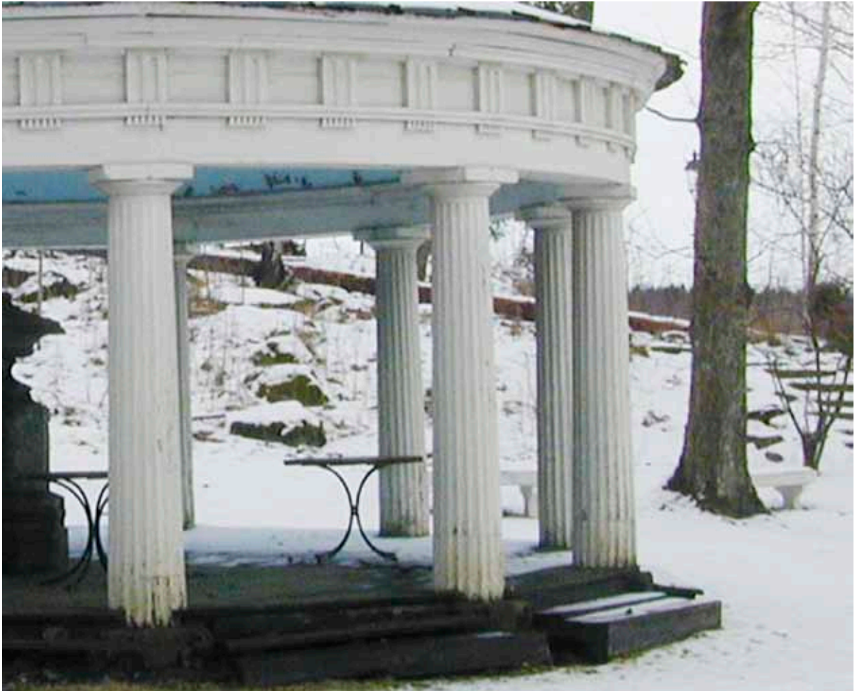
Figur 11. Templet är försett med tolv kolonner vilka har tillverkats ur vardera ett rundtimmer.
