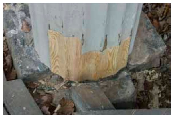
Figur 27. Björkkvists färdiga lagning.
