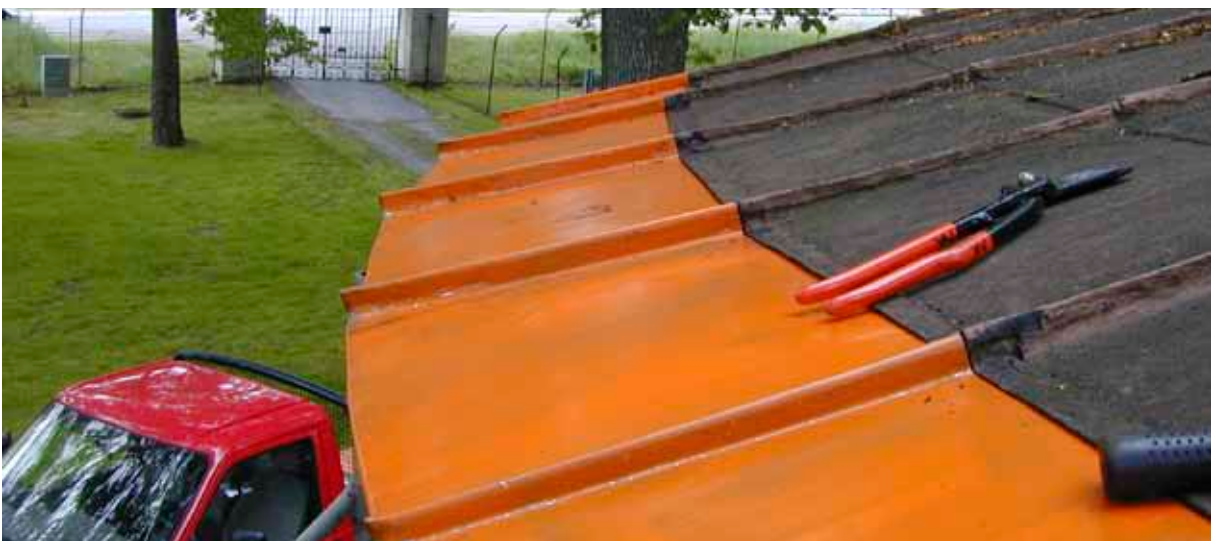
Figur 29. Samtliga skivor i anslutning till takfot täcktes med nya skivor.
