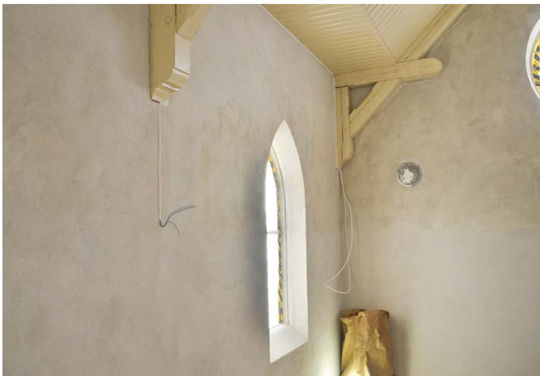
Bild 10. Pågående renovering av slätputs på innerväggar, målning av innertak och nya kabeldragningar. SLM D2021-0436.
