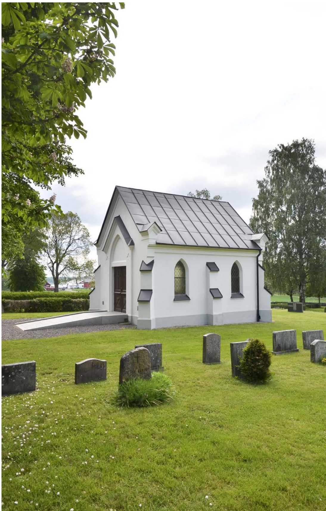
Bild 20. Gravkapellet efter avslutad renovering. SLM D2021-0427.
