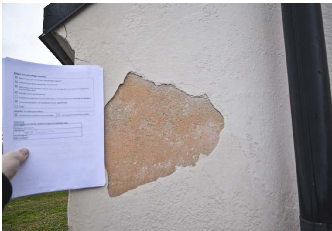
Bild 17. Undre färgskikt på en av strävpelarna. SLM D2021-0504.
