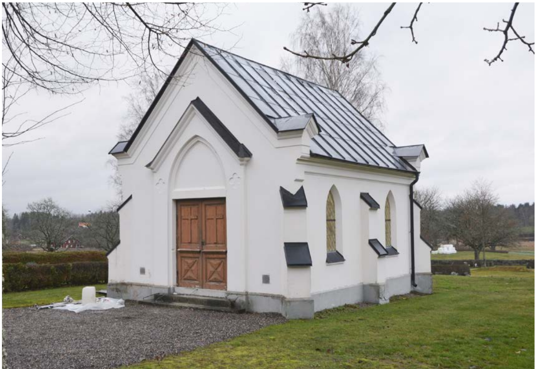
Bild 5. Gravkapellet innan påbörjad renovering. SLM D2021-0431.
