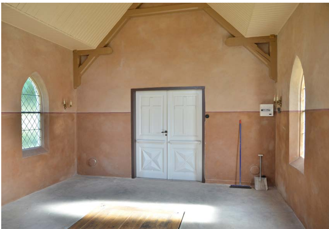
Bild 3. Interiör, vy mot norr. Bilden är tagen efter avslutad renovering SLM D2021-0430.
