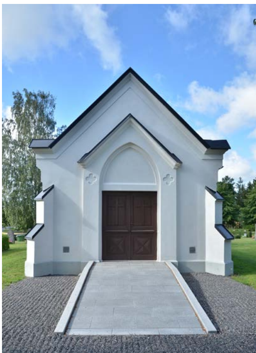
Bild 16. Den nya tillgänglighetsrampen av granit. SLM D2021-0445.
