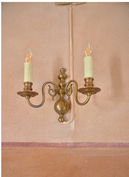
Bild 16. De gamla väggarmaturerna reparerades och återanvändes. SLM D2021-0444.
