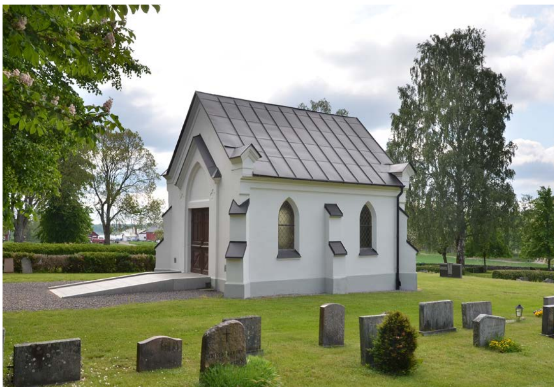
Bild 1. Gravkapellets nordvästra fasader. Bilden är tagen efter avslutad renovering. SLM D2021-0428.
