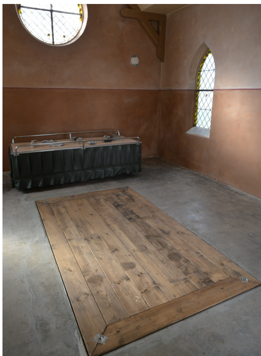
Bild 15. Golvet behandlades med vattenglas. En ny trälucka till kistgraven i golvet tillverkades. SLM D2021-0442.
