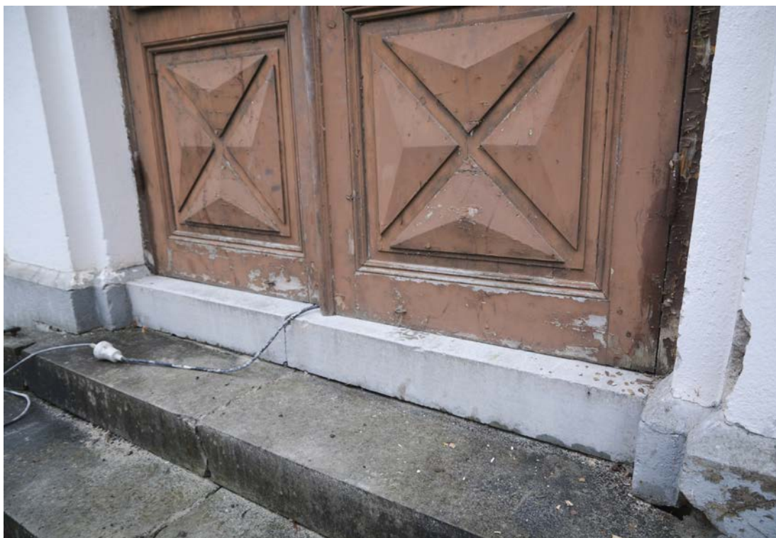
Bild 6. Entrédörrarna innan renovering. SLM D2021-0432.
