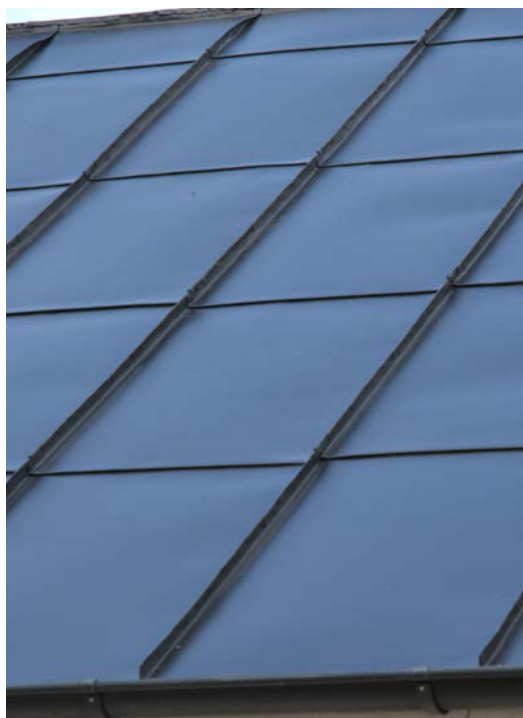
Bild 14. Plåttaket efter avslutad renovering. SLM D2021-0440.
