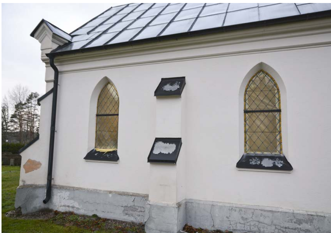
Bild 7. Östra fasaden innan påbörjad renovering. SLM D2021-0433.
