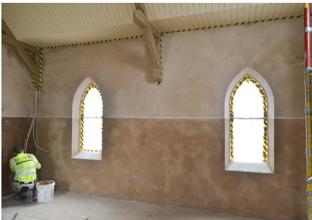
Bild 14. Pågående avfärgning av innerväggarna. SLM D2021-0441.
