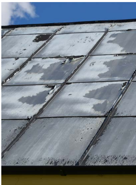
Bild 13. Plåttaket innan renovering. SLM D2021-0439.
