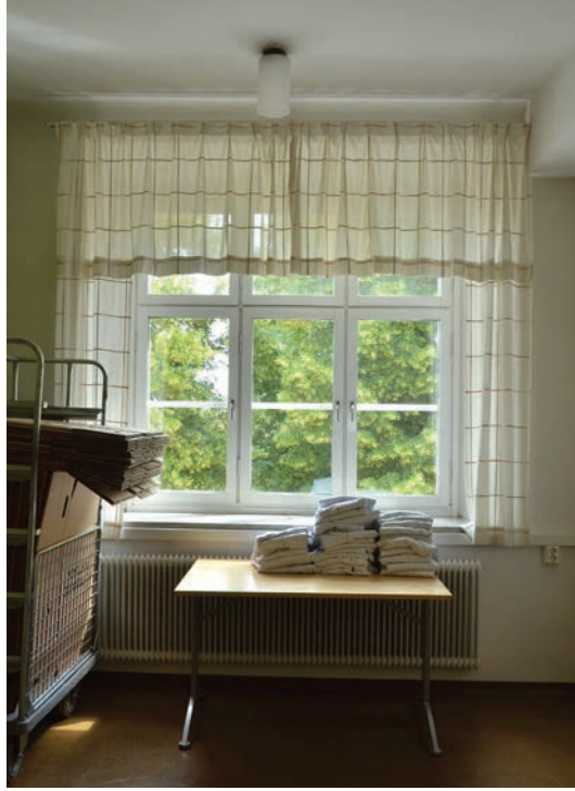
Sexluftsönster med ett äldre sektion radiatorer under. Äldre byggnadsdetaljer som är bevarade är radiatorerna. (SLM D2018-0829)
