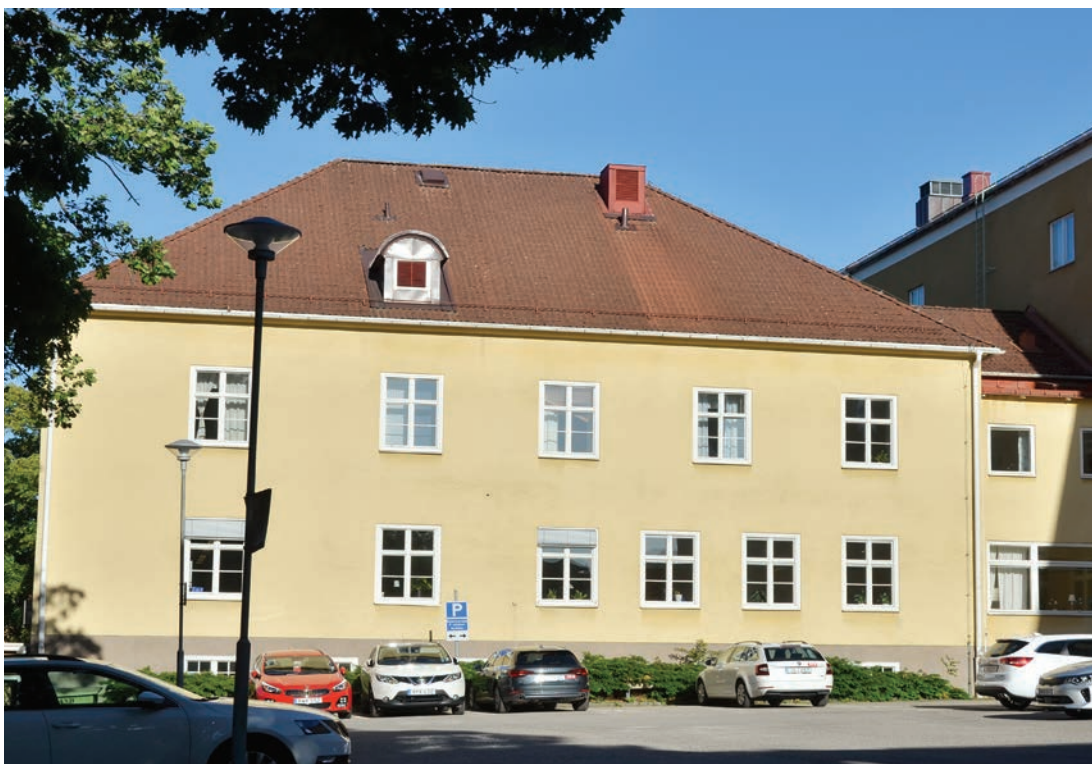
Byggnad K7, fasad åt väster med fyrluftsfönster. Exteriör och fönstersättning är välbevarad. (SLM D2018-0818)
