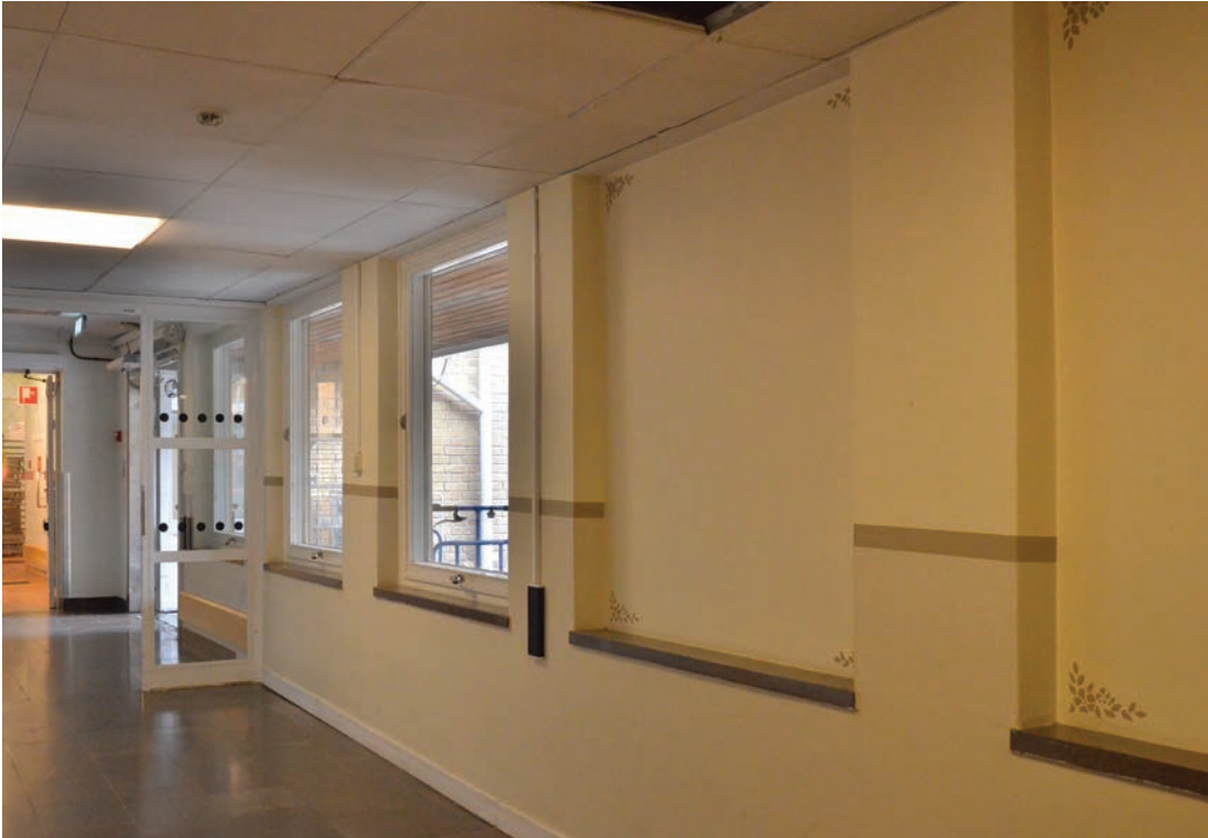
Interiörbild av gången mellan K7 och K10 sedd mot öster. Flera fönster är igensatta i samband med att ett garage byggdes intill varuintaget. (SLM D2018-0832)
