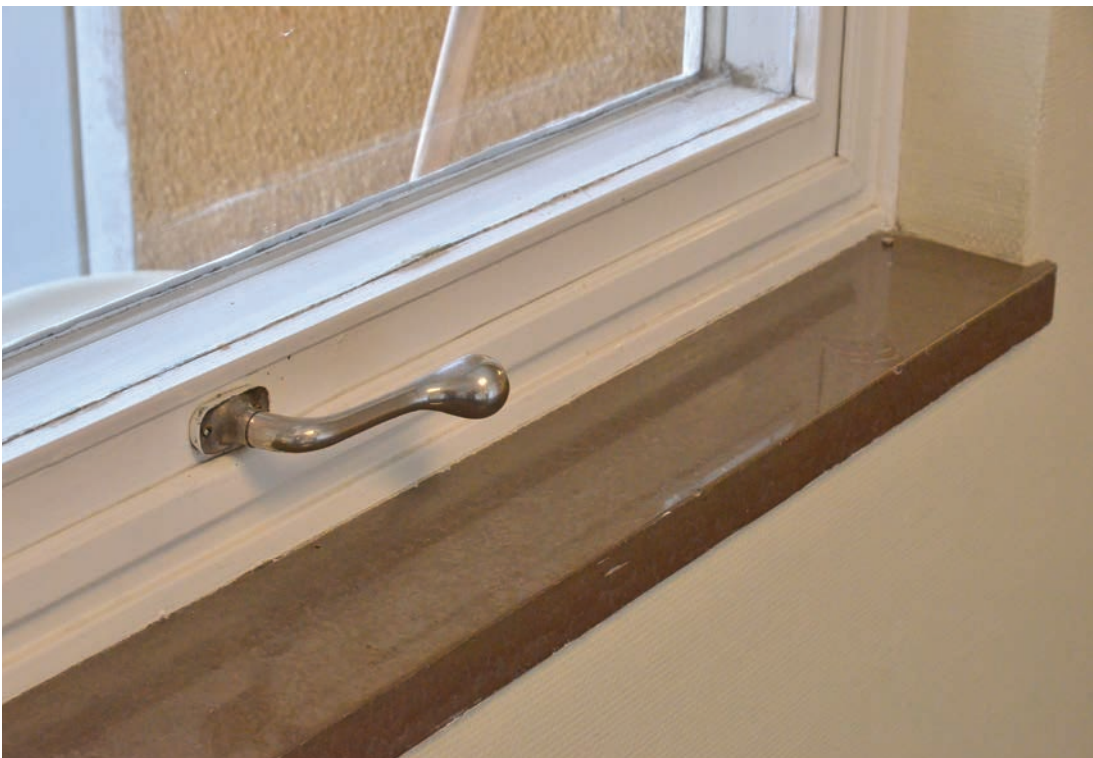
Detalj av ett av pivåfönstren i gången mellan K7 och K10 med greppvänligt och tidstypiskt handtag. (SLM D2018-0833)
