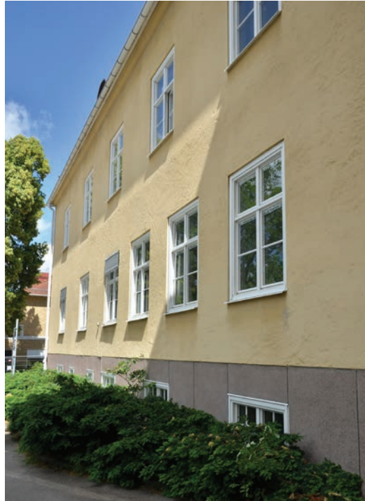
Den västra fasaden med källarfönster och fyrluftsfönster. (SLM D2018-0820)
