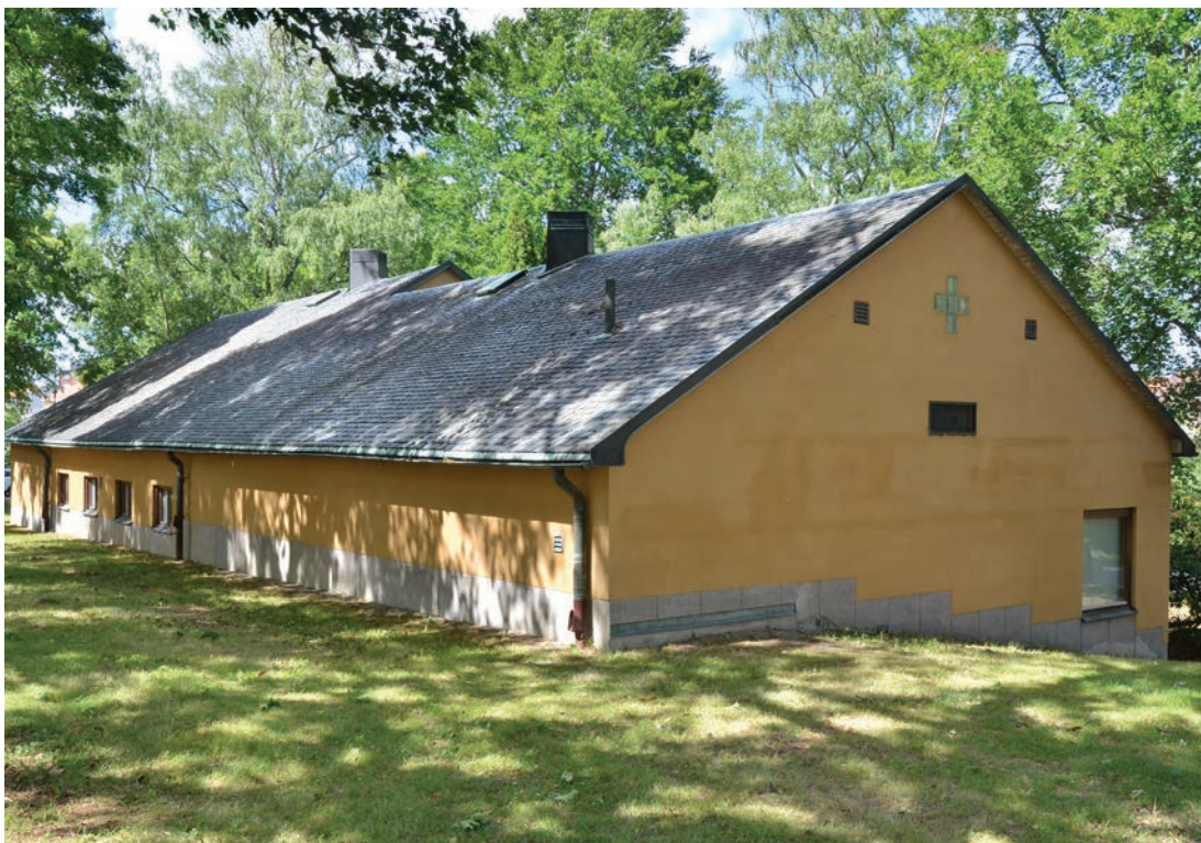
Det tidigare kapellet och obduktionssalen på Kullbergska sjukhuset benämnd som byggnad K12. Notera skiffertaket och byggnadsdetaljer i koppar som exempelvis hängrännorna. (SLM D2018-0834)
