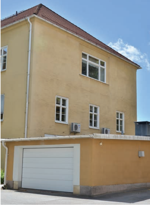
Norra gaveln med det övre fönstret ger bra ljusinsläpp till den tidigare operationssalen på plan 1. (SLM D2018-0819)
