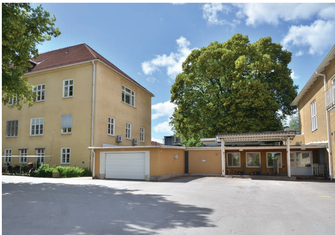
Gången och garaget mellan K7 och K10 som ska rivas. Till vänster flygeln K7. Till höger K 10:s östra fasad med ett garage och ett varuintag. (SLMD2018-0831)
