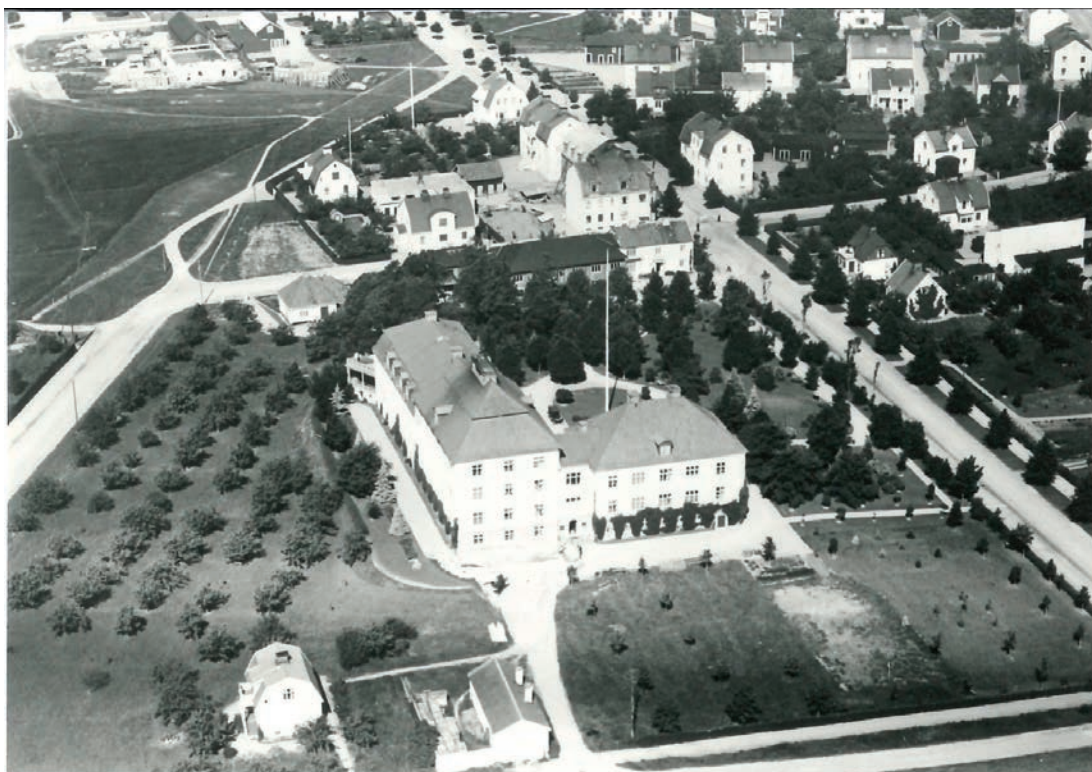
Flygbild över Kullbergska sjukhuset år 1927 från öster. Till vänster den påbyggda första sjukhusbyggnaden från 1916. Tillbyggnad K7 till höger i bild. Notera den lummiga sjukhusparken. Bild från Sörmlands Landstingsarkiv.
