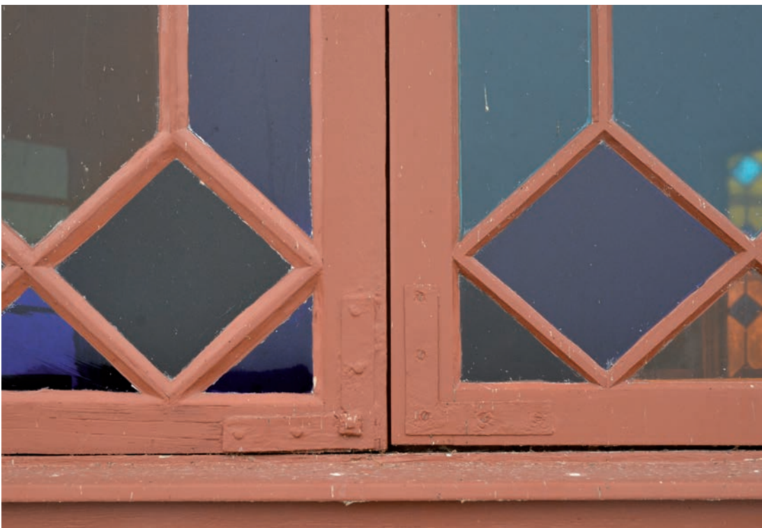
Två fönsterbågar efter målning och återmontering 2016-11-11. Här syns skillnad både i måleriarbete och kittning, där den vänstra har relativt tjocka färglager. Detta kan delvis förklaras av skillnad i renoveringshistorik och olika bredd på kittfalsen. Foto: David Hansson (SLM D2018-0645)
