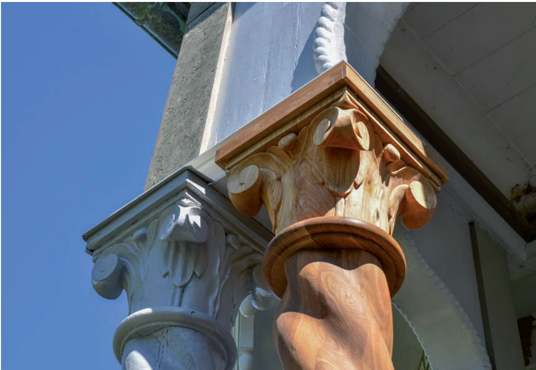
Den högra kolonnen är nytillverkad i Ungern med det äldre som förlaga. Detaljarbetet håller mycket hög konstnärlig och hantverksmässig kvalitet, och det är svårt att finna några avvikelser från de äldre kolonnerna. De nya kolonnerna tillverkades av ek. Foto: Emelie Mattsson (SLM D2018-0639)
