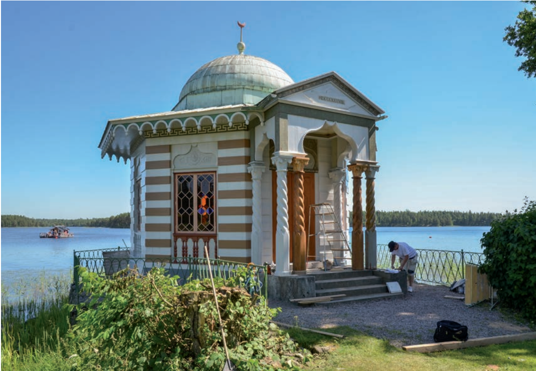
Turkiska paviljongen under målningsarbeten 2015-07-02. De nya kolonnerna har satts på plats, men är ännu inte målade. De tegelrusticerade väggfälten är här målade. Foto: Emelie Mattsson (SLM D2018-0638)
