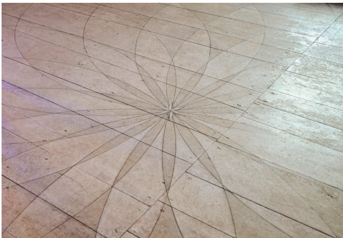
Golvet efter slutförd restaurering, vilken bestod av rengöring följt av att linjer och starkt slitna partier fylldes i på nytt. Foto: Emelie Mattsson (SLM D2018-0635)
