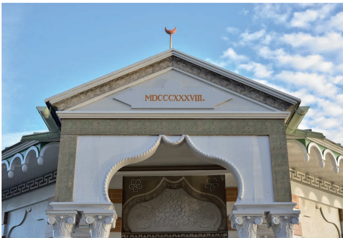
Entréns portik efter slutfört målningsarbete 2015-10-27. Det kakelimiterande partierna och taklisten med grönt arabeskmöster konserverades. Meanderfrisen under takfoten tvättades och övriga ytor målades om. Jämför nischens målade yta med föregående bild vilken här är nymålade på plywood. Foto: David Hansson (SLM D2018-0643)
