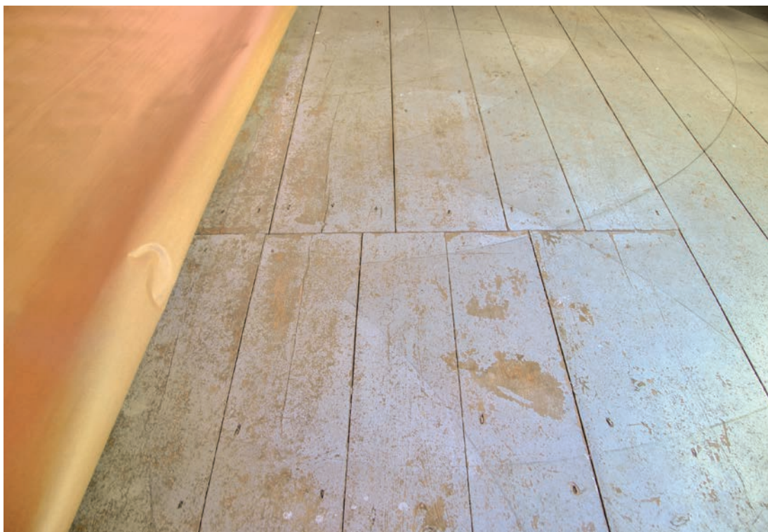
Golvet före åtgärd. Ytan var mycket sliten och det målade mönstret svårt att avläsa, framförallt i golvets mitt. Foto: Emelie Mattsson (SLM D2018-0634)
