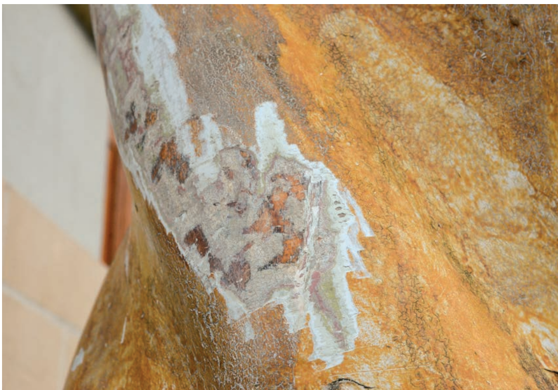
Bild från färgundersökningen 2015-04-25 på ett av kolonnskaften där man tydligt kan urskilja flera färglager. Av de undre lagren att döma är det sannolikt att kolonnerna ursprungligen varit målade i olika nyanser av grått. Foto: Emelie Mattsson (SLM D2018-0640)
