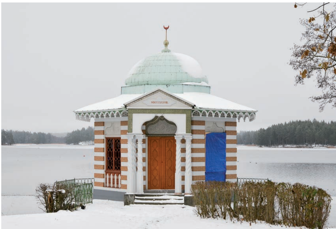
Turkiska paviljongen vid besiktningen av fönstren 2016-11-11. Här framträder den nya färgsättningen i sin helhet. Alla fönster dock har ännu inte levererats. Foto: David Hansson (SLM D2018-0646)
