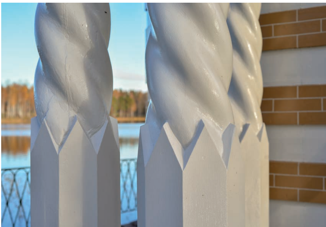
Spiralkolonnerna efter slutfört målningsarbete 2015-10-27. Kolonnen närmast i bild är en av de nytillverkade. Foto: David Hansson (SLM D2018-0641)
