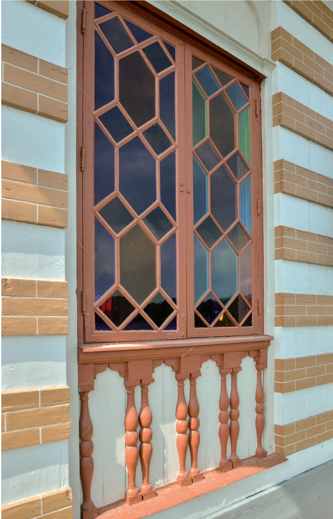
Ett av fönstren 2016-06-15 efter avslutat arbete och med ny färgsättning. Foto: David Hansson (SLM D2018-0647)
