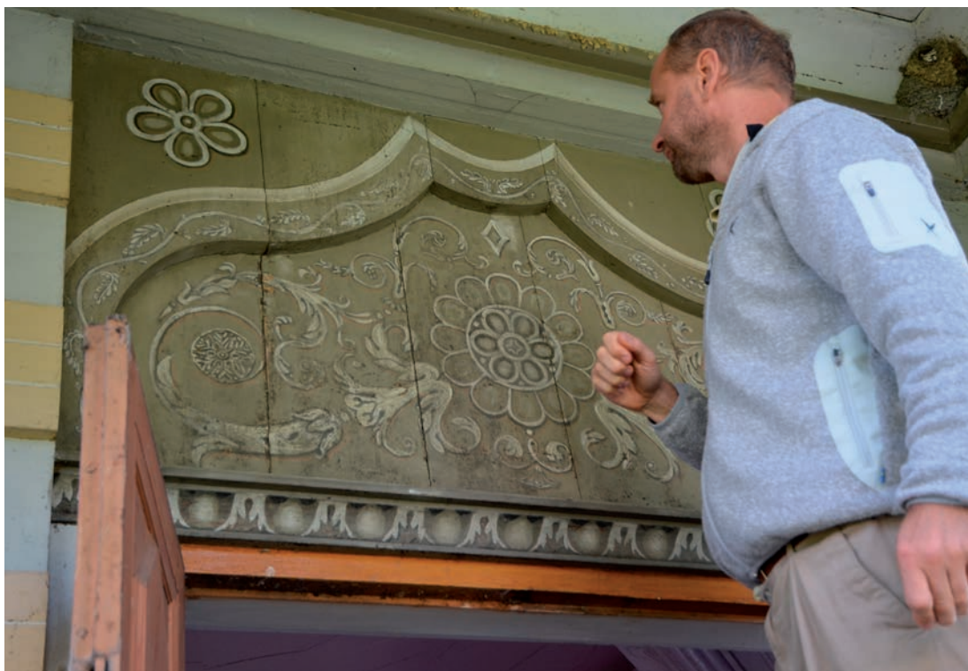
Konservatorn Gabor Pasztor inspekterar grisaillemåleriet i nischen över entrédörren. Måleriet, som var i dåligt skick med krackelerade färglager, beslutades efter överläggningar att sättas över med plywoodskivor som nymålats med samma mönster. Färgerna har genom åldrande och olika typer av konservering mörknat betydligt. Foto: Emelie Mattsson (SLM D2018-0642)
