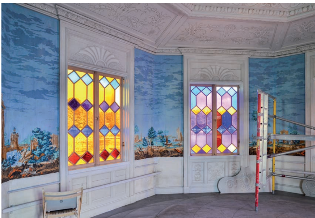
Paviljongens interiör efter slutförd restaurering. Tapeterna har rengjorts, lagats och upphängningen bättrats på. Snickeriernas dekorationsmåleri rengjordes och flagande färgskikt limmades fast. Foto: Emelie Mattsson (SLM D2018-0633)
