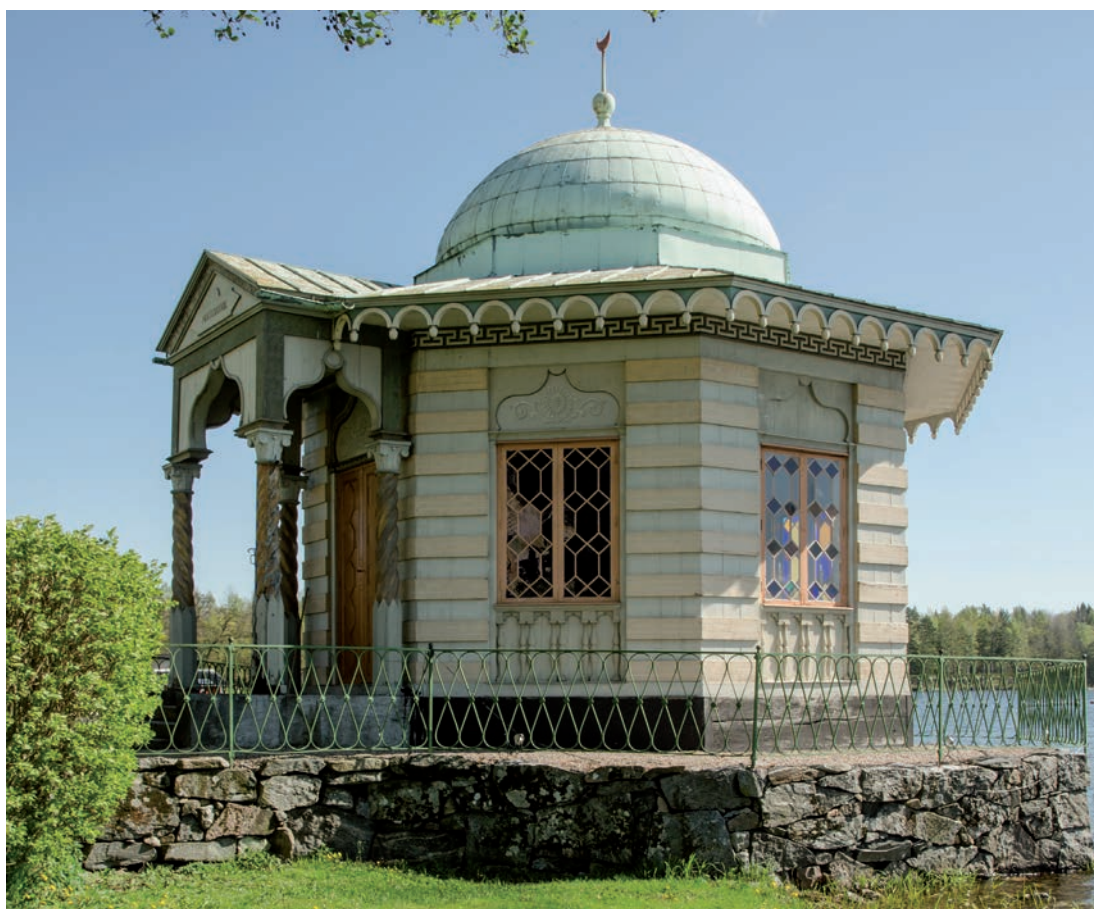
Turkiska paviljongen sedd från väster före utvändig restaurering 2015-05-06. Lusthuset har fortfarande kvar sin tidigare färgsättning och spiralkolonnerna är ännu inte åtgärdade. Två av de främre har dock monterats ned. Foto: David Hansson (SLM D2018-0628)
