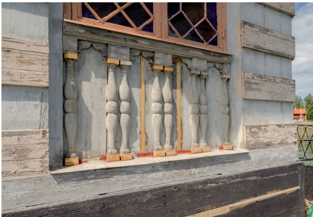
Trälagningar har här utförts i första hand på balusterdockornas klossar, men också vid mindre sprickbildningar på släta partier och i sockeln. Foto: Emelie Mattsson (SLM D2018-0636)
