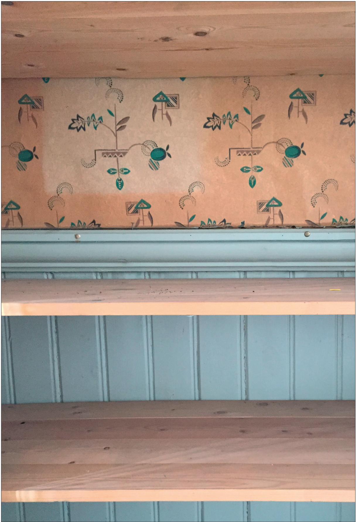
81. Detalj av väggfast skåp i skolsalen med bröstpanelens avslutande profilerade list (Slm D2016-0081).
