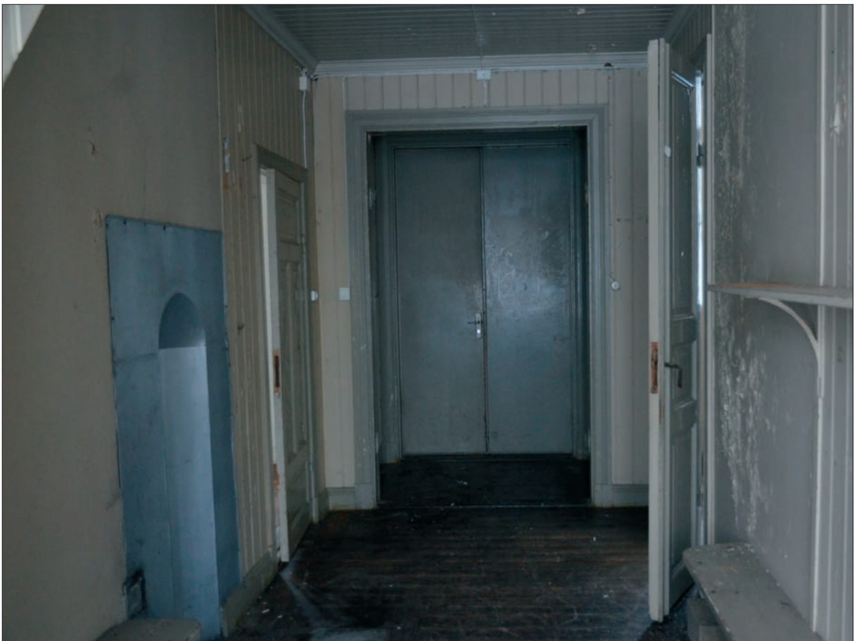
73. Kapprummet hade ursprungligen kamin. Till vänster spegeldörr in till lärarbostaden. Till höger pardörr till skolsalen (Slm D2016-0073).
