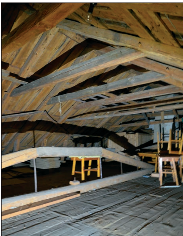
52. Vinden försedd med spännbalk Slm D2016-0053).
