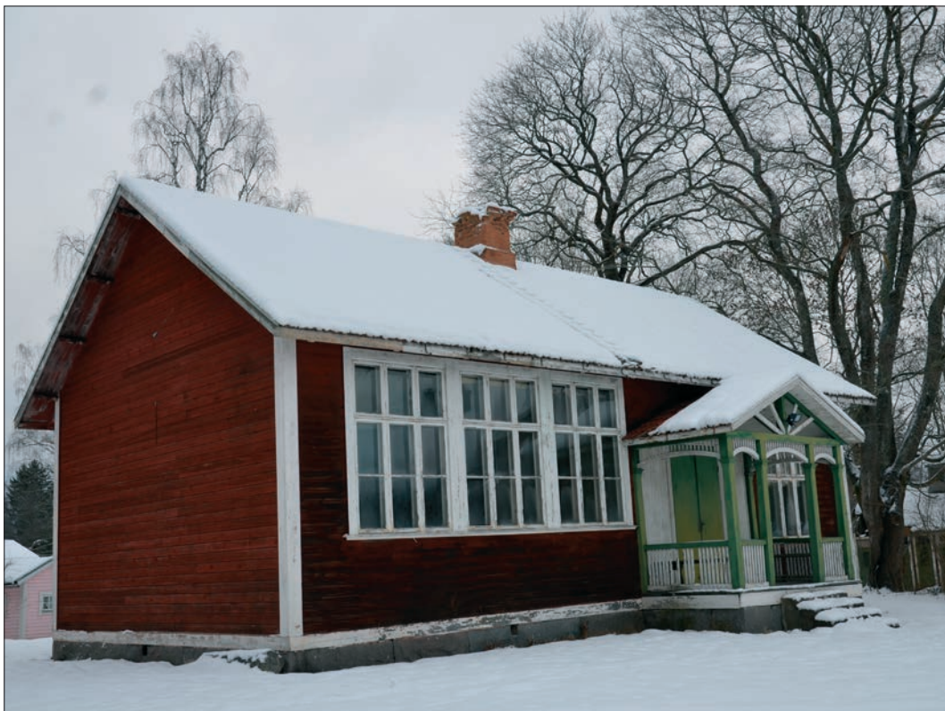
66. Småskolan från 1906, har höga stora fönster för maximalt ljusinsläpp till skolsalen (Slm D2016-0066).
