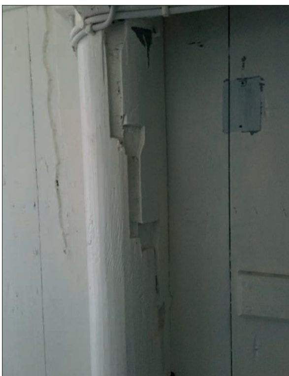
26. Detalj av urtagen i förrådet för de numera borttagna trappstegen. Stolpen är handbilad (Slm D2016-0029).
