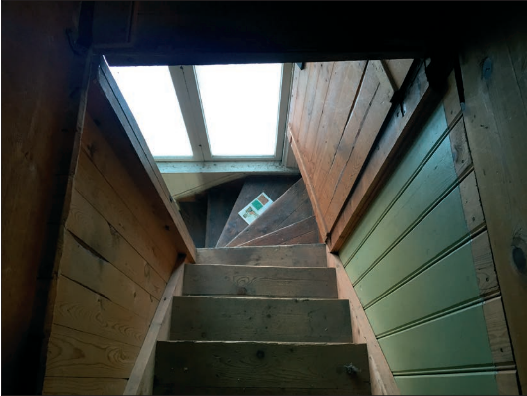
88. Vindstrappan fotograferad från vinden och sedd ned till kapprummet. Pärlspontpanelen har kvar sin ursprungliga färgsättning (Slm D2016-0088).
