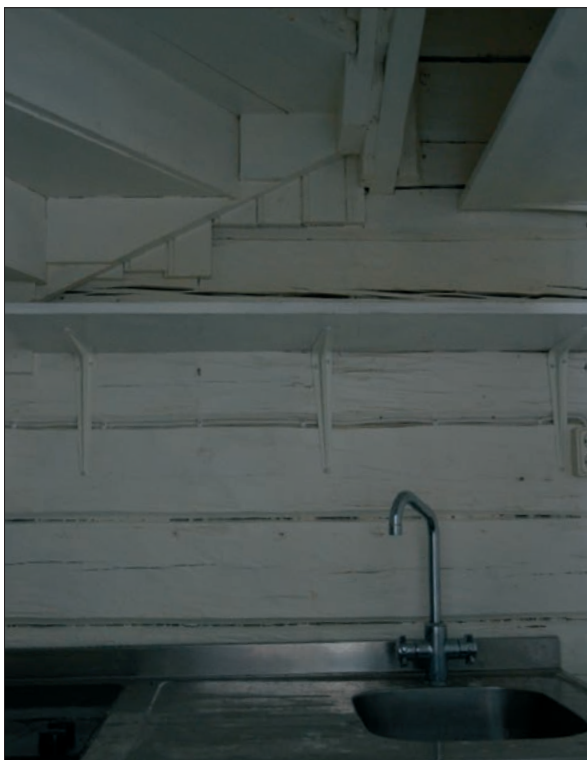
25. Synlig timmervägg i förrådet, vid nordöstra gaveln (Slm D2016-0028).
