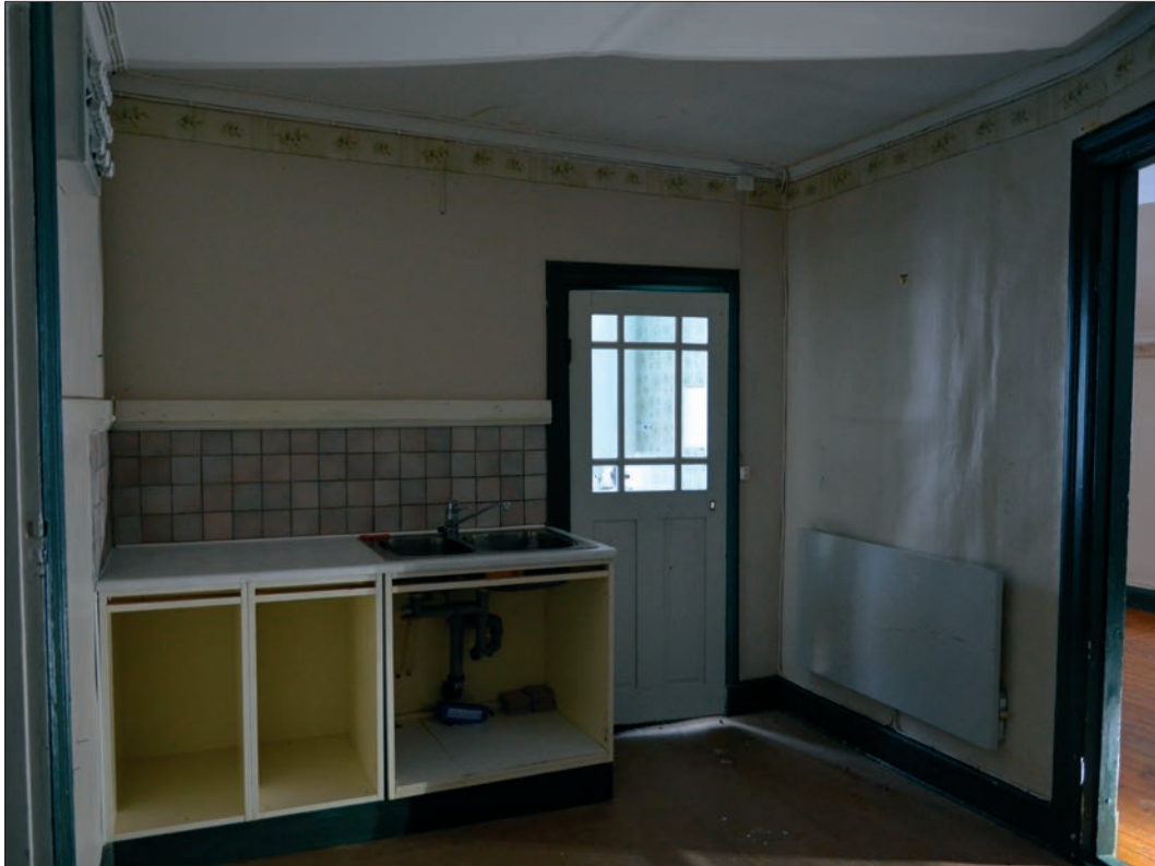
63. Köket på övervåningen. Bänk med diskho tillkommen troligen på 1990-talet. Innanför den glasade dörren finns inrett badrum med badkar, toalett och varmvattenberedare (Slm D2016-0063).
