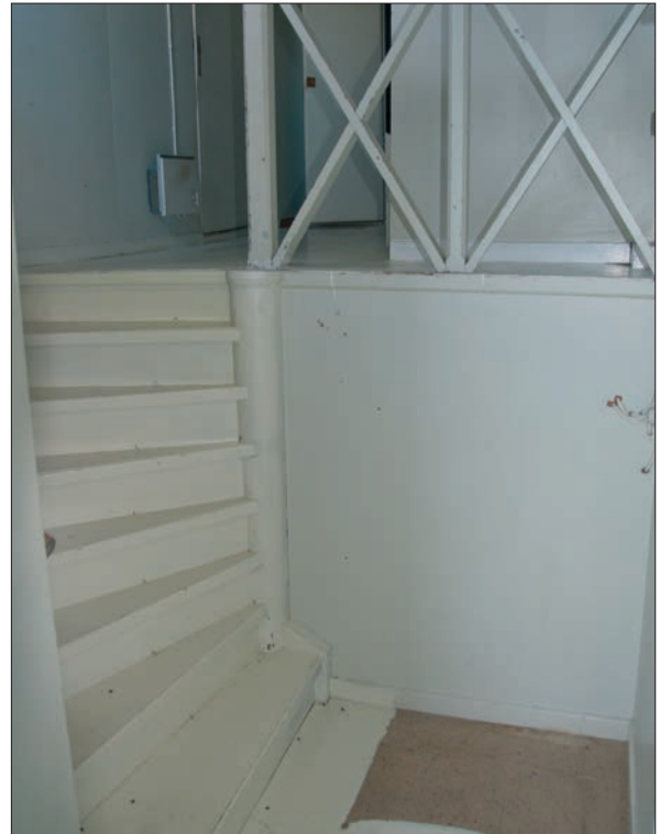
59. Övre delen av trappan upp till vinden på norra gaveln är ursprunglig (Slm D2016-0060).
