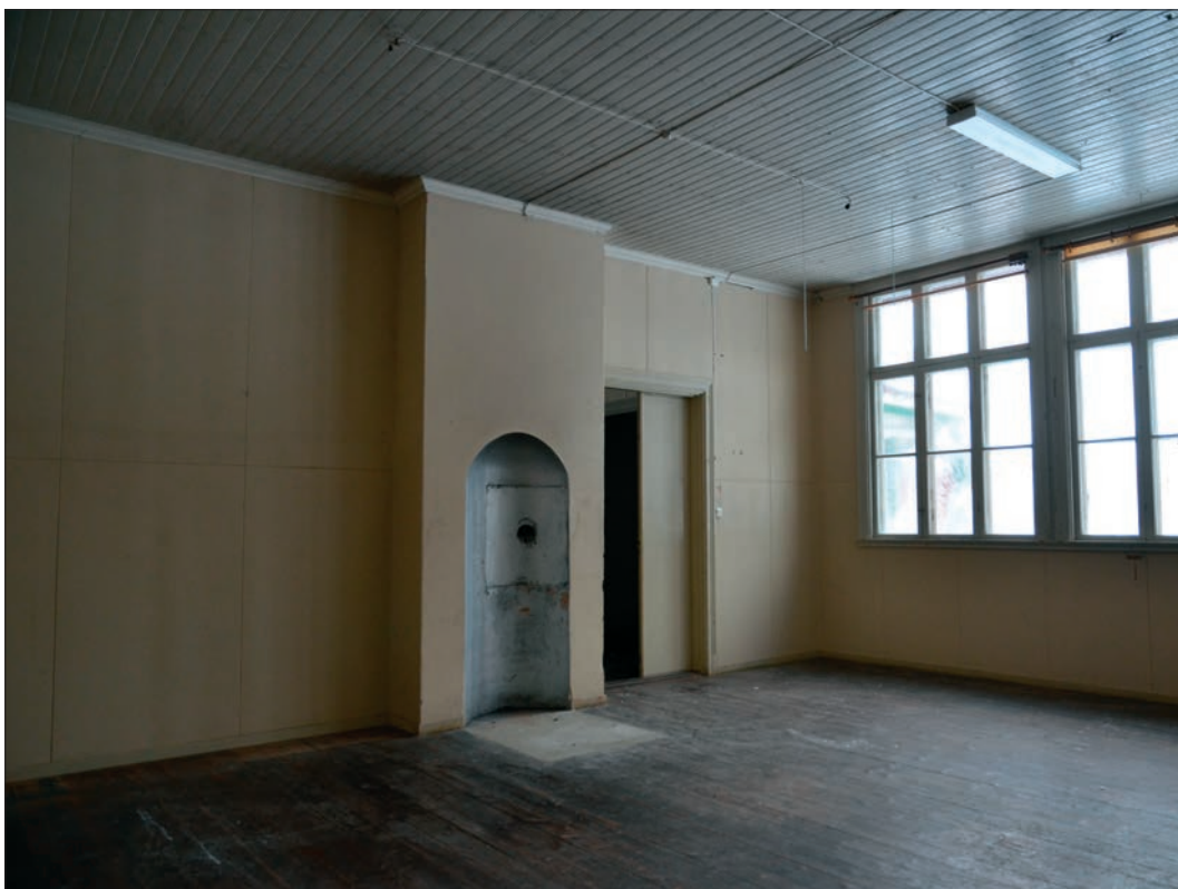
77. Nischen berättar var kaminen ursprungligen varit placerad. Pardörren leder till kapprummet. Skolsalen bevarar ursprungligt plankgolv och pärlspontklätt tak (Slm D2016-0077).
