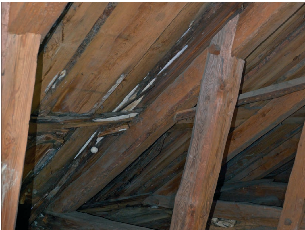
56. Detalj av handbilade takstolar som är sammanfogade med dymplingar, vilket är ålderdomligt. (Slm D2016-0057).
