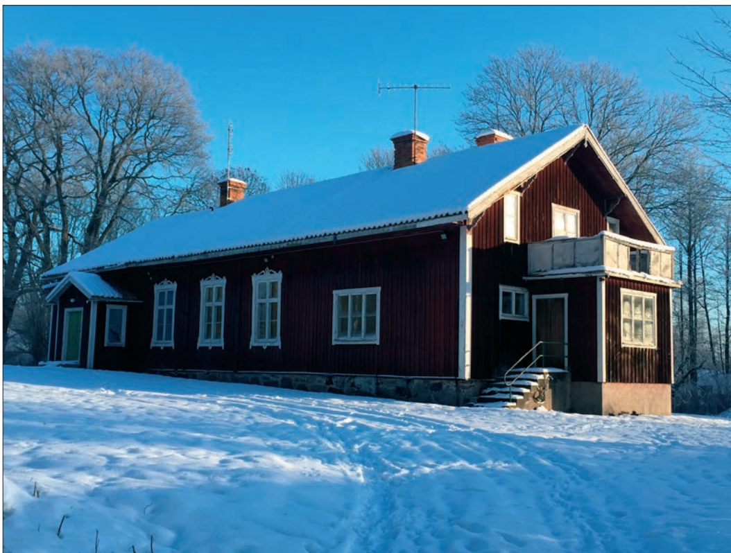
11. Stora skolan sedd från infarten, sydvästra gaveln byggdes till med entréfarstu och ovanpåliggande balkong på 1940-talet (Slm D2016-0014).
