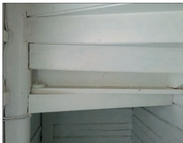
28. Ursprunglig trappa, till övervåningens vaktmästarbostad, delvis bevarad men ombyggd (Slm D2016-0031).
