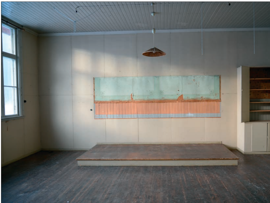
76. Skolsalen bevarar lärarens podium. Bakom skivtäckning finns den ursprungliga bröstpanelen bevarad (Slm D2016-0076).
