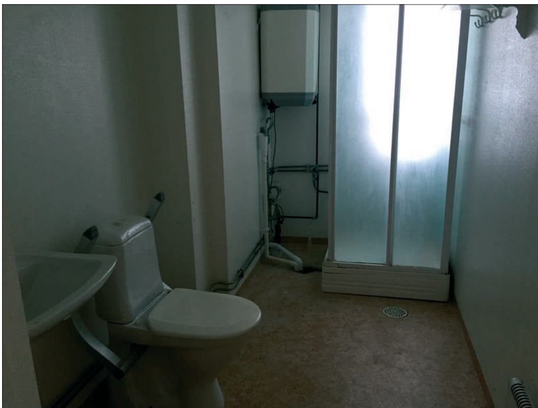
34. Badrummet byggdes 1998. Rummet har tagit del av kapprum och innanföriggande rum i anspråk (Slm D2016-0037).
