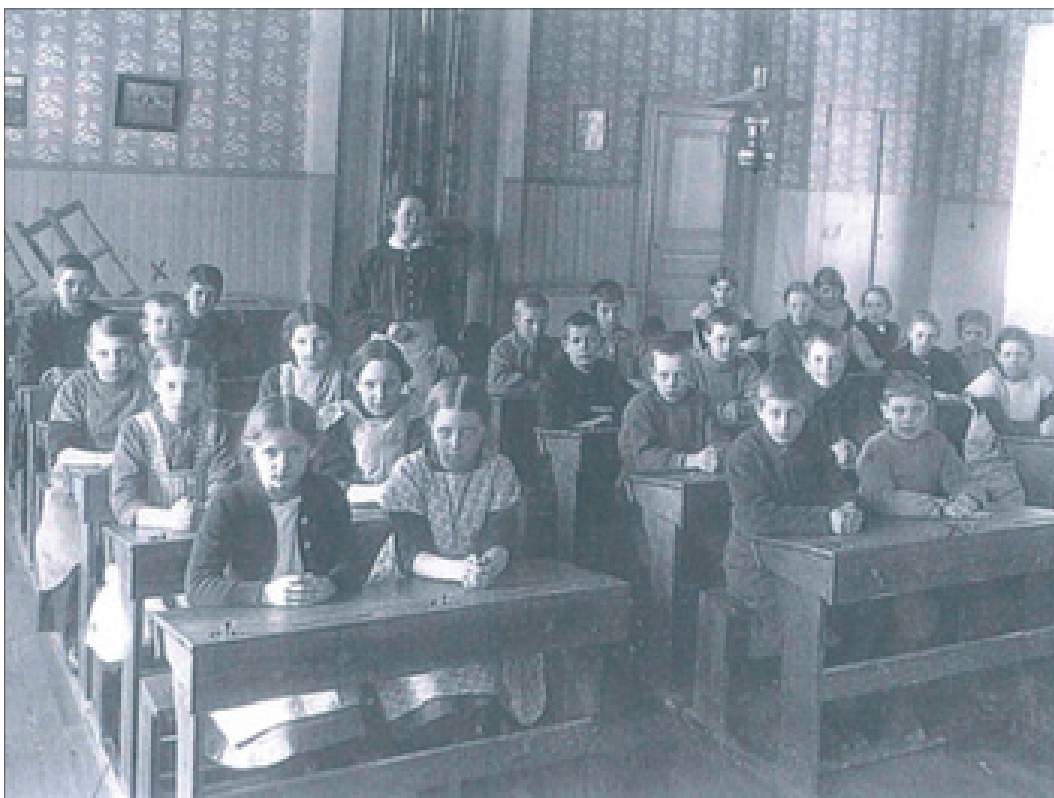
36. Djulö skolsal i början av 1900-talet med lärarinnan Gerda Forsberg. Väggarna var ursprungligen klädda med bröstpanel. Bakom lärarinnan syns kaminen som nu är borta. Dörren ledde in till lärarbostaden. Fotografi lånat av Katrineholm-Stora Malms hembygdsförening.
