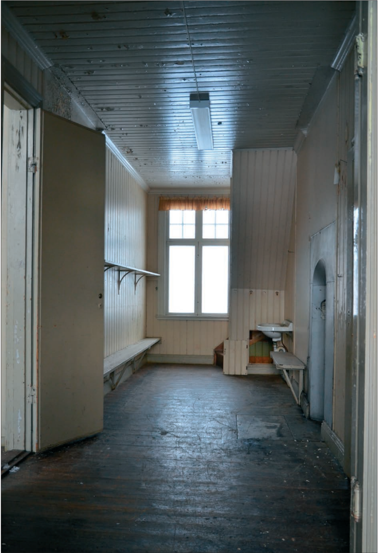
75. Kaprummet sett från entréfarstun. Rummet bevarar väggfasta bänkar, pärlspontpanel och plankgolv (Slm D2016-0075).
