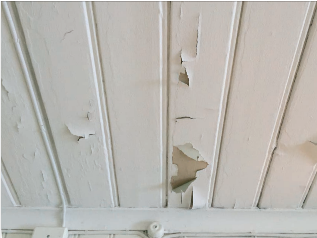
24. Detalj av pärlsponttak och taklist i kapprum/hallen (Slm D2016-0027).
