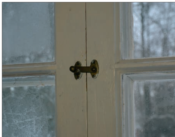
29. Detalj av fönsterhake (Slm D2016-0032).
