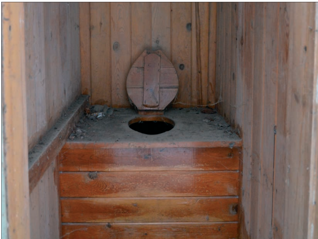
91. Ett av dassen. Väggarna är klädda med pärlspontpanel (Slm D2016-0091).
