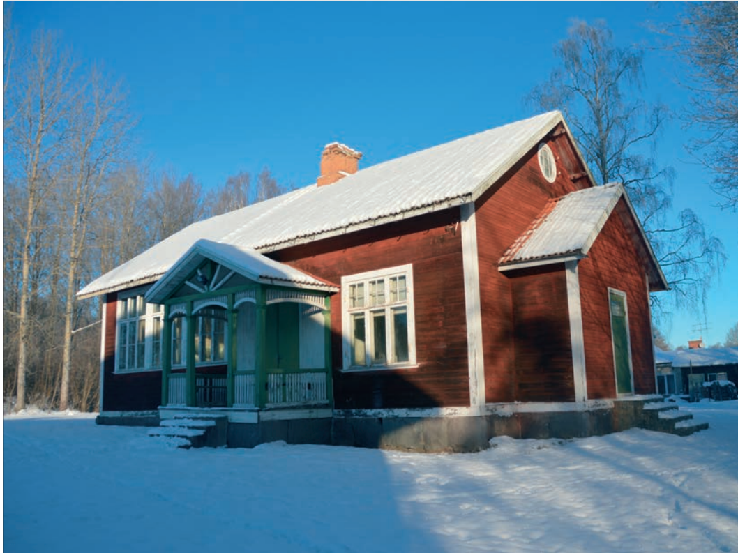
65. Småskolebyggnaden med lärarinnans entré belägen på gaveln mot sjösidan (Slm D2016-0065).
