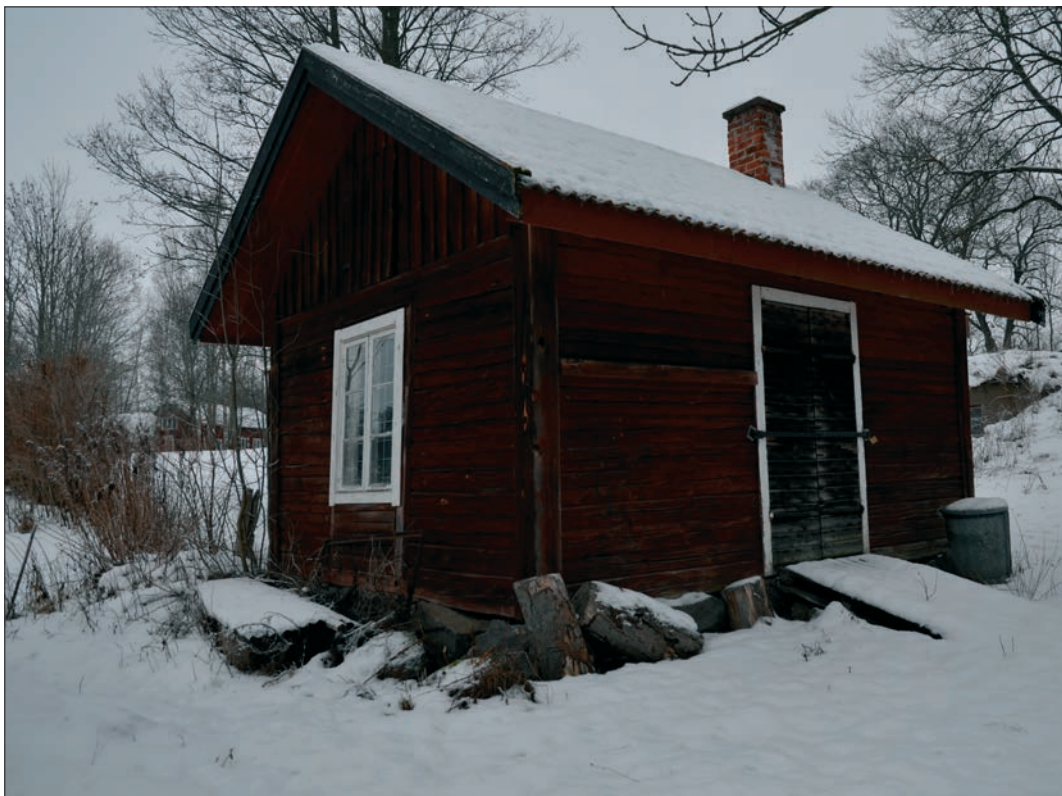
93. Tvättstugan sedd från söder. I bakgrunden syns jordkällaren (Slm D2016-0093).
