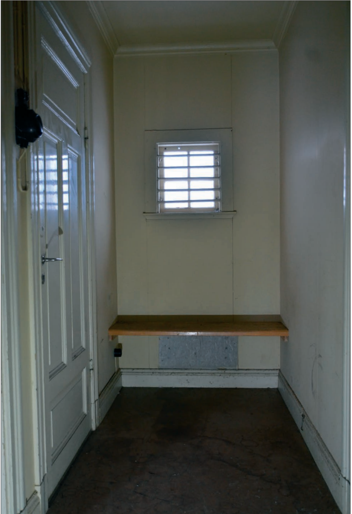
87. Lärarbostadens farstu är belägen på gaveln mot sjösidan. Ursprungligen fanns härifrån två dörrar till lärarbostaden. En dörr ledde till köket och en dörr till kombinerat sovrum/vardagsrum (Slm D2016-0087).
