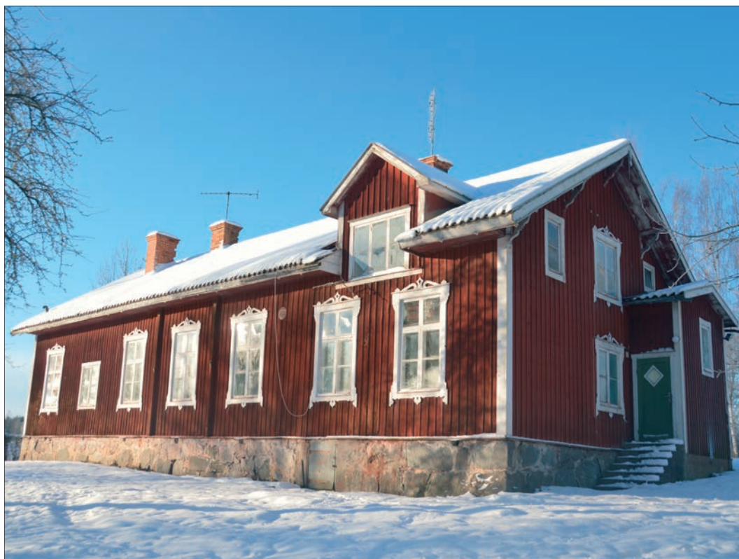
10. Östra långsidesfasaden som vetter mot sjön och som har symmetrisk fönstersättning. Endast ett fönster är utbytt till ett mindre (Slm D2016-0013).
