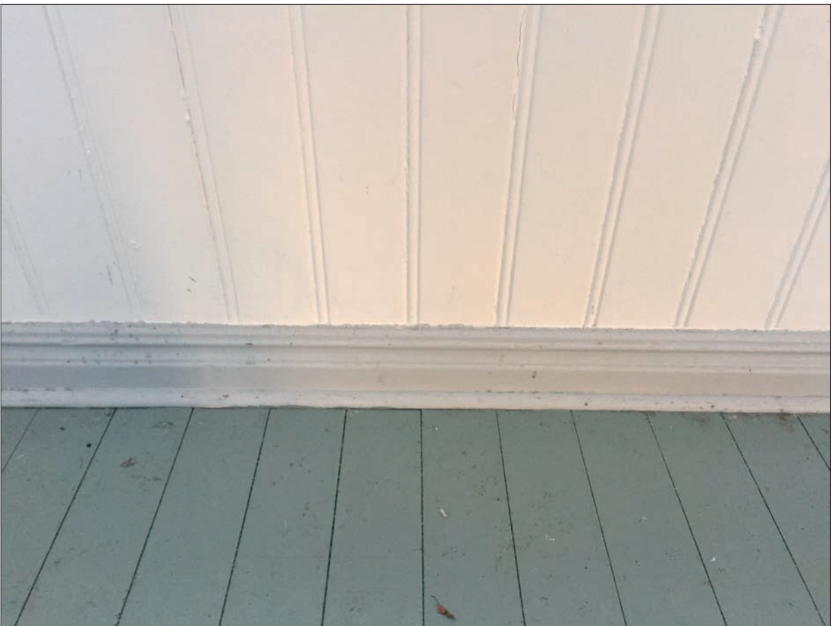
19. Detalj av farstuns plankgolv och del av vedlår, samt golvlister (Slim D2016-0022).
