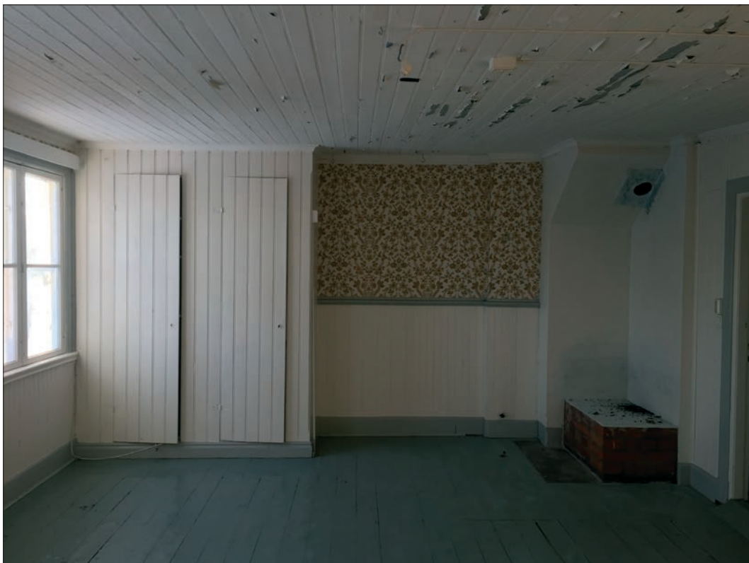
31. Platsbyggda skåp och bröstpanel. Fönstret till vänster i bild bevarar ursprunglig höjd på fasaden mot baksidan (Slm D2016-0034).
