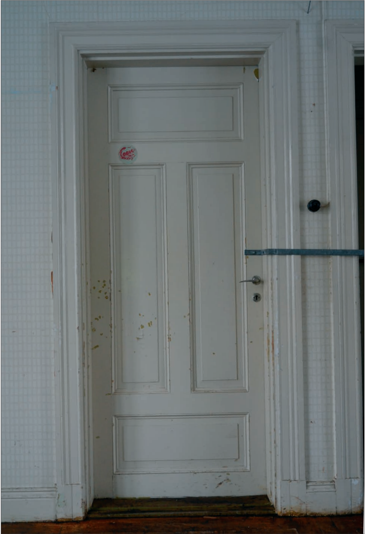
86. Ursprunglig spegeldörr från kök till farstu. Lägg även märke till dörrfoder och golvsöcket som också är ursprungliga (Slm D2016-0086).
