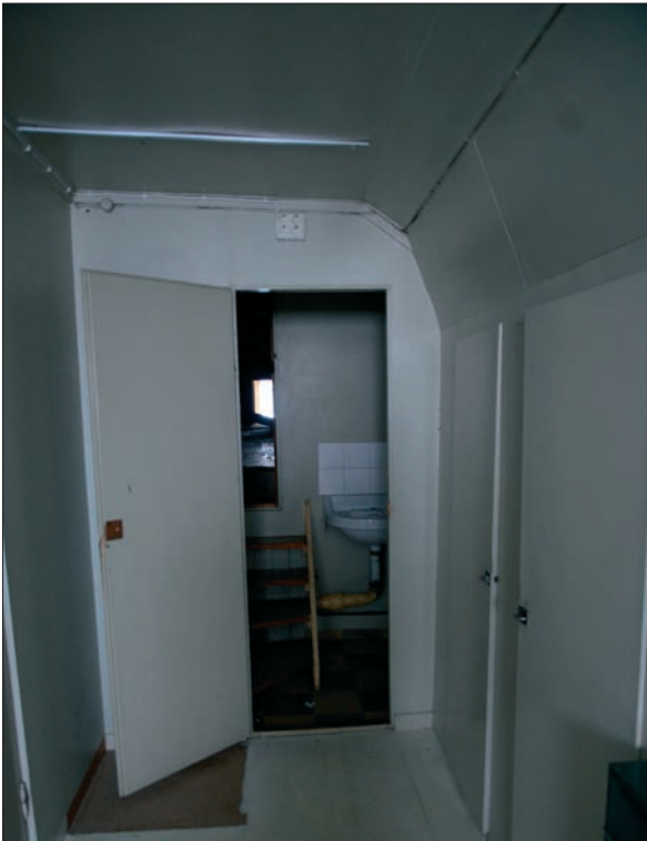
57. Vy från norra gaveln sett mot kallvinden (Slm D2016-0058).
