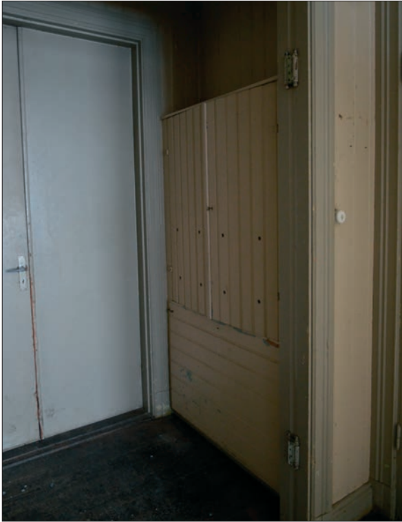
72. Farstu med platsbyggt skåp i pärlspont (Slm D2016-0072).
