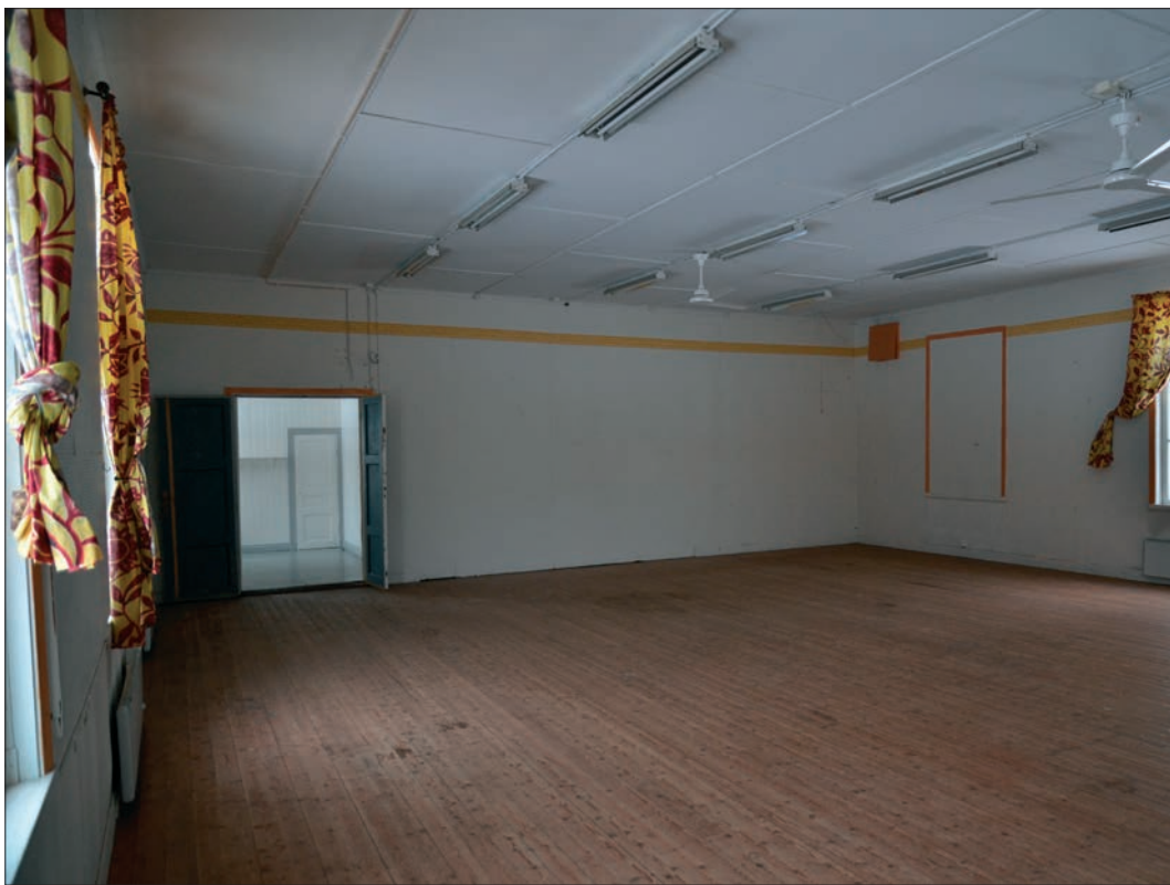
39. Stora skolsalen, i bakgrunden skymtar kapprummet/hallen. Troligtvis finns den ursprungliga bröstpanelen och pärlsponttaket bevarat under skivtäckningen (Slm D2016-0041).
