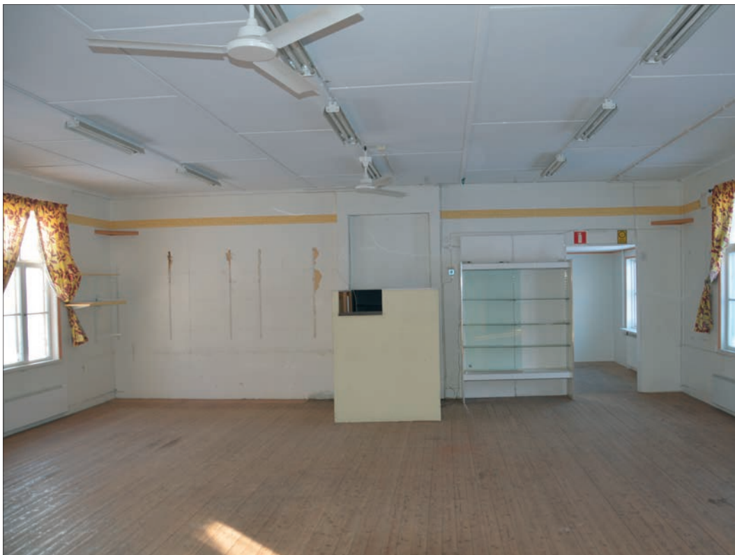
35. Stora skolsalens väggar och tak är klädda med skivmaterial. I mitten av kortsidan ses murstocken. Ursprungligen fanns en stor kamin på plats. Till höger ses öppningen in mot lärarbostaden (Slm D2016-0038).
