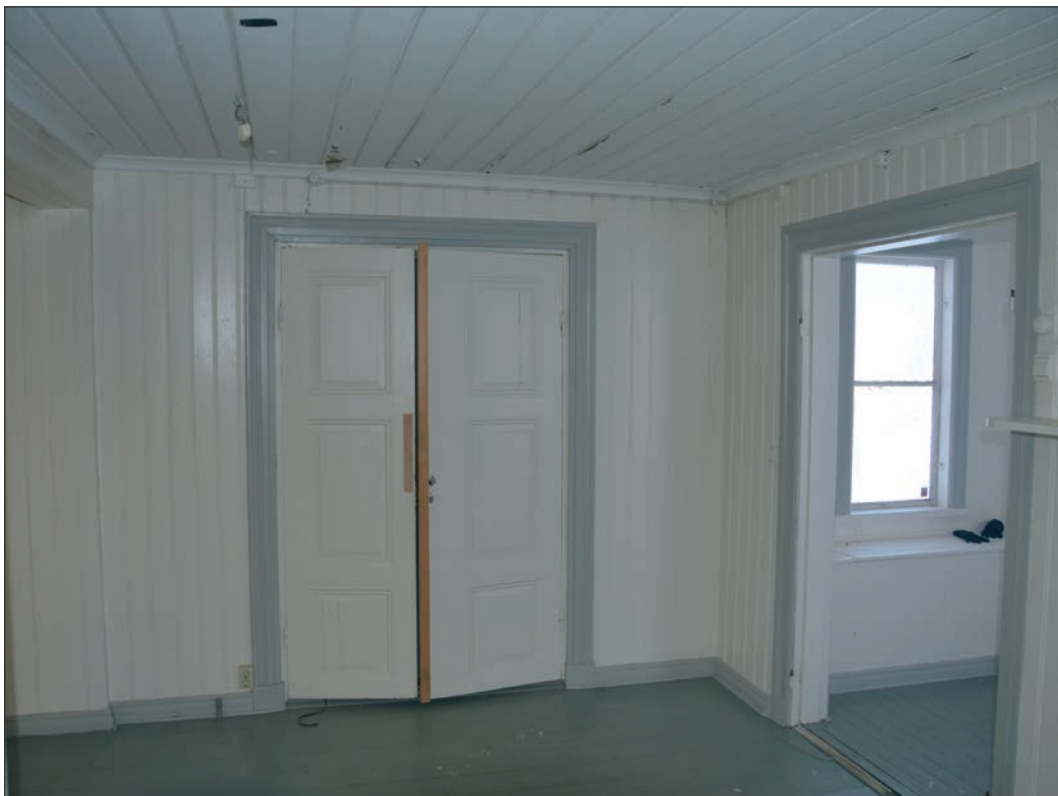
22. Pardörren som leder in till skolsalen. Till vänster skymtar farstun med vedlären (Slm D2016-0025).
