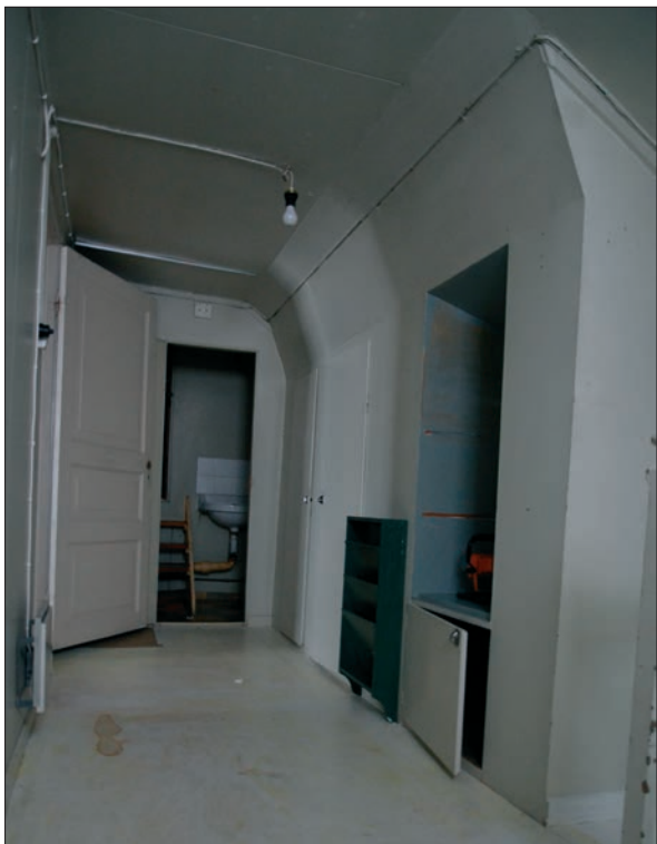
60. Bostaden vid norra gaveln. Hallen utanför köket med förvaringsskåp. Ursprunglig spegeldörr in till köket (Slm D2016-0060).
