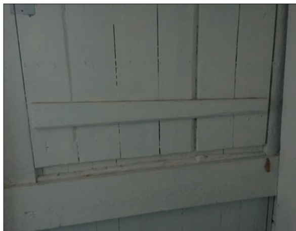
27. Igenbyggd plankdörr, synlig från förrådet i anslutning till kapprummet (Slm D2016-0030).
