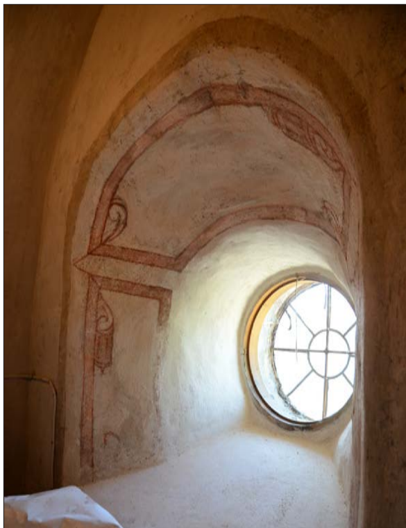
29 Det runda innanfönstret på läktaren var omålat. Det målades med grå linoljefärg. (Slm D2014-601).
