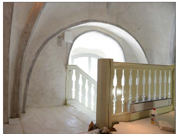
27 Balustradräcket upp till läktarvåningen efter skrapning och målning. (Slm D2014-599).
