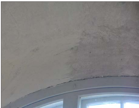
14 Fönsternischerna ljusades upp med kalkfärg. (Slm D2014-587).
