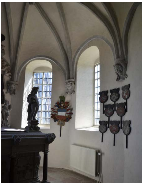
23 Gravkoret efter rengöring och målning med emulsionsfärg. Elementen är målade vita. (Slm D2014-595).
