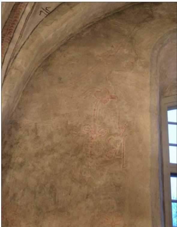
9 Långhusets norra vägg före rengöring (Slm D2014-582).
