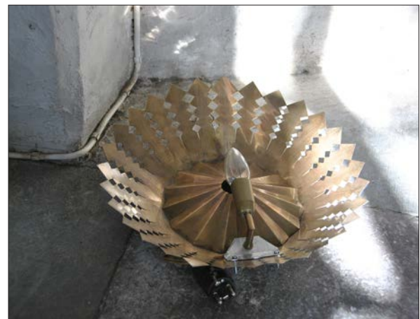
13 De äldre armaturerna i koppar. (Slm D2014-586).
