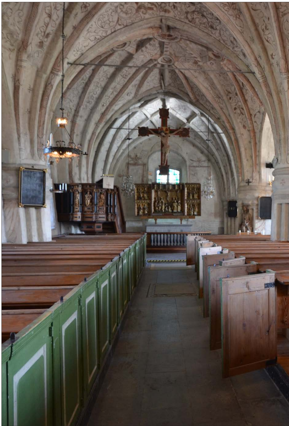
34 Kyrkorummet vid slutbesiktning efter rengöring och putsarbeten (Slm D2014-606).
