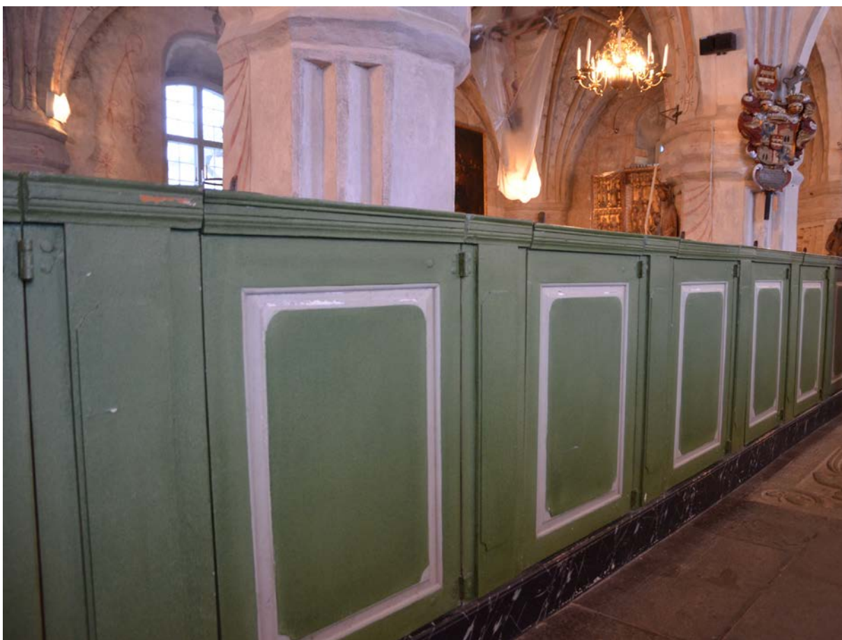
10 Bänkkvarterens dörrar före åtgärd. Krederingen har blivit synlig där färgen släppts (Slm D2014-583).
