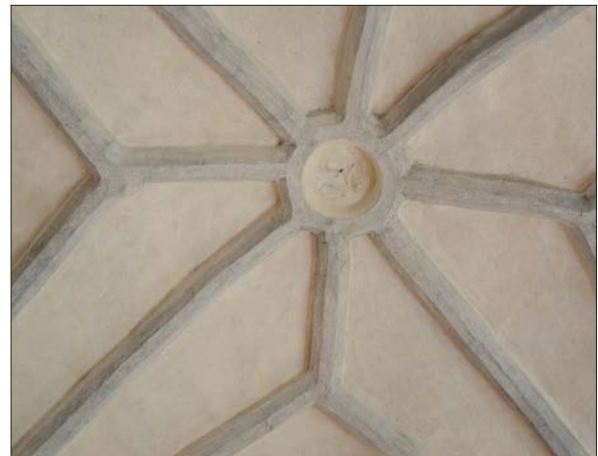
26 I det södra sidoskeppet är rören knappt synliga. (Slm D2014-598).
