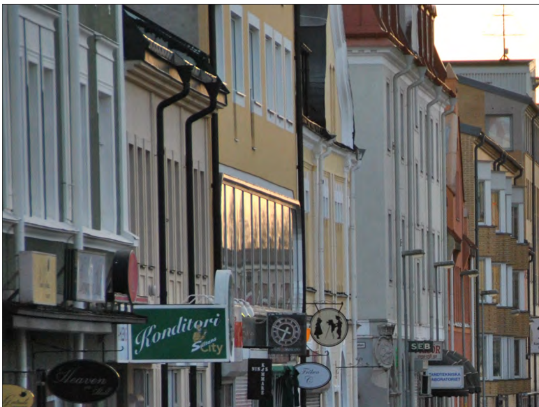
23 Byggnadsdetaljer och fasadelement bryter lättsamt upp Köpmangatans fasadliv vilket väcker intresse hos betraktaren (Slm D2014-245).
