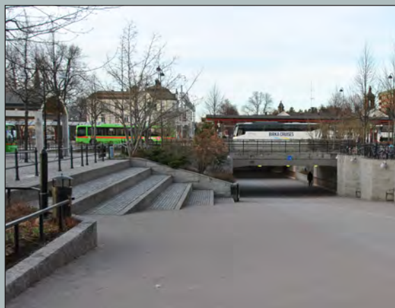
54 Gångtunneln som efterträdde de tidigare broarna. Tunneln binder samman stadens två sidor. (Slm D2014-273).
