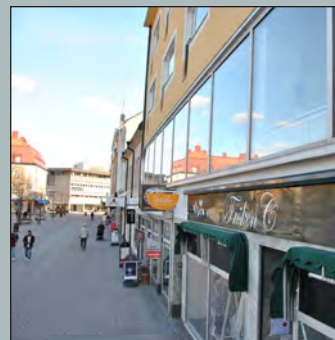
32 Lekfullt rundat kontorsfönster. (Slm D2014-253).
