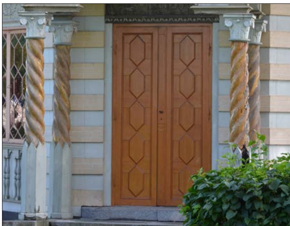
24 Utförandet av spiralkolonnerna med korintiska kapitäl visar på stor hantverksskicklighet (Slm D2013-646).
