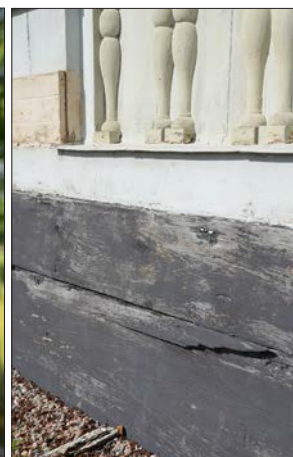
26 En stor träflisa har spruckit upp i sockeln (Slm D2013-648).
