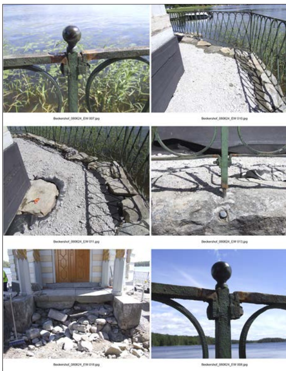
19 Blåstring och målning av järnräcket. Två av portikens kolonner tas ned i samband med åtgärder kring trappan. Eva Wockatz (Slm D2013-642).
