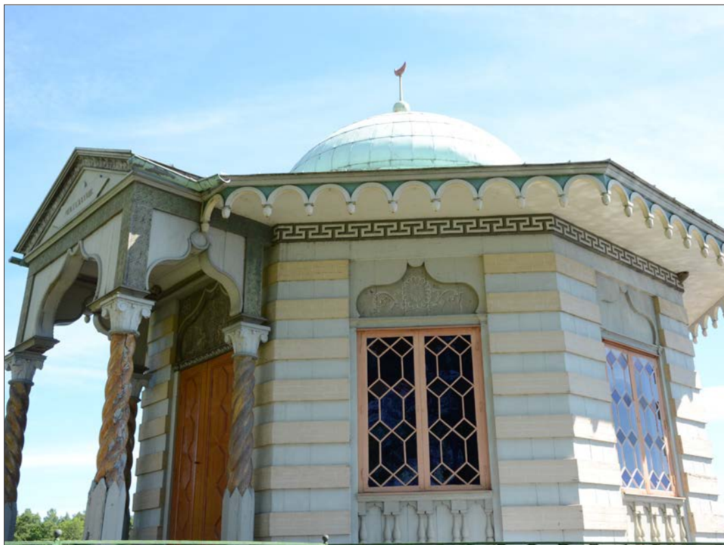
2 Byggnadens exteriör är idag färgsatt med kulörval som bryter mot byggnadens arkitektur. Foto: Kjell Taawo (Slm D2013-629)
