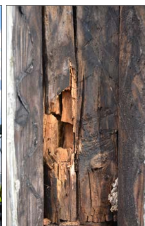
30 Kolonnens bas är rötangripen (Slm D2013-652).
