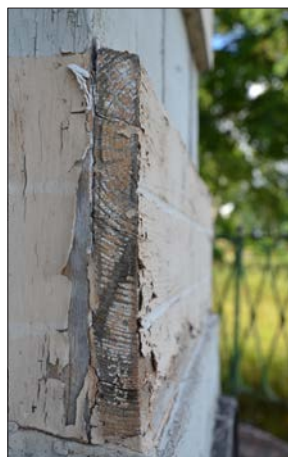
25 Färgskiktet har släppt från underlaget (Slm D2013-647).
