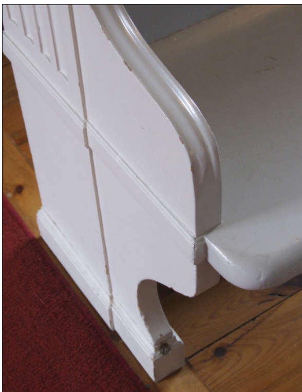
6 Bänkarna var fastskruvade i trägolvet med spårskruv (Slm D13-0199).
