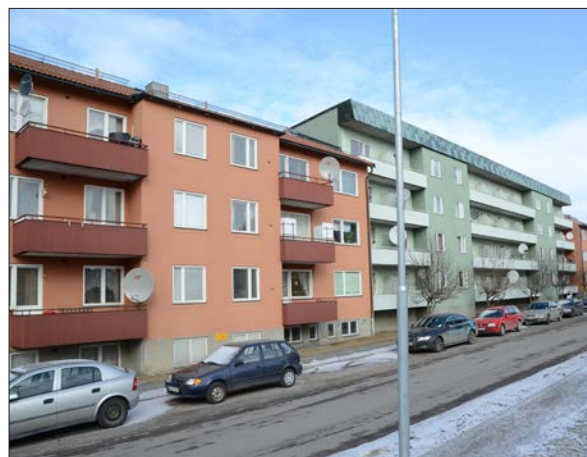
29 Fastigheten Vitsippan 3 (Slm D13-408).
