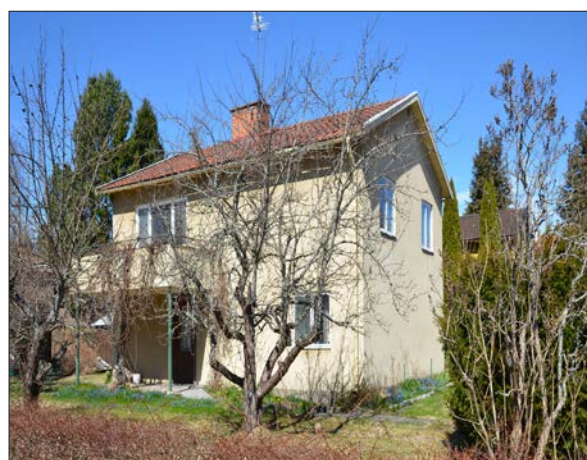
81 Välbevarad funkisvilla i fastigheten Stenkrossen 2 (Slm D13-451).
