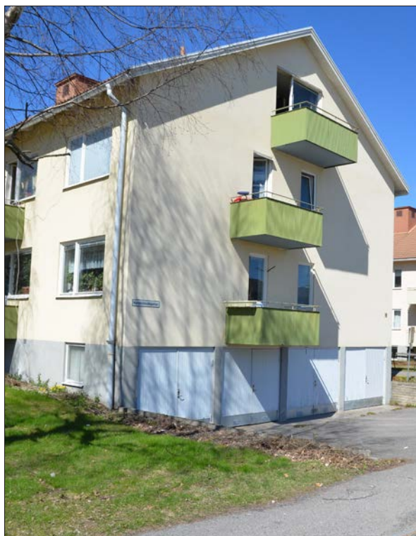
77 Fastigheten Räknestickan 5 och 4. (Slm D13-448).
