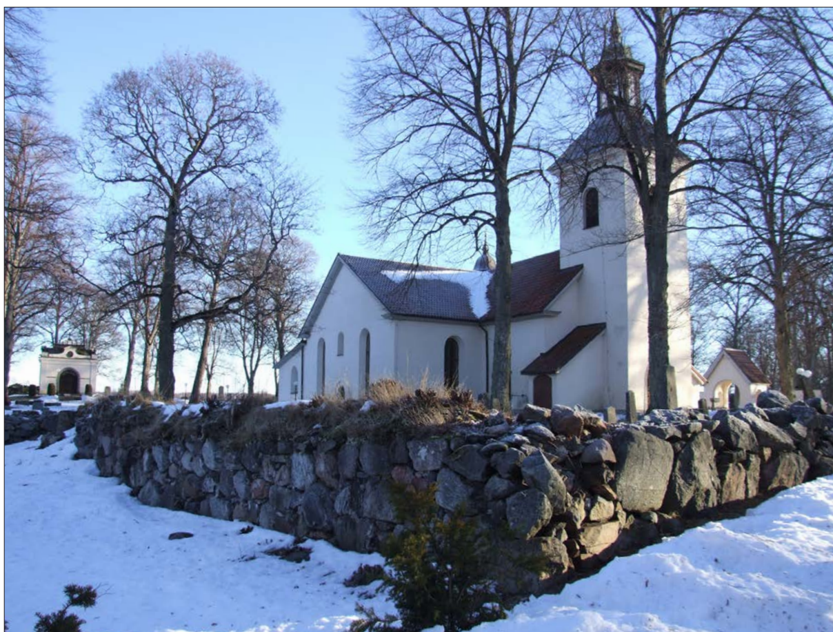
2 Julita kyrka sedd från nordväst, med bruksmuren till vänster och anslutande kallmur till höger, innan arbeten påbörjades (Slm D2013-690).
