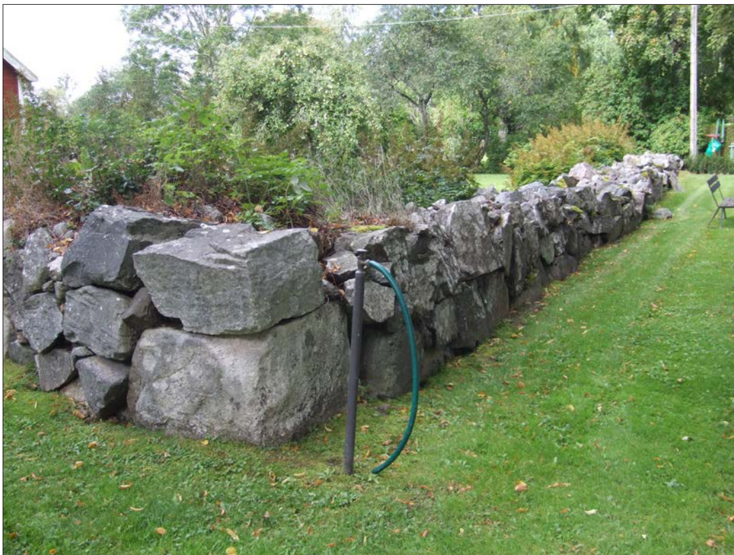
15 Den anslutande kallmuren i nordost före arbeten i september 2011. De två stora stenarna är troligen ditlagda då muren "kapades" mot öster och istället förlängdes mot norr (Slm 2013-701).
