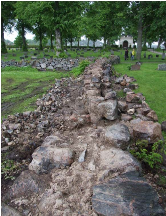
9 Bruksmuren efter rensning, sedd från väster i juni 2012 (Slm D2013-696).
