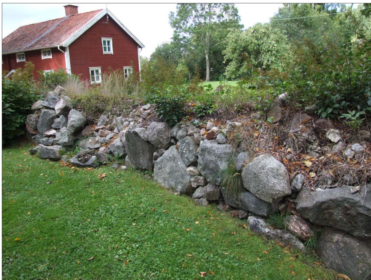
3 Bruksmuren var kraftigt överväxt och raserad. Bruksmuren sedd från sydost i september 2011 (Slm D2013-691).
