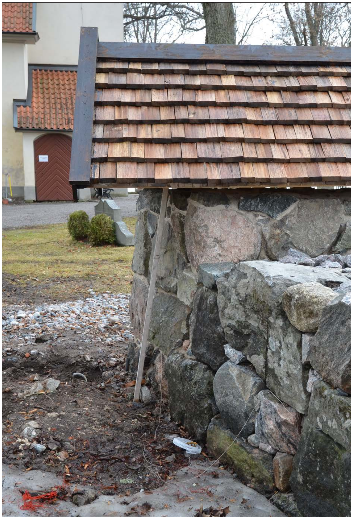
19 Bruksmurens östra kortsida anpassades efter nordöstra kallmuren, vilket gjorde att takets östra gavelröste sticker ut en bit utanför muren (Slm D2013-705).
