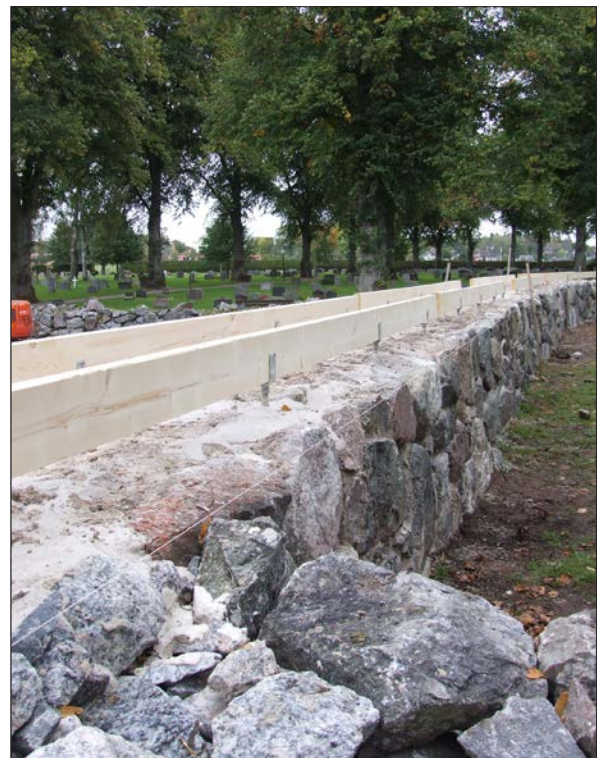
12 Stolpskor som håller taklagets bärlinor murades in mellan stenarna. Bruksmuren sedd från nordost i september 2012 (Slm D2013-699).
