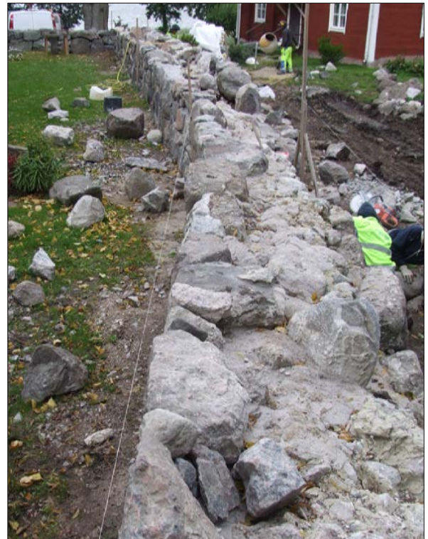
10 Bruksmuren sedd från öster i september 2012 efter tvätt. Muren "viker av" på mitten (Slm 2013-697).
