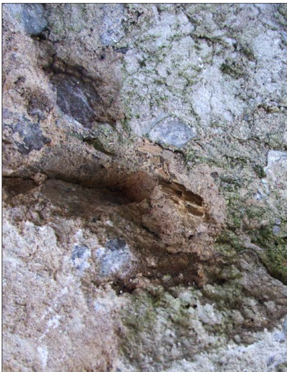
11 I murens kärna hittades rest av en träbit, vilken dessvärre var för spröd för att 14 C-dateras, september 2012 (Slm D2013-698).
