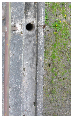
11 Läktargrundens formgjutna vattenränna (Slm D13-486).
