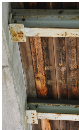
9 Detalj av balkarna som bär upp taket och som vilar på stålplackar (Slm D13-484).
