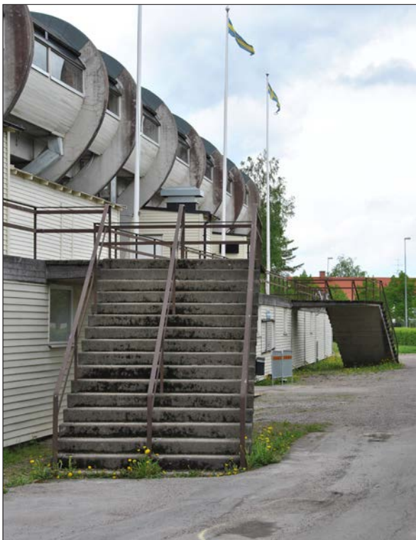
27 Läktarens baksida. Dubbeltrappor leder upp till läktaren (Slm D13-495).
