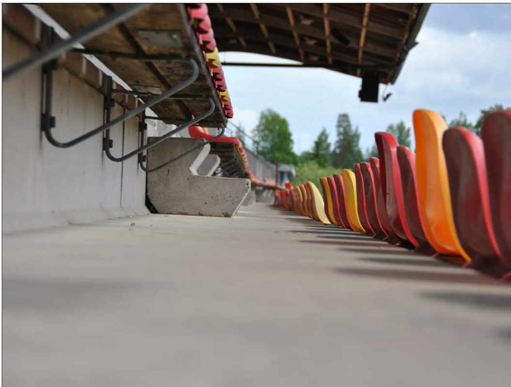
13 Vy av gradängerna. Sätena är monterade på de äldre träbänkarna (Slm D13-488).
