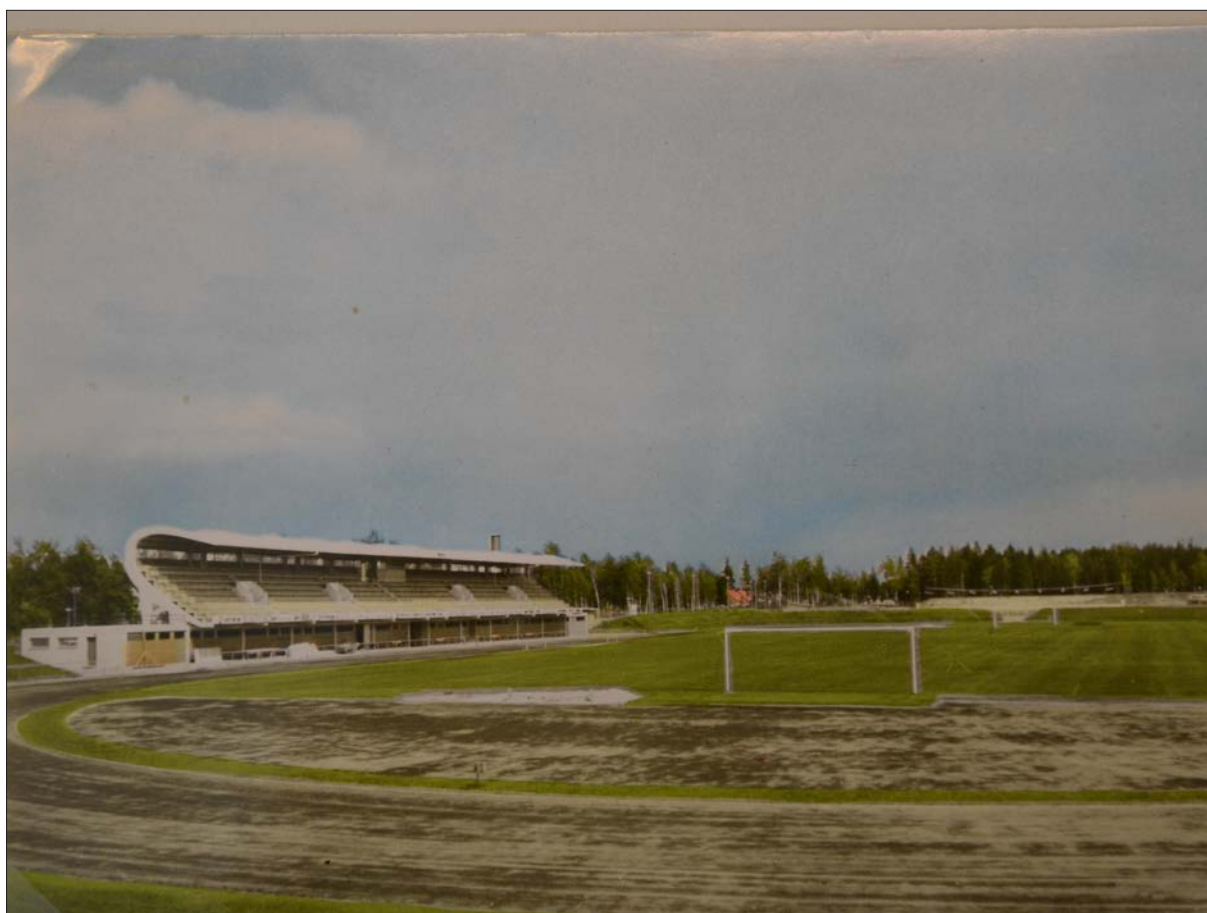
18 Läktaren sedd från sydväst år 1966. Läktaren har träbänkar och tillbyggnaden vid invigningen 1962. Bilden lånat från Katrineholms kommunarkiv. Okänd fotograf.
