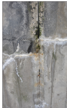
32 Läktargrädängernas skruvgenomföringar har på många håll roststat och sprängt sönder betongen. (Slm D13-506).
