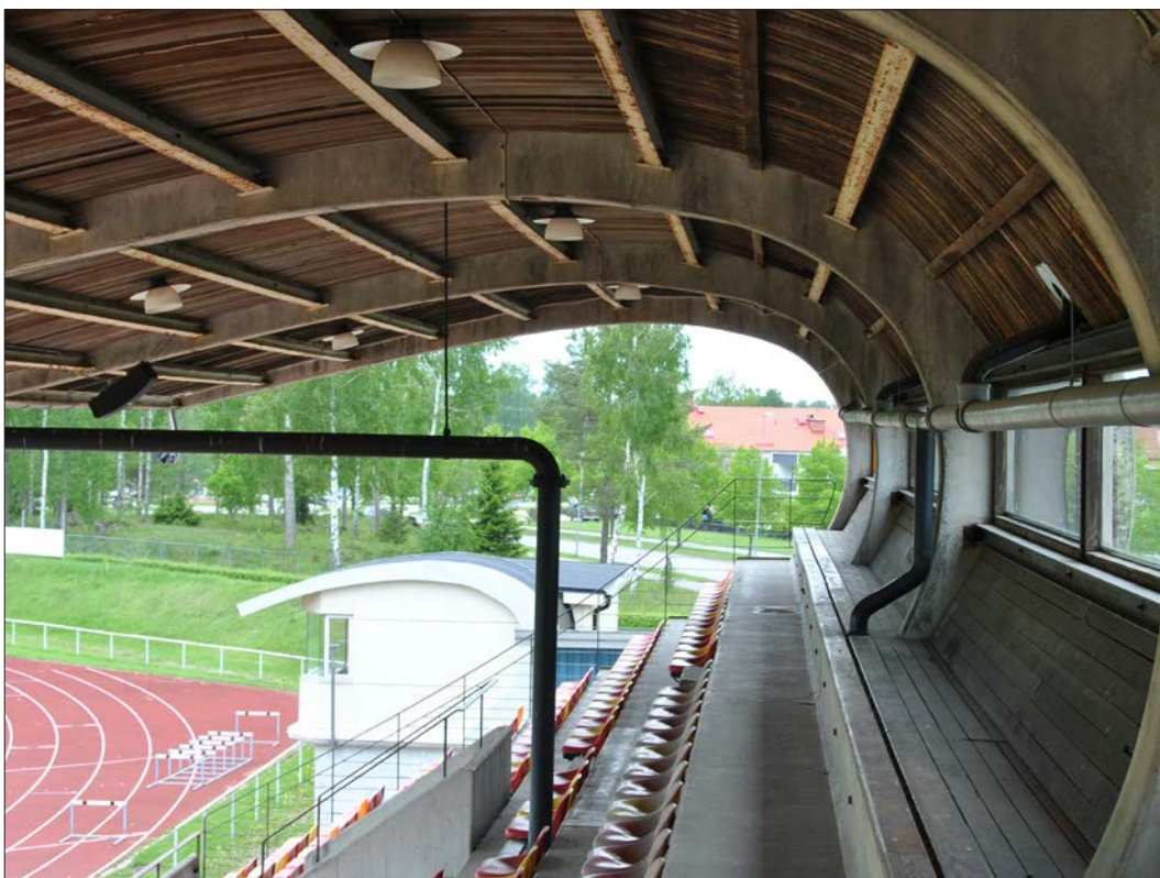
14 Vy inifrån läktaren mot väster. I bild syns takavvattningsystemet med stuprör som leder ned takfallets regnvatten. Det bakre horisontella uppsamlingsröret är nyligen utbytt mot ett plaströr med många länkande rörskarvar. Foto: Eva Wockatz (Slm D13-489).
