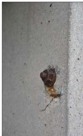
32 Läktargrädängernas skruvgenomföringar har på många håll roststat och sprängt sönder betongen. (Slm D13-506).
