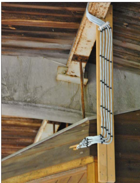
46 Ovarsam kabeldragning (Slm D13-520)
