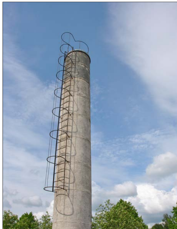
28 Detalj av skorstenen. De horisontella skarvarna visar att skorstenen är byggd av hopmonterade rördelar (Slm D13-496).
