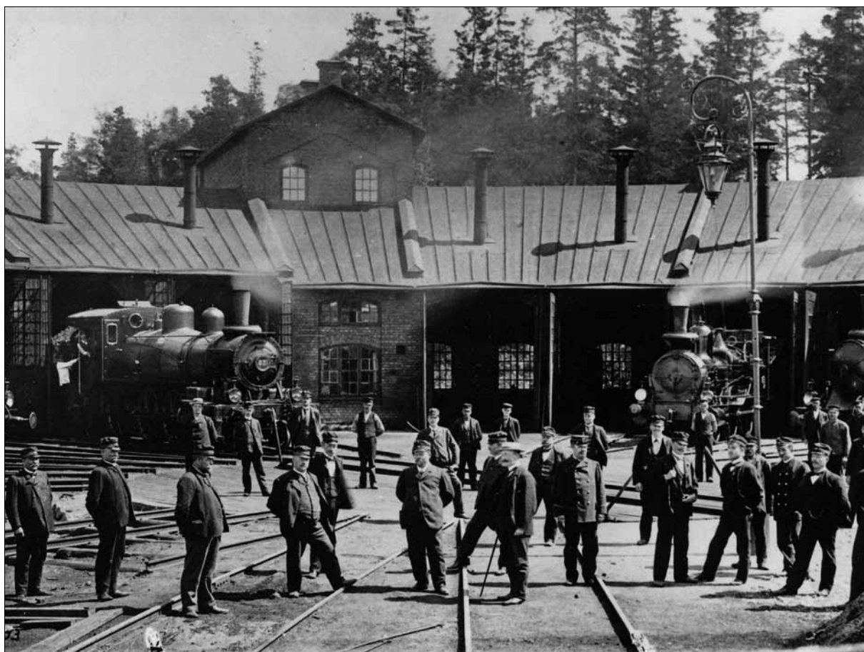
10 Lokstallets mittparti sett från vändskivan år 1905. Före vattentornets påbyggnad samt med ursprunglig takbeläggning och ursprungliga skorstenar. Okänd fotograf, Sörmlands museums arkiv. Bildnr M022927.
