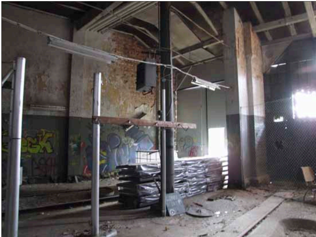
72 Lokstall 14 och 15 sett mot vändskivan.
