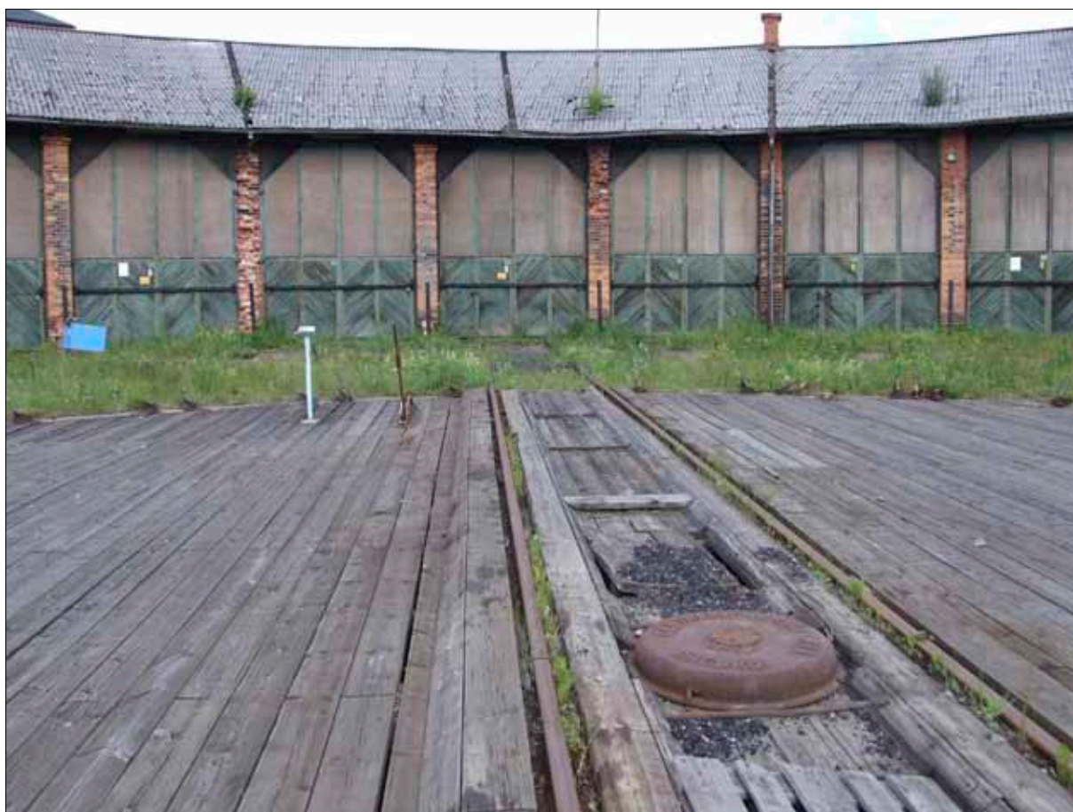
47 Vändskivan sedd från söder.
