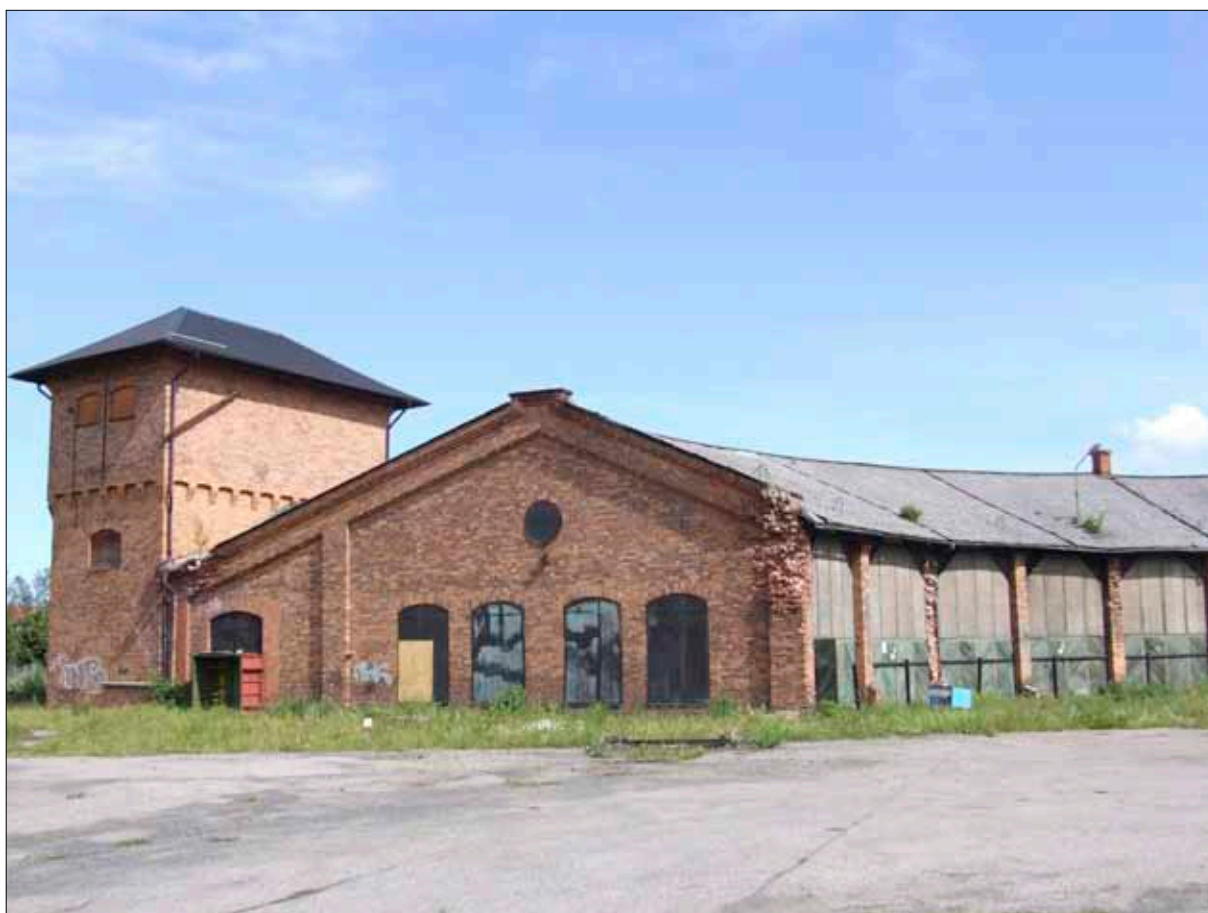
2 Del av Katrineholms lokstation med sandtornet till vänster i bild, ursprungligen byggt som vattentorn.
