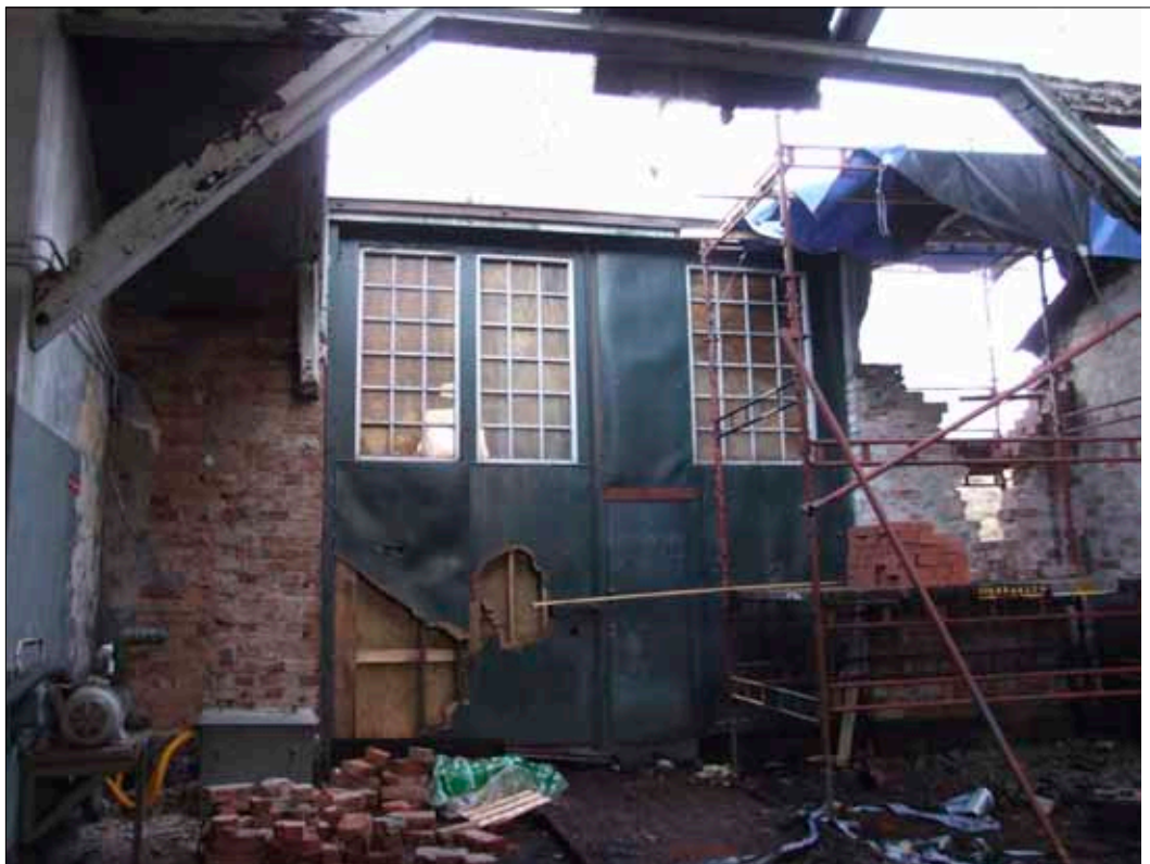
65 Lokstall 13 sett mot öster, där spåret fortsätter ut mot oljeförrådet.
