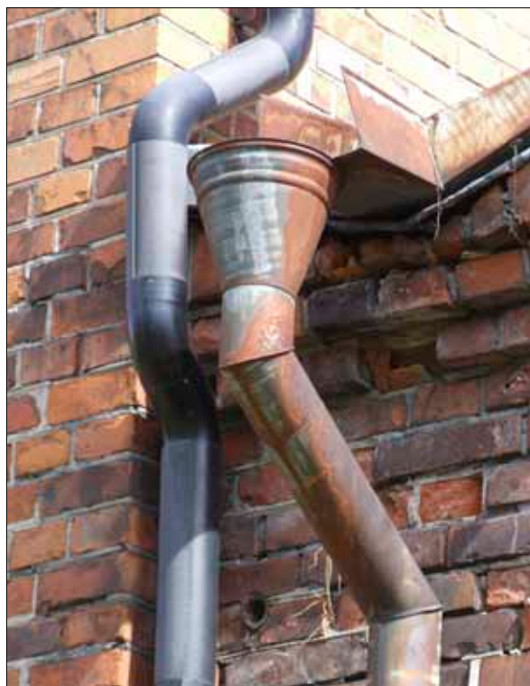
23 Äldre stuprör med konisk trätt vid gaveln mot sydväst.
