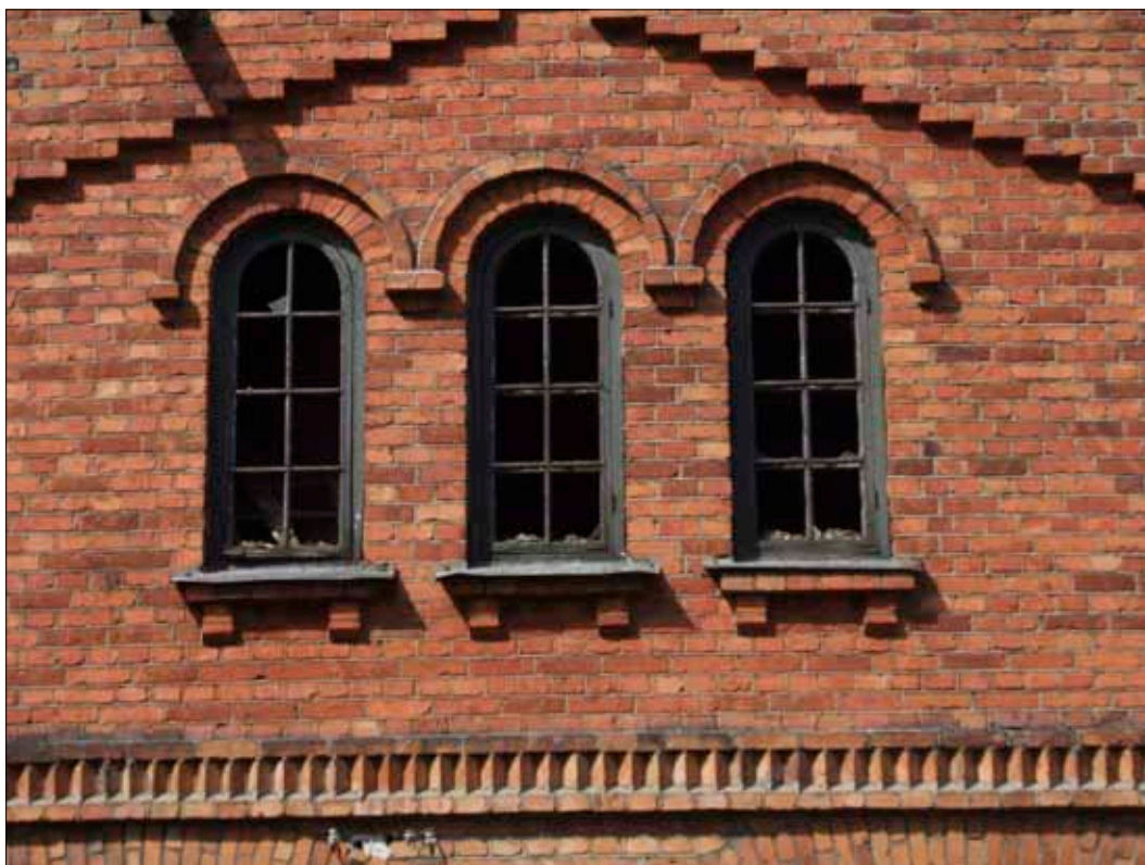
45 Detalj av tredje våningens fönsterparti mot öster med det dekorativa strömskiftet på fasaden.
