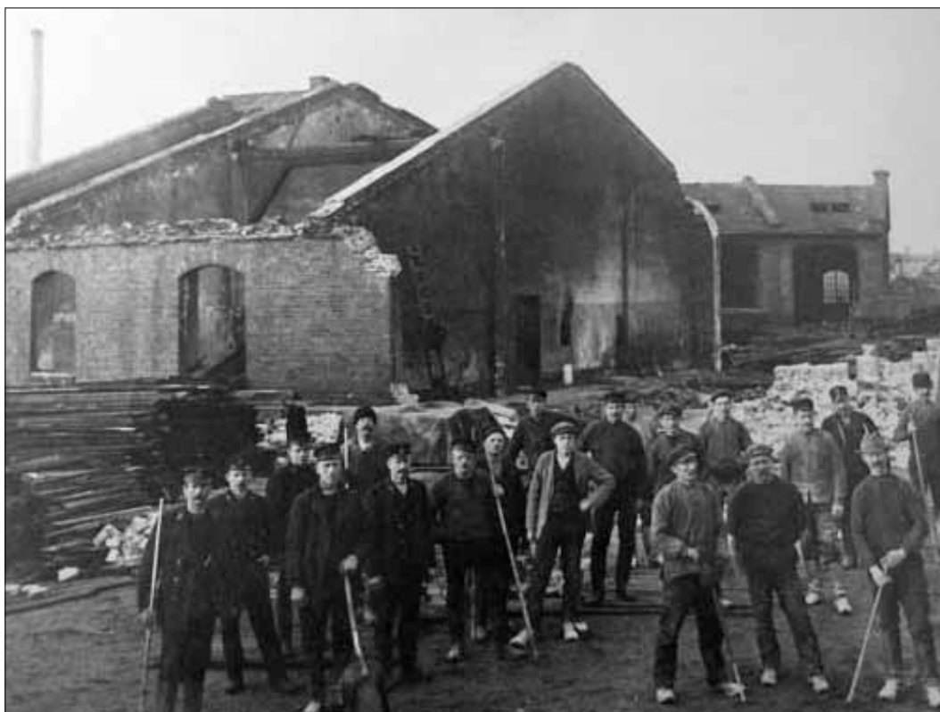
6 Rivning av Katrineholms första lokstall år 1912. Fotografi från Katrineholms kommunarkiv.
