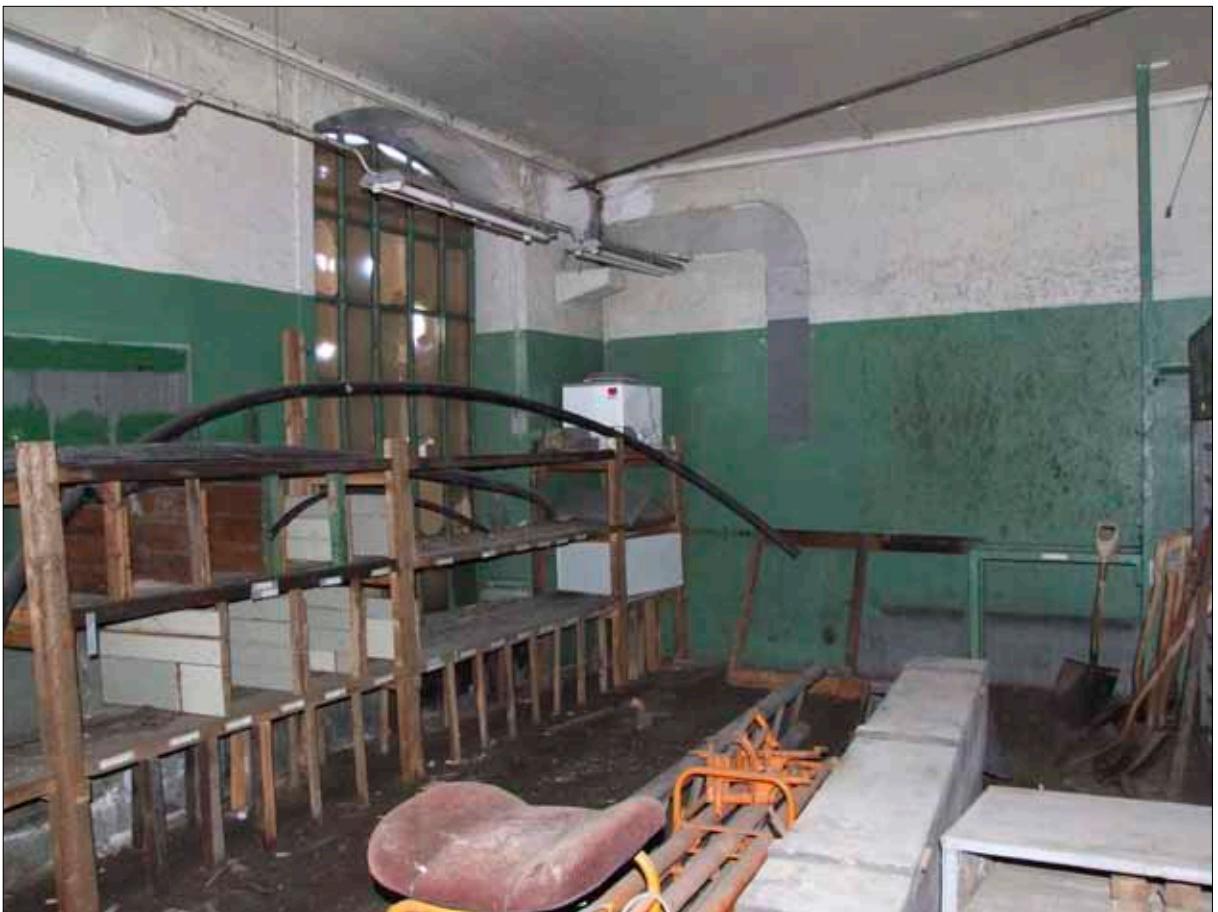
59 Rum 2A, slangverkstaden. Hyllor är placerade utefter väggarna.
