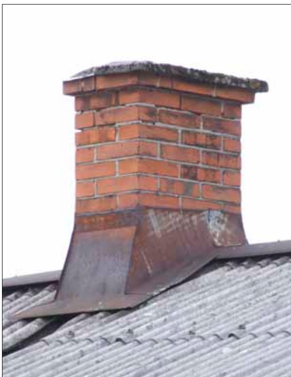
22 Skorsten som är placerad vidnock ovanför stallarna.
