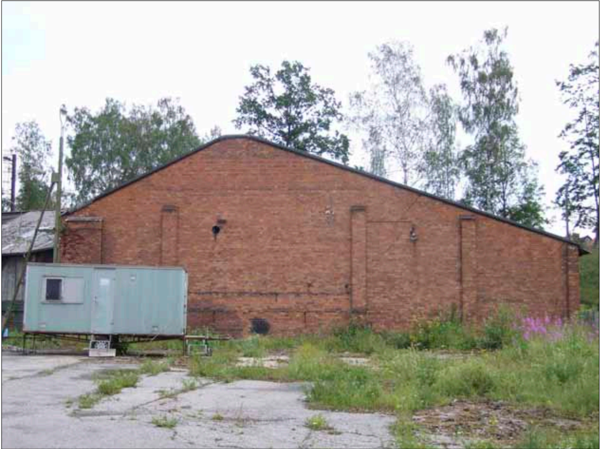
24 Gaveln mot väster på lokstallet. Det cirkulära hålet är en ventilationsöppning.
