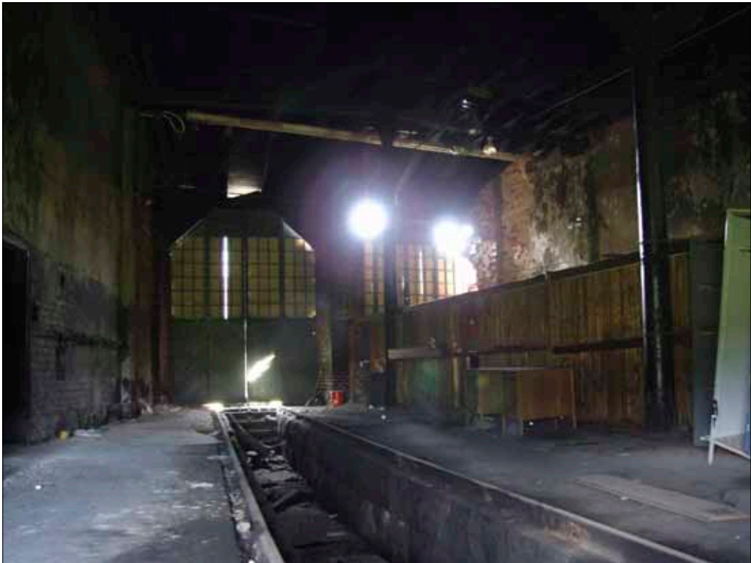
63 Lokstall 9 sett mot vändskivan.
