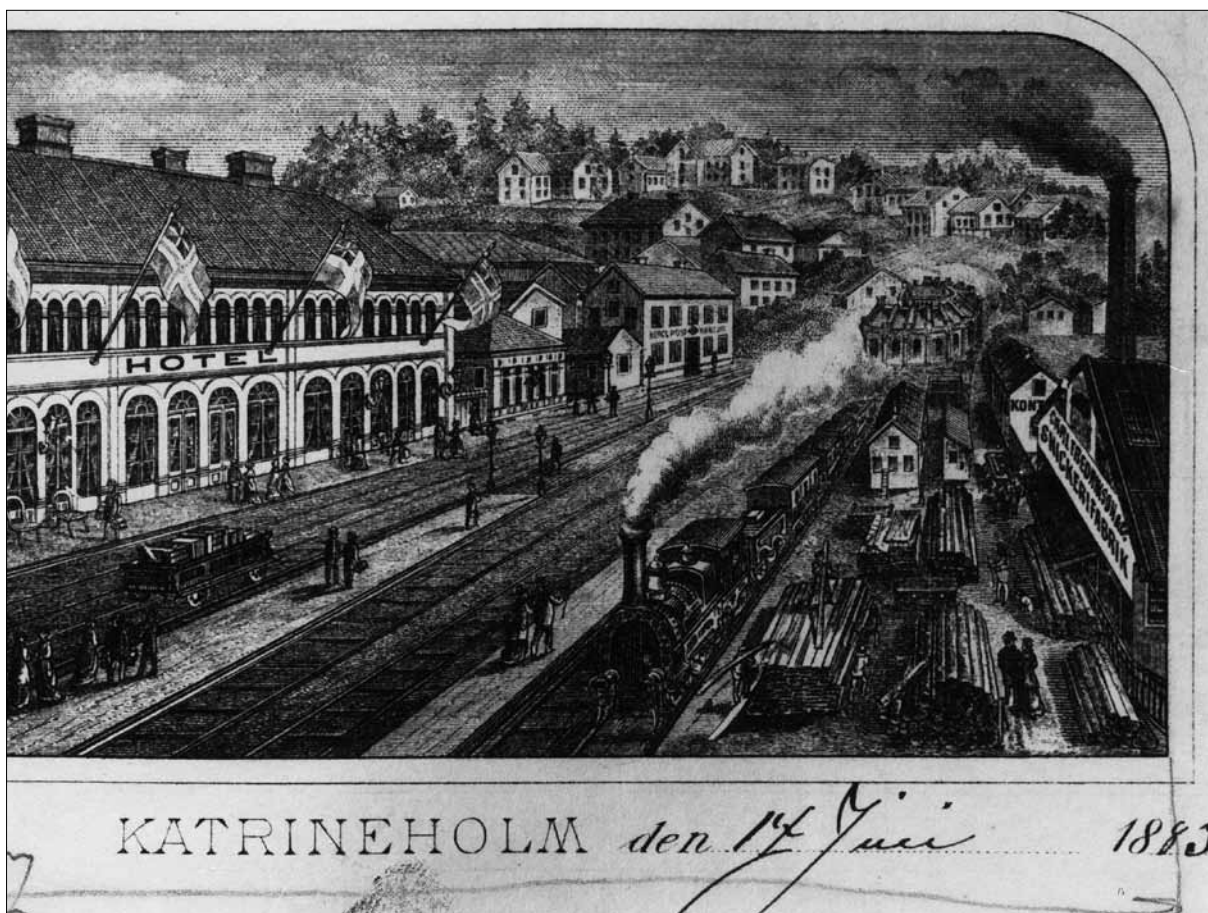
4 Del av vykort daterat år 1883, där det tidigare lokstallet som byggdes år 1862 är med i bild. Sörmlands museums arkiv. Bildnr M022896.
