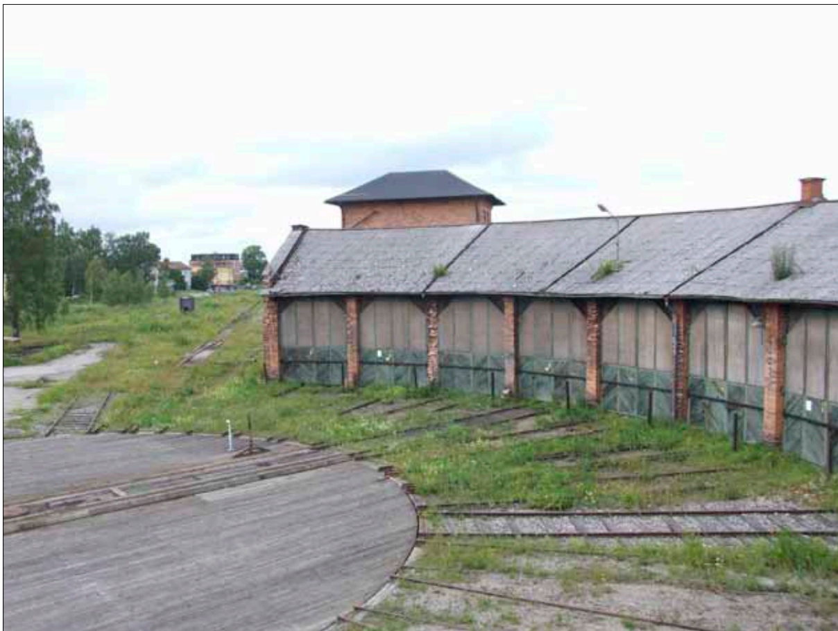
21 Lokstallets västra del. Fotot taget strax innan takomläggningen 2007.
