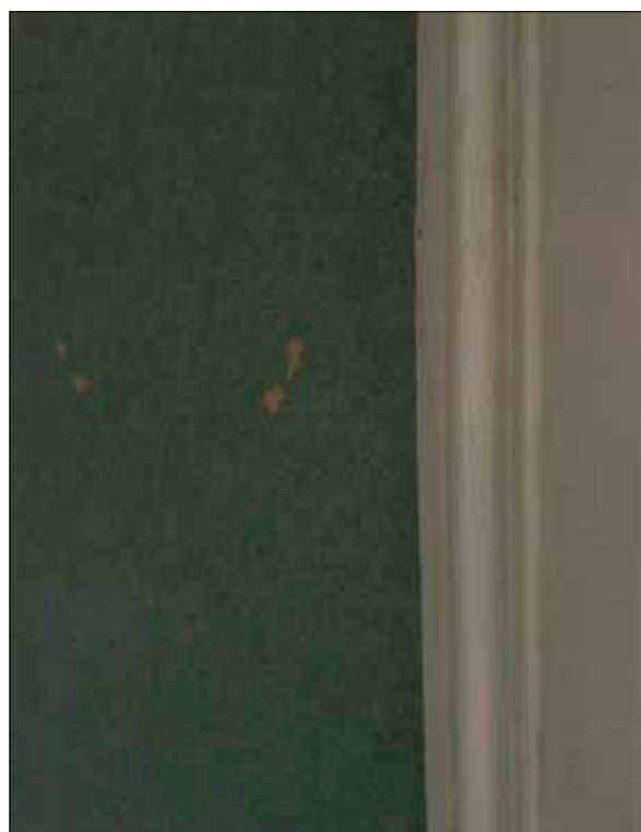
37 Fönsterfoder i rum 102.
