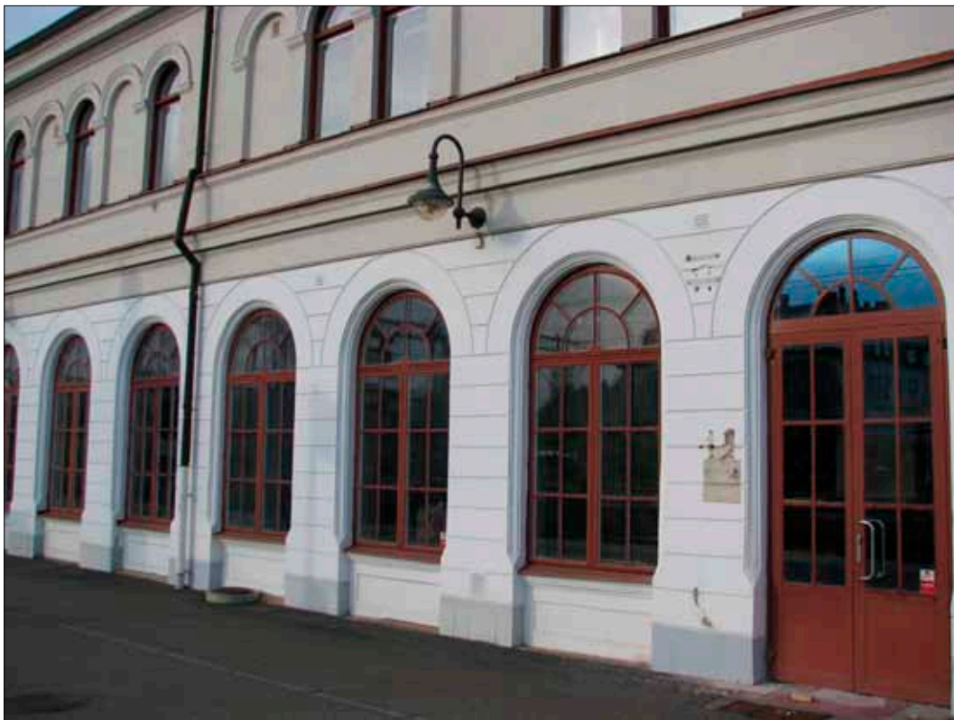
16 En mäktig fasad med den välvda fönsterraden mot perrongen. Hotellvåningen skymtar ovanför.
