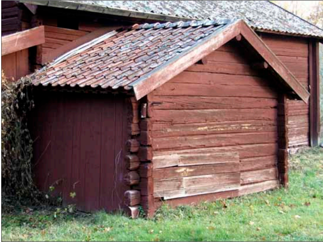
26 Hus 8 från sydväst (Slm D09-768).
