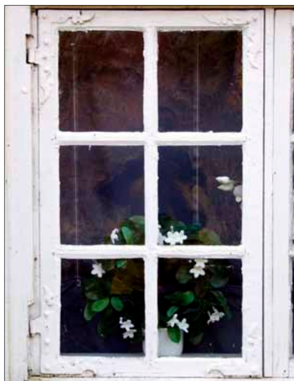
9 Fönster med 1700-tals beslag, hus 2 (Slm D09-752).
