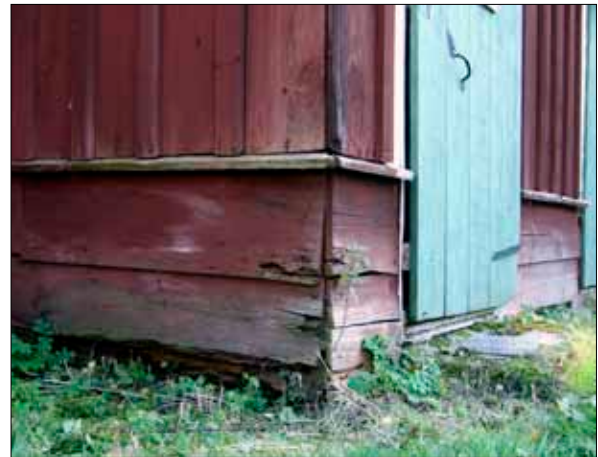
78 Skadad syllstock och panel vid förstugans nordvästra hörn (Slm D09-818).
