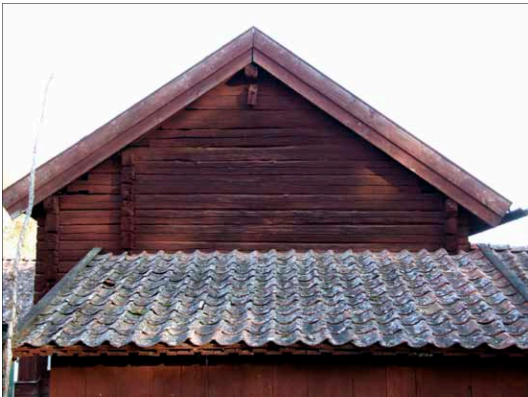
23 Gaveln på hus 6 från sydväst med hus 7 i förgrunden (Slm D09-765).
