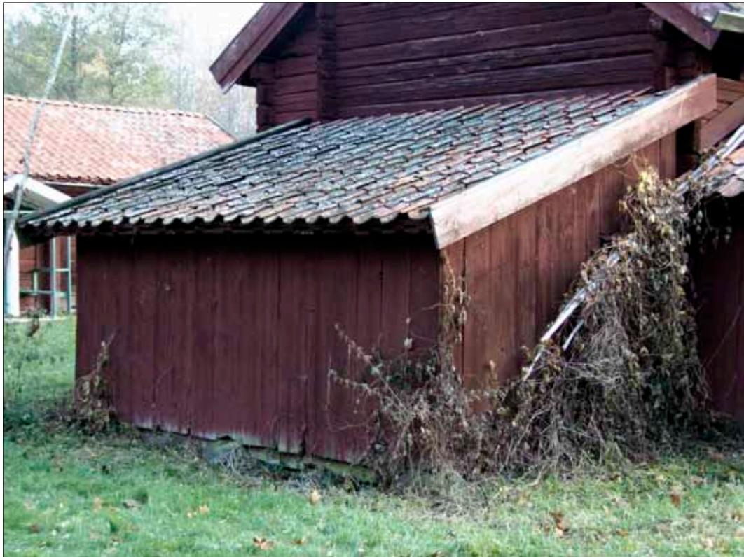
25 Hus 7 från sydväst (Slm D09-767).
