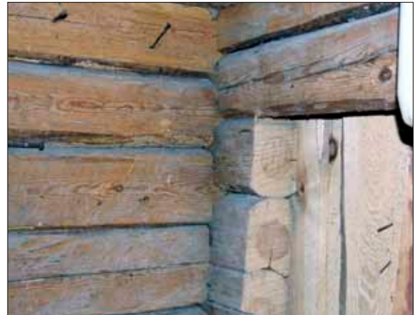
61 Flyttmärkning vid det norra hörnet i rum 502 från söder (Slm D09-803).
