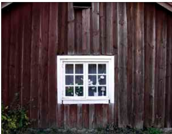
82 Lockpanelen på byggnadens nordöstra gavel (Slm D09-822).
