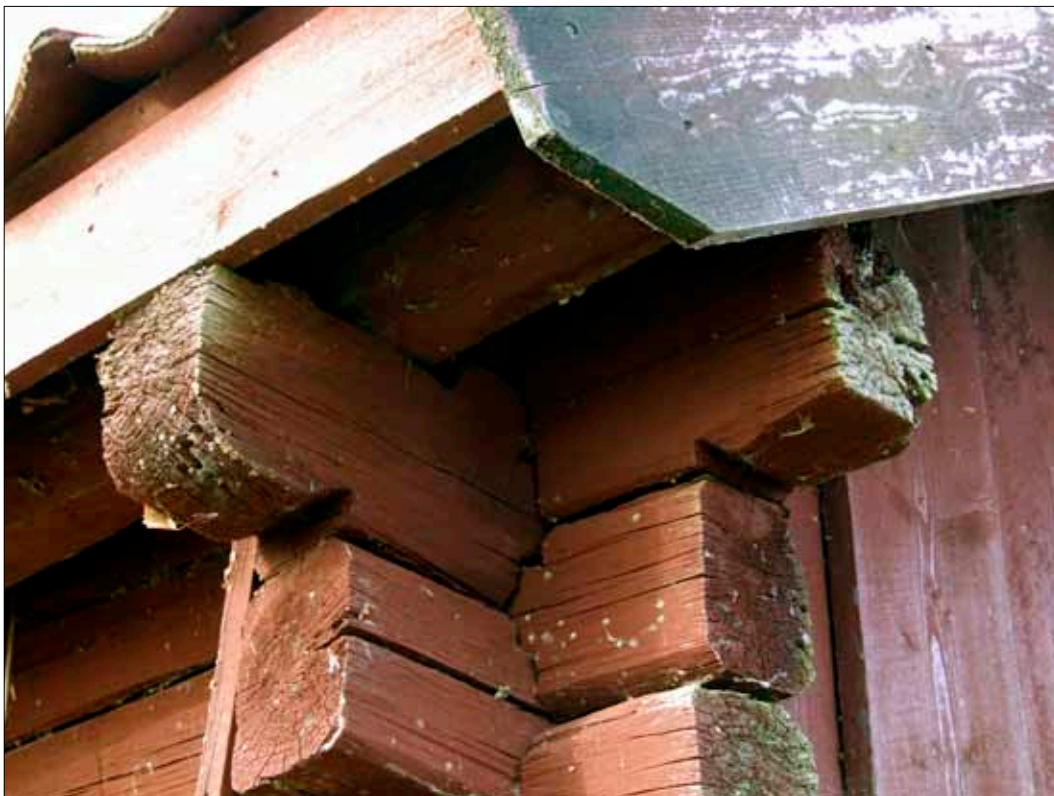
73 Det östra hörnet på hus 10 med vågbord och dekorativt tillhugna bjälkändar (Slm D09-815).
