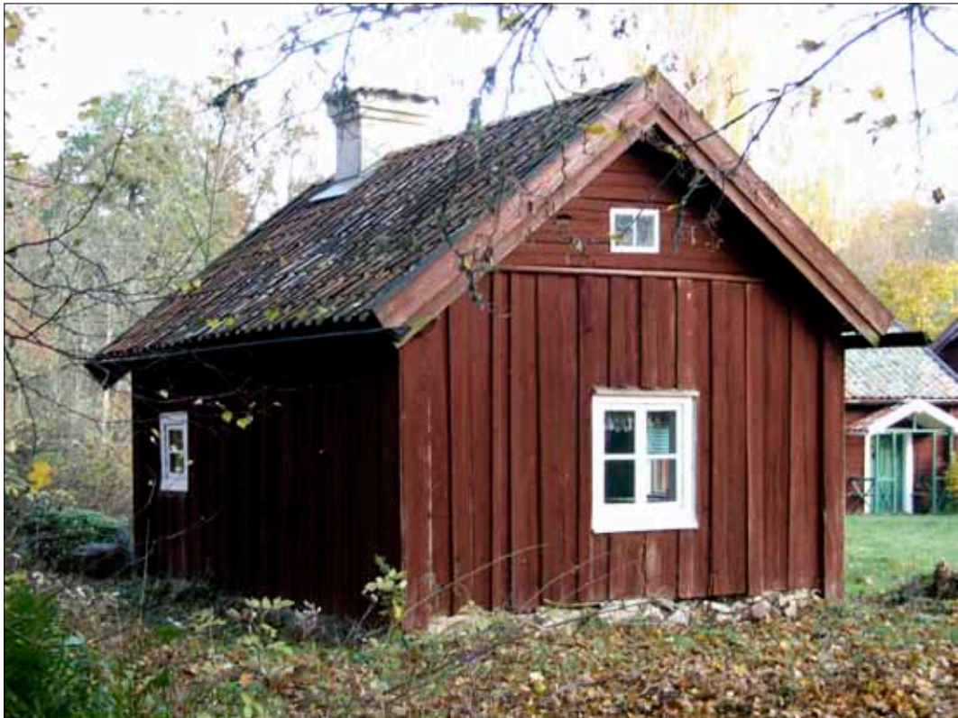
35 Hus 12 från sydväst (Slm D09-777).
