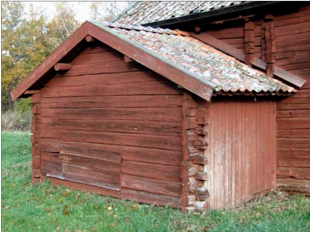
27 Hus 8 från sydost (Slm D09-769).
