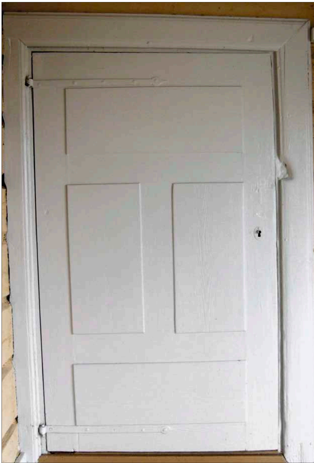
36 Fyllningsdörr i rum 201, hus 2 (Slm D09-778).
