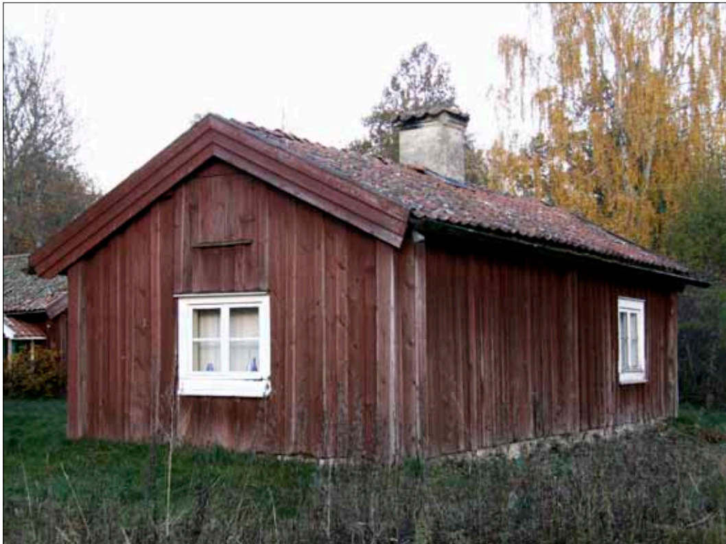
13 Hus 1 från sydost (Slm D09-755).
