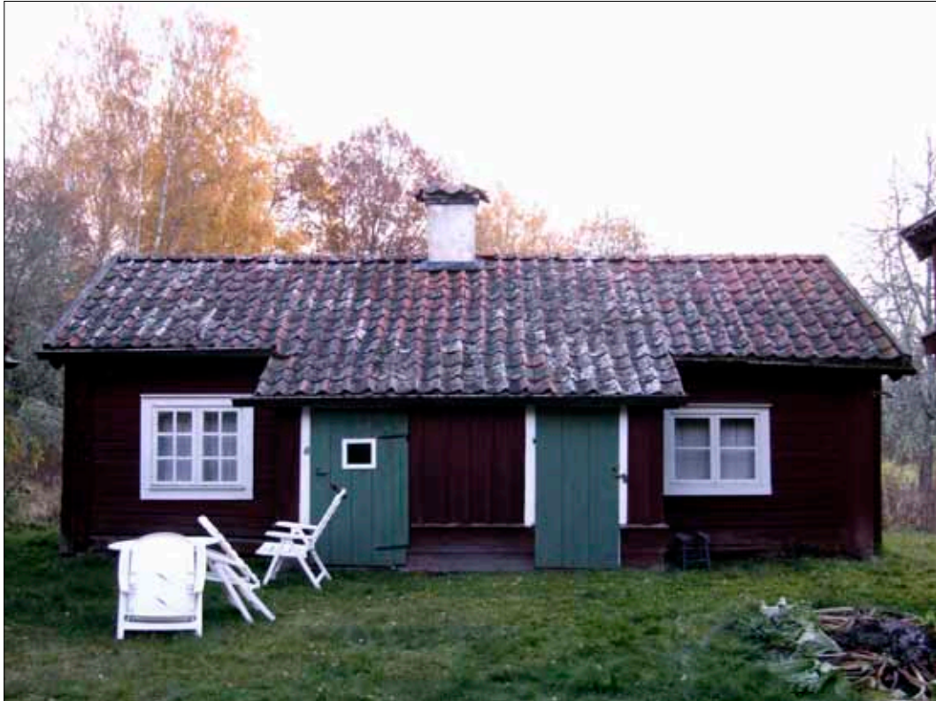
12 Hus 1 från sydväst (Slm D09-754).
