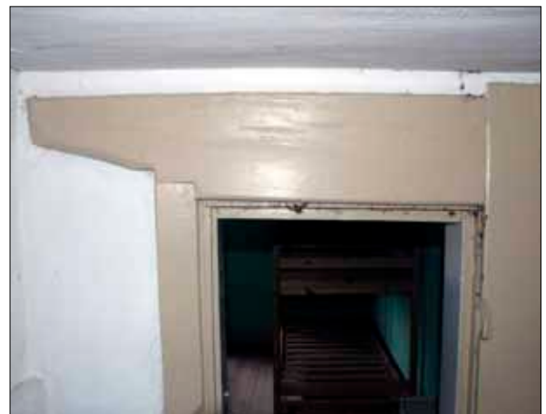
57 Detalj av dörröppning mellan rum 1203 och 1204 från rum 1204 (Slm D09-799).
