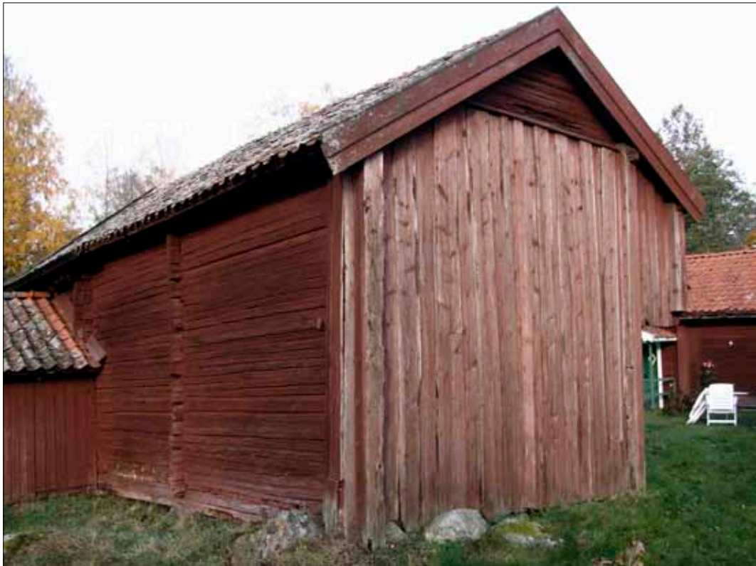
21 Hus 5 från sydost (Slm D09-763).
