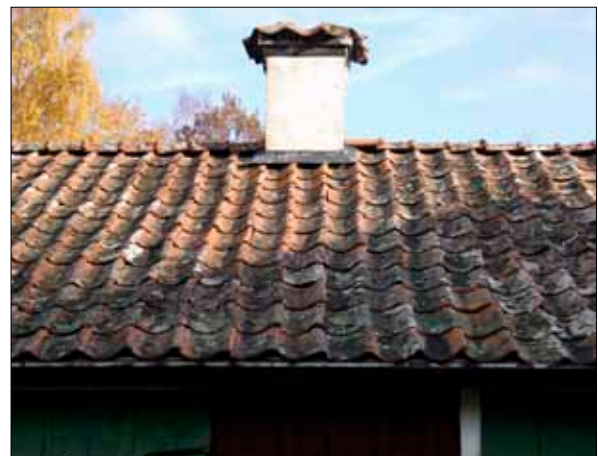
80 Byggnadens sydvästra takfall (Slm D09-820).
