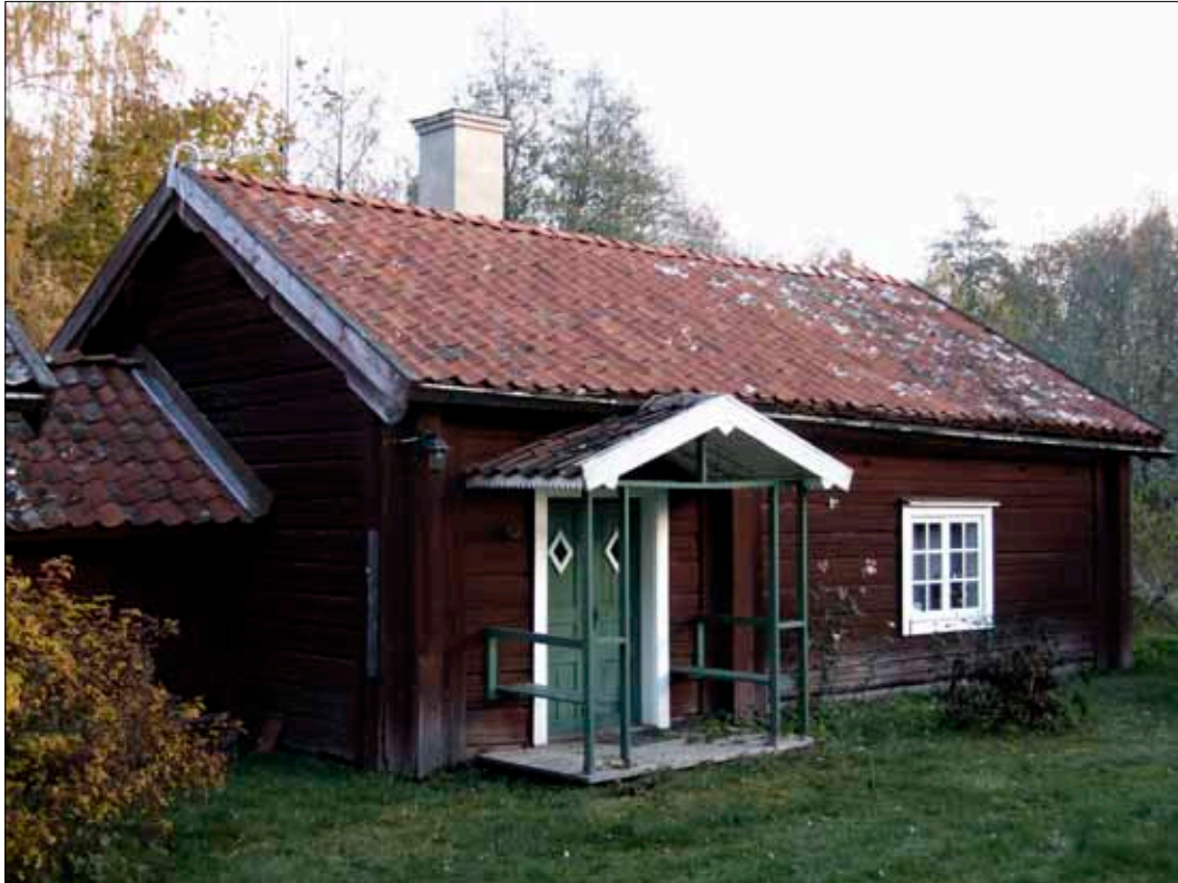
14 Hus 2 från sydväst (Slm D09-756).
