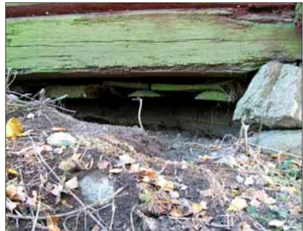
105 Minst en golvbjälke har kommit ur läge på grund av grävlingens aktiviteter (Slm D09-843).
