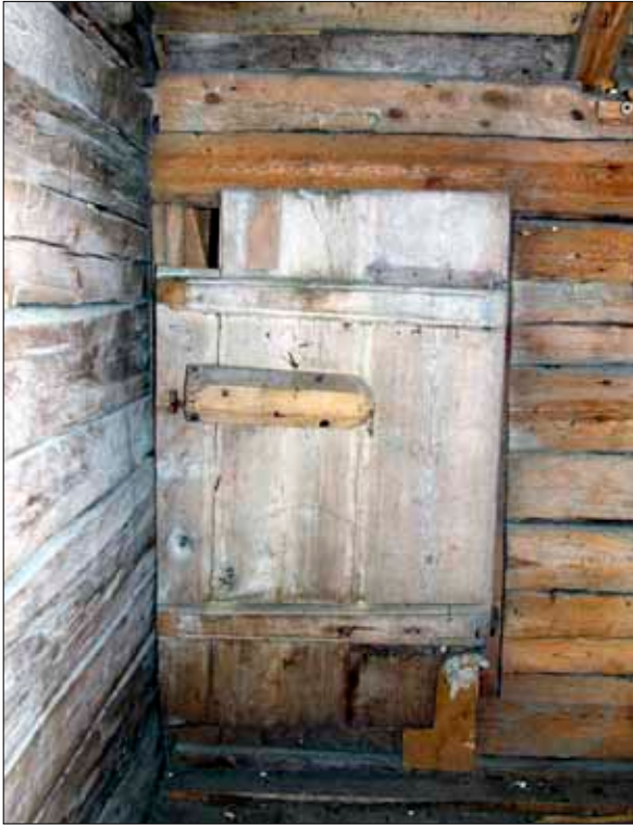
58 Dörren i rum 503 från sydost (Slm D09-800).
