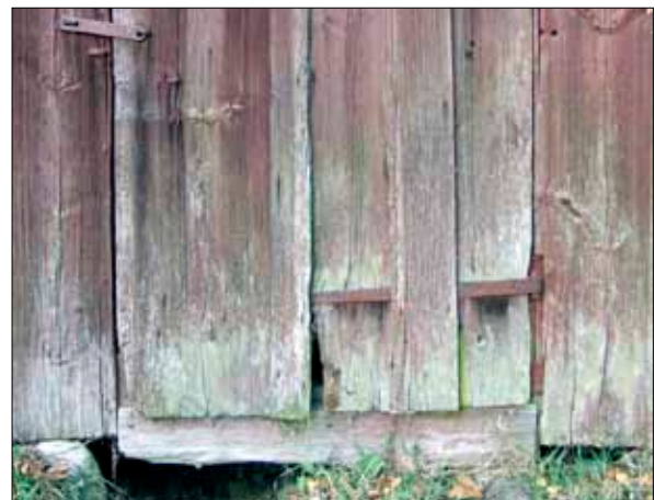
106 Dörrarnas nedre delar är delvis rötskadade (Slm D09-844).
