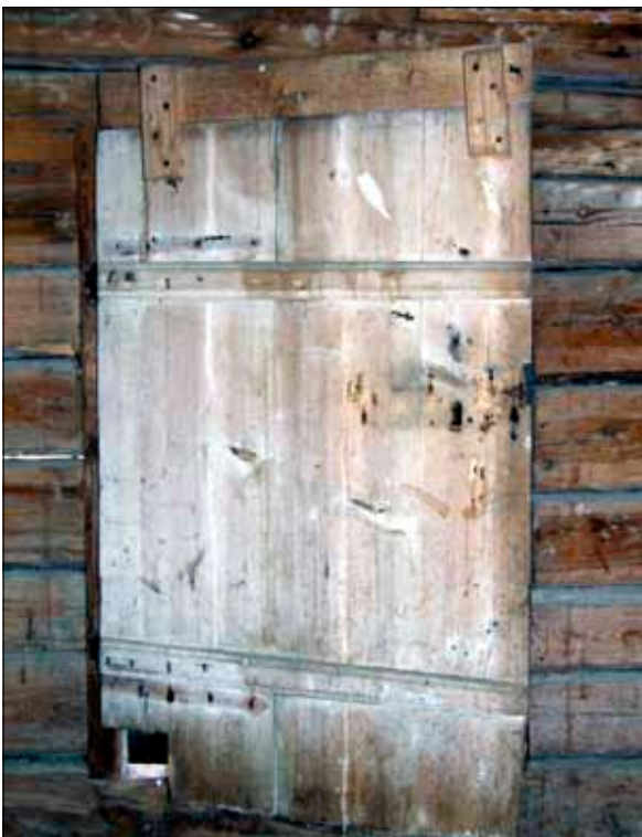
59 Dörren i rum 602 från sydost (Slm D09-801).
