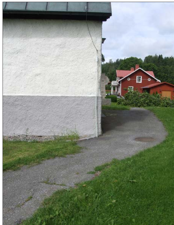
12 Den sedan tidigare asfalterade gången direkt norr om sakristian hade skador och belades därför med ny asfaltt (Slm D2014-402).
