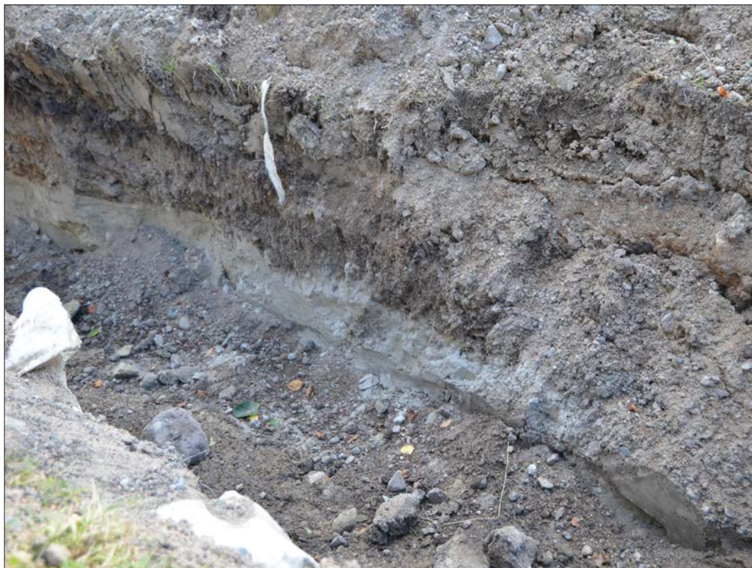
15 Del av schaktet för avloppsledningen ned till Frösjön. I schaktets nedre delar syntes den äldre sjöbottnen. Fotografi Dag Forssblad (Slm D2014-405).
