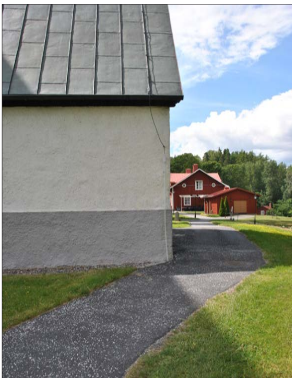
13 Samma gångparti efter asfalteringen (Slm D2014-403).
