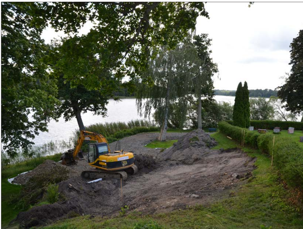
7 Schaktningsarbeten övervakades den 31 juli 2012. Fotografi Dag Forssblad (Slm D2014-397).
