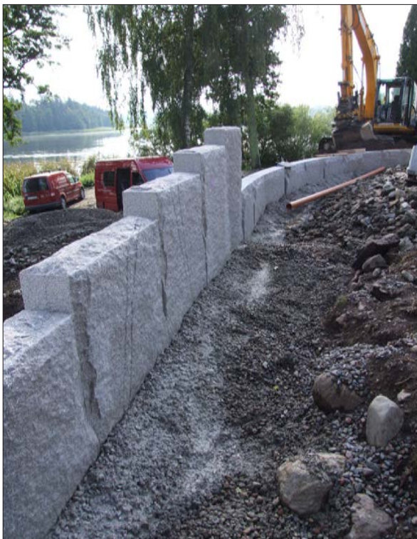
11 Terrassmurarna byggdes upp av huggna granitblock, som sattes i betongfundament (Slm D2014-401).
