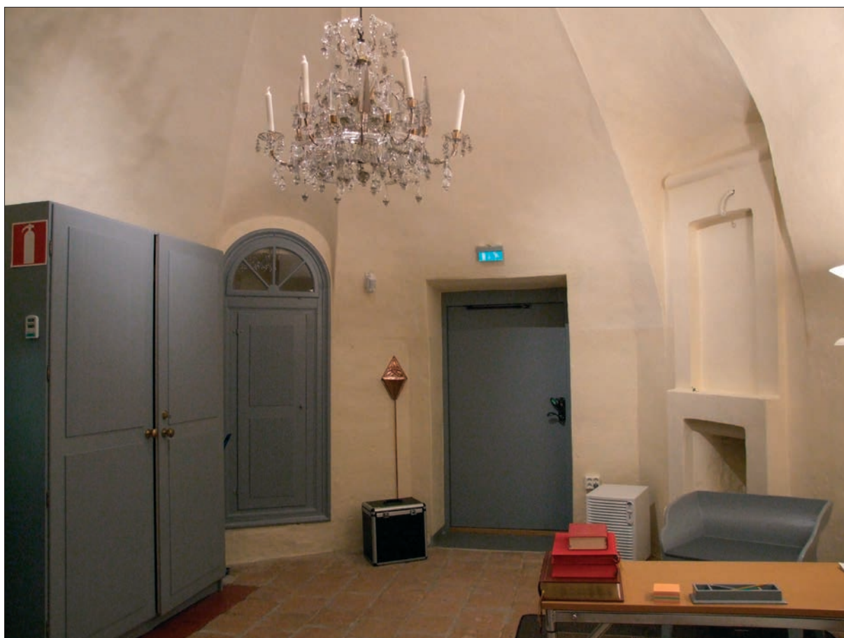
29 Sakristian sedd mot väster efter åtgärder 2007 ( D12-0326).
