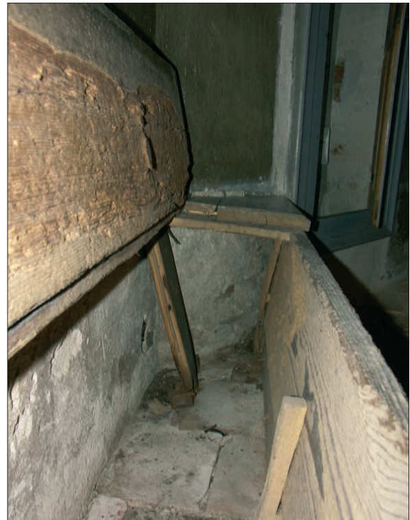
17 Detalj av den östra bänkens insida. Sittbrädan är utformad som en lucka. Vägghputsen är omålad (Slm D12-0315).
