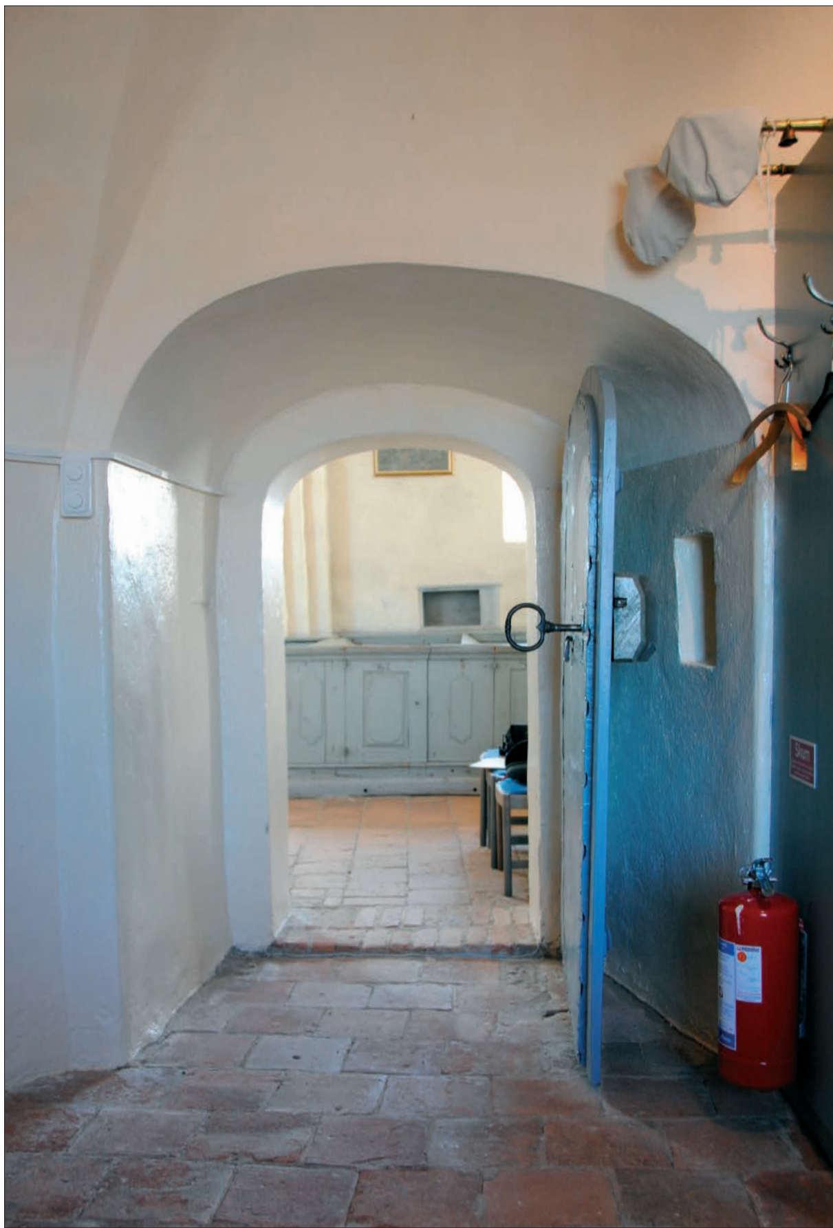
34 Vy från sakristian ut till långhuset efter åtgärd (Slm D12-0331).
