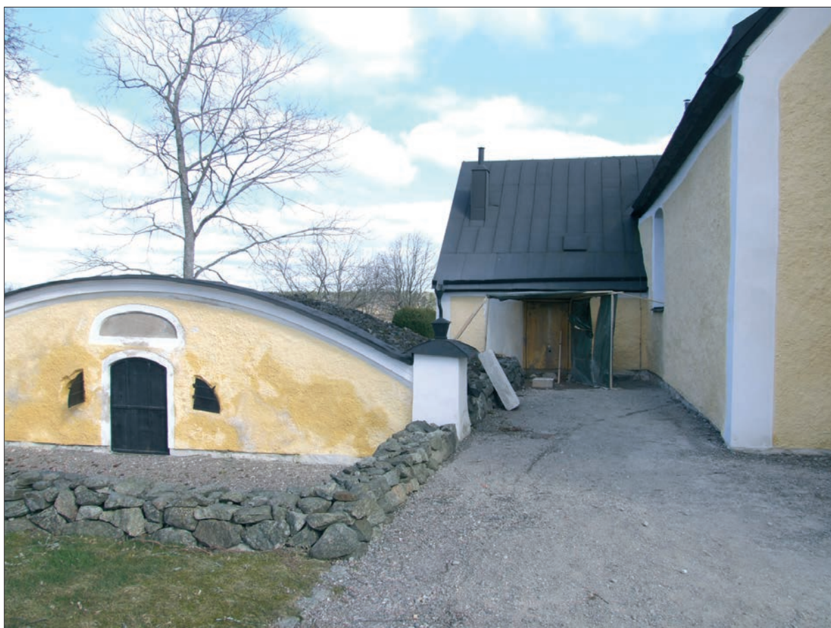
30 Sakristian sedd utifrån efter åtgärder, med den nya utrymningsvägen. Till vänster den så kallade rosanderska graven ( D12-0327).
