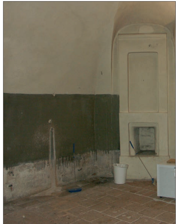
21 Väggytan bakom bänkarna var okalkad. Det stora borrhålet är efter provborrningen inför håltagningen av utrymningsvägen (Slm D12-0318).
