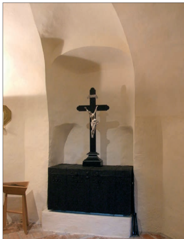
33 Järnkistan i sakristian efter åtgärder (Slm D12-0330).
