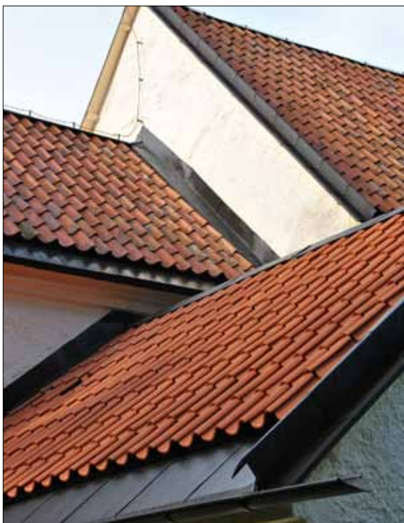
5 Långhuset, koret och sakristian täcks av enkupigt, rött lertegel (Slm D11-209).
