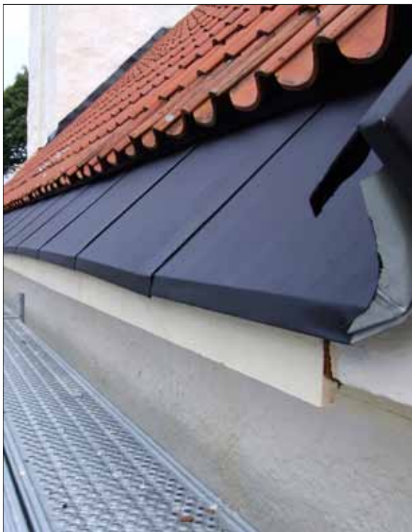
19 Takfotssprånget utfördes med nedknäckt kant, vilket avvek från tidigare plåtar (Slm D11-222).
