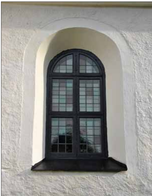
15 Dörr- och fönstersnickerier målades med linoljefärg pigmenterad med grön umbra (Slm D11-218).
