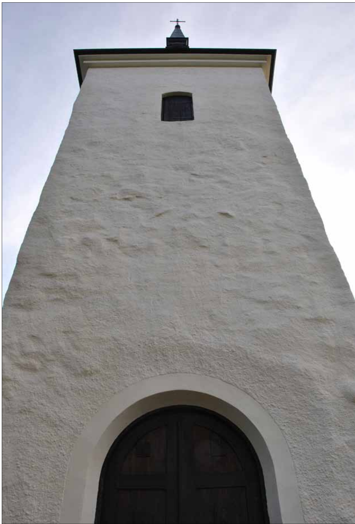
9 Fasadernas spritputs härrör från 1800-talet (Slm D11-211).
