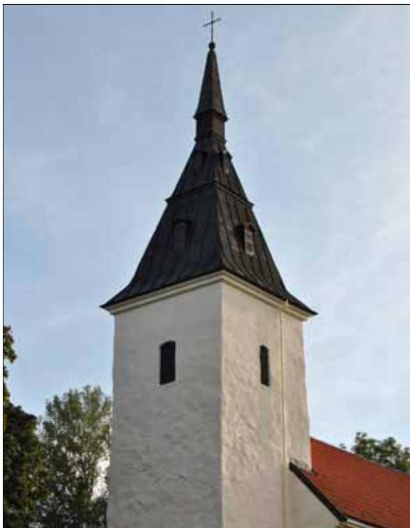
4 Tornspiran har skivtäckning av svartmålad plåt (Slm D11-208).
