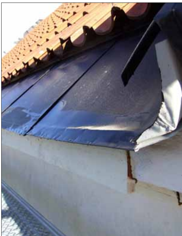
20 Efter samråd med Länsstyrelsen rätades plåtarna ut på långhusets takfall (Slm D11-223).
