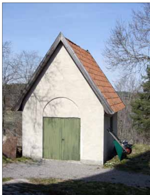
14 Bårhuset före restaureringen (Slm D11-217).
