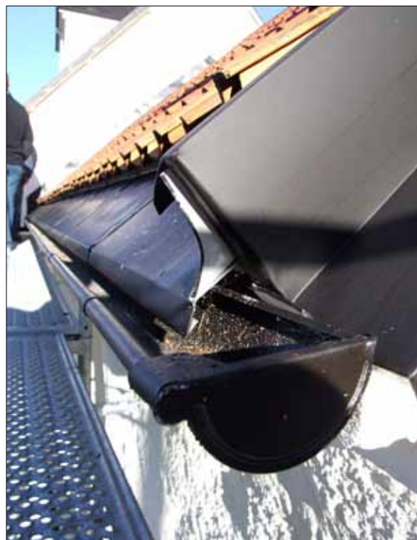
21 Takfotssprångets knäckta kant fick vara kvar på korets och sakristians takfall (Slm D11-224).
