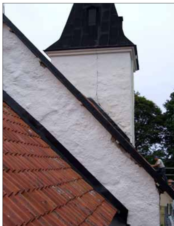
18 Nya vindskiveplåtar utfördes i korta längder och i utförande snarlikt befintliga (Slm D11-221).
