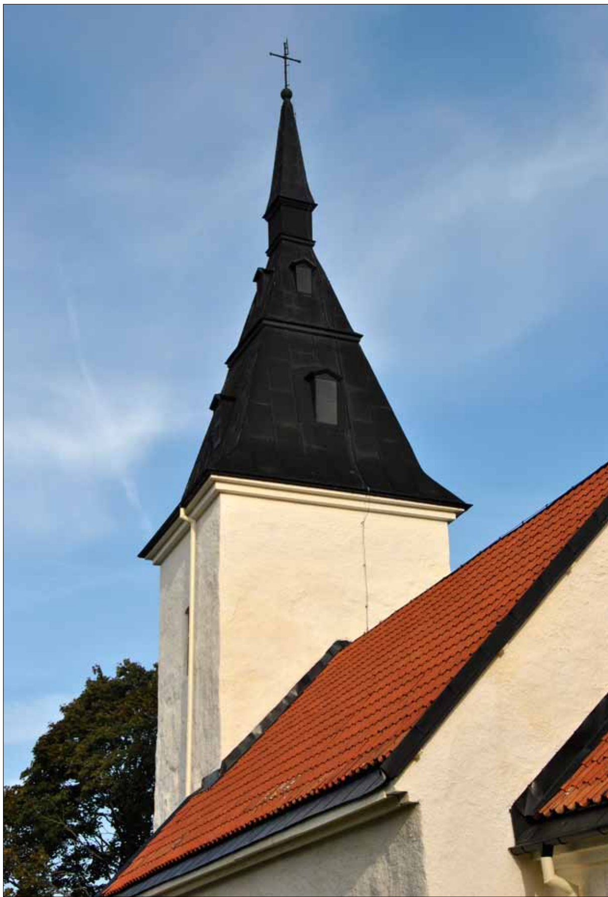
24 Kattnäs kyrkas långhus och torn från sydost (Slm D11-227).
