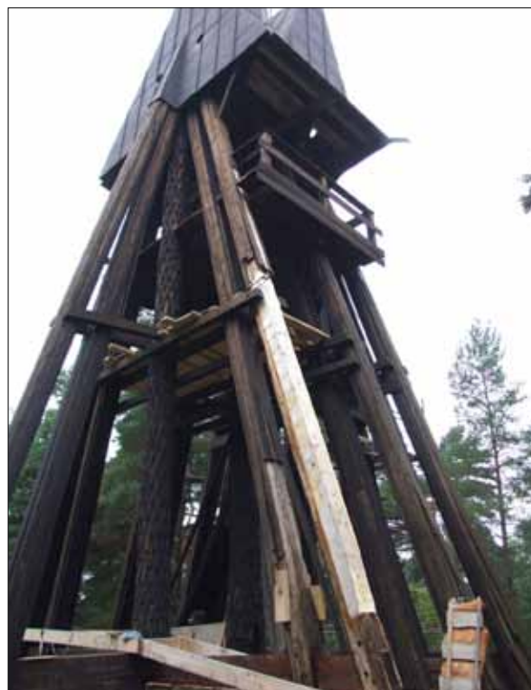
13 Ca 6 meter av snedsträvan ersattes med nytt virke (Slm D11-598).
