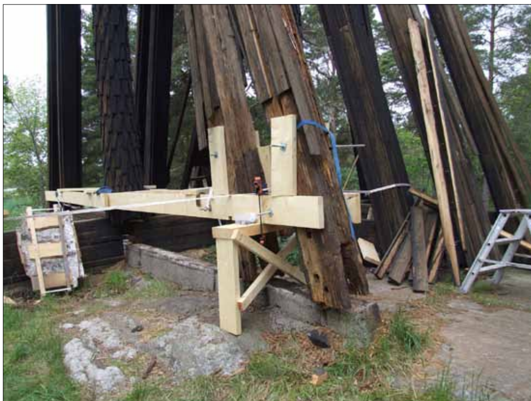
9 Den södra och östra yttre och inre snedsträvan hissades upp, så att syllen gick att montera (Slm D11-594).
