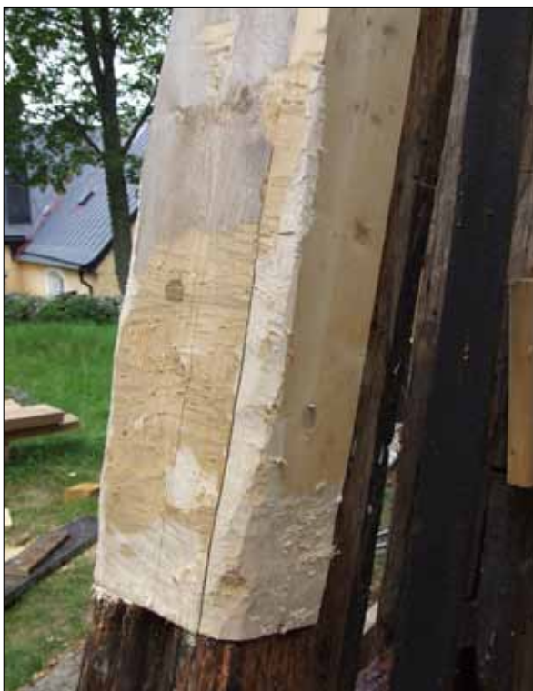
16 Nytt virke till snedsträvan dymlades och limmades fast i den äldre friska delen av strävan med expanderlim (Slm D11-601).
