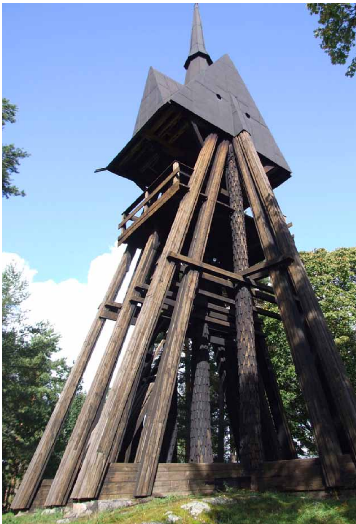
19 Björnlunda klockstapel i oktober 2010 sedd från sydväst före reparationen (Slm D11-604).
