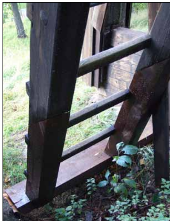
17 Stegen lagades nedtill med snedkapat virke som spikades (Slm D11-602).
