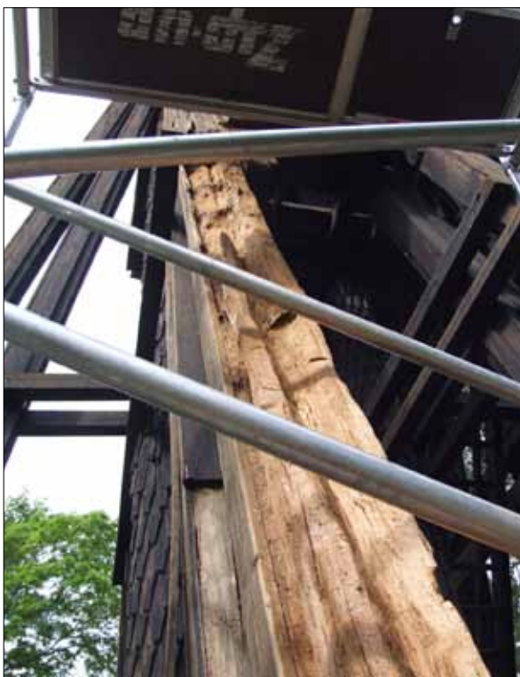
12 Yttre södra snedsträvan efter det att rötskadat virke tagits bort (Slm D11-597).
