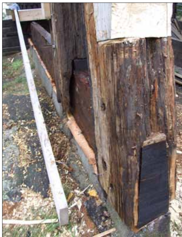
11 Syllen efter lagning. Gafflingen behölls (Slm D11-596).
