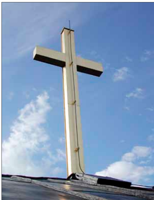
13 Det nya korset har målats och förgyllts. En åskledare har monterats på baksidan.
