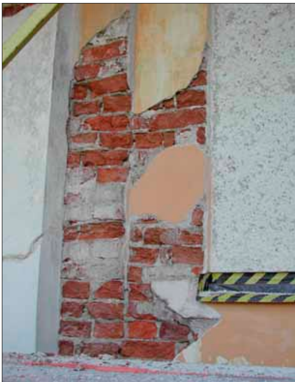
8 Tegel på östra väggen och koret i sydost.
