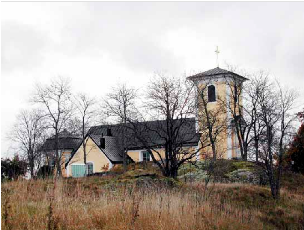
16 Torsåkers kyrka färdigupprustad utvändigt och invigd den 3 november 2003.
