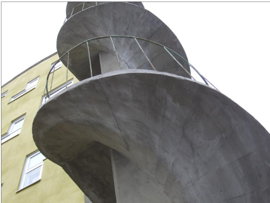
Utrymningstrappan underifrån efter upprustningen.
