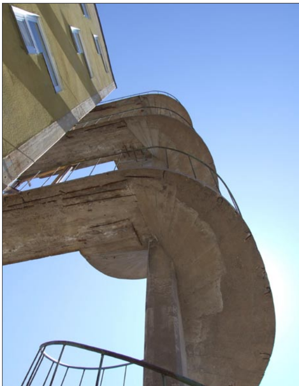
Spiraltrappan underifrån före åtgärder.
