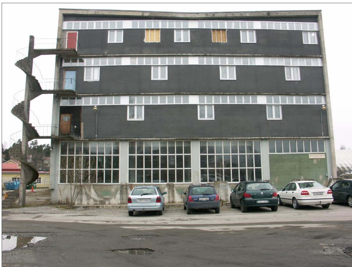
Fabriksbyggnadens sydfasad med spiraltrappan av betong, som byggdes för utrymning av fabriken.
