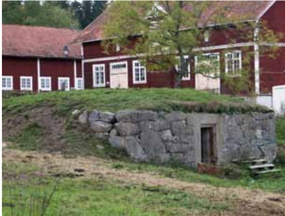
Bild 19. Jordkällaren med finhäststallet i bakgrunden.
