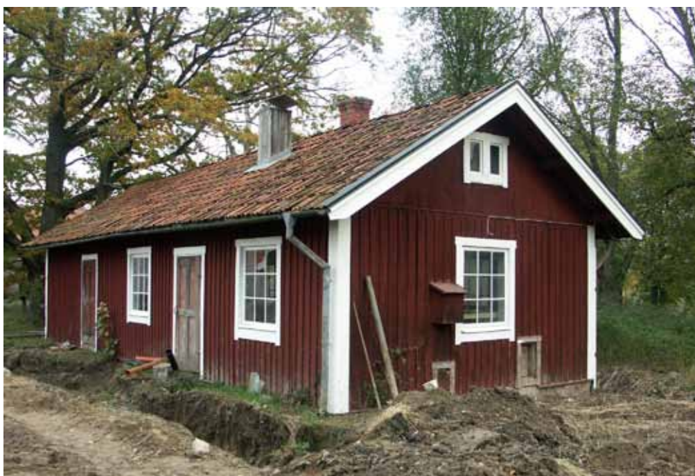
Bild 46. Hönshusets norra och västra fasad.
