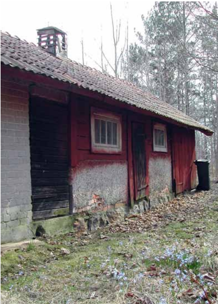
Bild 54. Svinstian och dassets västra fasad.
