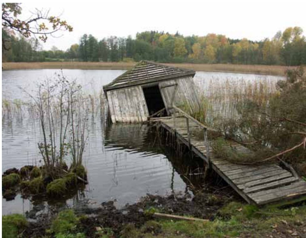
Bild 24. Båthuset har en gångbro som leder ut till huset.
