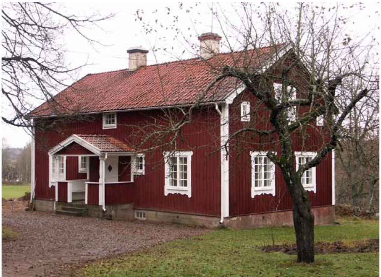
Bild 50. Rättarbostadens västra fasad.
