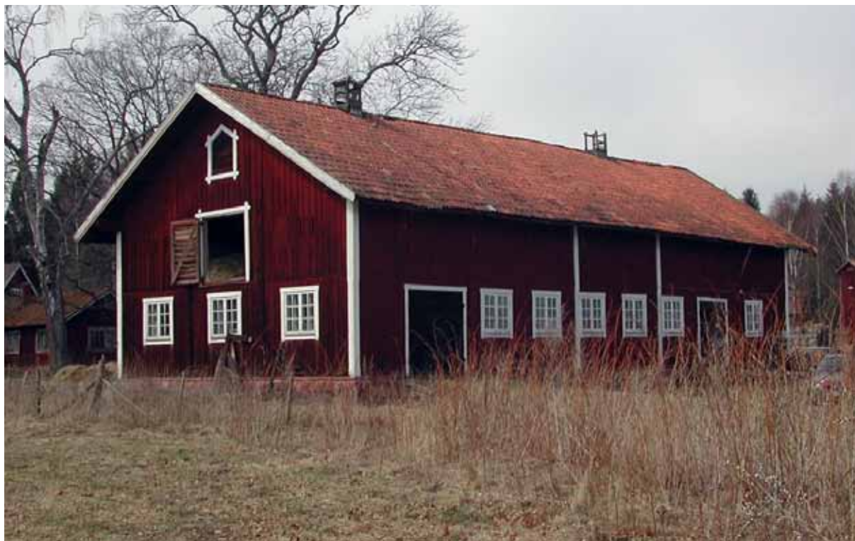
Bild 34. Arbetshäststallet som idag har större fönster än tidigare, jmf. bild 33.
