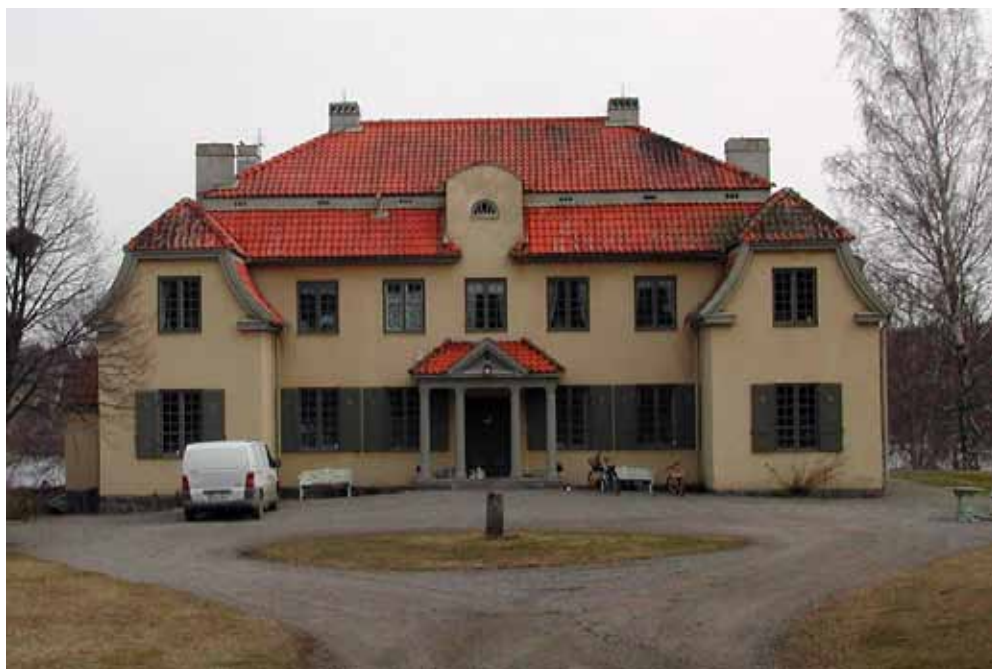
Bild 11. Corps de logiet sett från söder.
