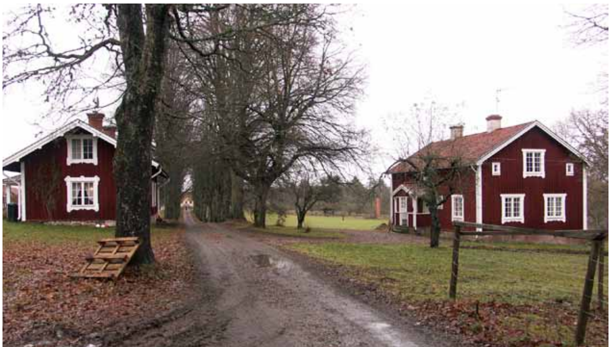
Bild 4. Vid ankomsten till Fastmyra gård möts man först av två bostäder som ligger parallellt med vägen - arbetarbostaden till vänster och inspektorbostaden till höger.
