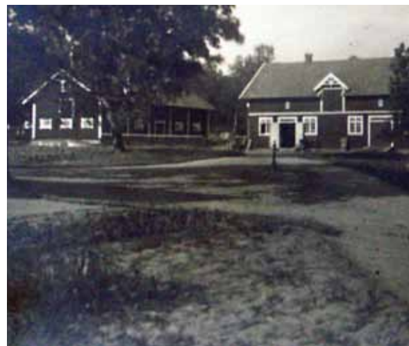
Bild 33. Äldre fotografi inlånat av fastighetsägaren, där man ser att arbetshäststallet har låga liggande fönster. Okänd fotograf. Okänt årtal.
