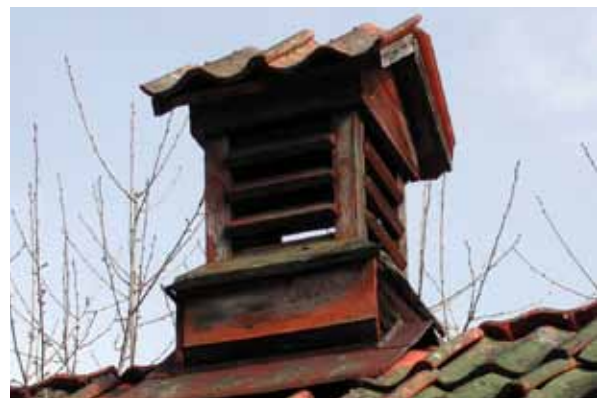
Bild 57. Detalj av hönshusets ventilationshuv.
