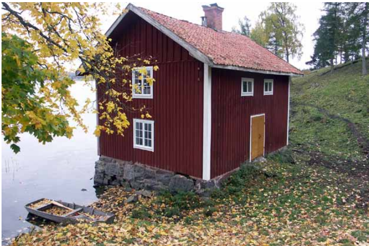
Bild 20. Tvättstugan sedd från norr.
