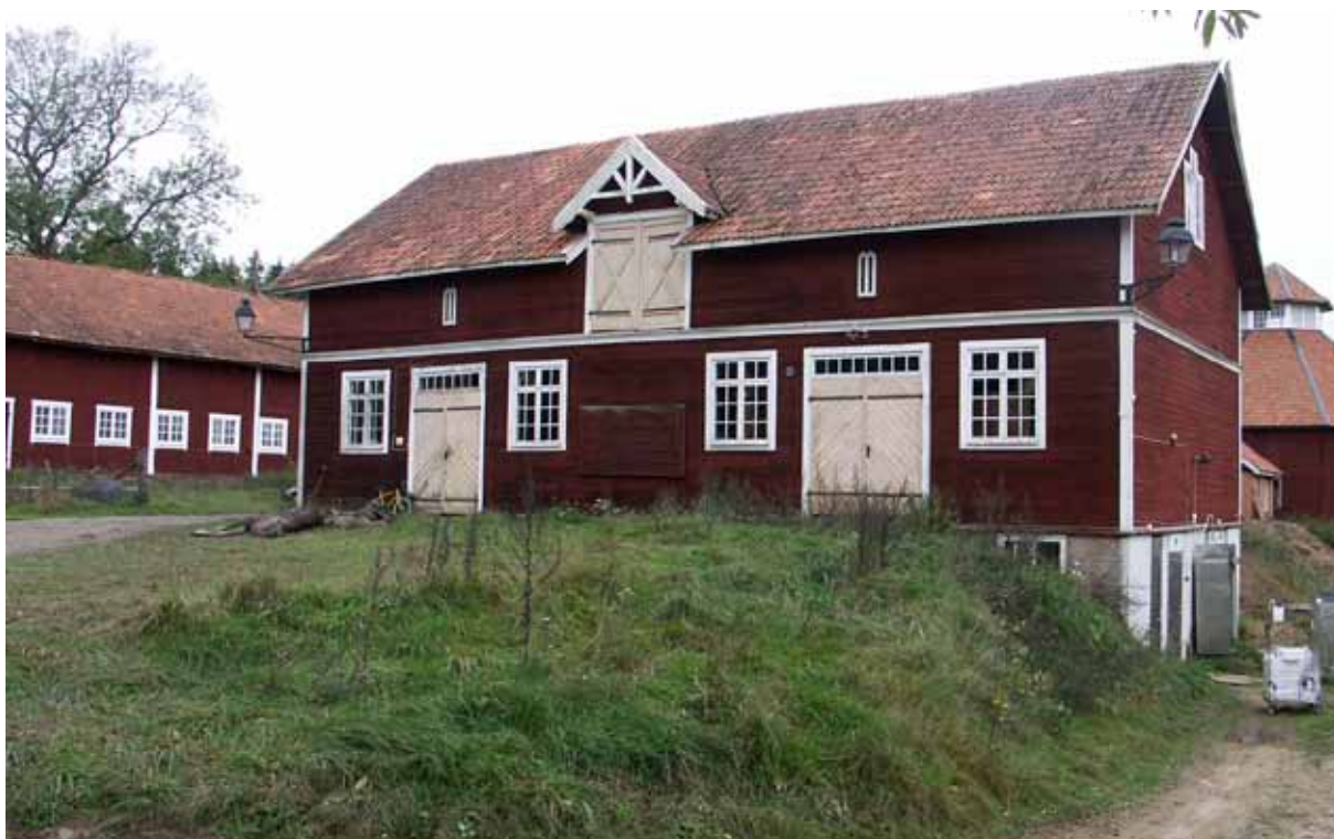
Bild 32. Finstallet från söder.
