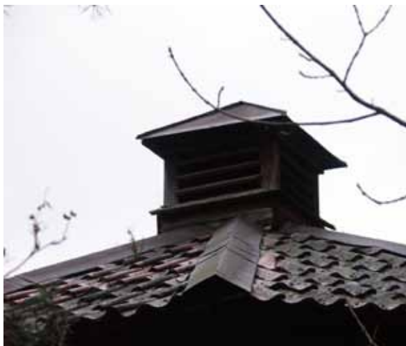
Bild 52. Detalj av vattentornets huv.
