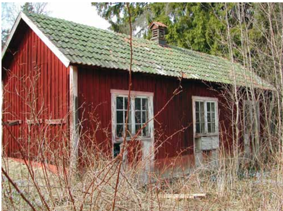
Bild 55. Hönshusets östra fasad.
