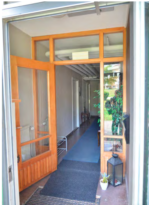
77. Glasat dörrparti av ek i hallen till den f.d. frisersalongen. SLM D2022-0424.
