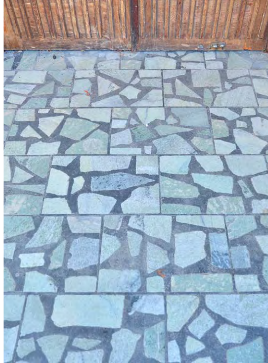
Bild 56. Kolonnadens terazzoliknande golv av marmorskärvor och svartpigmenterat fogbruk är precis som dörrarna omistligt för byggnadens karaktär och kulturhistoriska värden. SLM D2022-0403.
