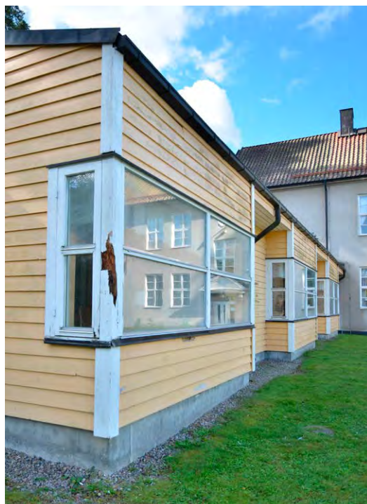
Bild 8. SLM D2022-0355. Tillbyggnadens västra fasad med burspråk som framhävs av mellanliggande oglasade partier....
