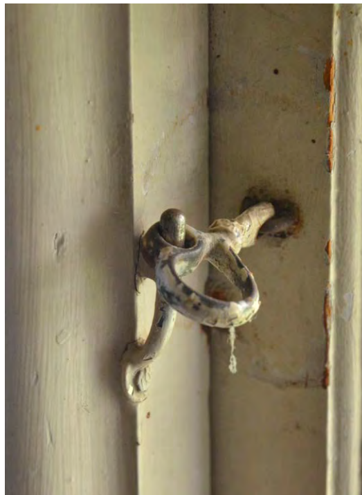
Bild 48. Stormhasp, s.k. handvarpa, av sekelskiftesmodell på övervåningens fönster. SLM D2022-0395.
