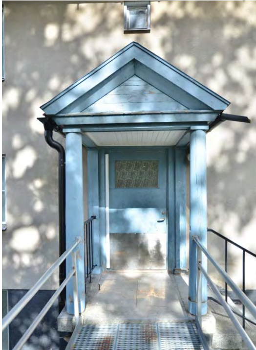
Bild 25. Förstuvistens tempelgavel med panelad fronton och svarvade kolonner är ursprunglig, med undantag av borttagna delar av det smidda järnräcket. SLM D2022-0372.
