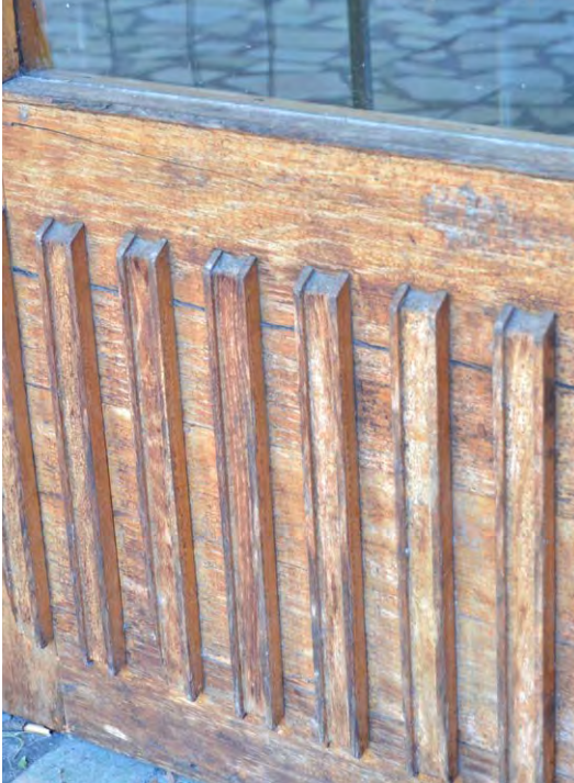
Bild 55. Ekdörrarna utgör en genomtänkt del av byggnadens arkitektur. Att fernissan har flagnat och träet bitvis grånat gör inte att dörrarnas utmärkta kvalitet har försämrats. SLM D2022-0402.
