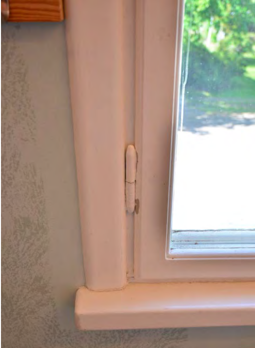
Bild 16. Ursprungliga träfönster, fönsterbänkar och foder av god kvalitet. SLM D2022-0363.
