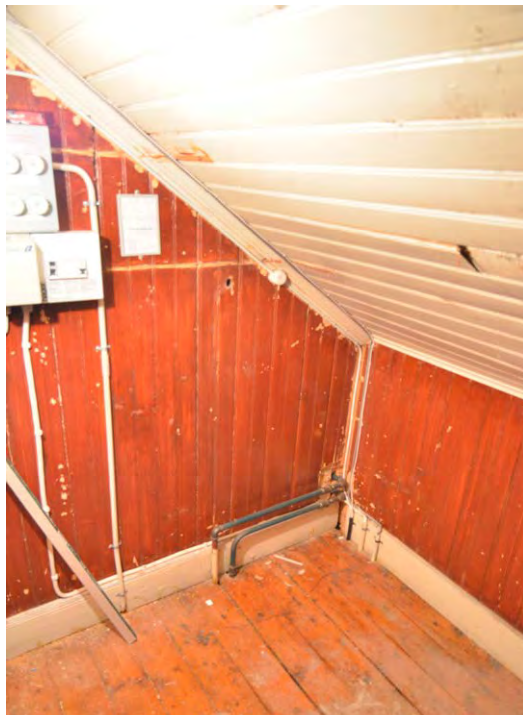
Bild 51. Inredd vind på västra sidan. SLM D2022-0398.
