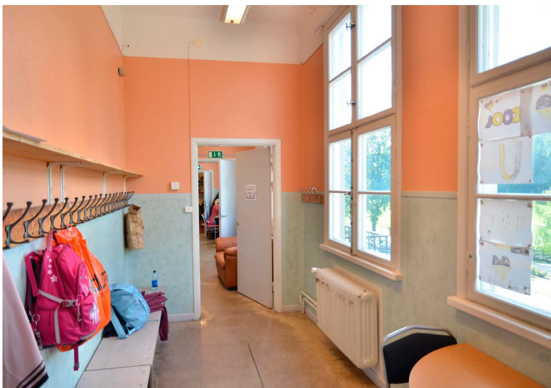
Bild 11. Vägg till vänster i bilden har tillkommit under senare tid. Takhöjden och de höga fönstren bevarar dock en äldre karaktär. De ursprungliga fönstren med spanjolettbeslag, hyvlade foder och lister samt klädkrokarna av gjutjärn är värdefulla. SLM D2022-0358.
