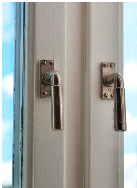
Bild 74. Andra våningens träfönster är i gott skick. Virkets proportioner och utförande är karaktärsskapande. SLM D2022-0421.
