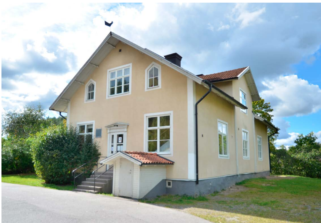
Bild 37. Slöjdhusets nordvästra fasader. SLM D2022-0384.
