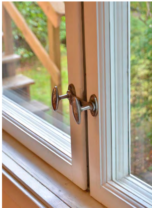
Bild 42. Klassrummets kopplade träfönster och vred är i mycket gott skick. SLM D2022-0389.
