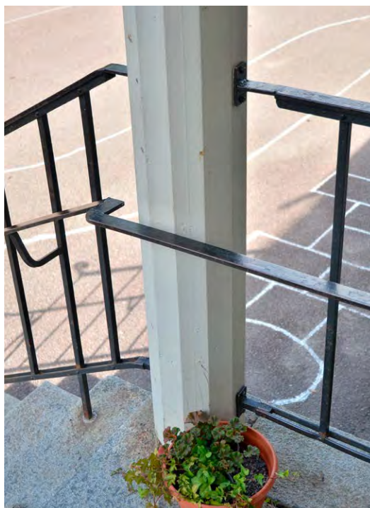
Bild 5. Målade träkolonner med släta räfflor (kanellyrer). SLM D2022-0352.
