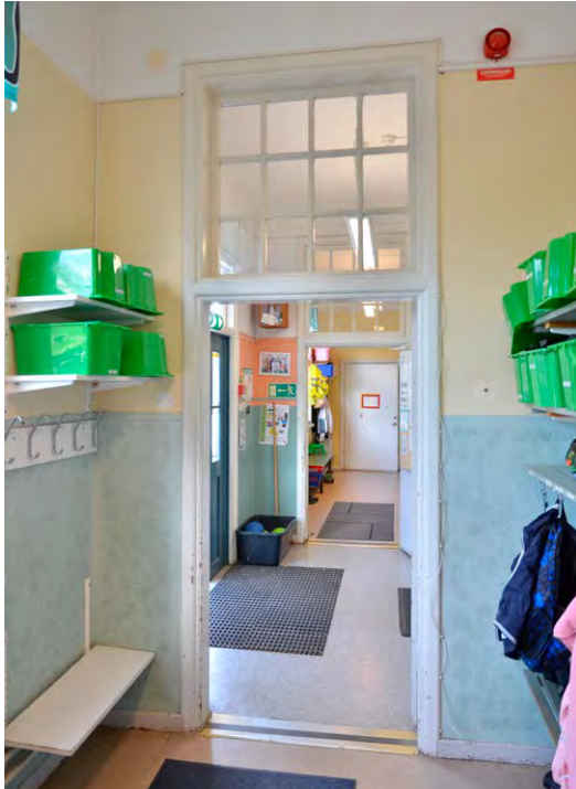
Bild 12. Motsvarande korridor i bottenvåningen, med värdefulla äldre dörrfoder. Inte minst de spröjsade fönstren över dörrposterna är karaktärsskapande. SLM D2022-0359.
