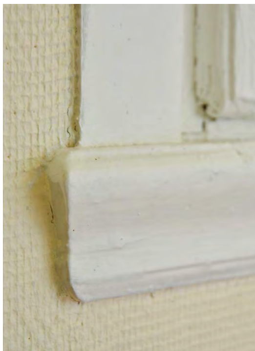
Bild 34. Ursprungliga profilhyvlade fönsterfoder. SLM D2022-0381.
