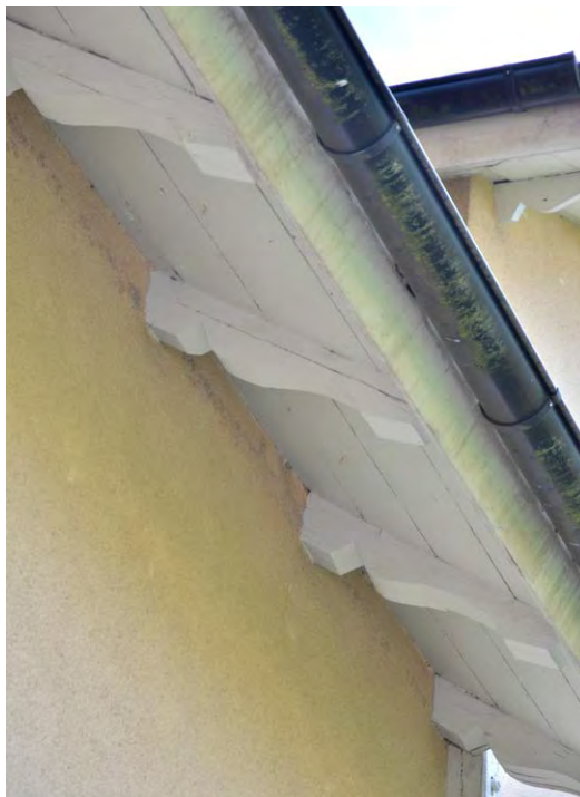
Bild 39. Profilerade taktassar är typiskt för 1800-talets slut. SLM D2022-0386.
