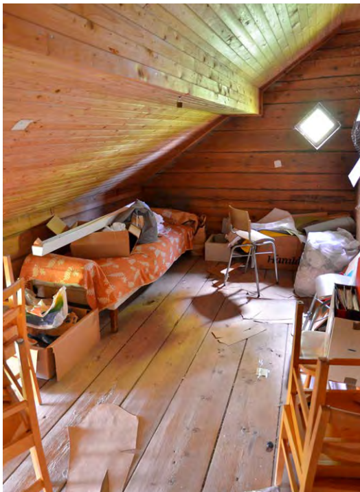
Bild 47. Inredd vind med äldre brädgolvv under östra takfallets södra del. SLM D2022-0394.
