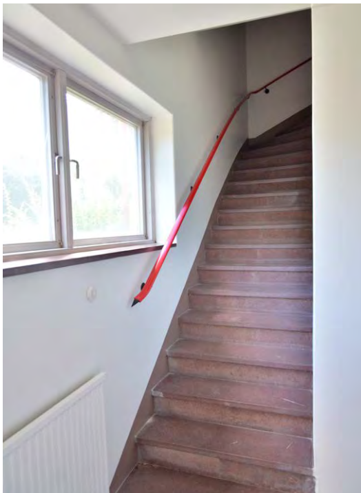
Bild 76. Kalkstenstrappa med järnräcke i hölje av röd plast. Bilden är tagen vid den f.d. biblioteksingången. SLM D2022-0423.
