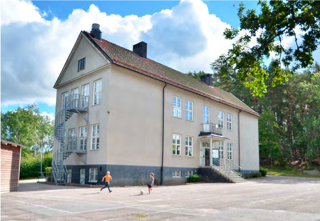
Bild 2. Skolhuset från 1930, vy mot nordöst. SLM D2022-0349.
