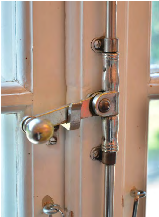
Bild 18. Utanpåliggande äldre spanjoletter av det slag som bilden visar finns på nästan alla de större fönstren. De är av hög kvalitet och är viktiga för interiörens karaktär. SLM D2022-0365.
