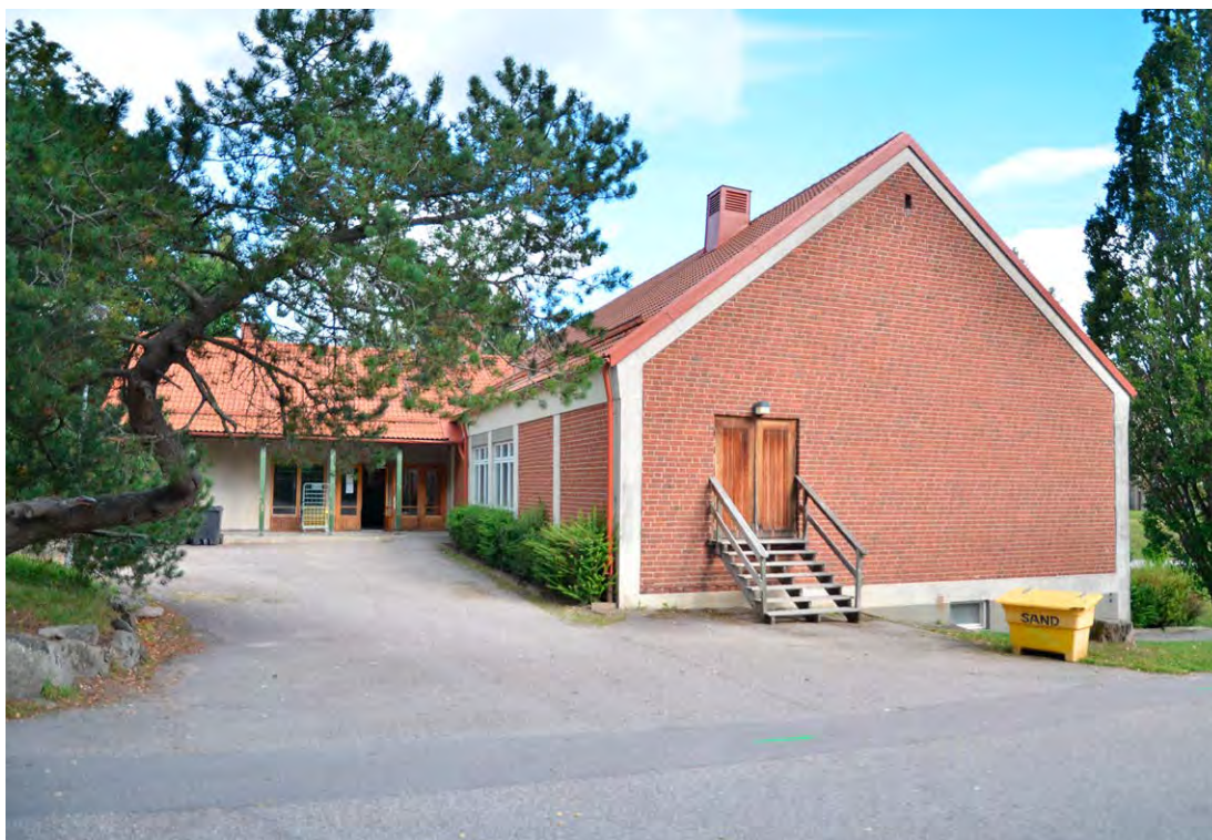
Bild 53. Mellösagårdens sydvästra fasader. SLM D2022-0400.
