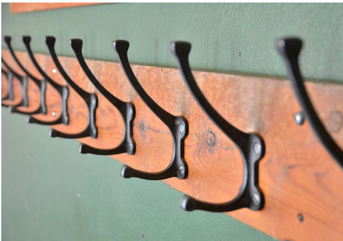
Bild 68. Äldre gjutjärnskrokar i foajén, av samma slag som finns i såväl skol- och gymnastikhuset. SLM D2022-0415.
